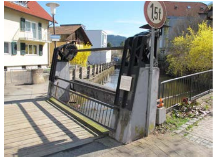
Ansicht der Stellfalle von Westen
