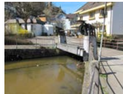
Ansicht von Osten
