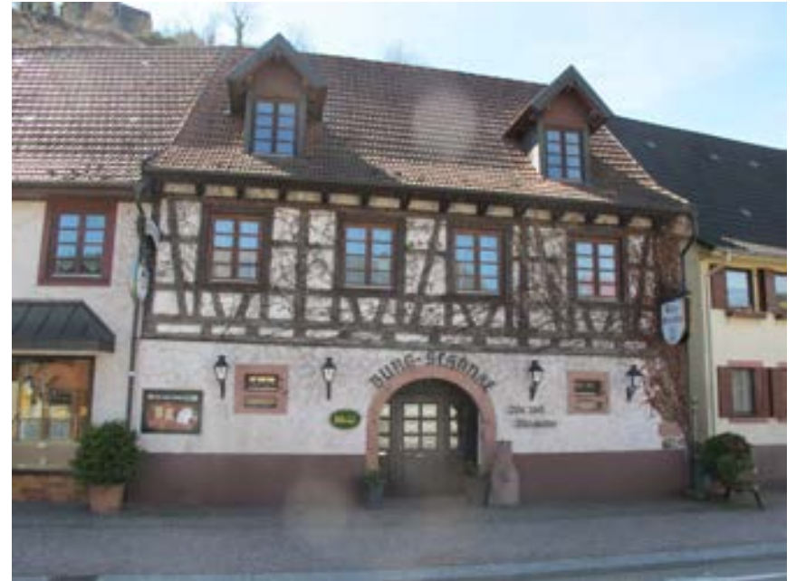
Ansicht des Gebäudes von Norden
