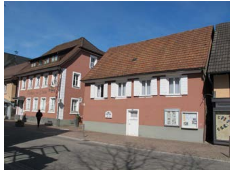
Ansicht des Gasthofes von Südosten
