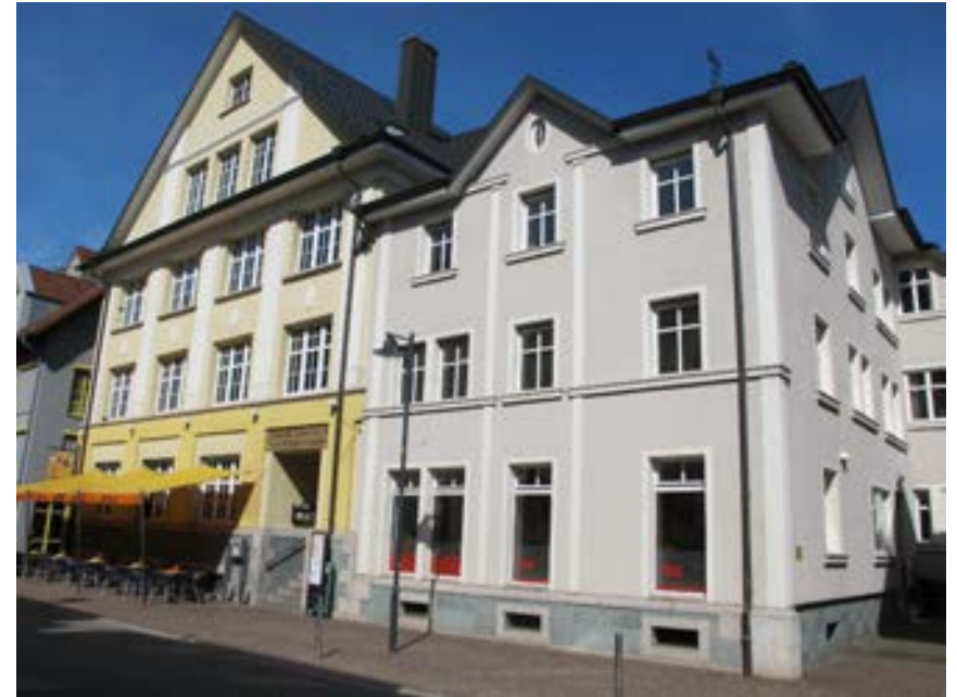
Ansicht der ehemaligen Hosenträgerfabrik von Südosten
