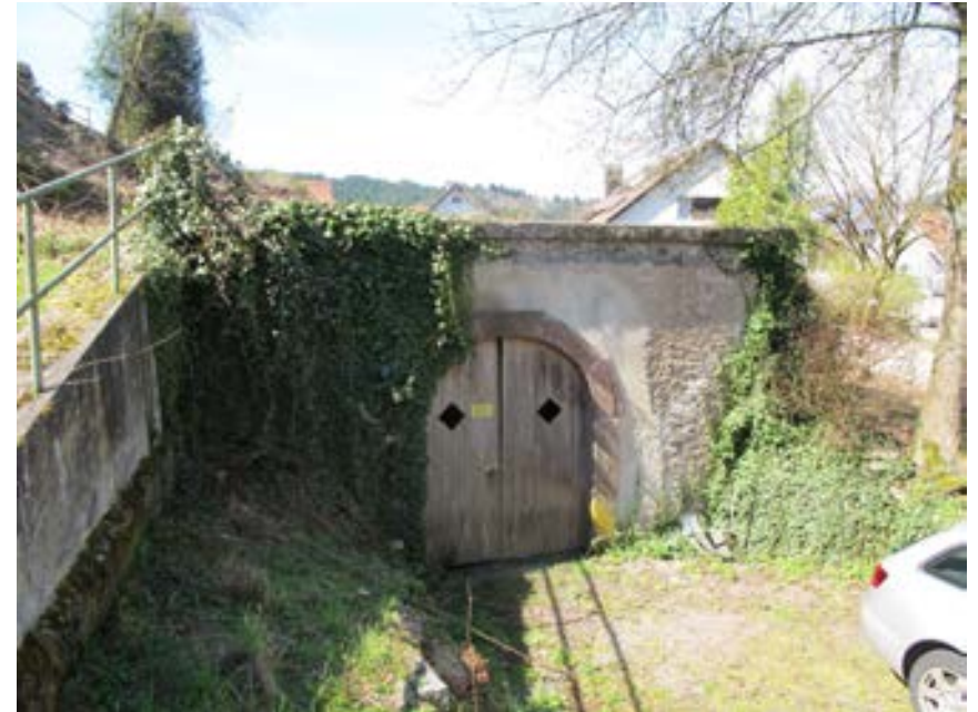
Ansicht des Gewölbekellers von Osten
