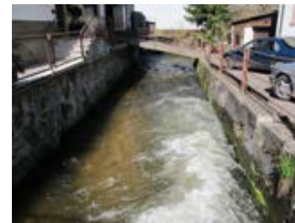
Gewerbekanal bei Gartenstraße 2
