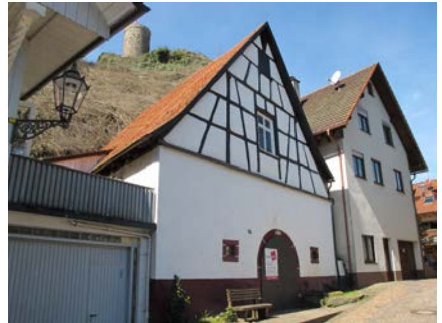
Ansicht des Speichergebäudes von Osten
