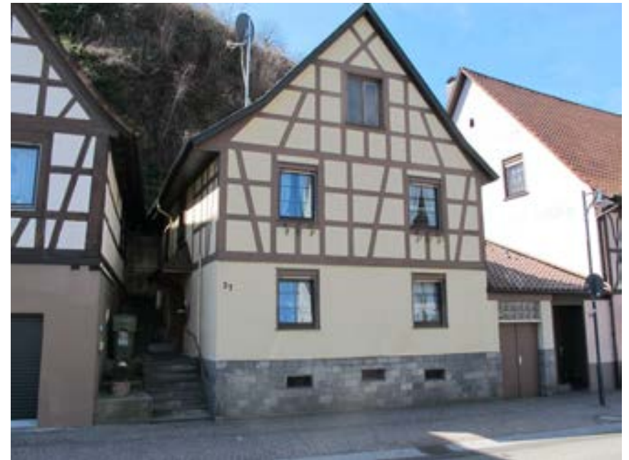
Ansicht des Wohnhauses von Nordosten
