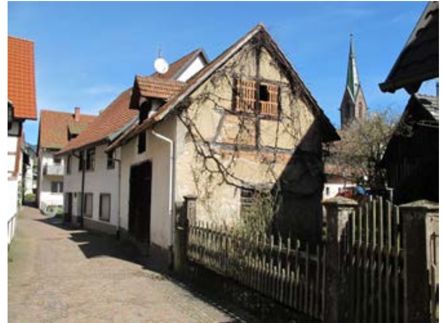
Ansicht des Ökonomiegebäudes von Südwesten
