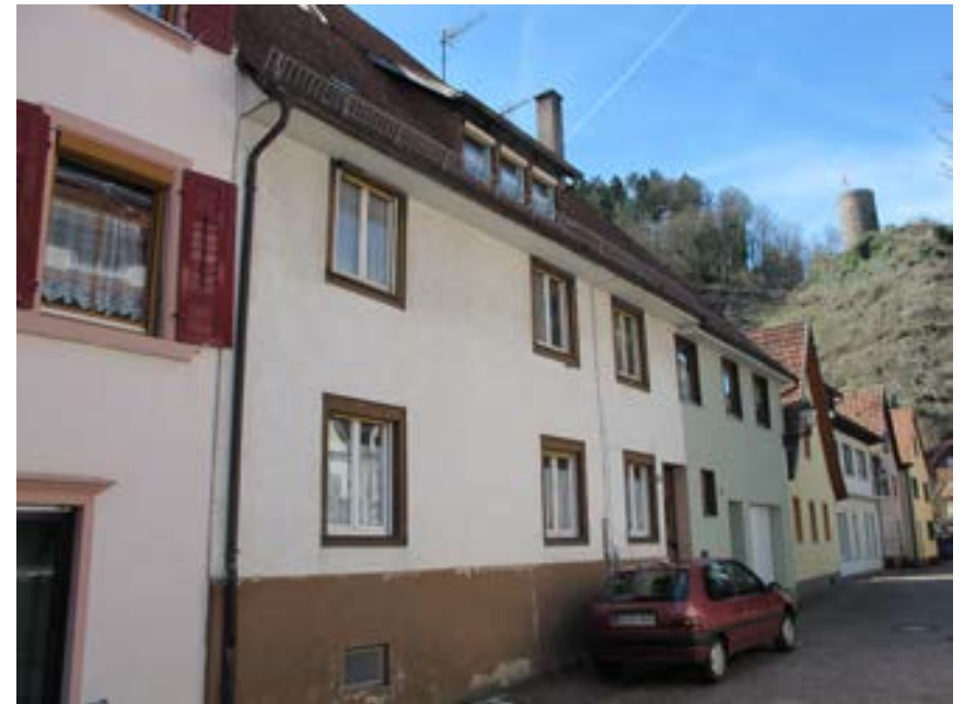
Ansicht des Wohnhauses von Nordosten
