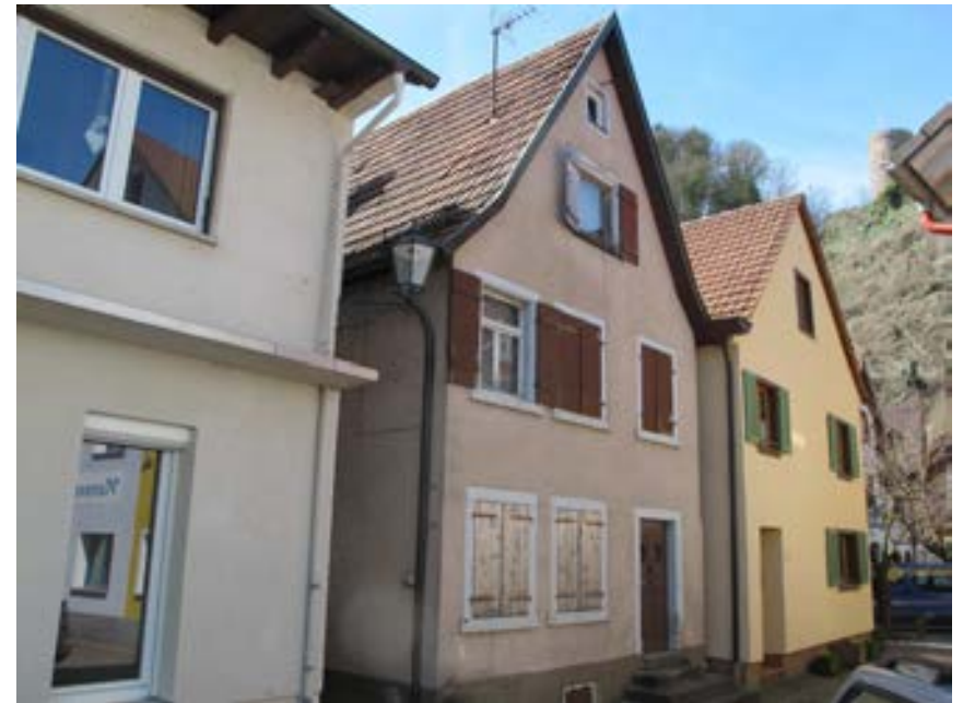
Ansicht des Wohnhauses von Nordosten
