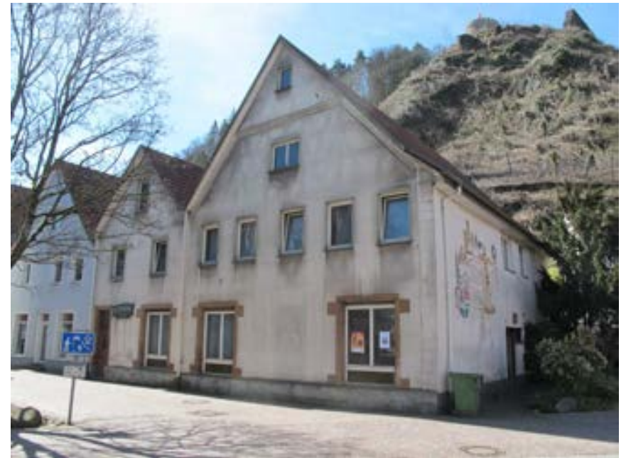
Ansicht des Gasthauses von Nordosten
