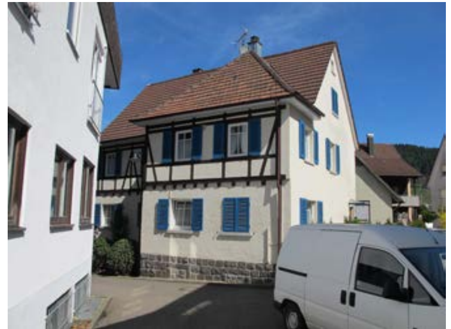
Ansicht des Gebäudes von Süden
