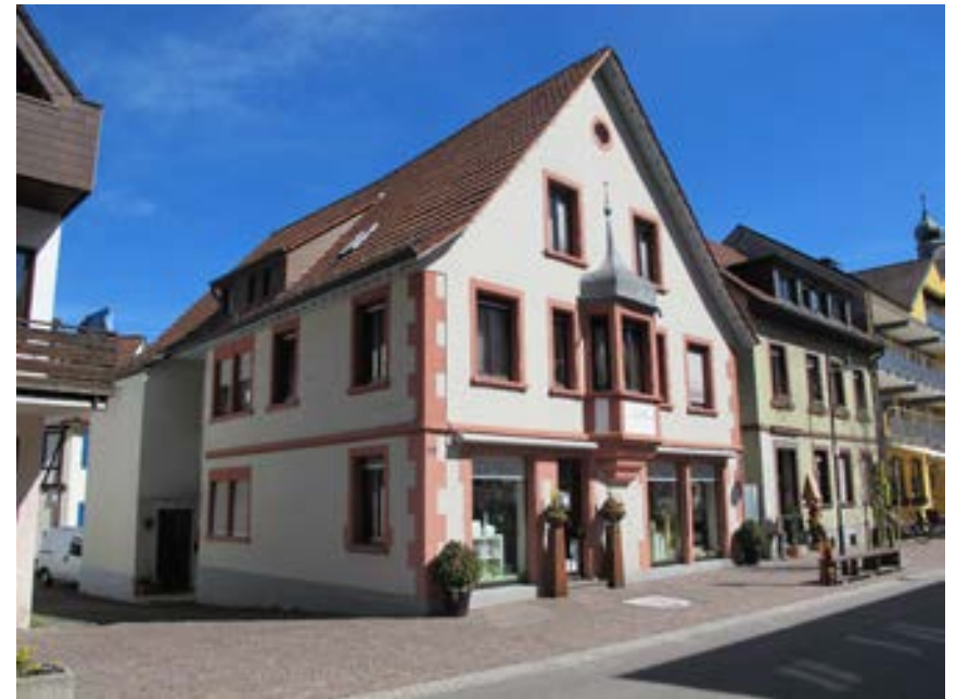
Ansicht des Gebäudes von Südwesten
