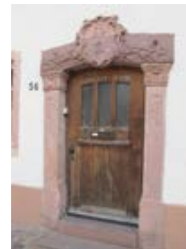
Ansicht des Türportals
