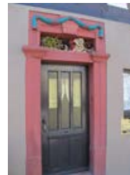
Ansicht des Türportals
