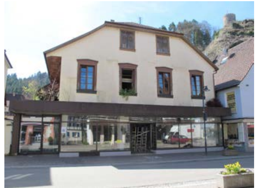
Ansicht des Gebäudes von Norden
