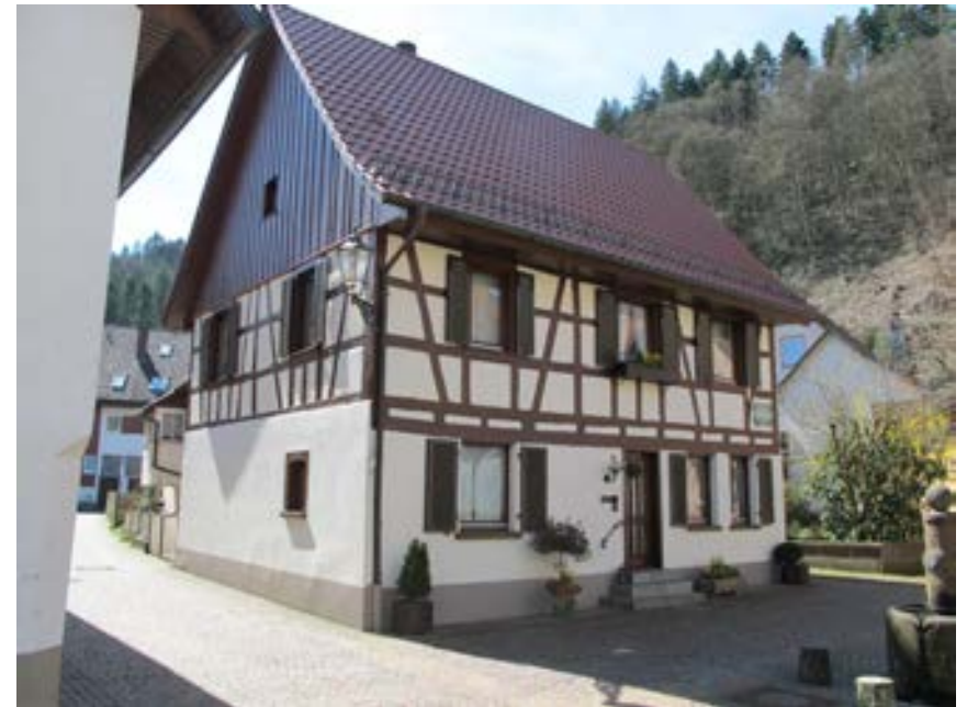
Ansicht des Wohnhauses von Nordosten
