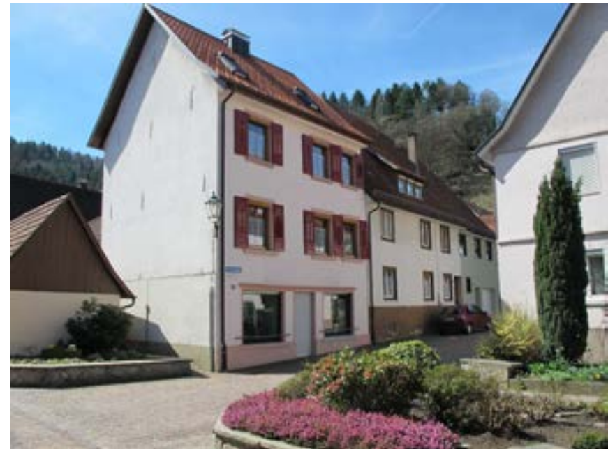
Ansicht des Wohnhauses von Nordosten
