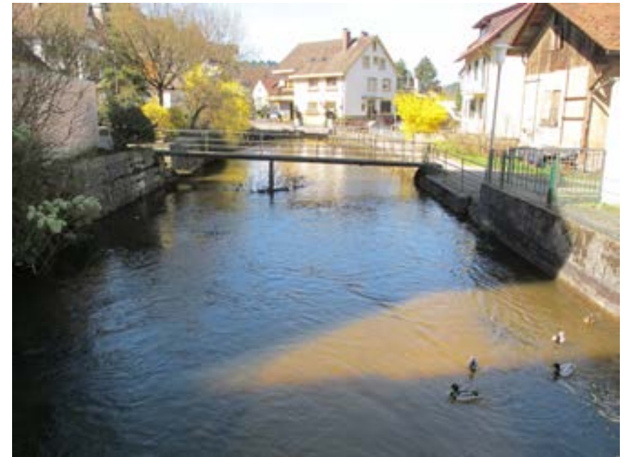
Blick auf den Gewerbekanal nördlich von Hauptstraße 30
