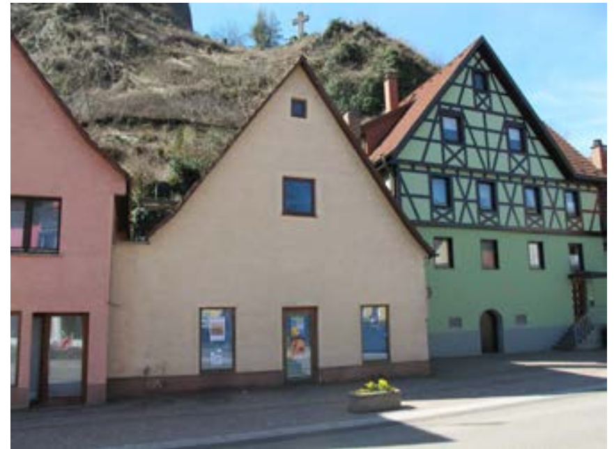
Ansicht des Wohnhauses von Nordosten
