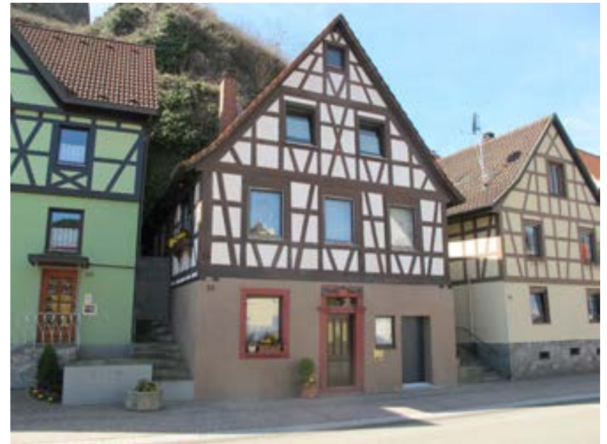
Ansicht des Wohnhauses von Nordosten
