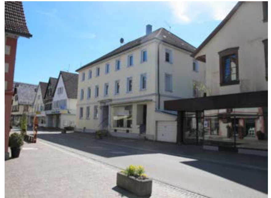
Ansicht des Gasthauses von Nordwesten
