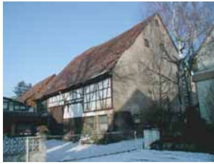
Fachwerkscheunen des 19. Jh. - historischer Ortsrand an der Maul- bronner Straße
