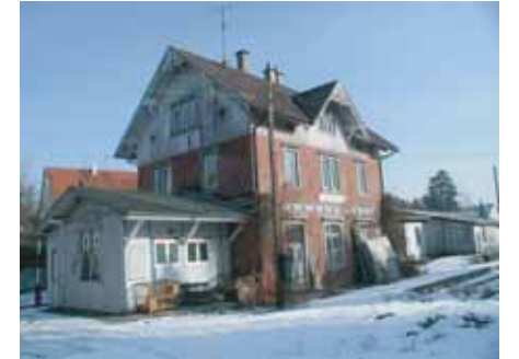
Ehem. Bahnhof - Solitär am Ostrand
