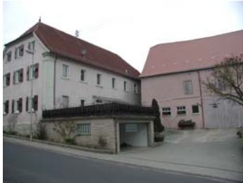
Grünfelder Str. 12: Hofanlage, bestehend aus giebelständigem massivem zweigeschossigem regelmäßig gegliedertem Doppelwohnhaus vom Anfang des 19. Jh. mit dekorativen Eckpilastern und durch Keilsteine ausgezeichneten Fensterlaibungen, an hofseitiger Traufseite befinden sich zwei Eingänge, darunter der Gewölbekeller, Kulturdenkmal nach § 2, dazu nachzutragen als Teil der Sachgesamtheit nach § 2 DSchG:
