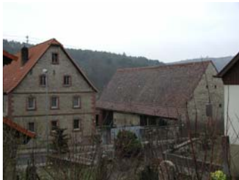
Grünfelder Str. 13: Hofanlage, bestehend aus giebelständigem Wohnhaus, bez. 1800, und parallel stehender Massivscheune sowie Hofmauer mit dekorativ gearbeitetem schmiedeeisernem Torblatt. Erhaltenswert.
