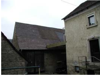
Grünfelder Str. 11a: traufständige zurückstehende Scheune, Massivbau des ausgehenden 19. Jh. Erhaltenswert.
