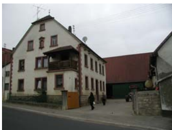
Grünsfelder Str. 8: Hofanlage, bestehend aus giebelständigem massivem zweigeschossigem Wohnhaus unter Krüppelwalmdach mit Rotsandsteingliederungen, datiert 1914, dazugehörig zurückgesetzte traufständige gewaltige Massivscheune mit zwei Tennen und Torpfeileranlage bez. 1906. In Sachgesamtheit erhaltenswert.
