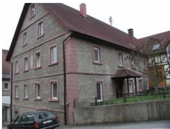
Grünsfelder Str. 7: traufständiges zweigeschossiges massives Wohnhaus, Muschelkalkbau mit Rotsandsteingliederungen aus ausgehendem 19. Jh., am seitlichen Eingang bez. 1855. Erhaltenswert.
