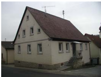
Grünsfelder Str. 5: giebelständiges massives Wohnhaus aus 1. Hälfte des 19. Jh. mit traufseitigem Eingang an Unterer Gasse, ausgezeichnet durch kapitellartige Wiederkehren und Giebelschlaudern mit den Initialen FJ. Dazugehörig von der Unterer Gasse einfahrbare traufständige Massivscheune, bauzeitlich mit Wohnhaus. In Sachgesamtheit erhaltenswert.
