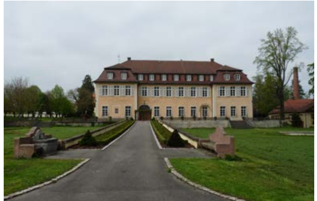
Ansicht von der Parkseite
