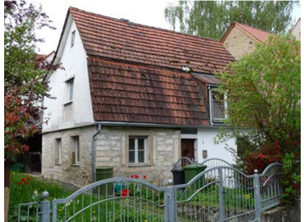
Blick von der Hauptstraße
