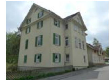
Straßenansicht von Nordwest
