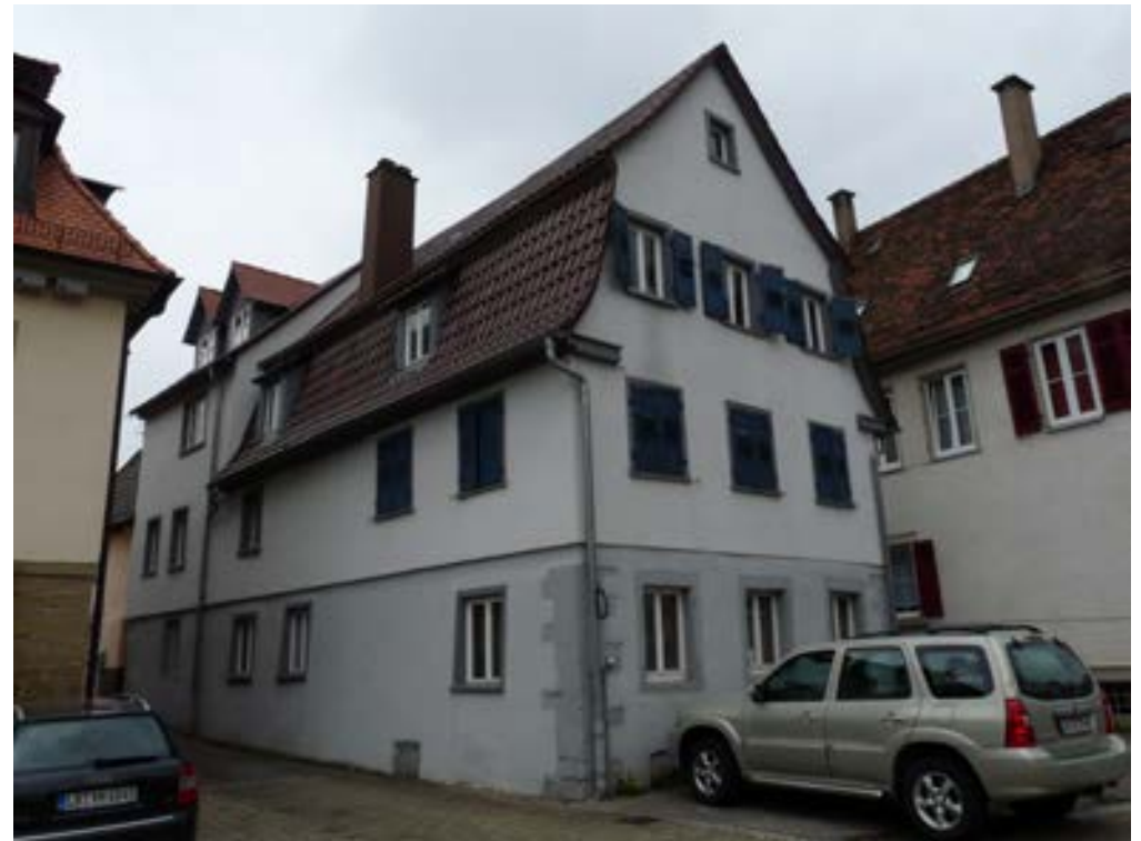
Blick von der Hauptstraße
