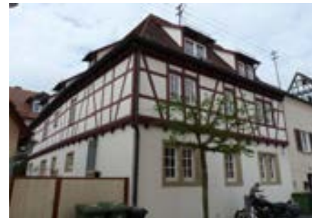
Straßenansicht Gästehaus von NO
