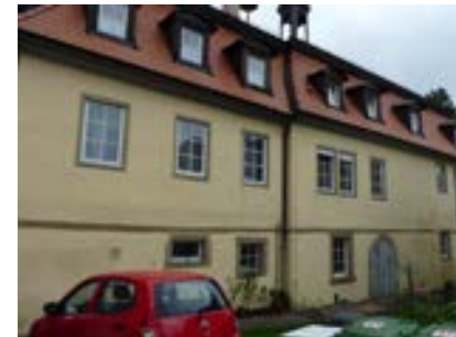
Rückseite des Gebäudes
