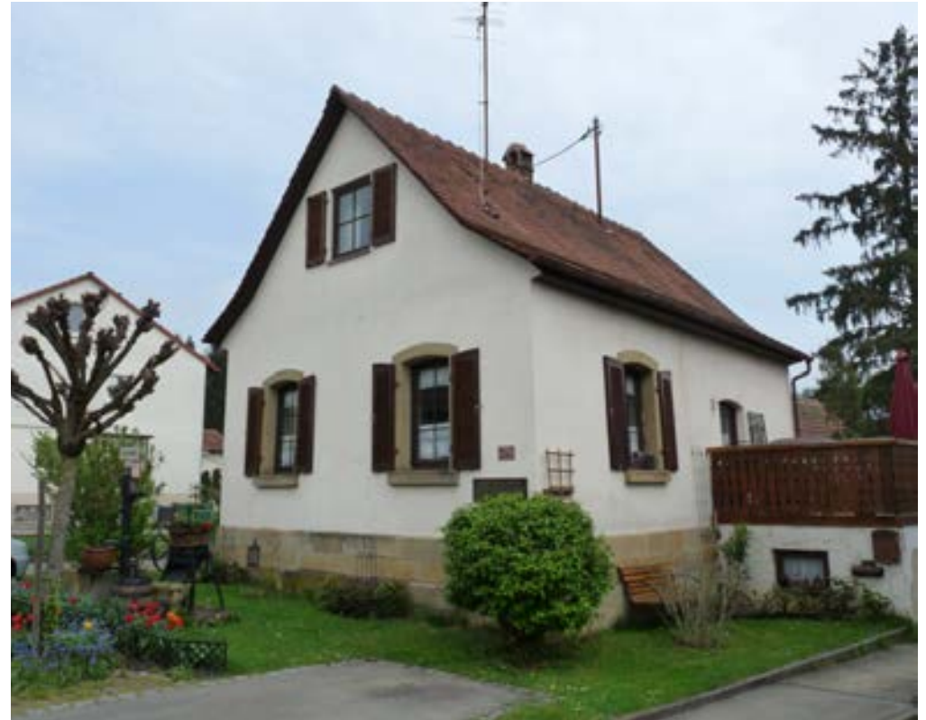
Straßenansicht von Süd-Ost
