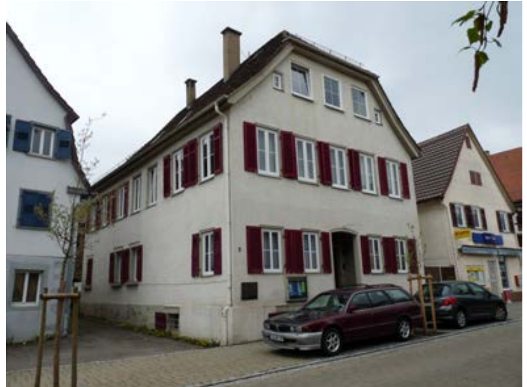
Blick von der Hauptstraße
