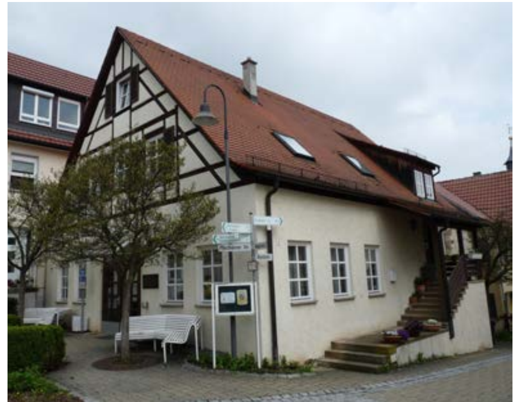
Straßenansicht von Süd-Ost
