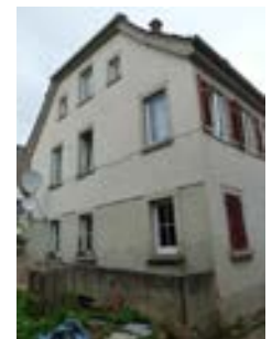
Rückseite des Gebäudes
