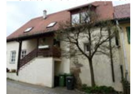
Straßenansicht von Osten
