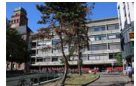
Kollegiengebäude III von 1969
