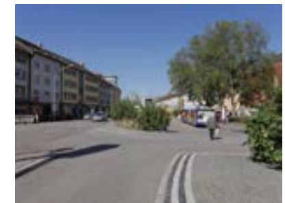
Friedrichring, derzeit Baustelle
