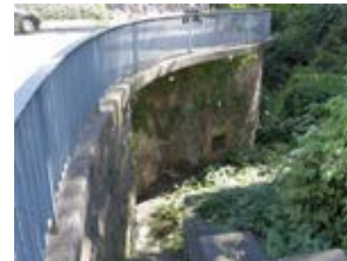
Turmstumpf des ma. Pulverturms
