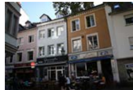
Alte Bausubstanz: Nr. 4, 6 und 8
