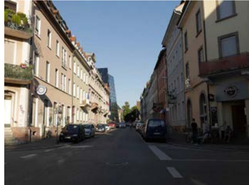
Östlicher Abschnitt, Höhe Moltkestraße
