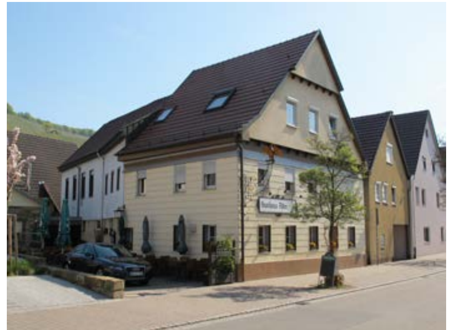
Ansicht des Gasthauses von Südwesten
