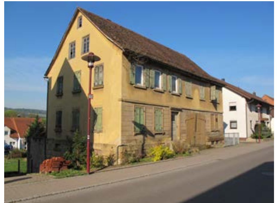
Ansicht der Hofanlage von Nordosten
