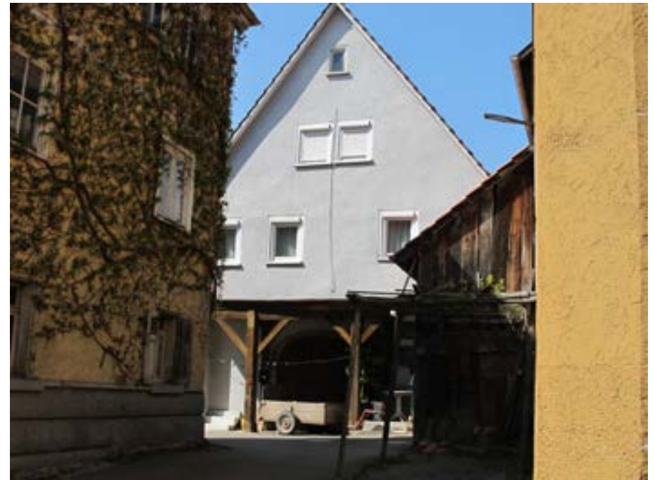
Ansicht des Wohnhauses von Osten
