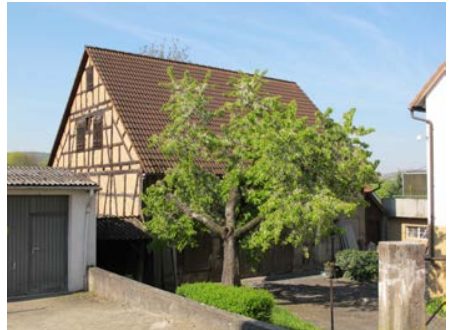
Ansicht der Scheune von Nordosten
