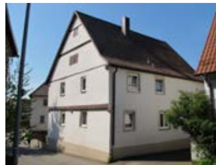
Ansicht des Hauses von Nordosten
