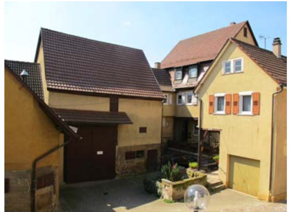
Ansicht der Hofanlage von Nordosten
