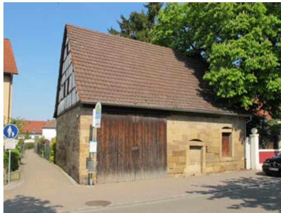
Ansicht der Scheune von Südosten
