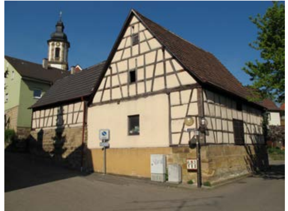
Ansicht der Scheune von Südosten
