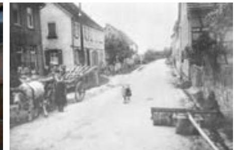
Blick nach Nordwesten bei Hausnr. 17
