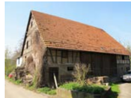
Ansicht der Doppelscheune von Nordosten
