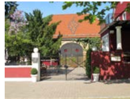
Ansicht der Scheune von Südosten
