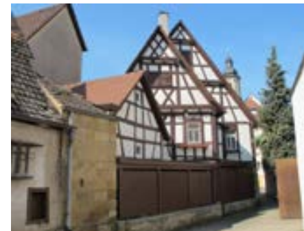
Ansicht des Hauses von Nordosten
