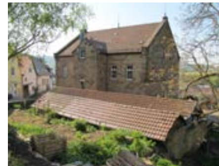
Ansicht des Schulhauses von Nordwesten
