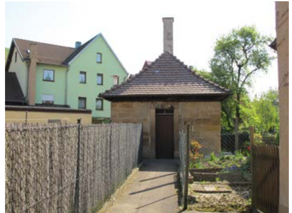
Ansicht des Backhauses von Westen
