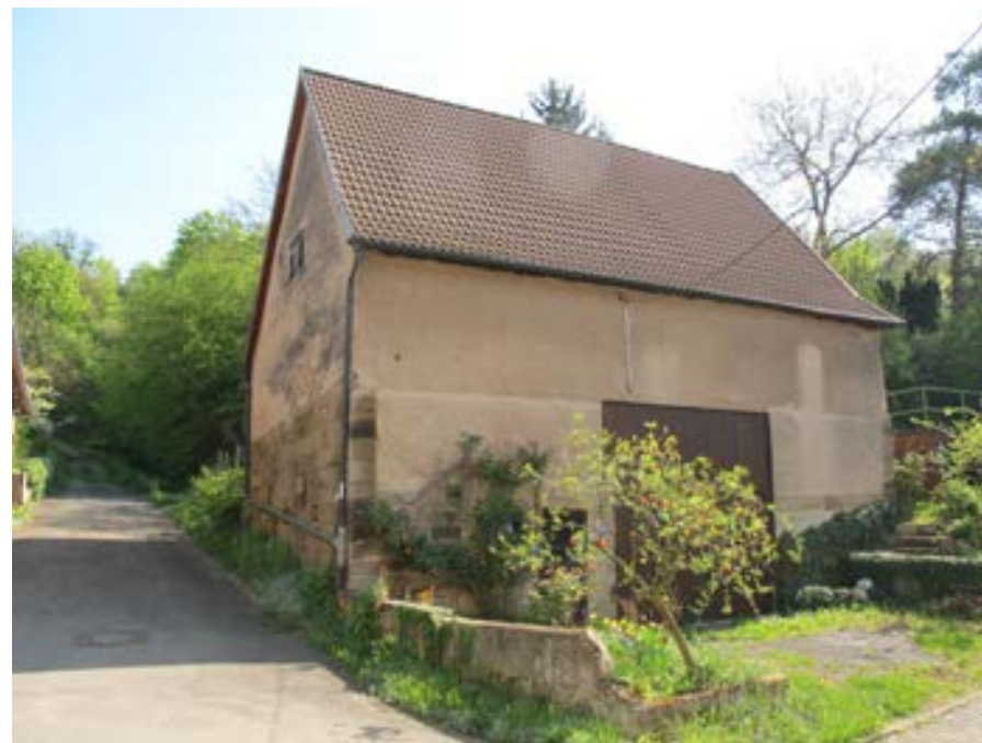
Ansicht der Scheune von Westen
