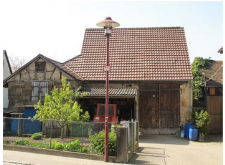
Ansicht der Scheune von Nordosten
