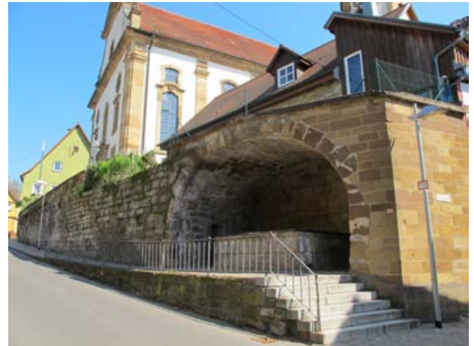
Ansicht des Kirchbrunnens von Südwesten
