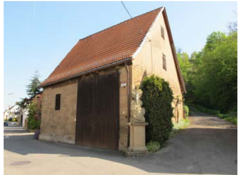
Ansicht der Scheune von Südwesten
