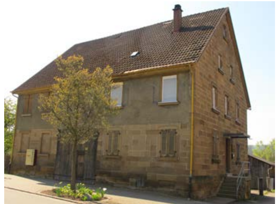
Ansicht der Hofanlage von Norden
