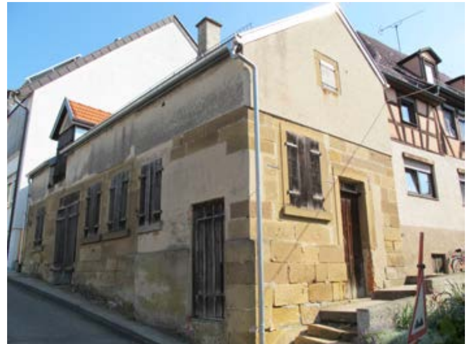
Ansicht des Gebäudes von Südwesten
