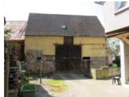
Ansicht der Scheune von Norden
