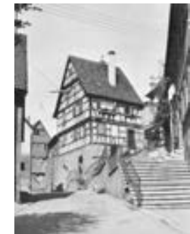
Historische Ansicht des alten Schulhauses
