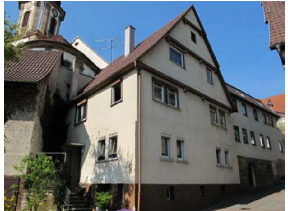
Ansicht der Hofanlage von Nordosten
