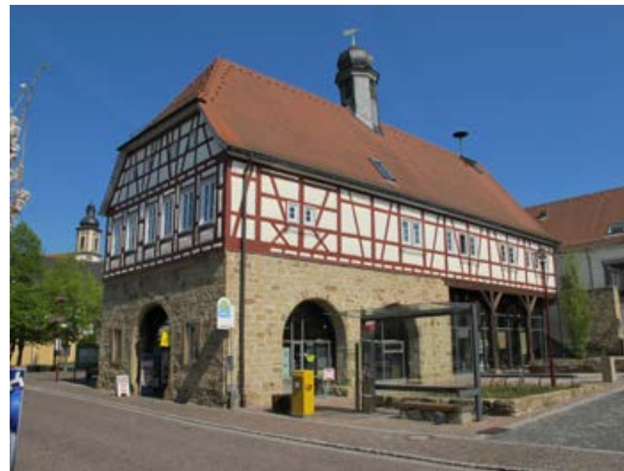
Ansicht des Rathauses von Süden
