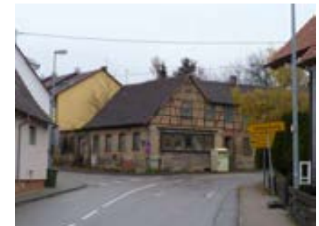
An der Ecke zur Heimerdinger Straße
