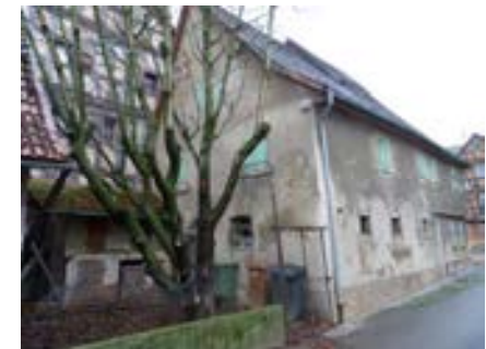
Ansicht von Nordosten, Stalltrakt
