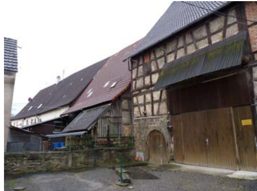
Ansicht des Scheunenriegels von Nordosten, Bildmitte Scheune Nr. 25/1
