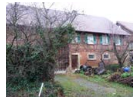
Ansicht von Südwesten mit Garten
