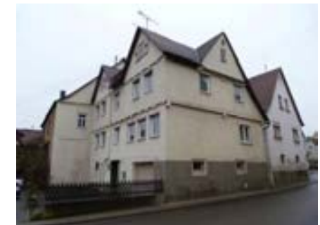
Wohnhaus von Nordosten
