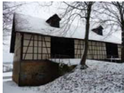
Rückseite der Remise
