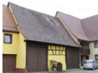
Scheune Nr. 8/1 von Südosten
