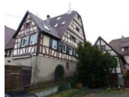
Blick von Südosten
