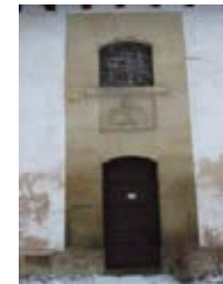
Detail Eingangsbereich und Wappen
