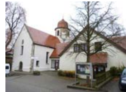
Ansicht von Westen mit Gemeindehaus
