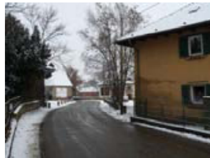
Ansicht Gesindehaus Richtung Nordwesten
