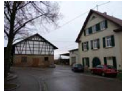
Schlösschen und Stallgebäude
