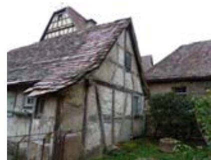
Rückseitige Ansicht von Nordosten
