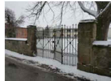
Portal und Steinmauer
