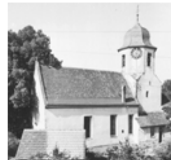
Historische Ansicht von Westen
