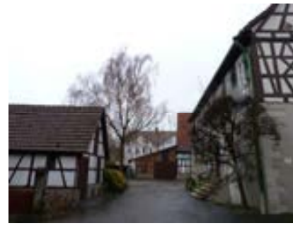
Hofraum mit ehem. Mosterei (links)
