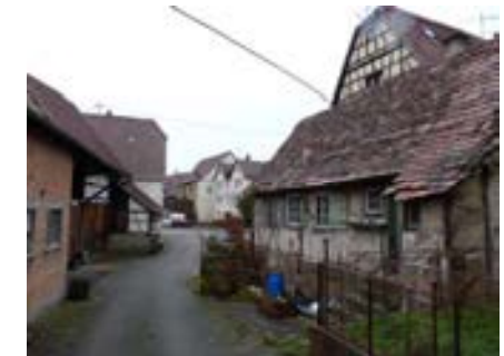
Gesamtsituation mit Blick nach Süden
