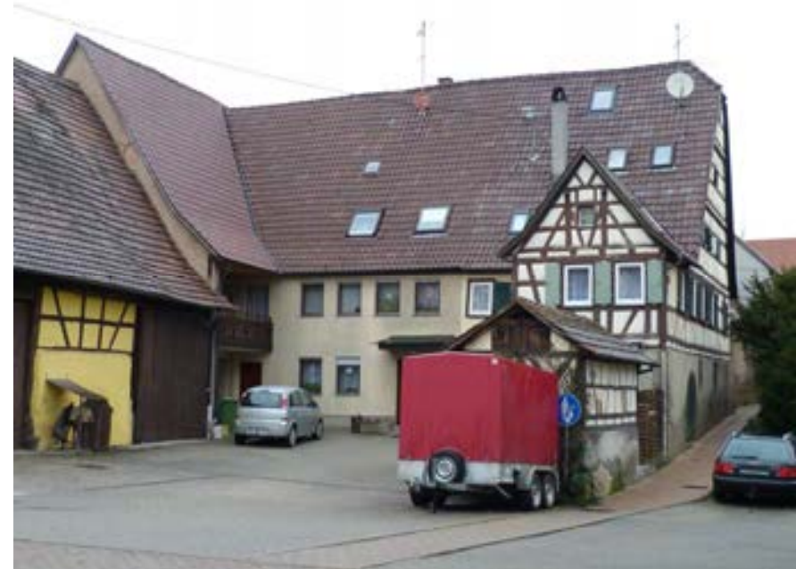
Ansicht von Norden
