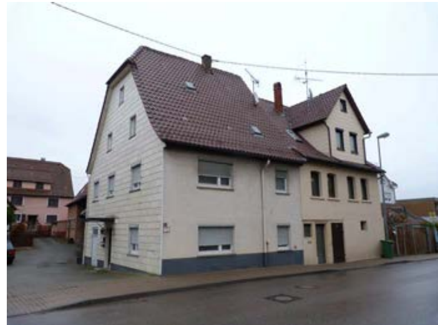
Ansicht von Südwesten (linker teil)
