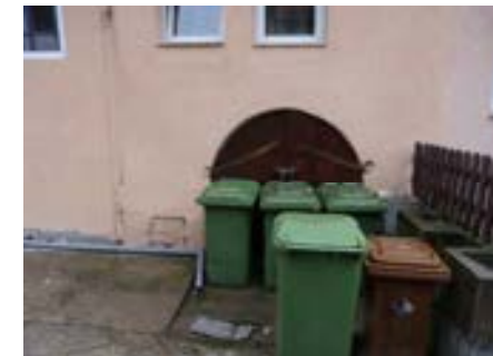
Kellertor an Westseite
