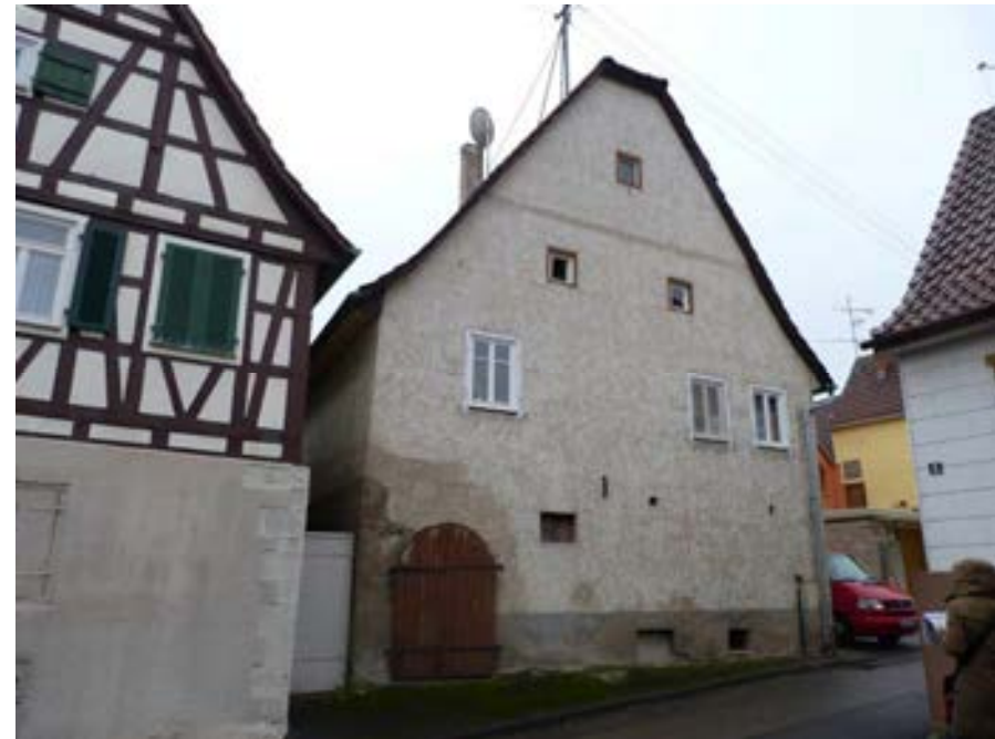
Ansicht von Norden
