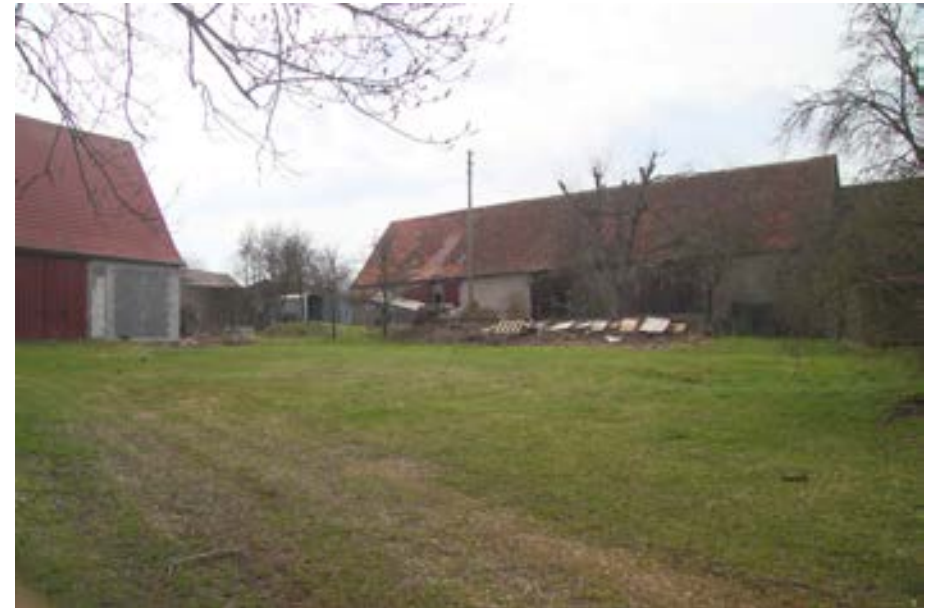
Blick von Nr. 17 nach SW, vor der Scheune Reste von HS.Nr. 16
