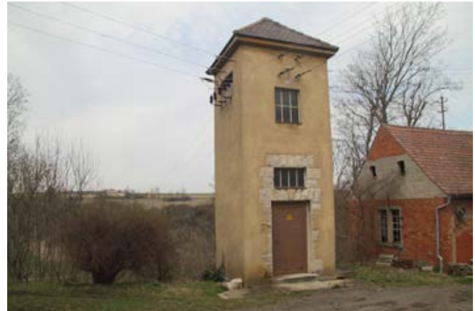
Seitenansicht, Trafostation mit Werkstattbau Nr. 46 im Hintergrund
