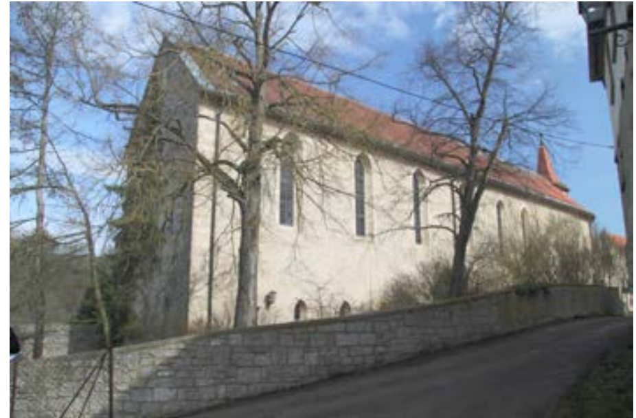
Alte Kirchhofmauer an der Klosterkirche, Blick auf die Südfassade
