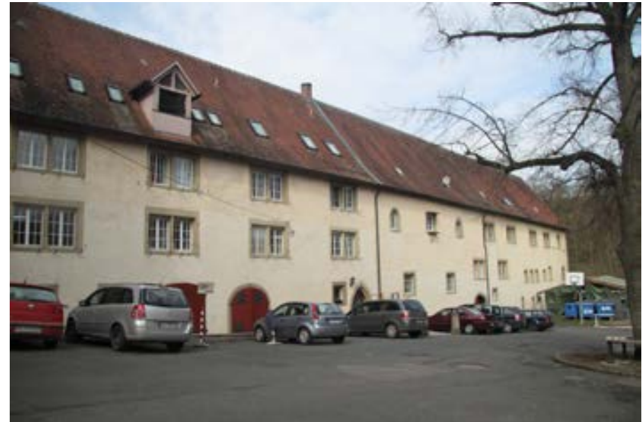
Hauptfassade gegen den Innenhof
