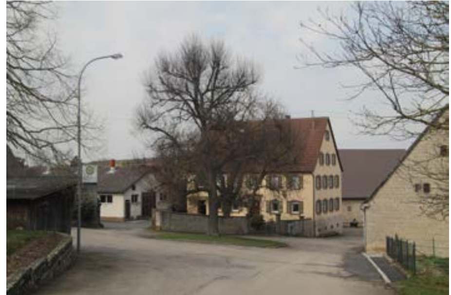
Blick von Nr. 17 nördliche Richtung, platzartige Aufweitung mit Linde
