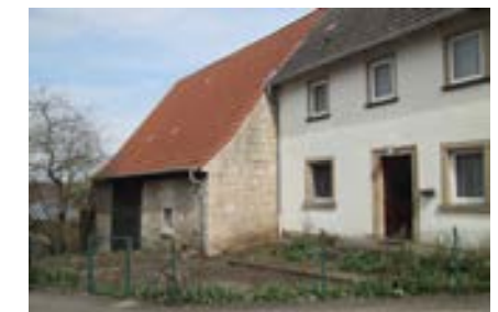
Wohnhaus mit Stallscheune
