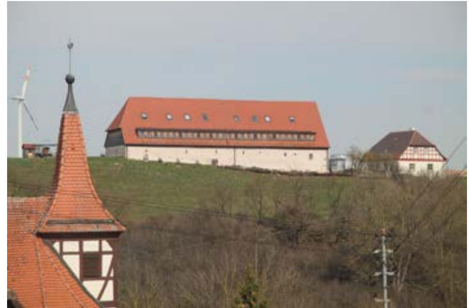
Blick auf die Hofanlage mit Schafscheune (links) oberhalb des Ortes
