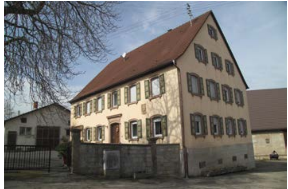
Eckansicht, Hauptfassade und Giebel des Wohnhauses mit Hofmauer
