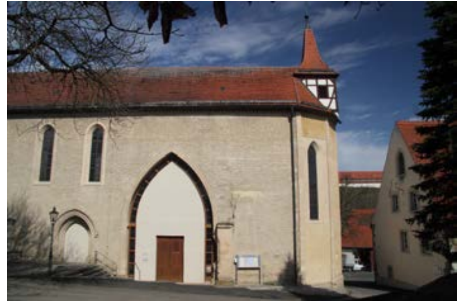
Doppelkirche mit Dachreiter, Ansicht von der Hauptstraße aus
