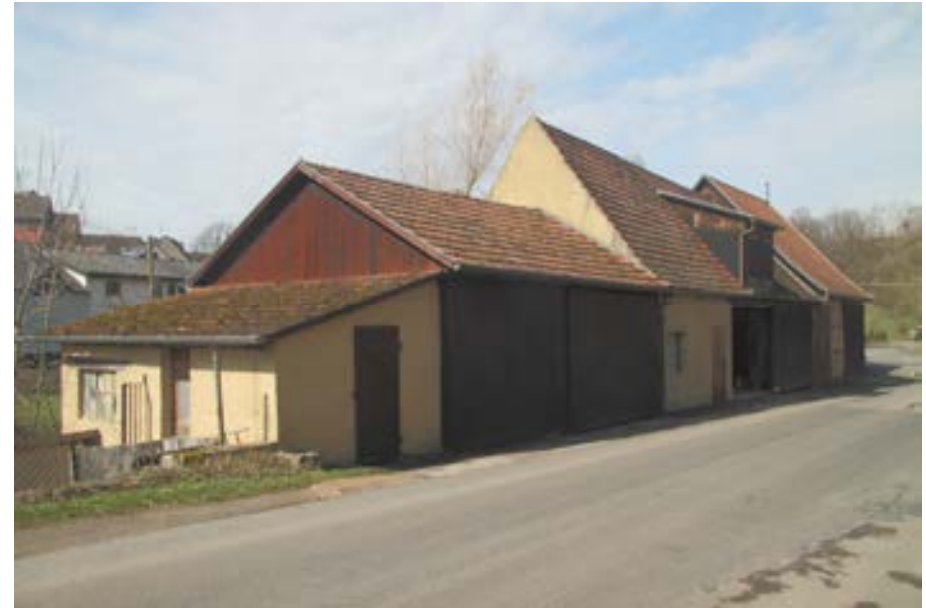
Scheunenreihe am Ortseingang, von links nach rechts Nr. 48, 49 und 65
