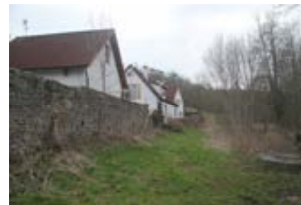
Dorfmauer westlich von Hs. Nr. 3 und 4
