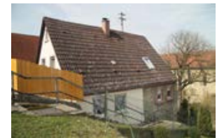
Seitenfassade von Südost
