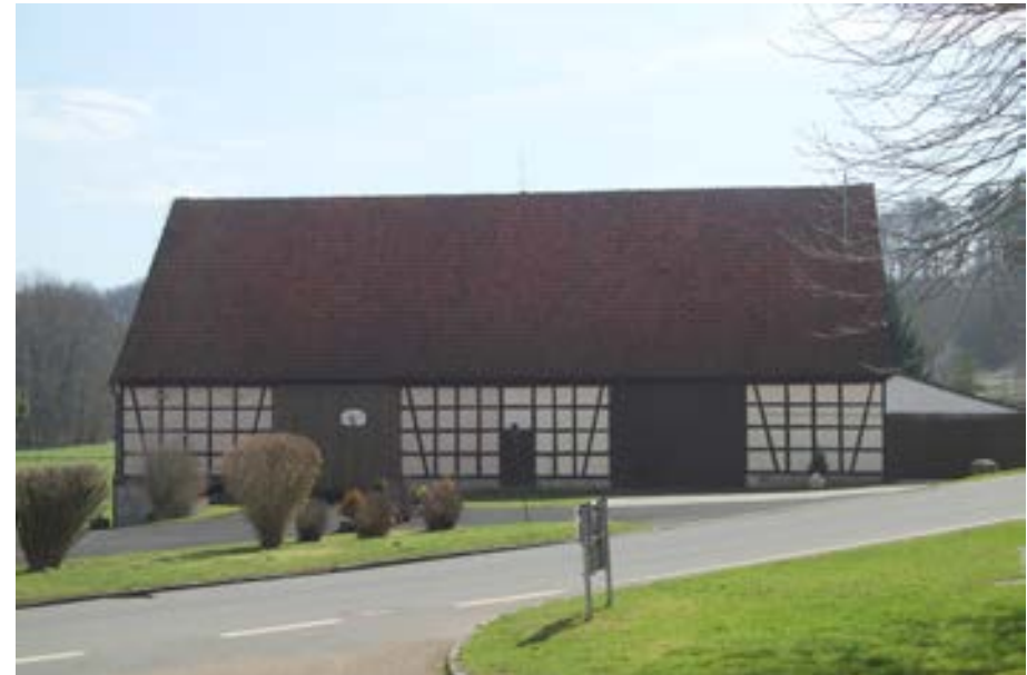
Scheunen Nr. 43/1 (links) und 43/2 mit Anbau (rechts)
