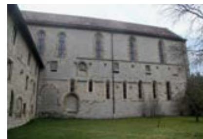
Spuren des Kreuzganges, Nordfassade
