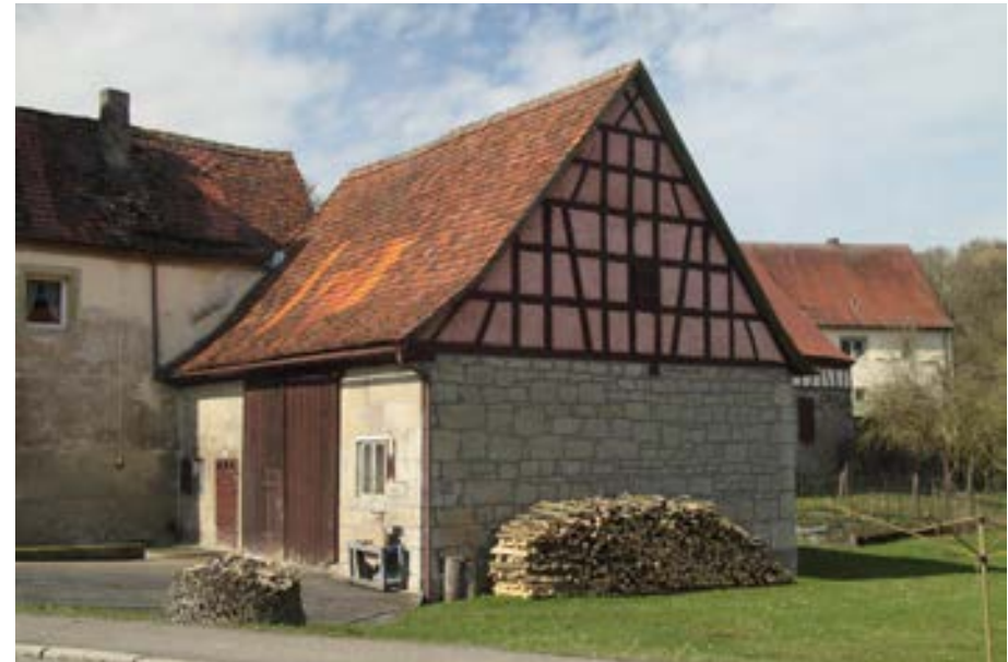
Seitenansicht, Scheune mit traufseitiger Tenne und Fachwerkgiebel
