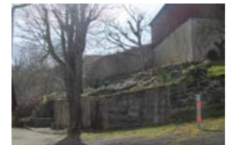
Dorfmauer südlich Hs. Nr. 23
