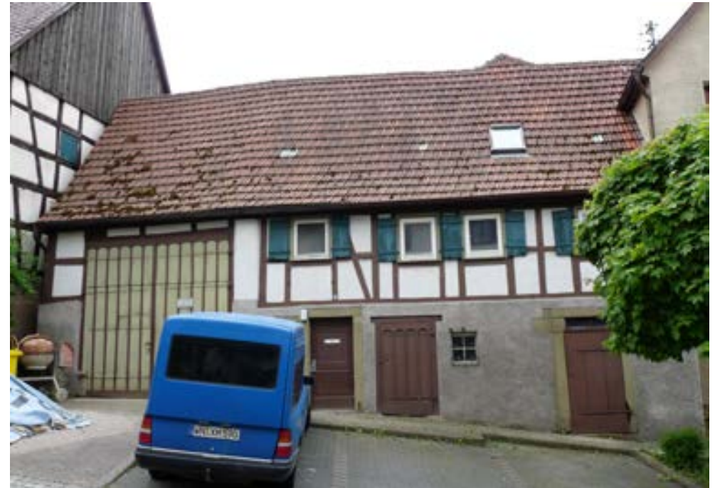
Wohn- und Wirtschaftsgebäude, Straßenansicht
