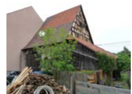
Scheune zu Gebäude Nr.12
