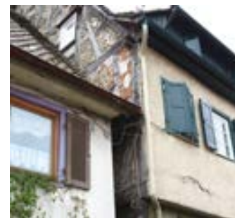
Fassade zu Gebäude Nr. 12
