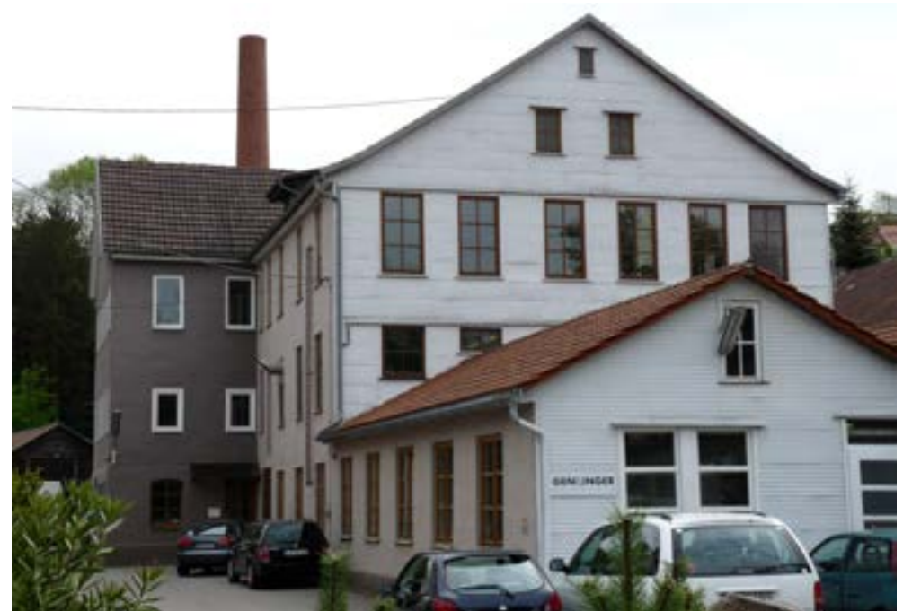
Gewerbliches Gebäude, Westansicht
