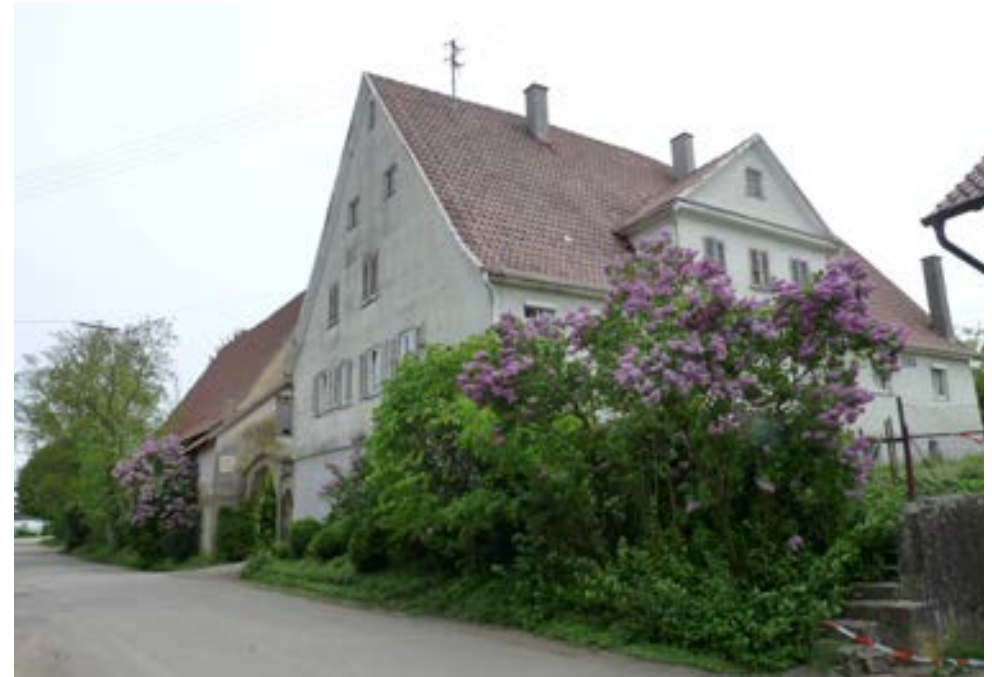
Wohn- und Wirtschaftsgebäude mit Torbogen, Straßenansicht
