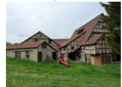
Stall (li.) und Scheune (re.), Ostansicht
