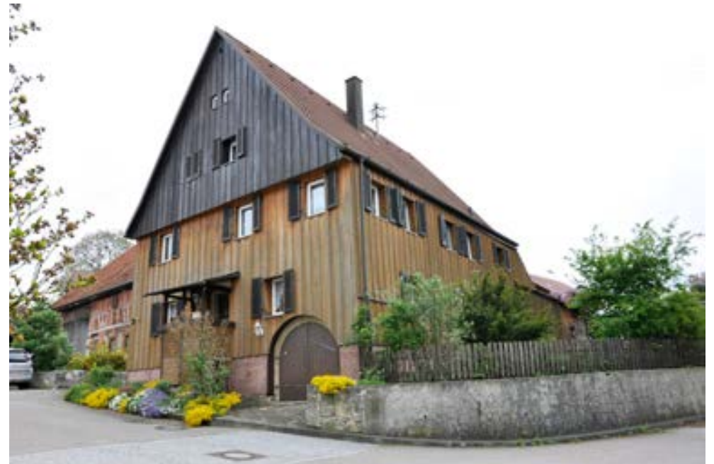
Wohngebäude Nr. 30, Straßenansicht
