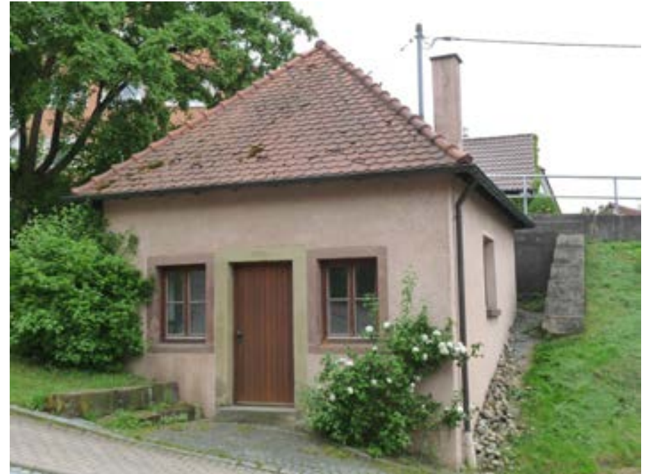
Ehemaliges Backhaus, Straßenansicht
