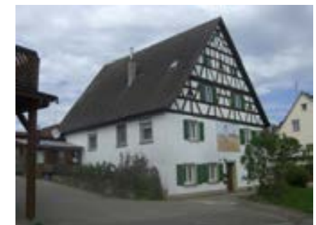
Südlicher Dachstuhl mit Sichtfachwerk
