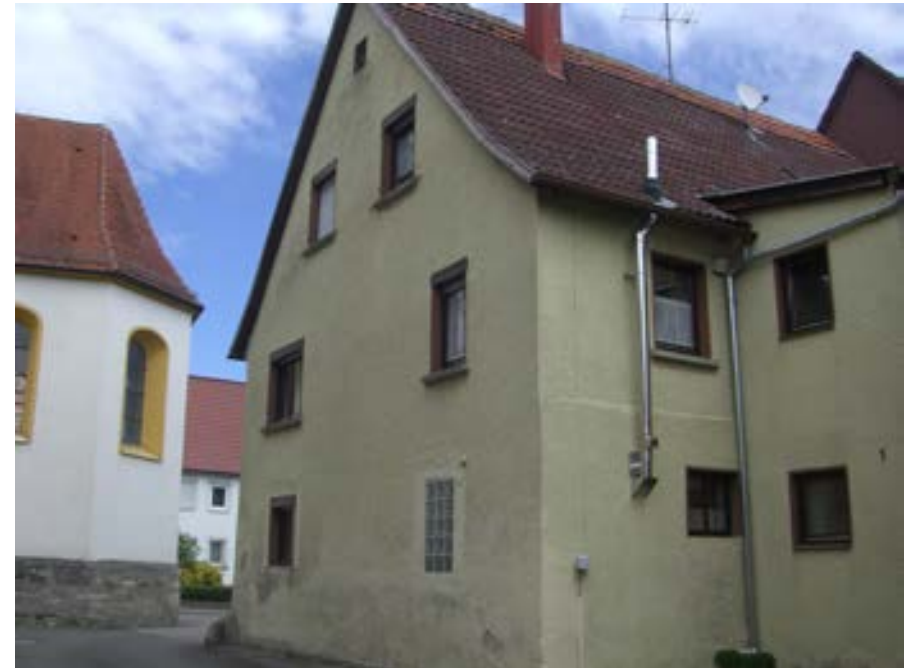
Verengter Straßenraum unmittelbar neben der Kapelle St. Gangolf
