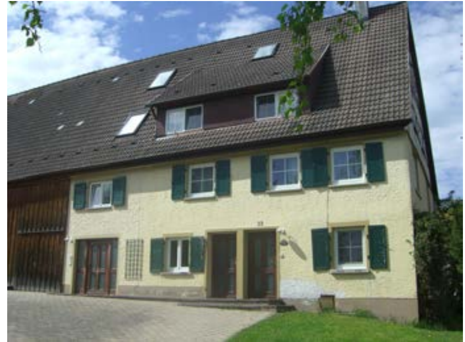
Südfassade des Wohnteils
