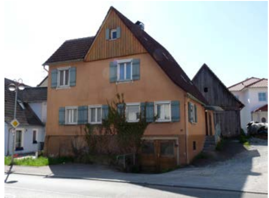
Ansicht von der Hauptstraße
