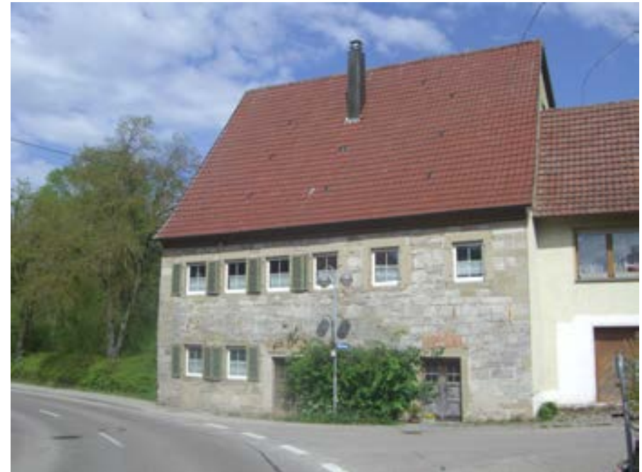
Blick auf die Westfassade
