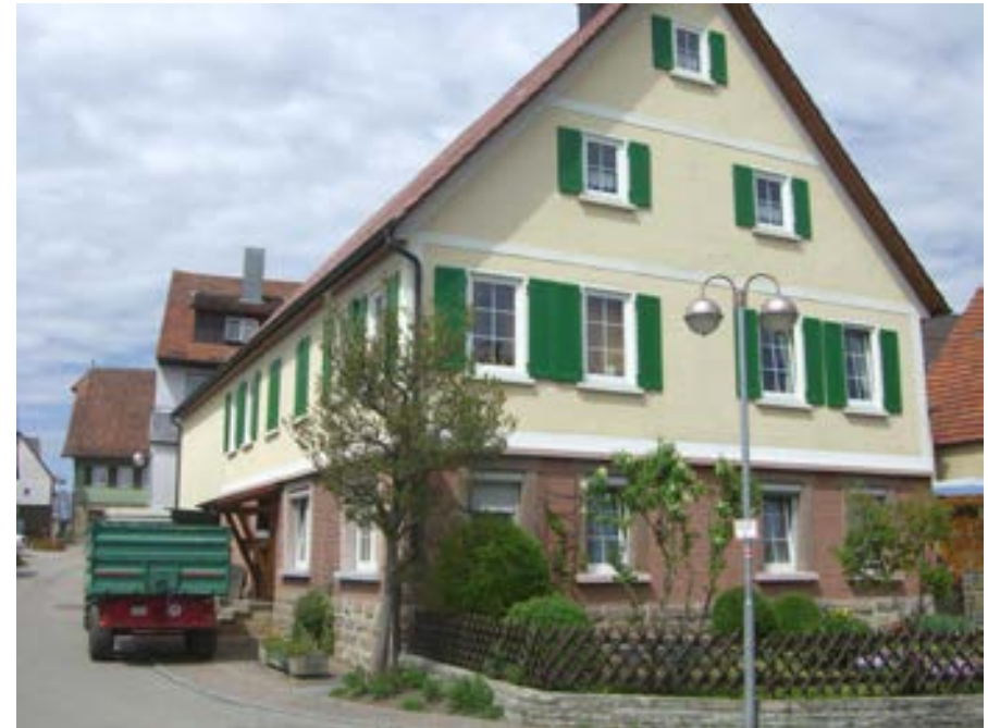
Ecksituation Ziegelstraße - Seestraße
