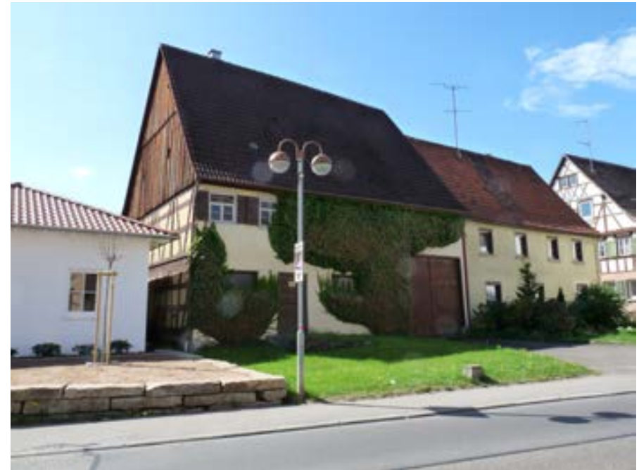
Wohn- und Ökonomieteil – Blick von der Hauptstraße
