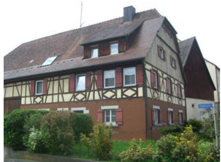
Blick von der Hauptstraße
