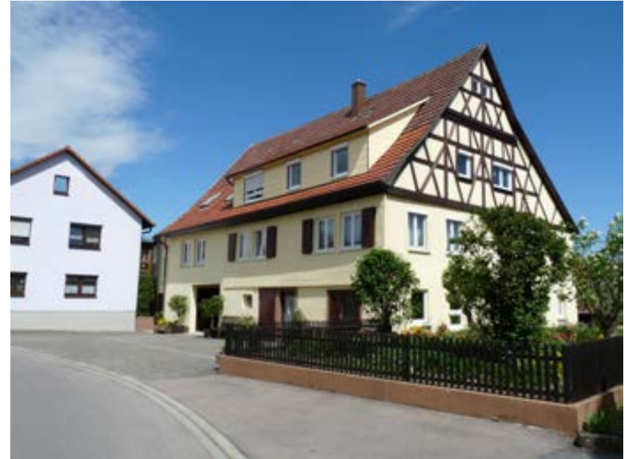
Blick auf Süd- und Westfassade
