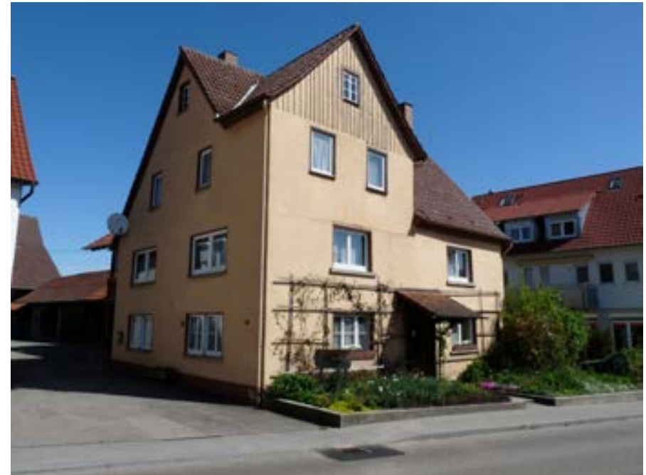
Süd- und Westfassade
