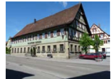
Blick von Südosten
