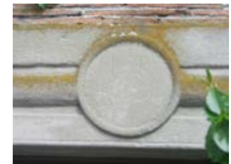
Detail über dem Eingang
