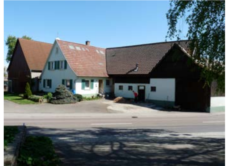
Ansicht mit Scheune, Wohn- und Ökonomieteil
