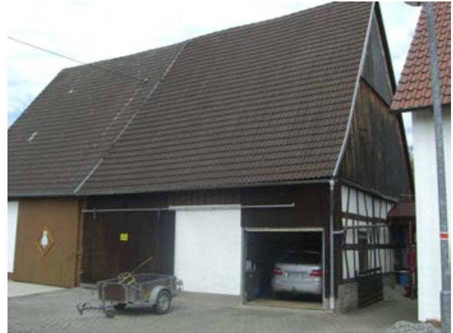
Südliche Giebelseite mit Sichtfachwerk
