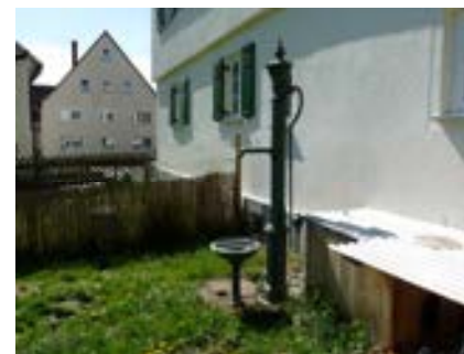
Brunnenstock hinter dem Gebäude
