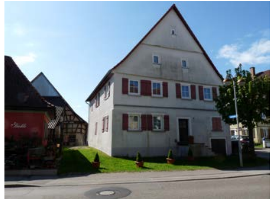
Straßenansicht mit benachbartem ehem. Arrestgebäude
