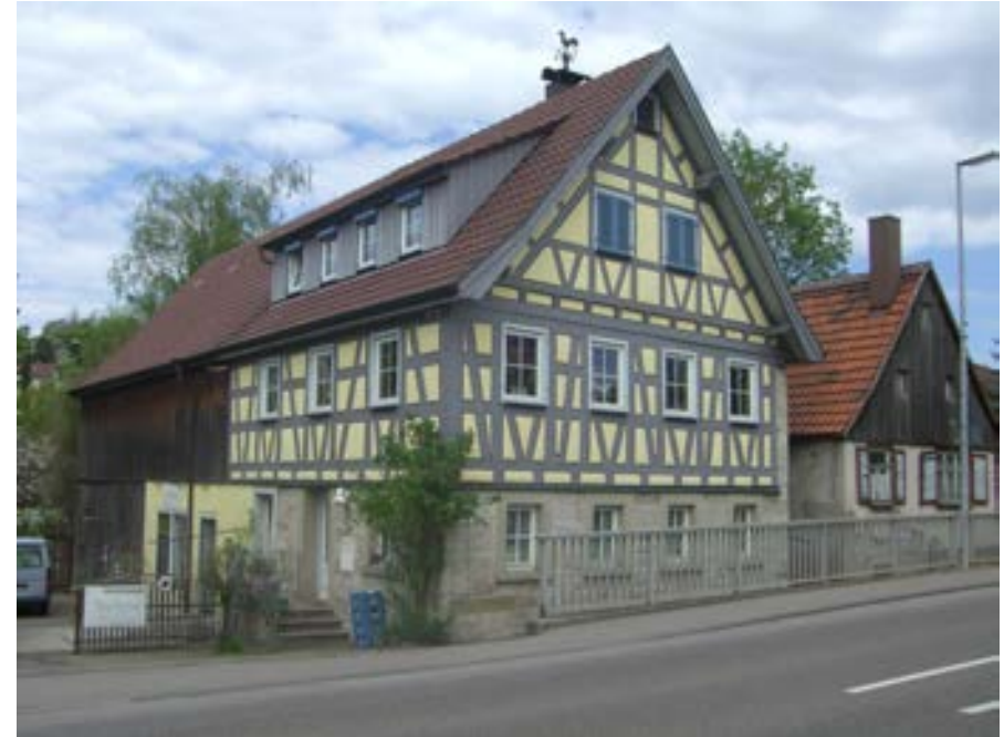
Blick auf Wohn- und Ökonomieteil
