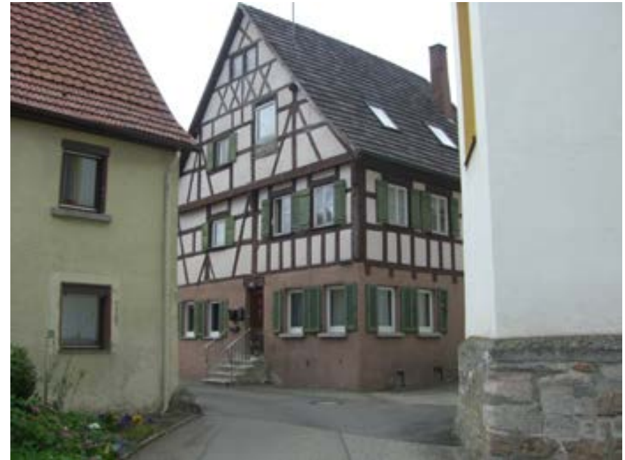
Blick von der Hauptstraße
