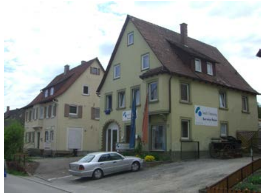
Ansicht von der Hauptstraße
