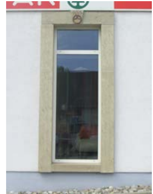
Sandsteintürgewände an der Südfassade
