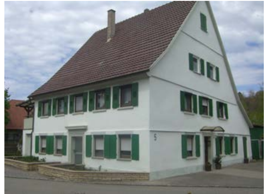
Giebelansicht von Süden, westliche Traufseite
