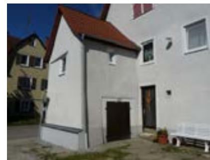
Anbau an südlicher Giebelwand
