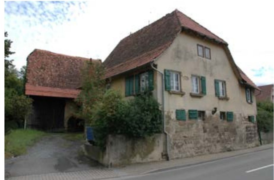
Ansicht von Nordwest mit Blick in den Hof
