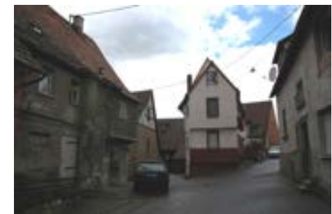
Giebelansicht von Westen
