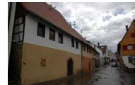
Blick in die Oststraße mit Nr,3, 5, 7, 9
