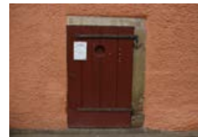
Stalleingang im Hanggeschoss
