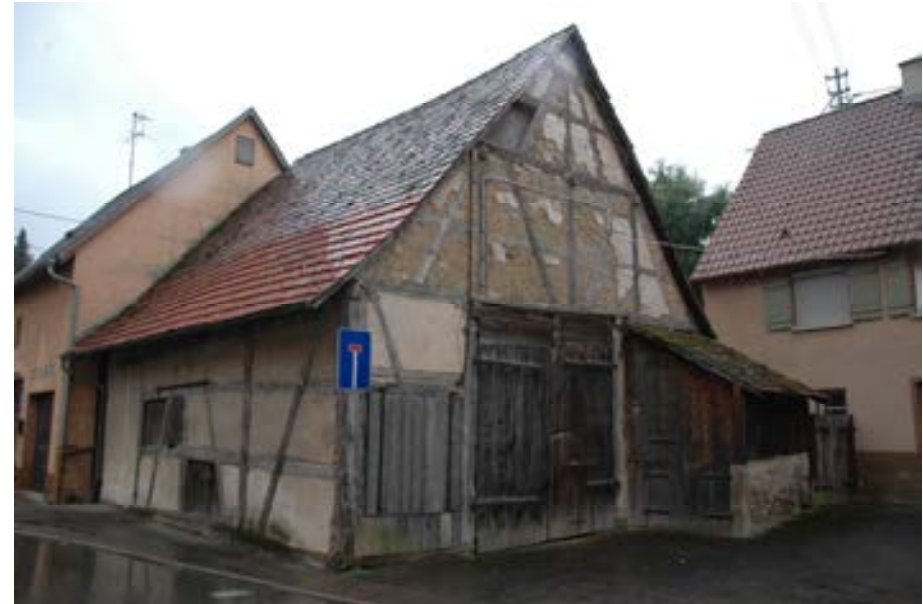
Ansicht von Nordwest
