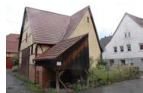
Scheune mit Schweinstall von Nr. 6
