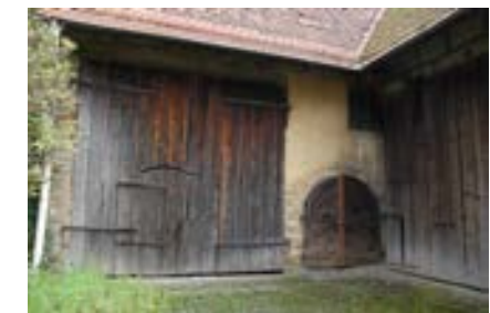
Scheune mit Kellerzugang
