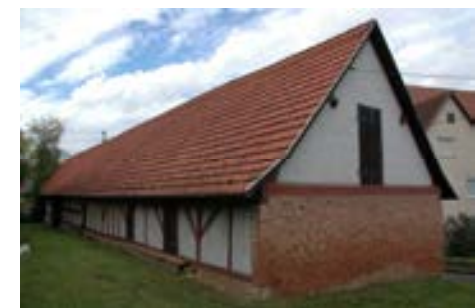
Rückfassade und Giebelfront von NO
