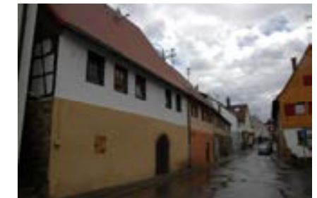
Blick in die Oststraße mit Nr,3, 5, 7, 9
