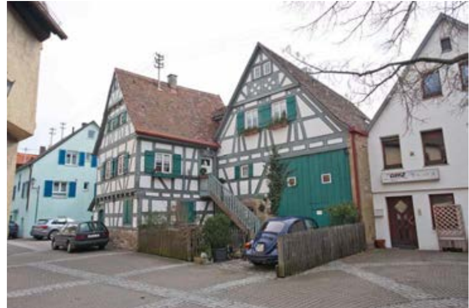
Ansicht gegen NW, gegen die angerartige Aufweitung
