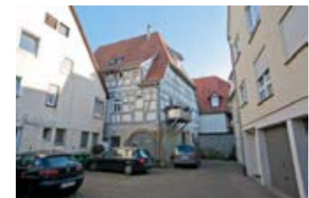
Blick auf die Rückfassade
