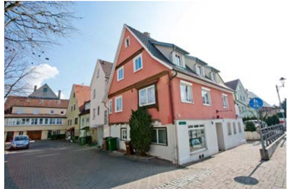
Ansicht von NW, gegen den alten Stadtgrabenbereich
