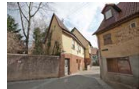
Erhaltenswertes Wohnhaus von NW
