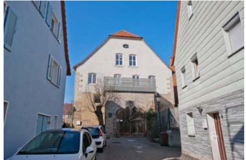
Blick auf den Südgiebel der ehemaligen Kronen-Scheuer
