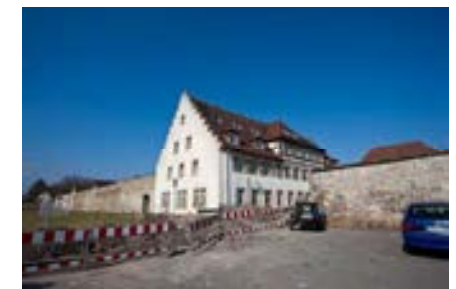
Ansicht gegen SO mit Treppengiebel
