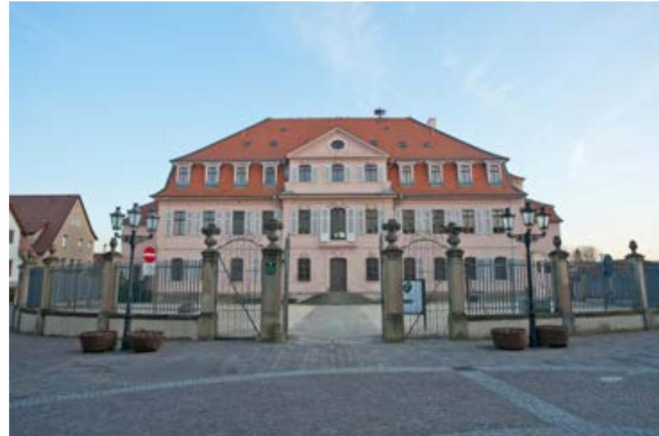
Ansicht Nordfassade, gegen die Stadt
