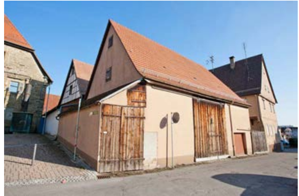
Hinten: Scheune zu Nr. 10 mit unverputztem Giebel, davor Scheune zu Nr. 12
