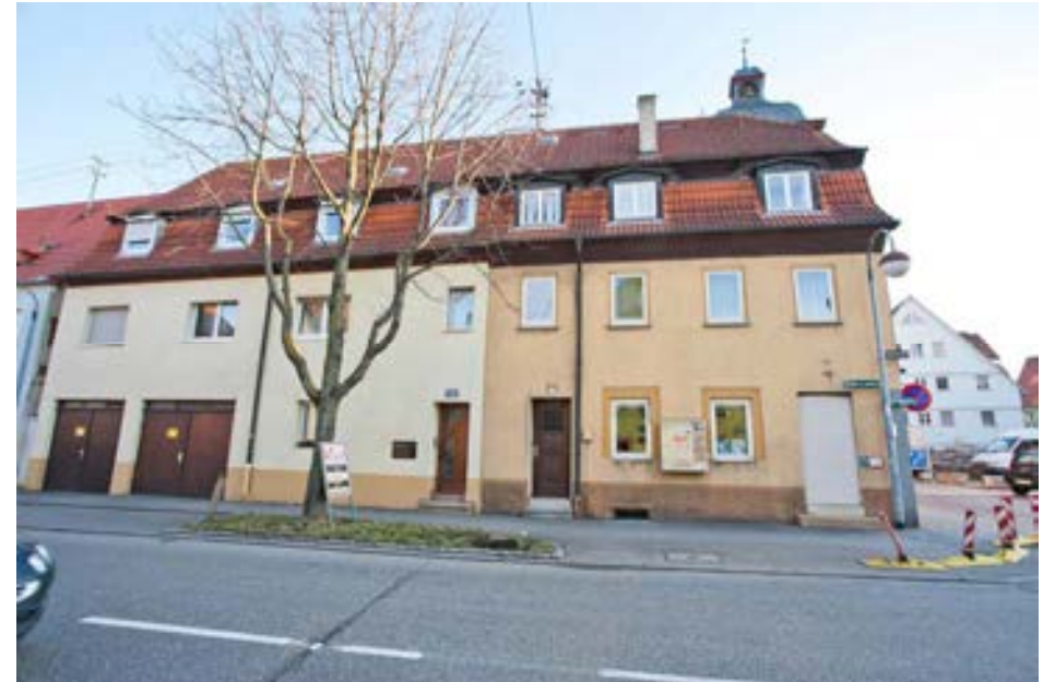
Ansicht gegen Norden, gegen die Karlstraße
