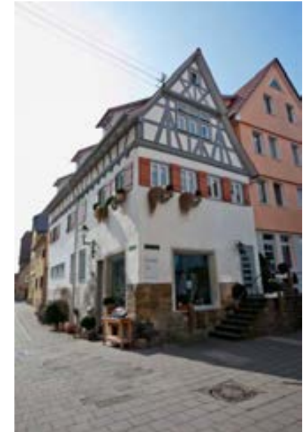
Ansicht gegen NO, links der Eingang zum Kirchplatz
