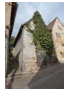
Nebengebäude an der Schloßstr.
