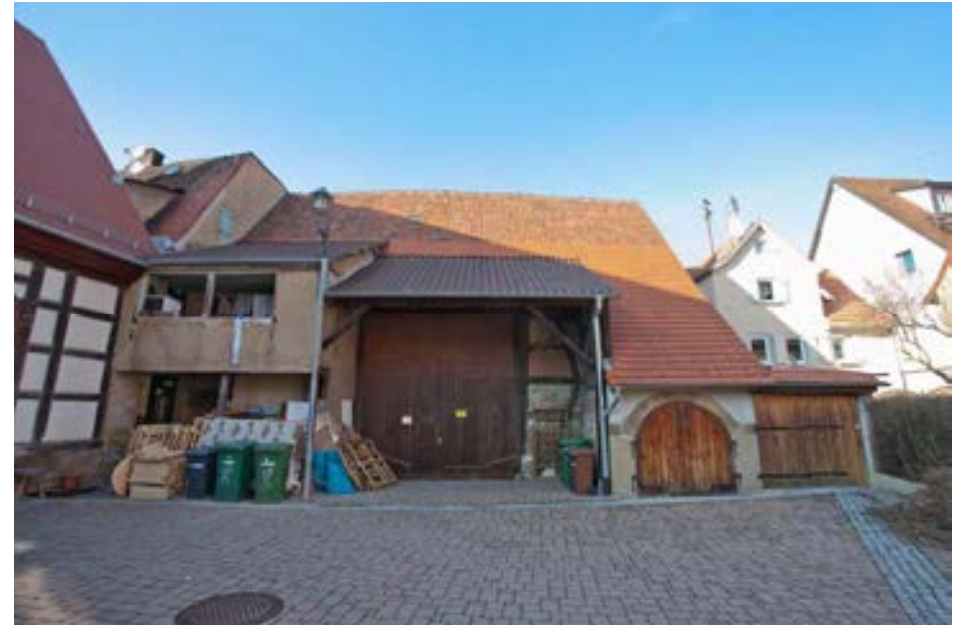
Die Hoffassade der Scheune Schmale Gasse 9 mit Kellerabgang Meiereihof 4
