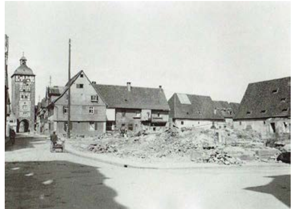
Brandplatz Hauptstraße Ecke Kirchstraße, Blick in Richtung Nordosten auf die ehemalige Gemminger- und die Neippergerkelter (aus: Damals und heute)
