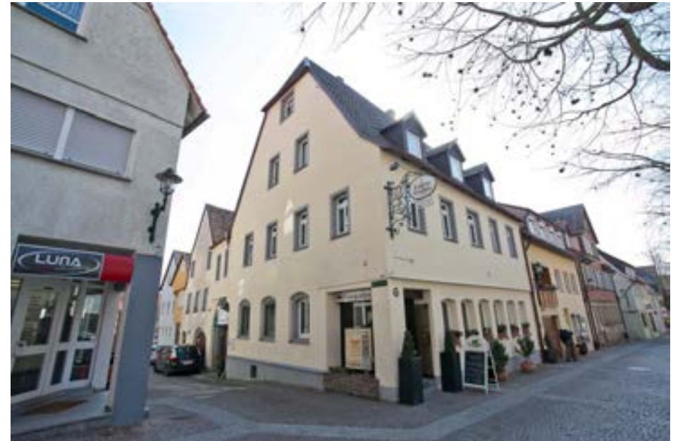
Eckgebäude an der Hauptstraße (Nr. 72)
