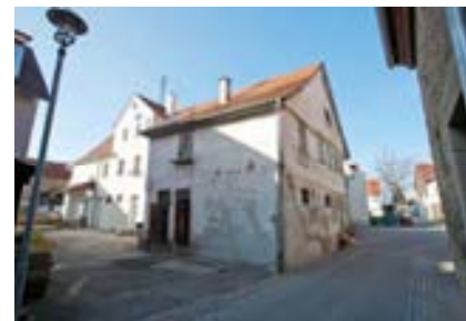
Blick auf die südl. Seitenfassade
