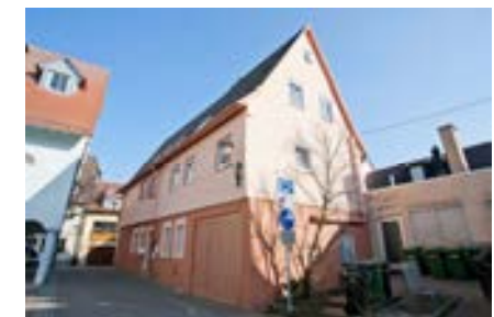
Blick auf die Rückfassade
