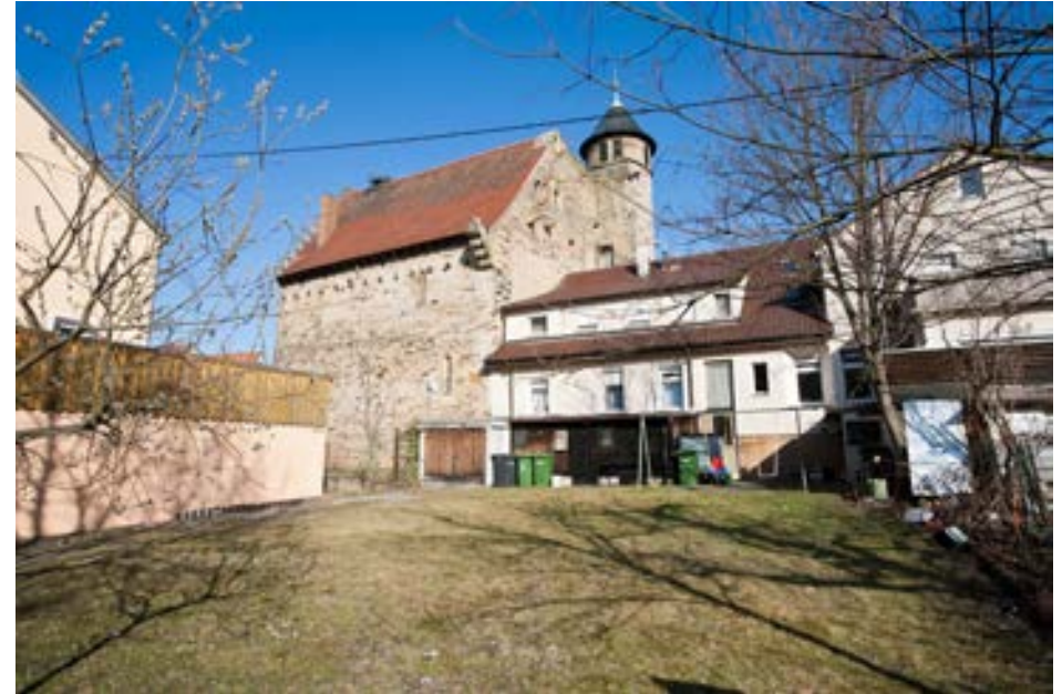
Ansicht gegen Westen mit ehemaliger Staufenburg
