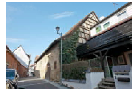
Nördlicher Abschnitt, Höhe Nr. 3
