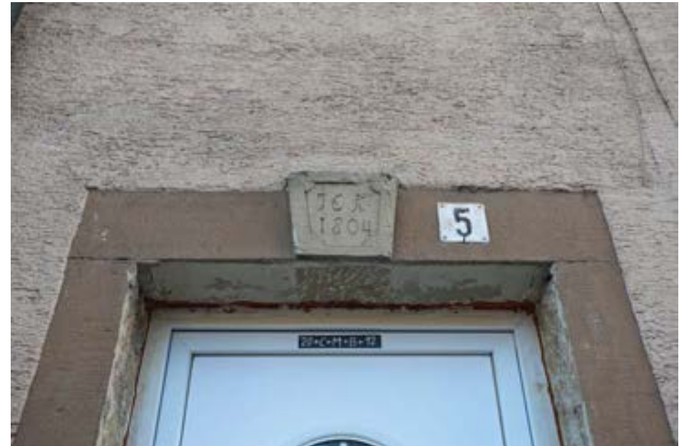
Der Keilstein am Türsturz des Wohnhauses
