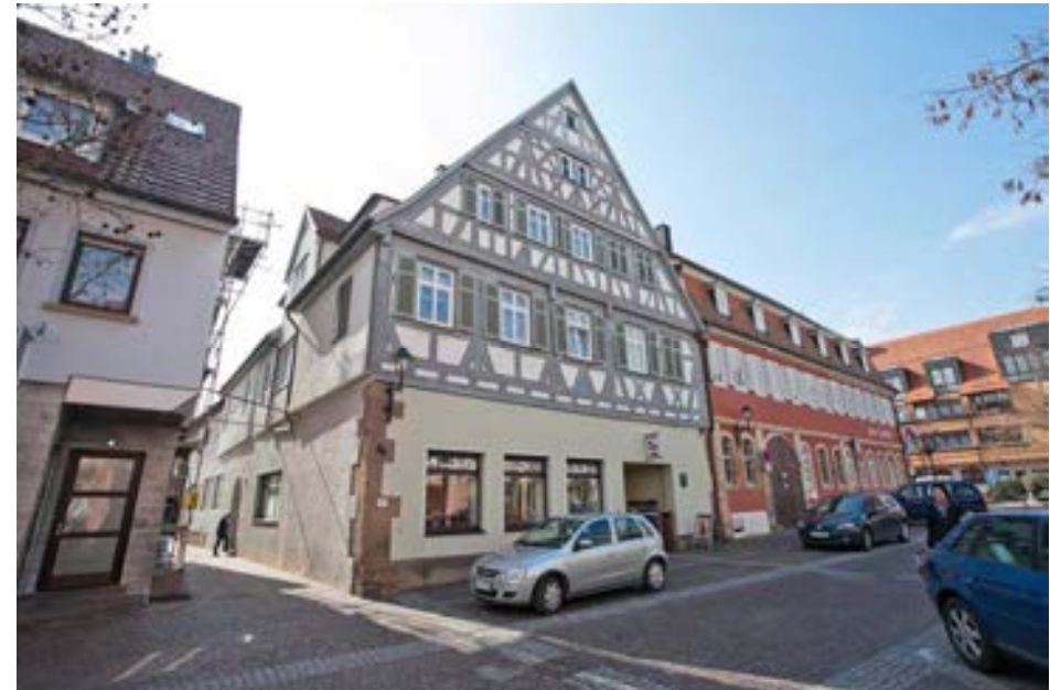
Ansicht gegen NO, links davon das Eckartsgäßle abgehend
