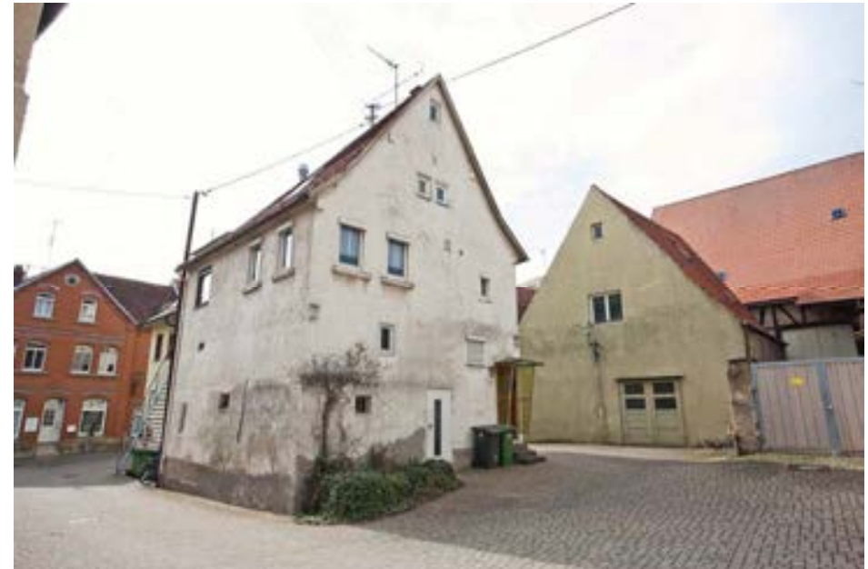
Ansicht gegen NO, dahinter verläuft die Schloßstraße
