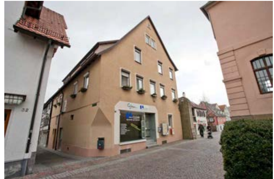
Ansicht gg. NW, im Hintergrund das alte Zollhaus (rot)
