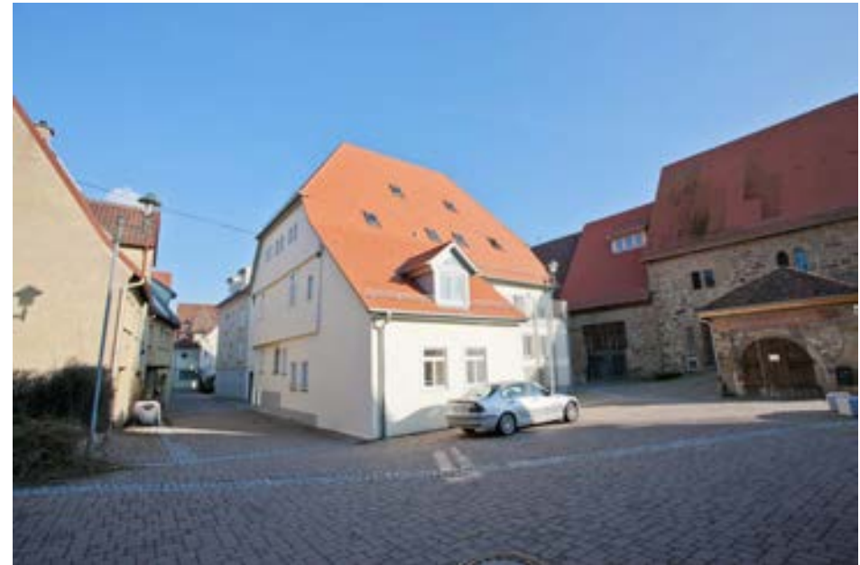
Blick in Richtung SO auf Nr. 6 (Mitte) und Nr. 7 (sog. Steinhaus)
