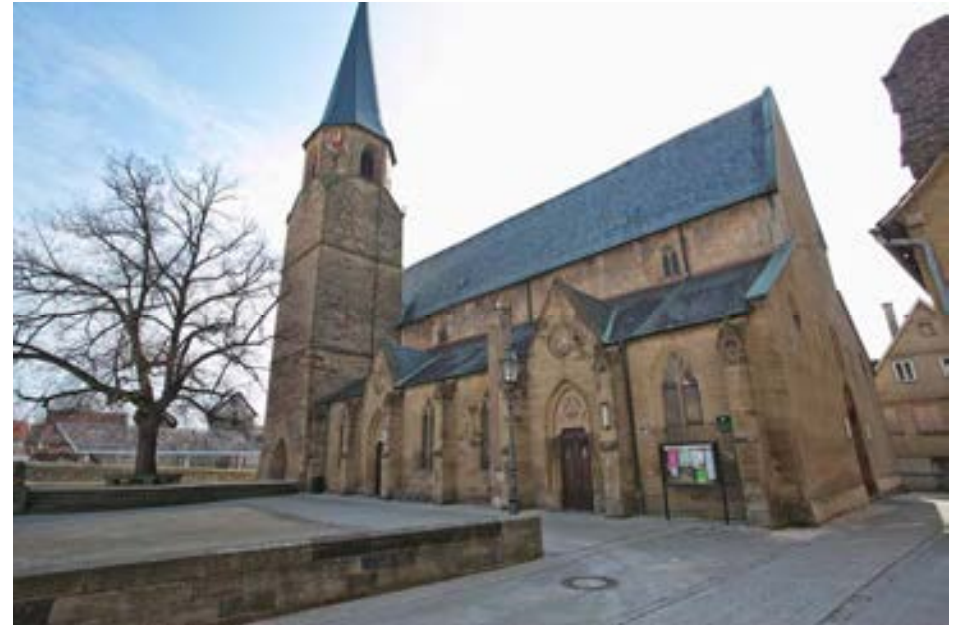
Blick von NW auf Turm, Mittelschiff und das neugotische Seitenschiff
