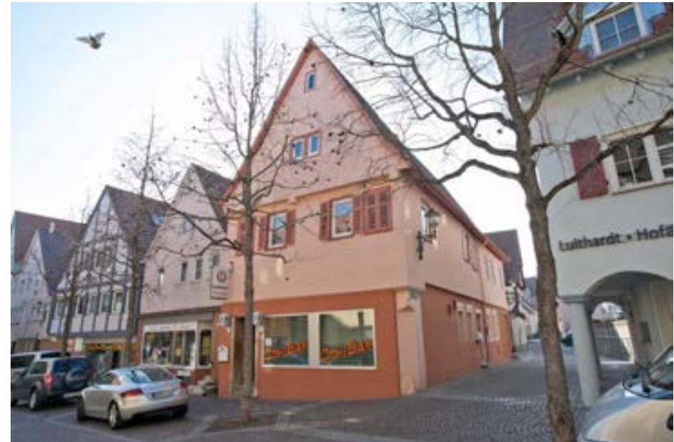
Ansicht von NO, rechts davon verläuft die Schmale Gasse
