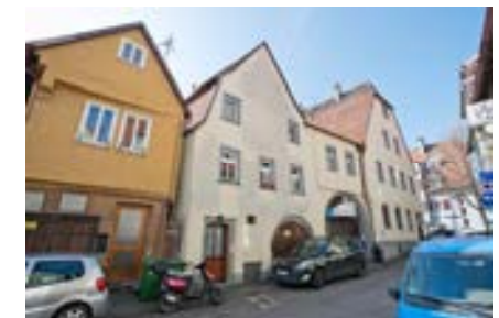
Wohnhaus Nr. 72a in der Ringstraße
