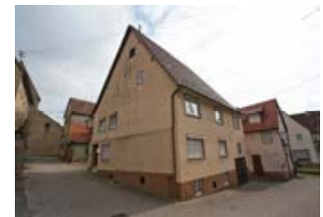
Höhe Nr. 6, in Richtung SO
