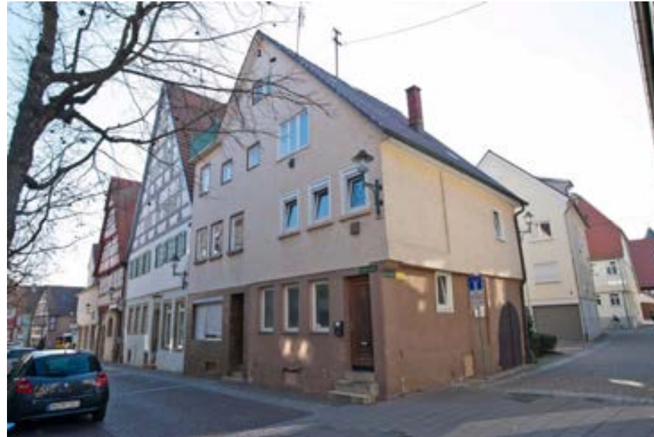
Ansicht gegen NO, rechts ein Blick in den Meiereihof
