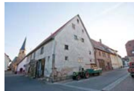
Ansicht des Ökonomieteils gg. NO
