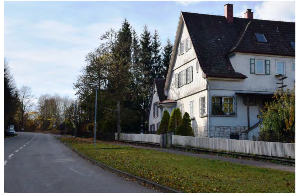
Buchheimer Straße Richtung Südwesten mit nordwestlicher Bebauung
