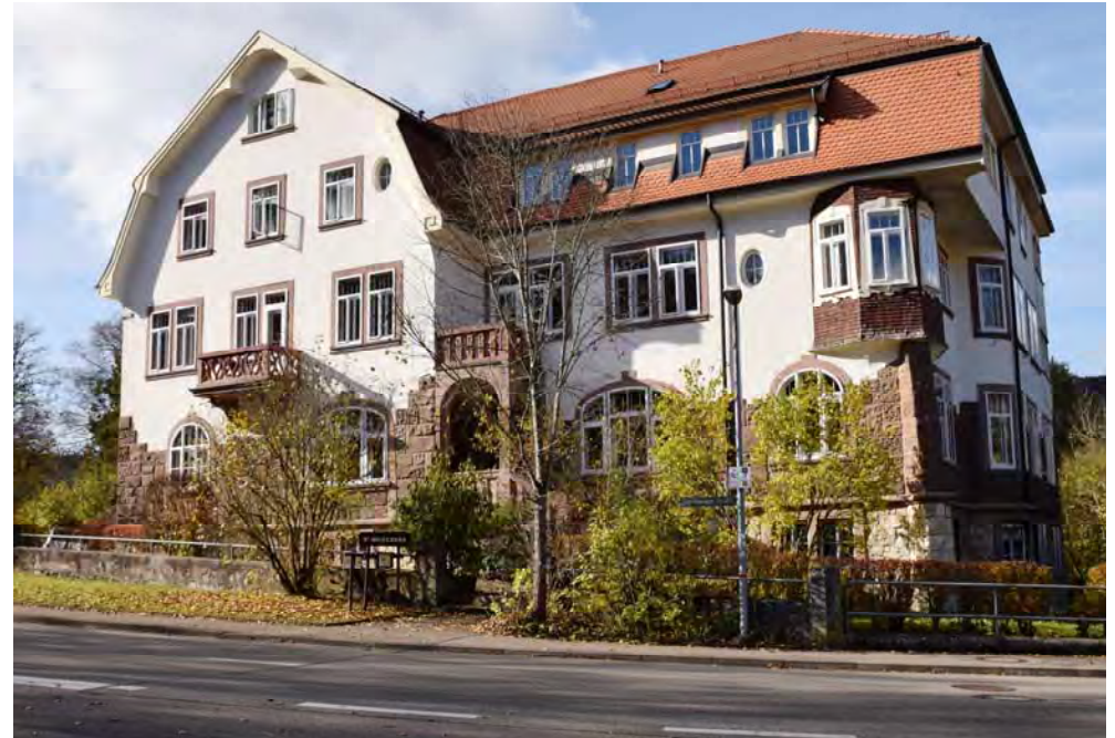
Ostansicht von der Buchheimer Straße
