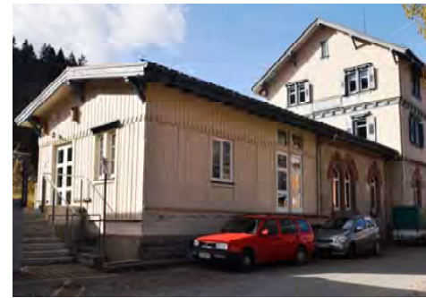
Empfangsgebäude mit Güterschuppen von Osten
