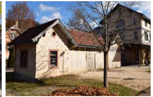
Ehem. Abortgebäude von Südwesten mit Empfangsgebäude im Hintergrund
