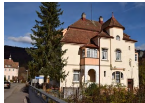
Südansicht zur Bahnstrecke
