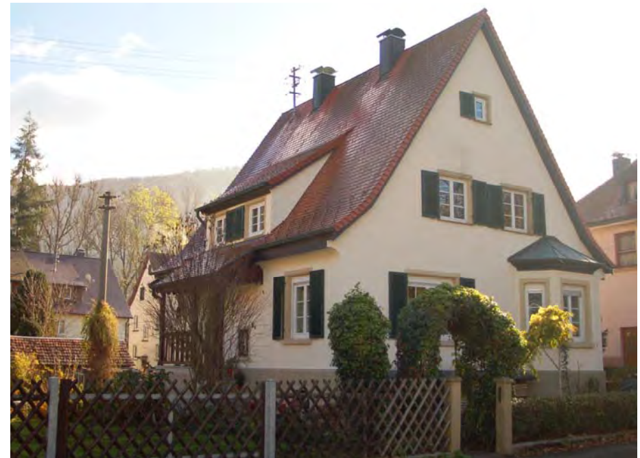
Ansicht von Nordwesten gegen die Straße
