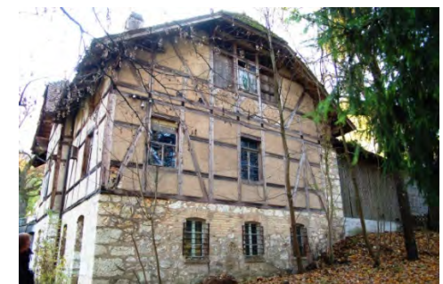
Nordostansicht des Remisen- und Wirtschaftsgebäudes
