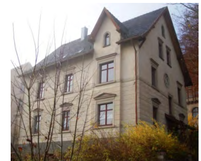
Ansicht von der Talseite
