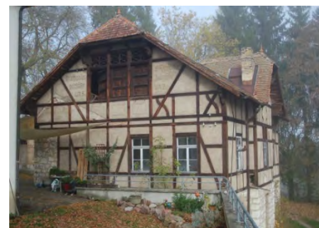
Südostansicht des Remisen- und Wirtschaftsgebäudes
