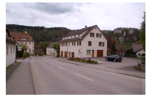
Oberer Südabschnitt mit ostseitiger Fehlstelle
