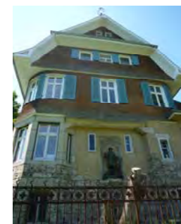
Nordansicht zur Bahnstrecke
