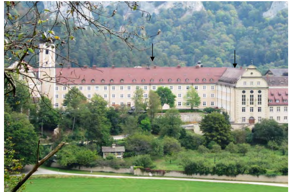
Mittelbau und Südflügel (rechts)
