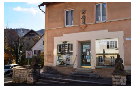
Hauptansicht von Norden gegen Wolterstraße
