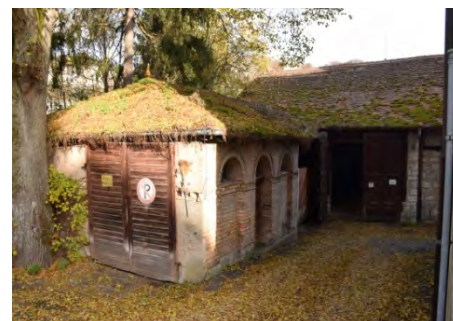
Westansicht des Aborthäuschens zur Abteistraße
