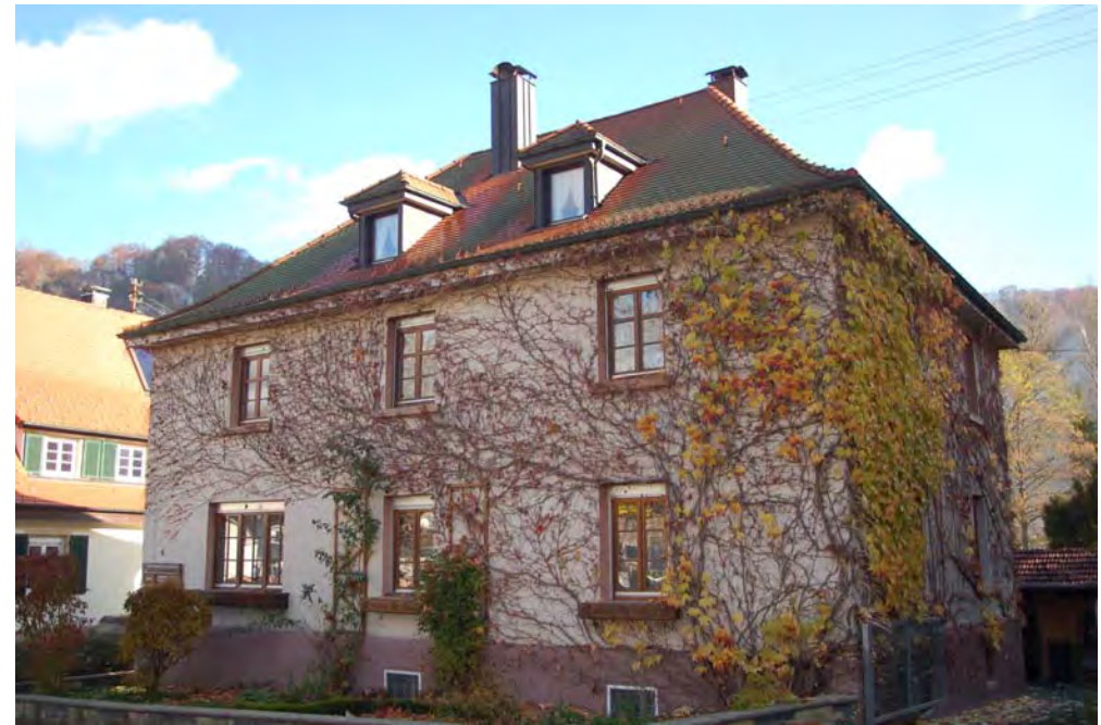
Ansicht von Südwesten gegen die Straße
