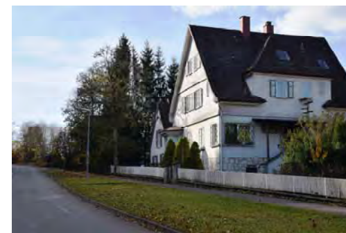
Ansicht von Norden
