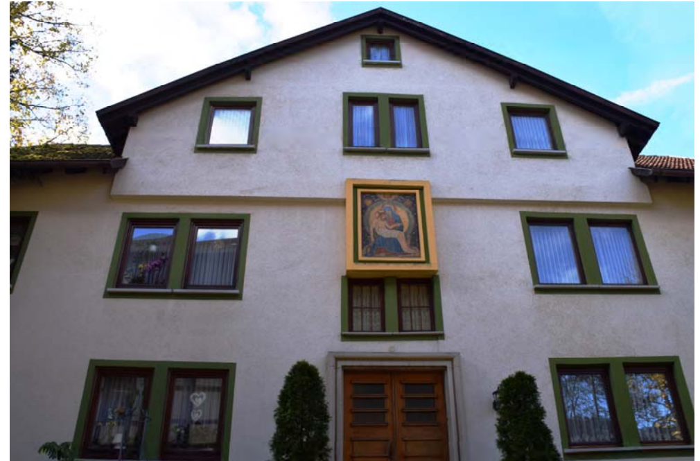
Gesamtansicht gegen Osten
