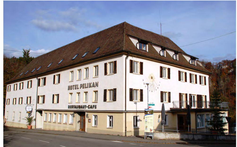
Ansicht von Südwesten, vom Abteivorplatz
