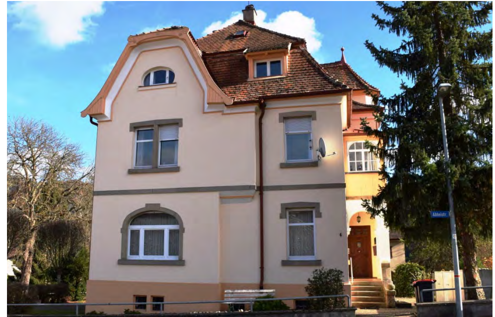
Westansicht zur Abteistraße
