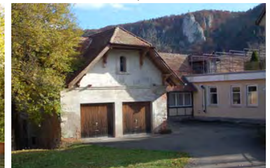
NW-Ansicht mit modernisiertem Remisenteil
