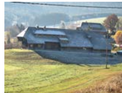
Ansicht der ehemaligen Mühle von Norden
