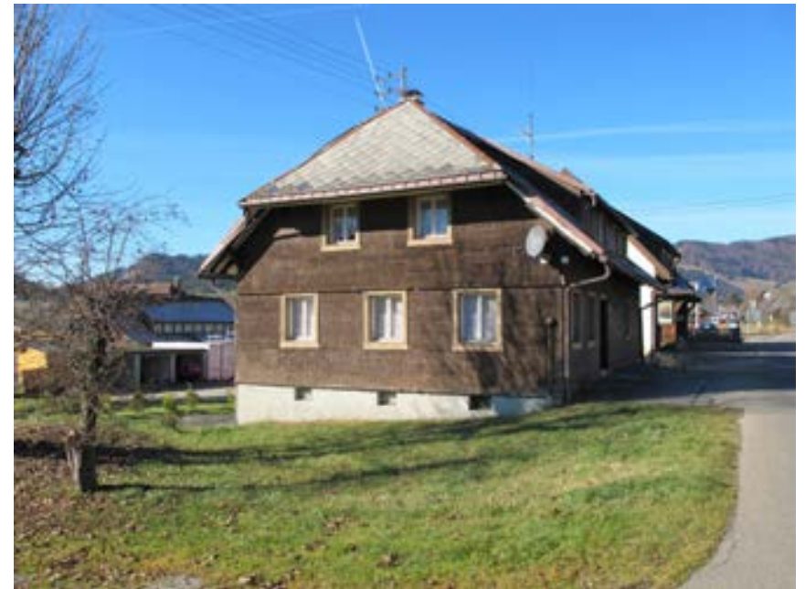
Ansicht des Wohnhauses von Osten
