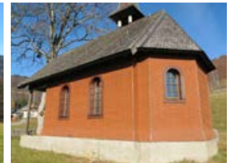
Ansicht der Kapelle von Südosten
