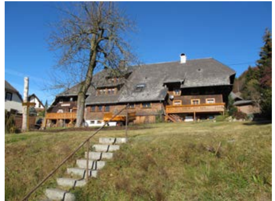
Ansicht des Doppelhofes von Süden
