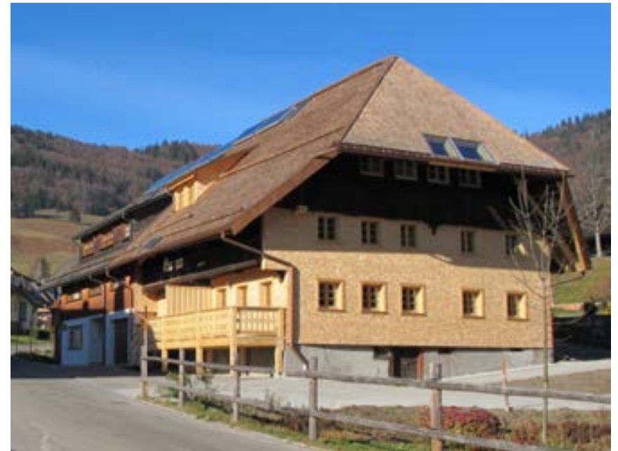
Ansicht des Schwarzwaldhofes von Südosten
