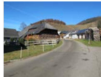
Blick nach Norden bei Hausnr. 24
