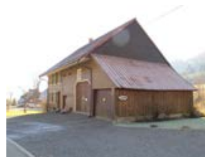
Ansicht des Ökonomieteils von Nordwesten
