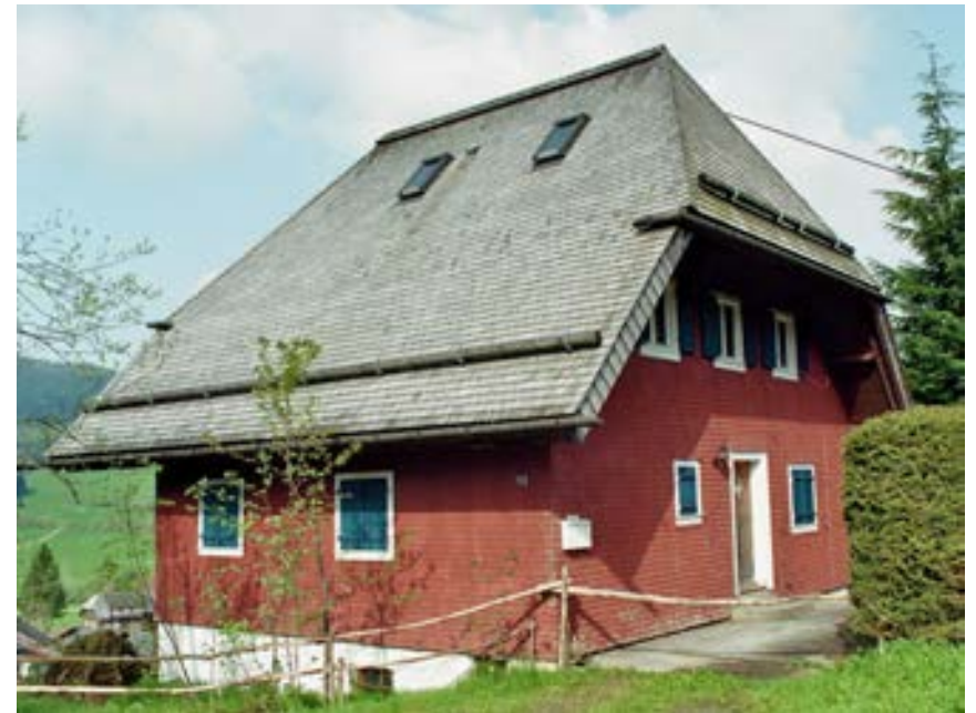
Ansicht des Wohnhauses von Nordosten
