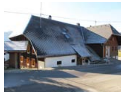
Ansicht des Doppelhofes von Nordosten
