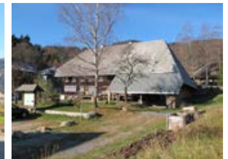
Ansicht des Hofes von Osten
