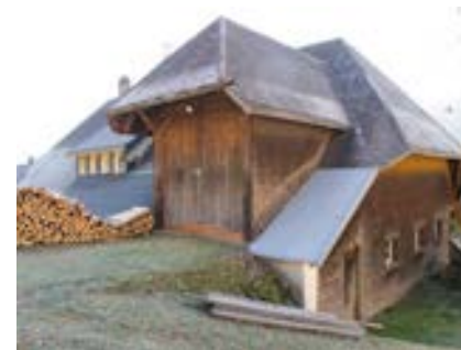
Ansicht der Hocheinfahrt von Nordwesten
