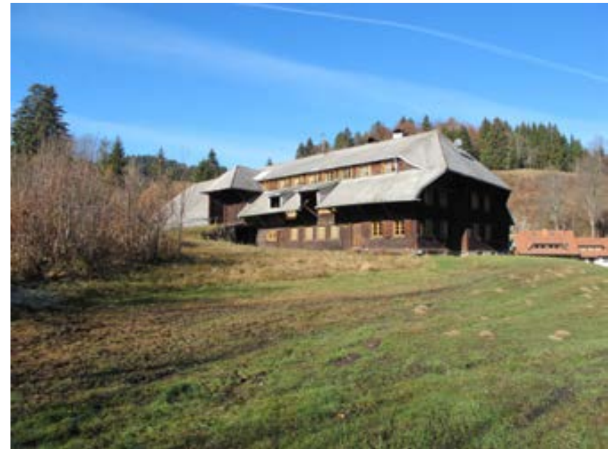
Ansicht der ehemaligen Mühle von Südosten
