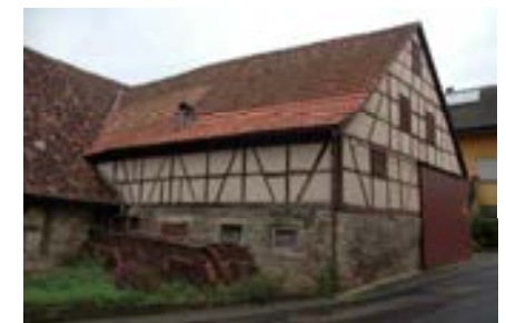
Nr. 11, Ansicht von Südosten
