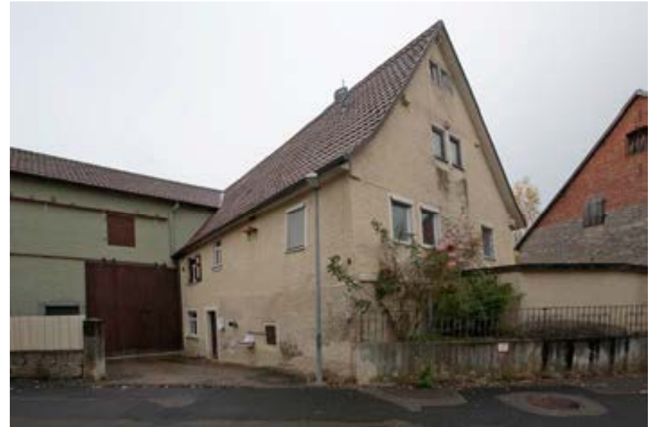
Ansicht gegen Südosten
