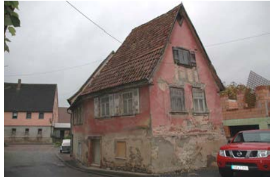
Ansicht von Osten, im Hintergrund verläuft die Hauptstraße
