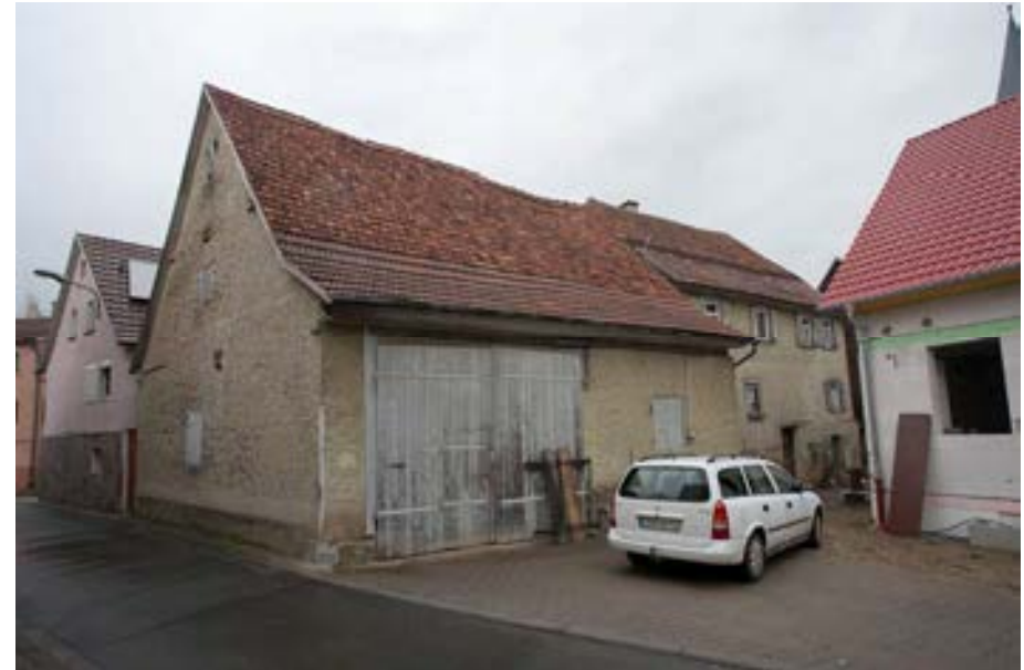
Gesamtansicht von Südwesten mit Scheune und Wohnhaus
