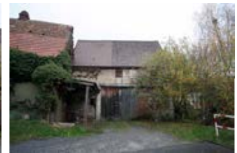
die erhaltenswerte Scheune
