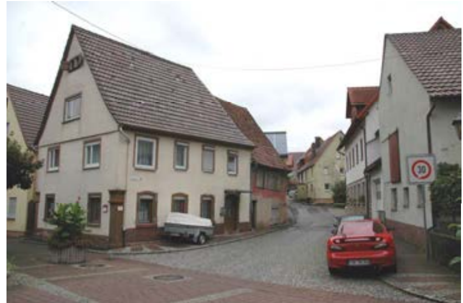
Höhe Hauptstraße, Blick in östliche Richtung
