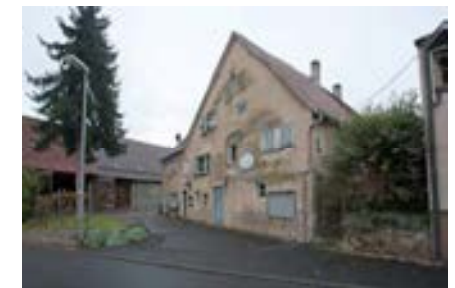
Wohnhaus und Scheune Nr. 30
