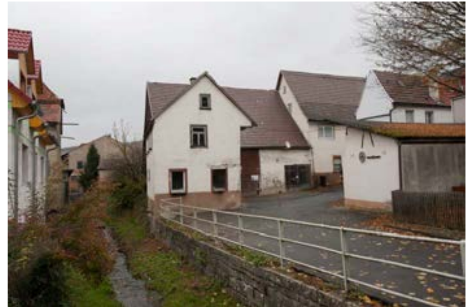
Ansicht von Südwesten, Höhe Lochbach
