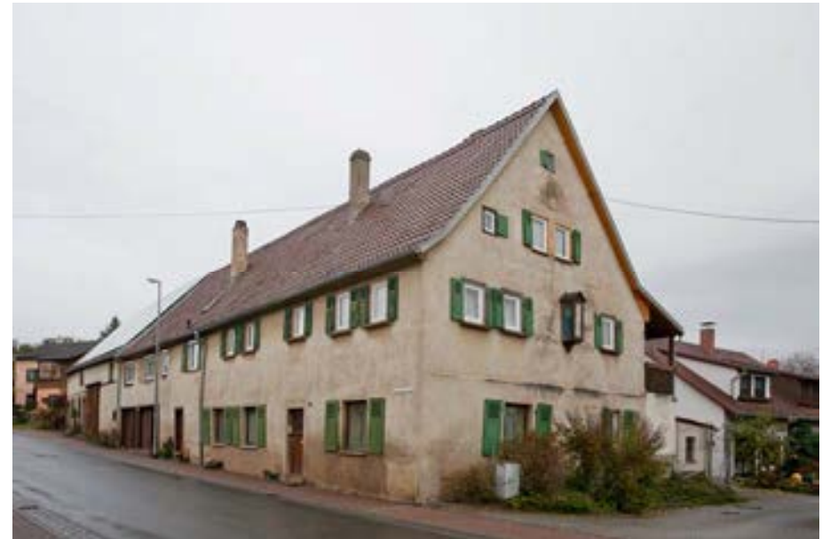
Gesamtansicht von Südosten
