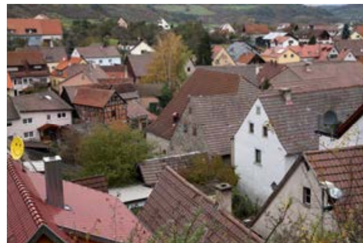
Dachlandschaft Höhe Hauptstraße 68 / Weingasse 25
