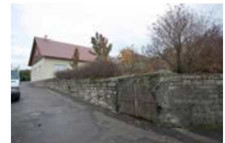
Fundamentrest mit Kellerbogen
