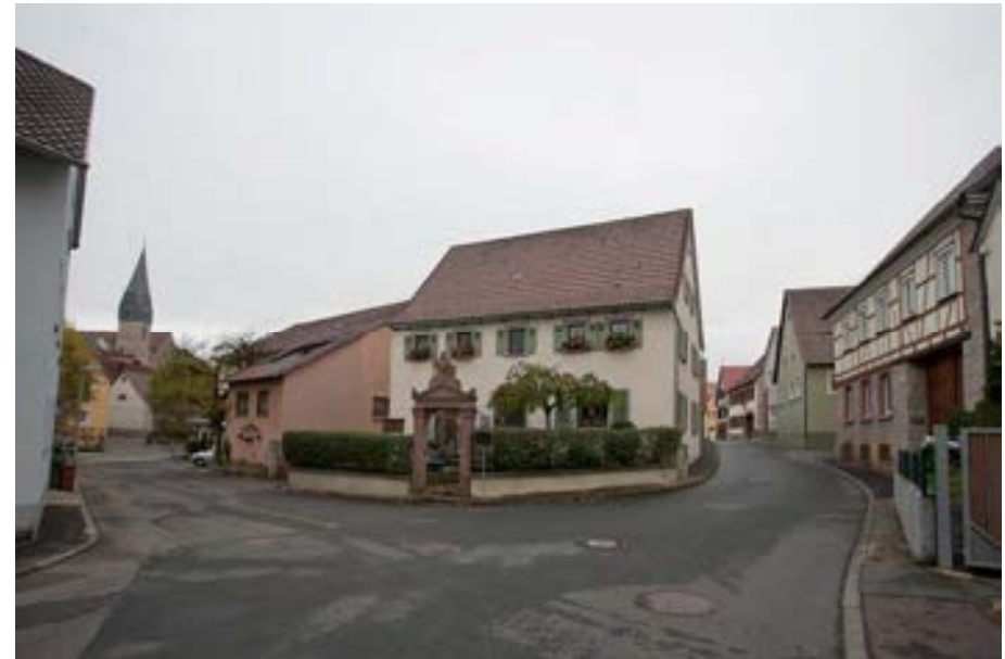
Weingasse Höhe Bachgasse, Blick auf Weingasse 5 mit Pforte
