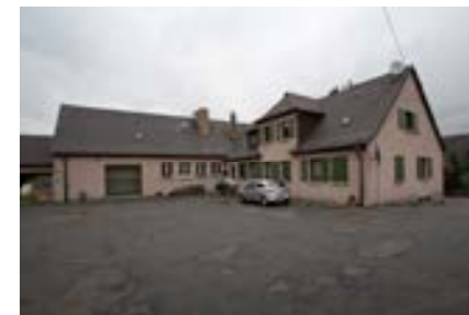
das Schulhaus gg. den Innenhof
