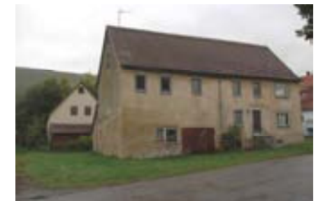
Blick auf die Südfassade
