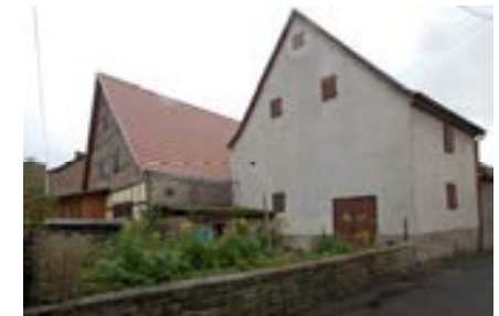
die erhaltenswerte Scheune (links.)
