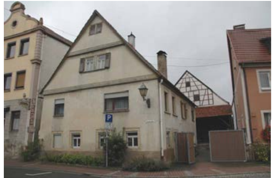
Ansicht gegen die Hauptstraße, dahinter liegt die Fachwerkscheune
