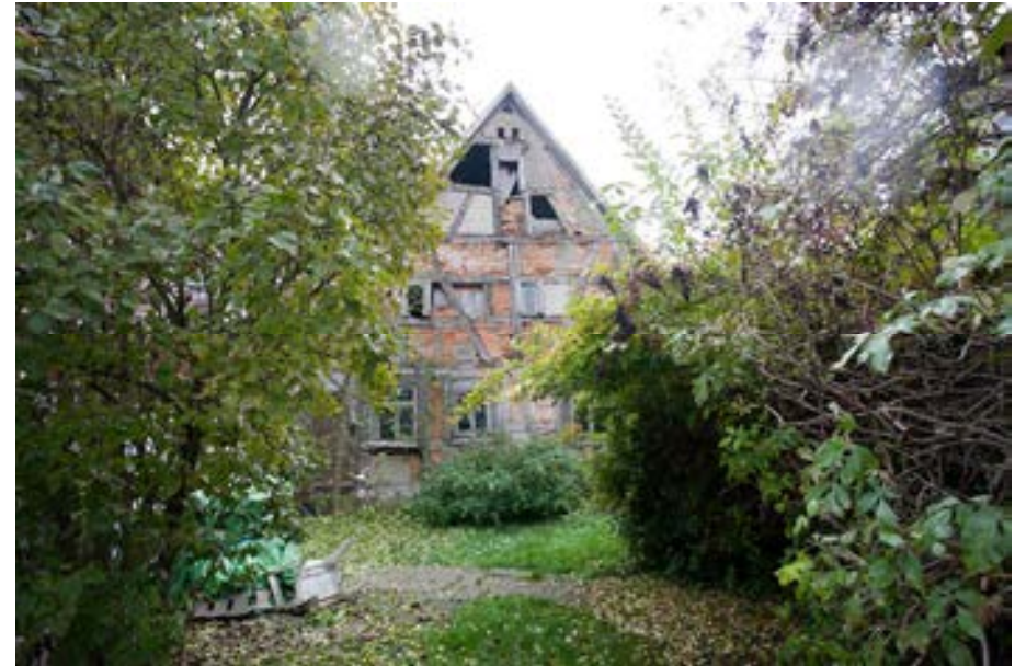
Blick auf den Westgiebel gg. den Unteren Wall
