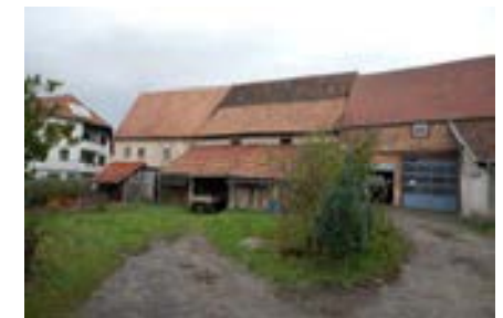
Scheune Nr. 40 (links)
