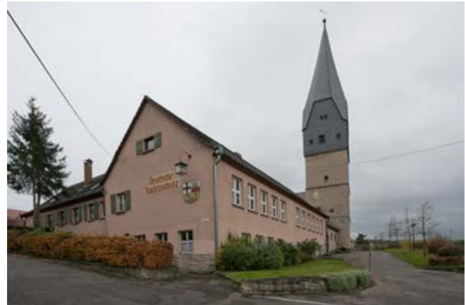
das Schulhaus von Norden aus gesehen
