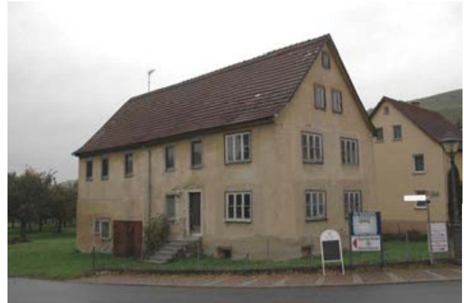
Ansicht gegen Südosten
