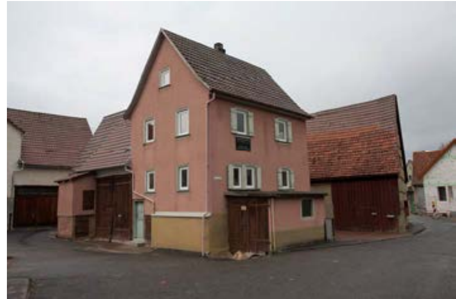
Ansicht gegen Südosten
