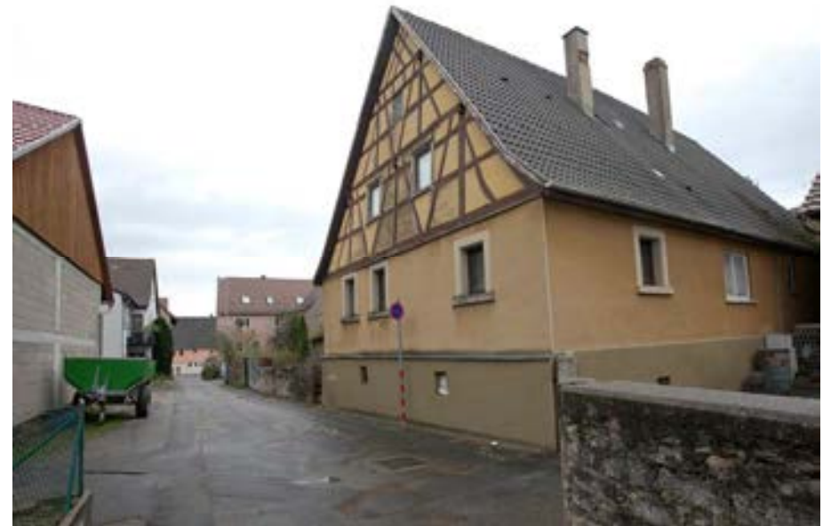
Blick auf das Wohnhaus von NW
