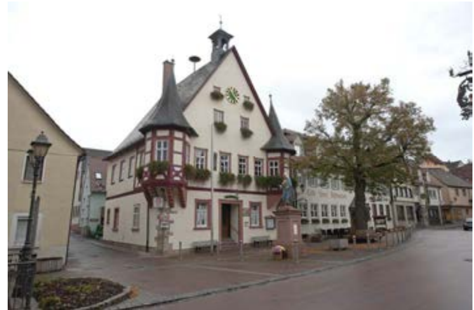
Ansicht von Norden
