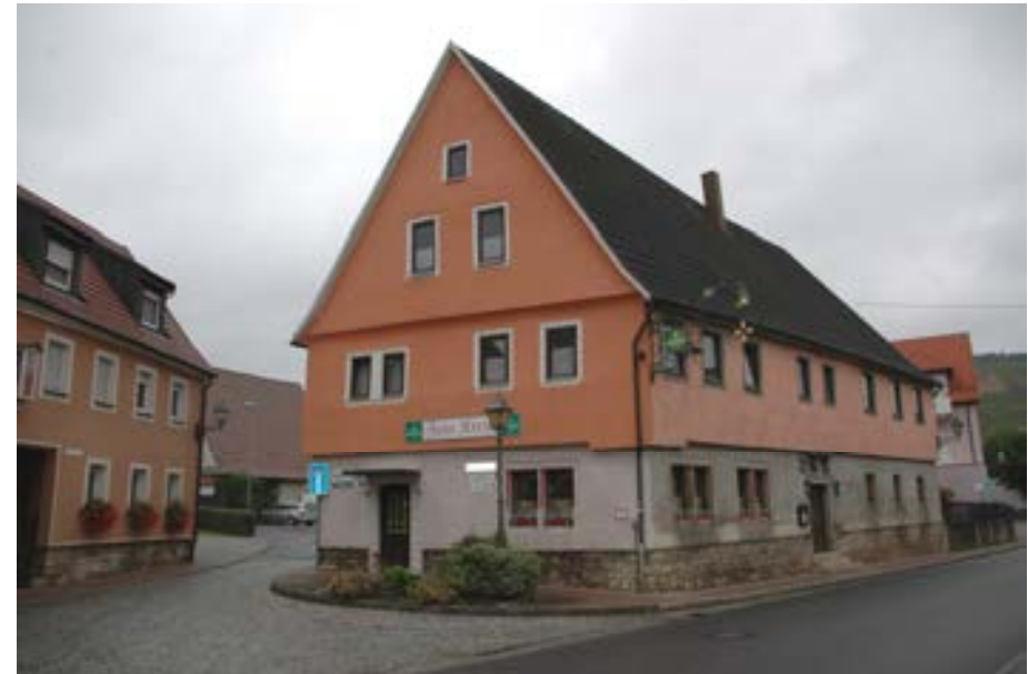
Ansicht von Süden, im Hintergrund verläuft die Schwennengasse
