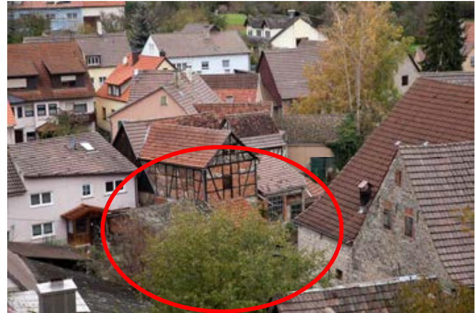
Blick vom Engelsberg auf die Nebengebäudegruppe in der Weingasse
