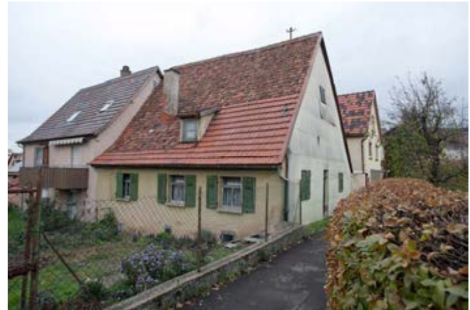
Ansicht gegen Südosten
