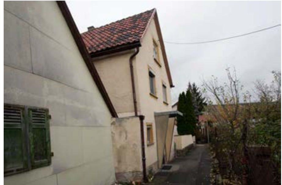
Ansicht von Südosten
