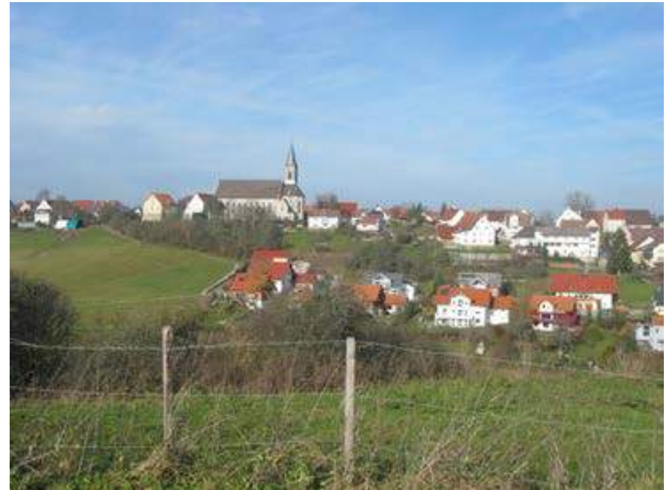
Abb. 3 - Südansicht von Aixheim (2006)
