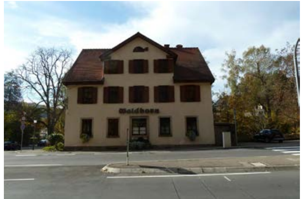
Ansicht von Osten, im Vordergrund die L 1208, links zweigt die Schönbuchstraße ab, 2012
