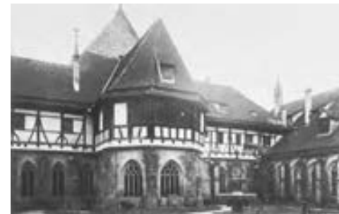
Ansicht des Brunnenhauses von Nordosten, 1930
