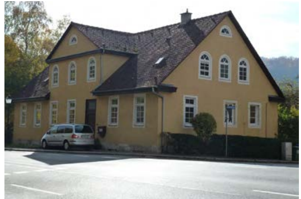
Ansicht von Nordosten, im Vordergrund die L1208, rechts zweigt die Schönbuchstraße ab, 2012
