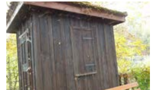
Nordostecke mit Tür und Fenster, 2012
