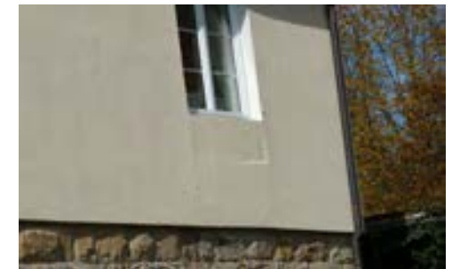
Detailansicht von Osten, 2012
