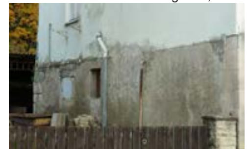
Detail der Westseite, 2012
