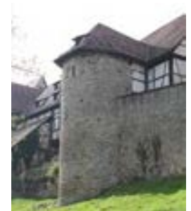
Ansicht von Norden, 2012
