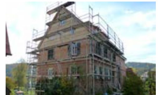
Ansicht von Norden, 2012
