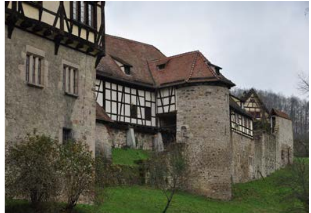
Ansicht von Südosten, 2013
