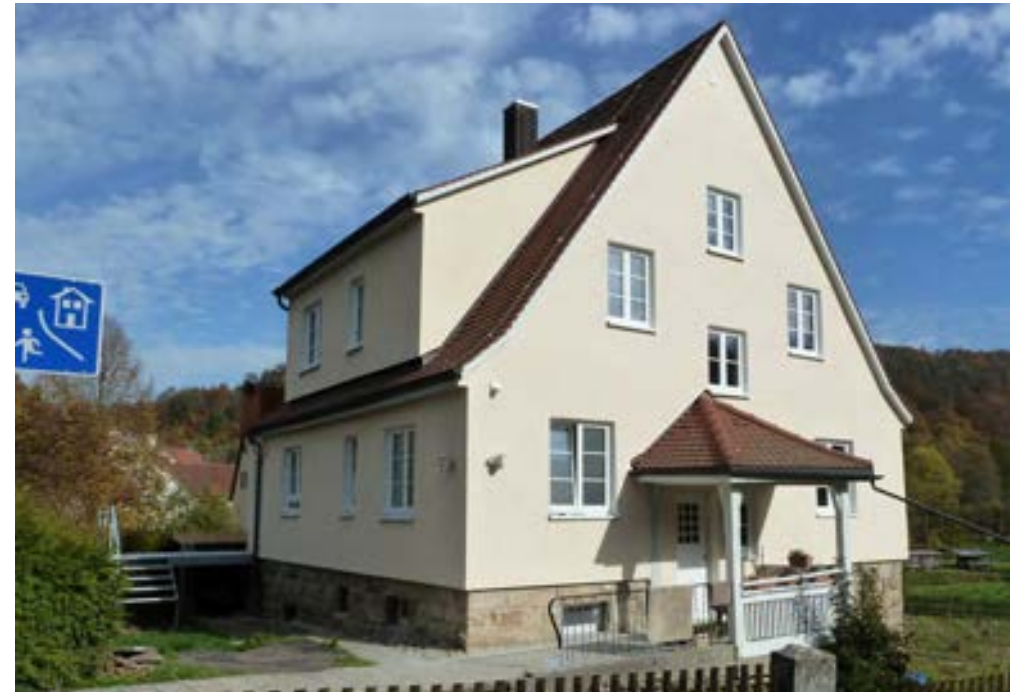
Ansicht von Südwesten mit jüngerer Dachgaube, 2012
