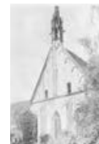
Ansicht des Sommerrefektoriums von Südosten, 1936
