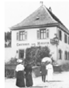
Südostansicht (undatiert) (Bildindex Marburg)
