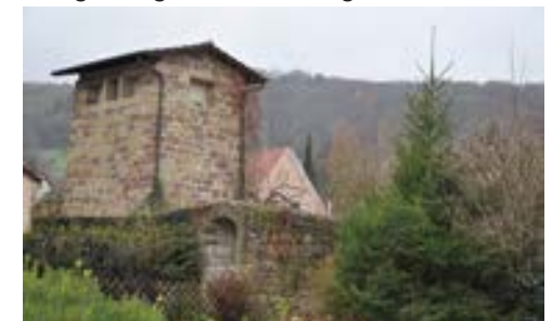
Blick auf das Trafohaus und die Umfassungsmauer Richtung Norden, 2013
