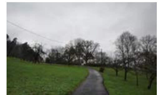
Blick auf die Straße Am Jordan Richtung Nordosten, 2013
