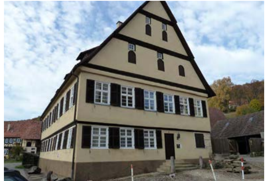
Ansicht von Südosten, 2012
