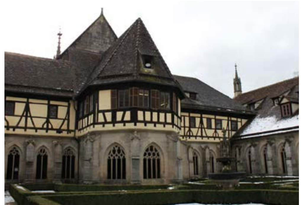
Ansicht des Brunnenhauses von Nordosten, 2012
