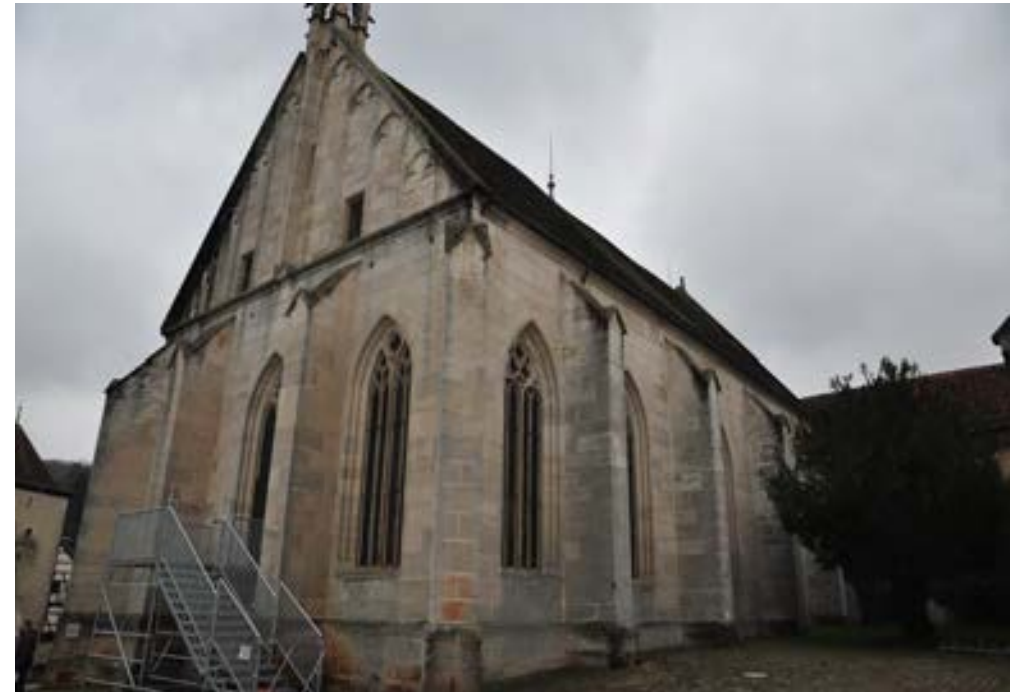
Ansicht des Sommerrefektoriums von Südosten, 2013
