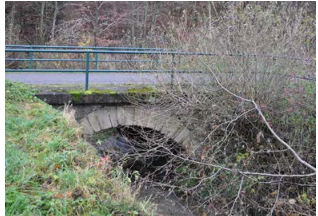
Nordostansicht der Brücke, 2012
