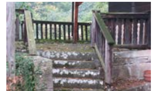
Treppenaufgang an der Südseite, 2012
