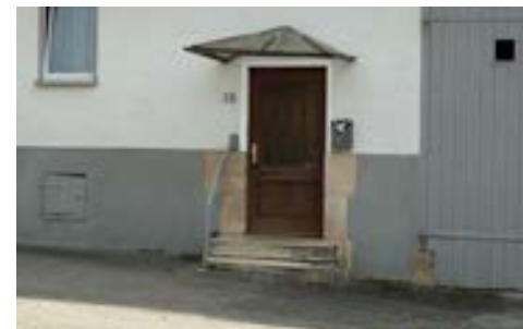
Eingang an der Westseite mit teilw. freiliegender Eckquaderung, 2012
