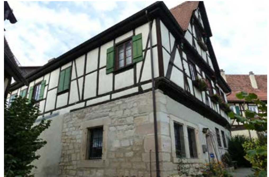
Südostansicht mit jüngerer Aufstockung an der Südseite und massiven Quadern im EG, 2012
