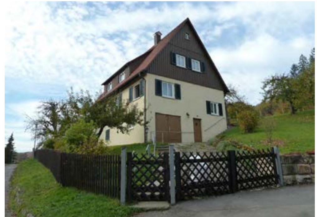
Ansicht von Südosten, 2012
