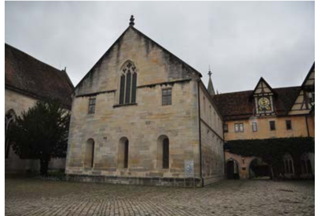
Ansicht von Südosten, 2013
