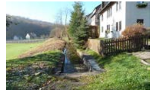
Mühlkanal im Bereich Am Mühlrain, Blick nach Westen, 2012
