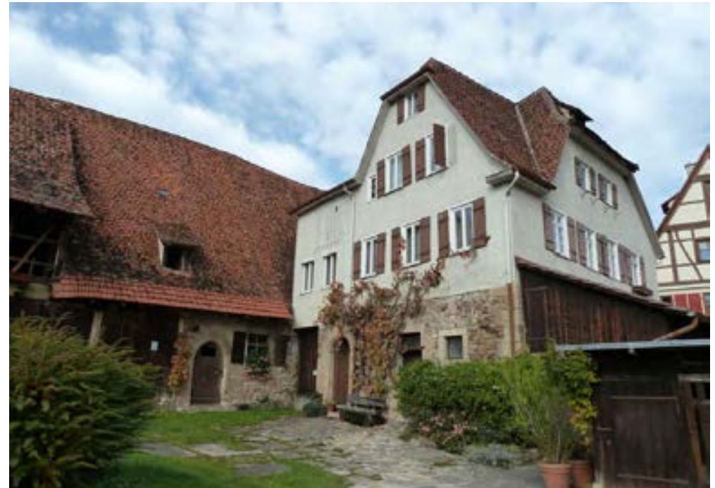
Kasernenhof 4, 6 und 8 Südostansicht, 2012
