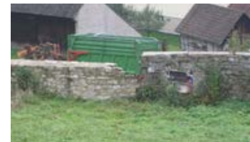
Blick auf den Anschluss des instandgesetzten Mauerteils an der Nordseite, 2012
