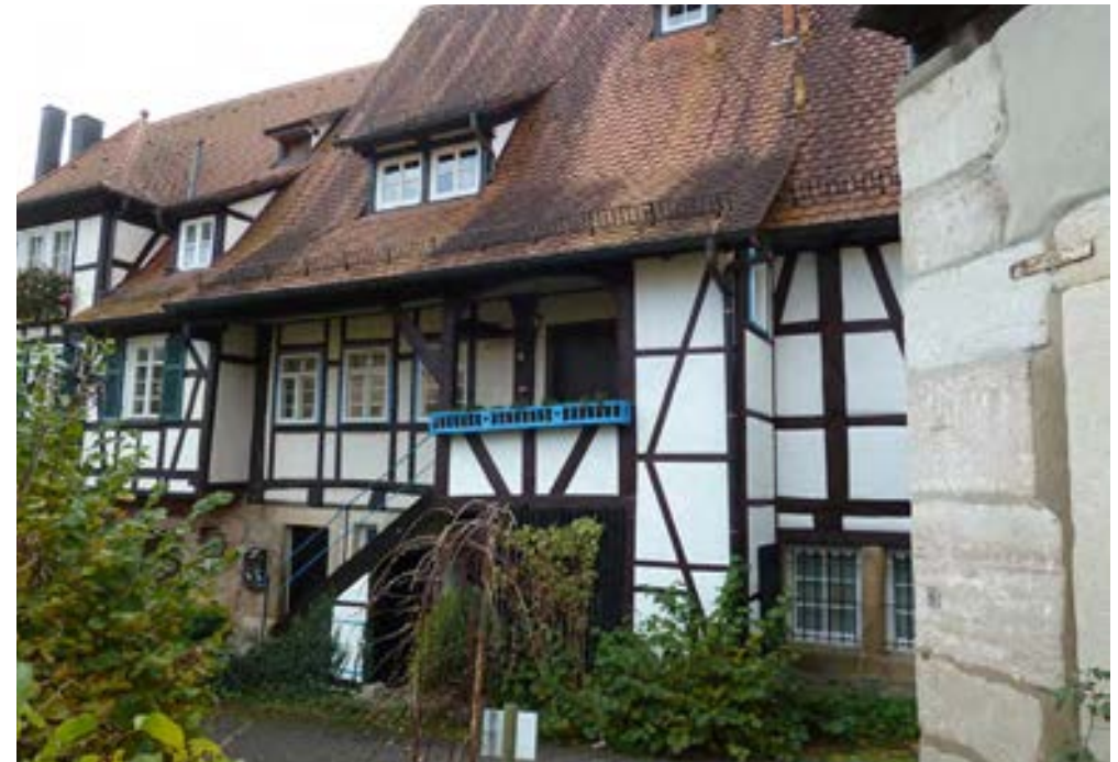
Nordostansicht mit außen liegendem Treppenaufgang, 2012
