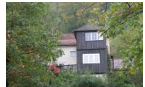
Ansicht von Südosten der östlichen Gebäudehälfte, 2012
