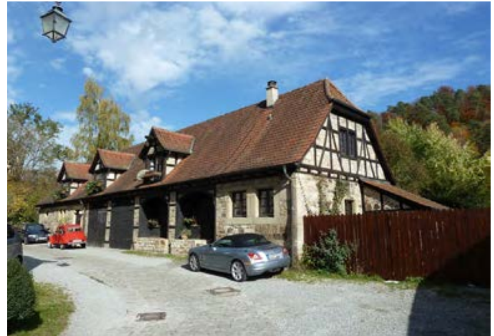
Südwestansicht, mittlere Gaube nach 1971 zugefügt, 2012
