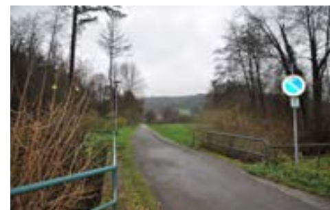
Brücke über den Goldersbach Richtung Nordwesten, 2013
