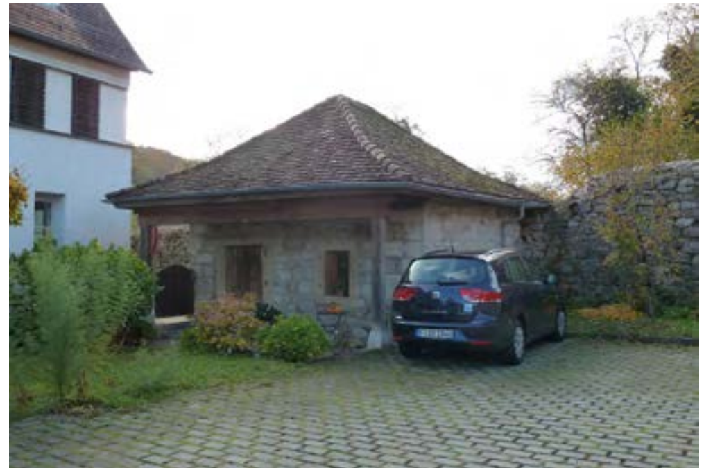
Nordostansicht des ehemaligen Waschhauses, rechts im Bild die Äußere Klostermauer, 2012
