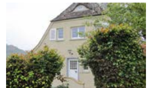
Detailansicht der Haustür an der Nordseite, 2012
