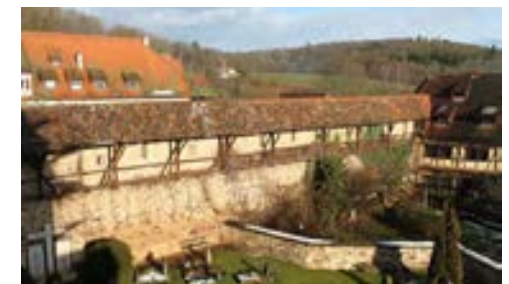
Ansicht des Wehrgangs nördlich des Friedhofs von Süden, 2012
