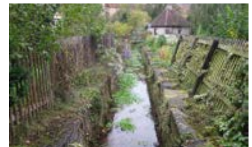
Seit 2003 wieder offener Mühlkanal im Kasernenhof, rechts im Bildhintergrund das ehemalige Backhaus, 2012
