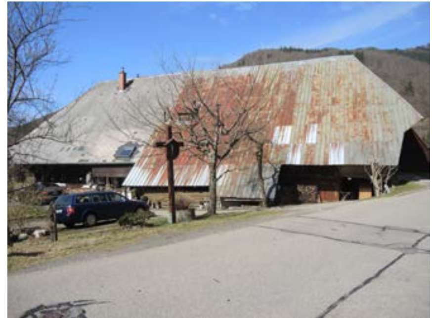
Ansicht des Eindachhofs von Osten
