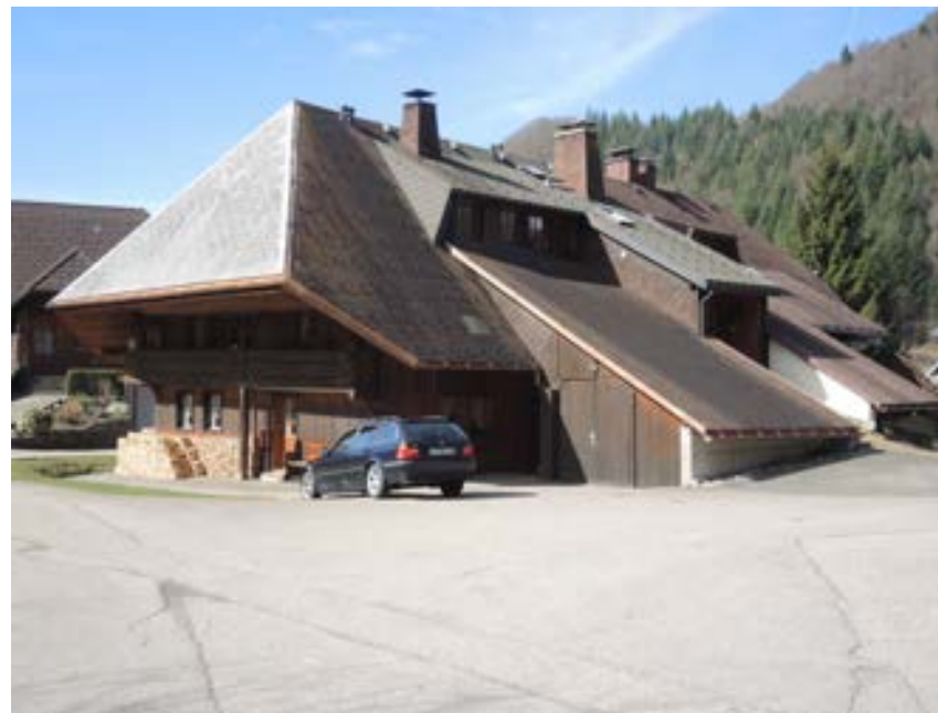
Ansicht des Eindachhofs von Osten
