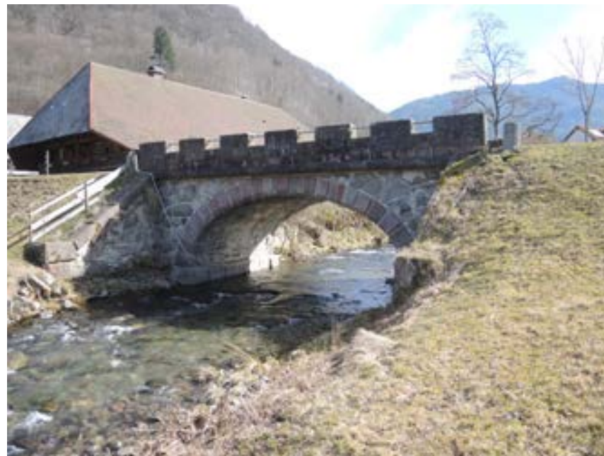
Ansicht der Bogenbrücke von Südwesten
