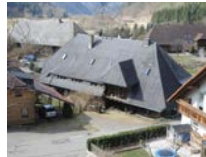
Ansicht von Nordosten
