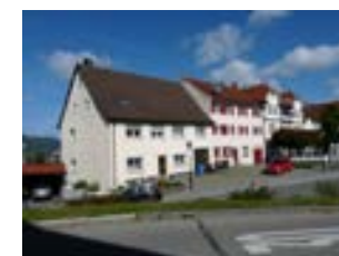
Ansicht mit Nr.2 von Südosten
