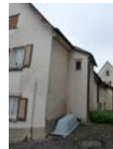
Ansicht Rückseite von Süden
