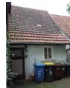
Ansicht Rückseite von Osten
