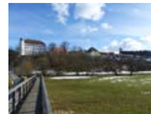
Ansicht von W
