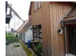
Ansicht Rückseite von Osten
