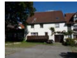
Ansicht der Rückseite mit Stadtmauer von Süden
