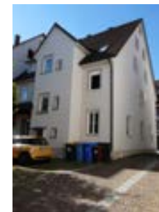
Ansicht Rückseite von Osten
