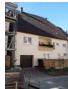
Ansicht Rückseite von Osten
