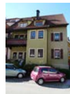
Ansicht Rückseite von Osten
