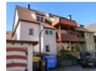
Ansicht Rückseite von Osten
