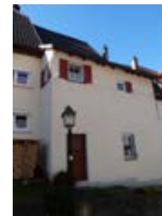
Ansicht Rückseite von Osten
