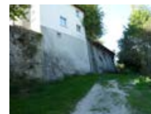
Nördliche Stadt- und Schlossmauer An der Steig 2
