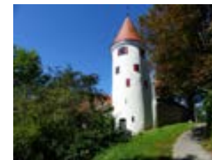
Oberer Graben Pulverturm
