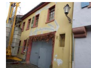
Hauptstraße 28 zur Metzgergasse
