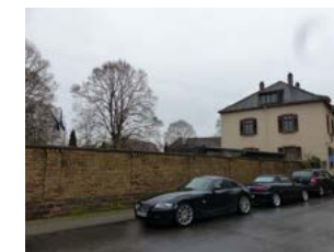
Bild Schulstraße 6 Mauer bei
