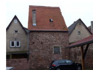
Nagelschmiedgasse 7 Scheune Rückseite
