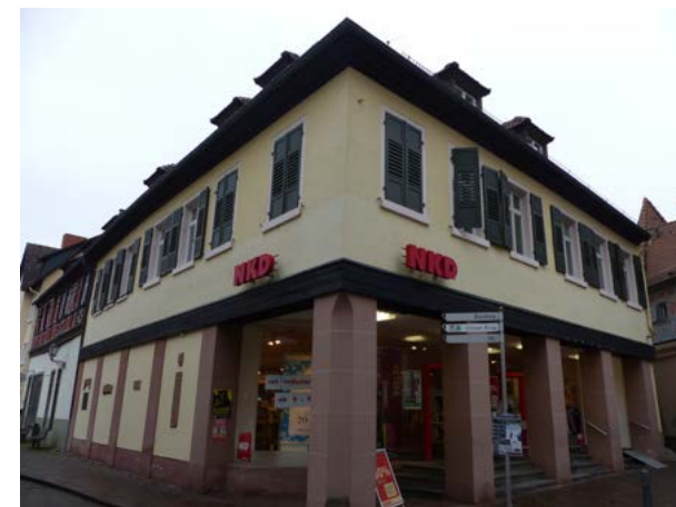
Hauptstraße 19, östlicher Teil
