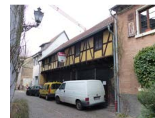
Bild Hauptstraße 18 Rückgebäude
