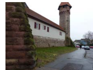
Neue Anlage, Grünfläche NW
