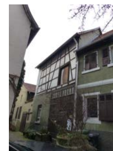
Rheingaustraße 5, ehem. Scheune
