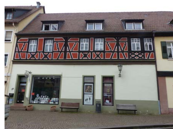
Hauptstraße 19, westlicher Teil
