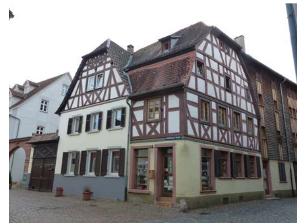
Kirchenstraße 12 u. Heidelberger Straße 2
