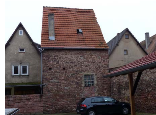
Nagelschmiedgasse 7 (bei), Scheune, Rückseite
