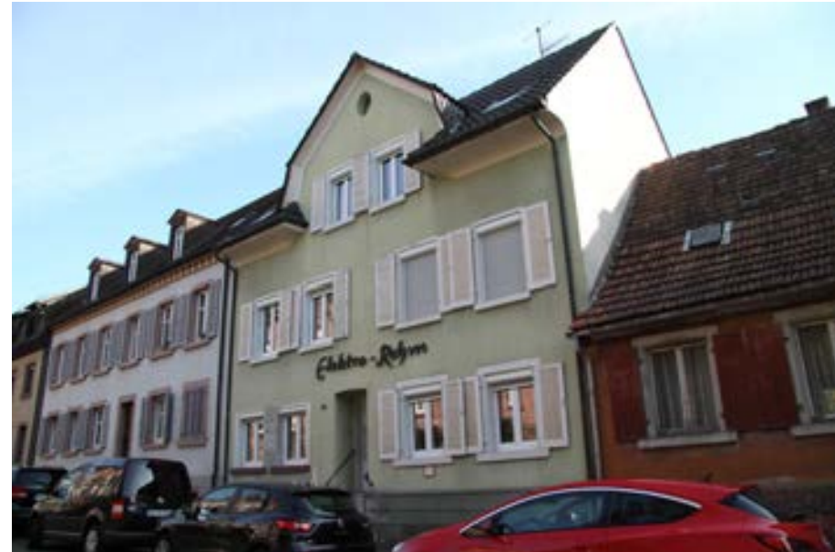
Ansicht gegen die Grabenstraße
