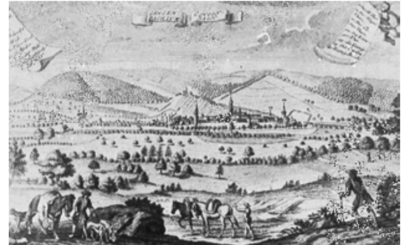
Ansicht von Süden um 1730 (Quelle: LDA)
