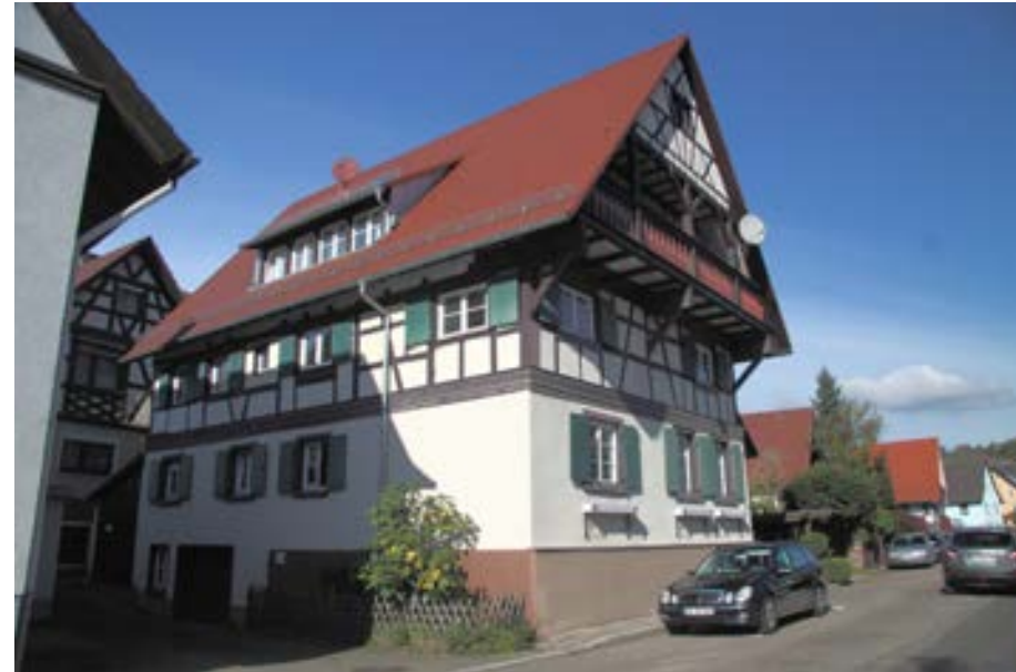
Schrägansicht der südöstlichen Traufseite und der Giebelfassade mit Laubengang
