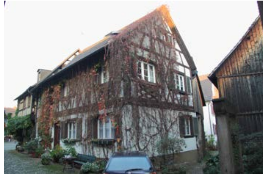
Ansicht von Südwesten gegen die kleine Stichgasse zur Höllengasse
