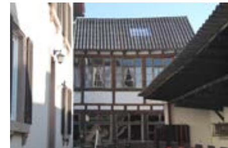
rückwärtiges Nebengebäude (Werkstatt)
