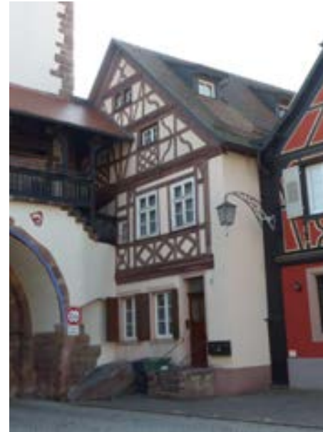
Ansicht gegen die Hauptstraße; links die Durchfahrt des Kinzigturmes
