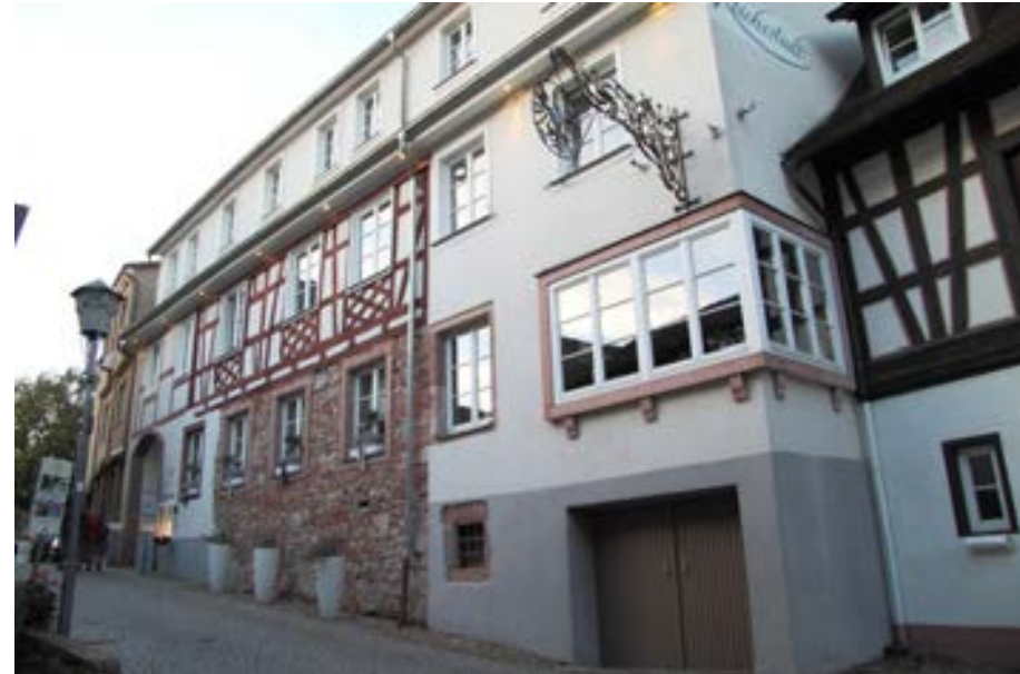
Hauptfassade an der Engelgasse
