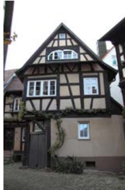
Blick auf den Ostgiebel mit über Eck geführter Tennenzufahrt
