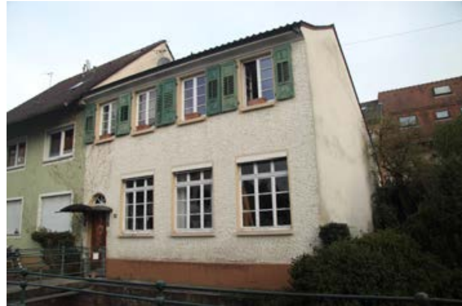
Südliche Trauffassade mit Steg über die Haigerach
