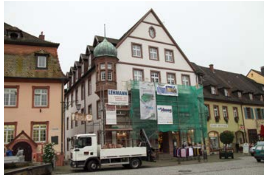
Neues Foto? Ansicht der Giebelfassade gegen die Hauptstraße
