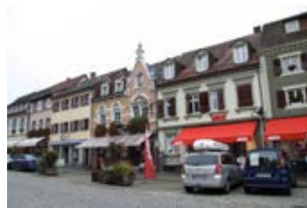
Ansicht der Gebäudereihe Nr.24 ff
