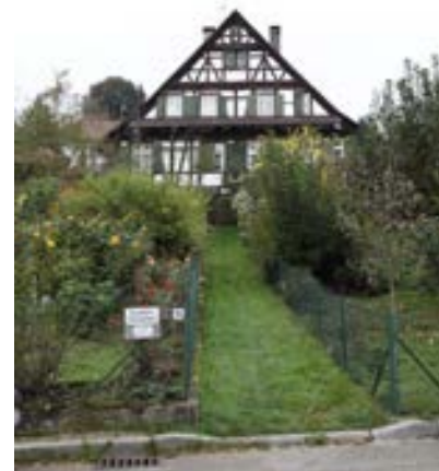
Ansicht gegen die Oberdorfstraße
