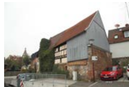
Nebengebäude über Stadtmauer
