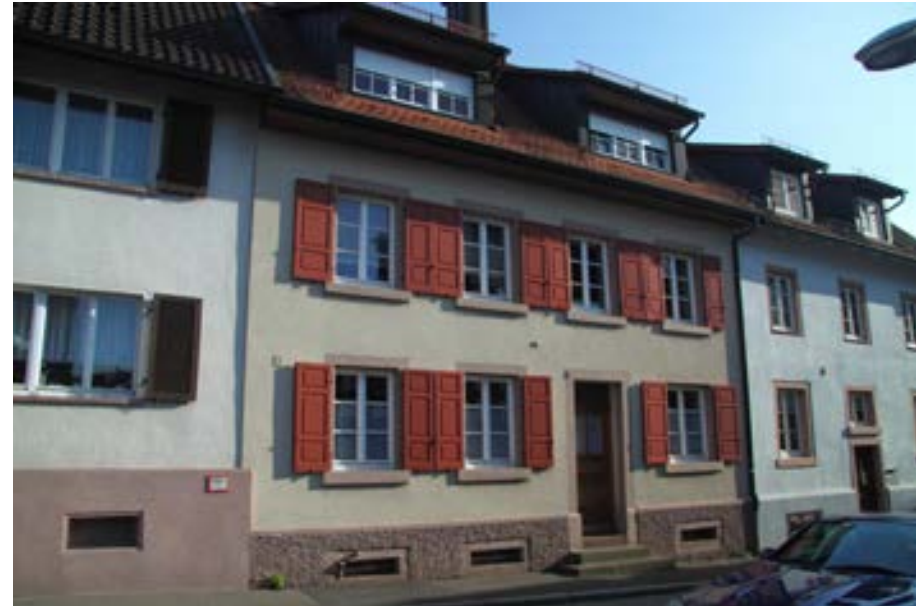
Ansicht gegen die Grabenstraße
