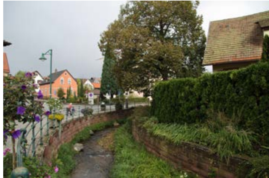
Die Haigerach an der Aufweitung Oberdorfstraße
