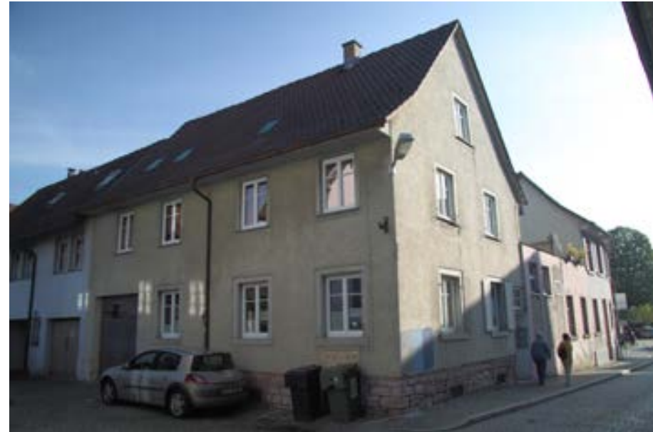
Ansicht gegen die Grabenstraße, Höhe Engelgasse
