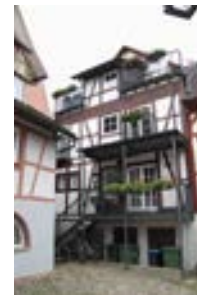
Ansicht der Rückfassade vom Gänsbühl aus
