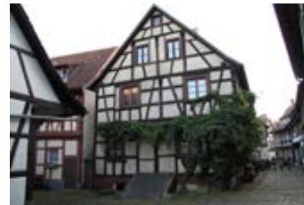
Blick auf die Nordfassade mit Kellerhals
