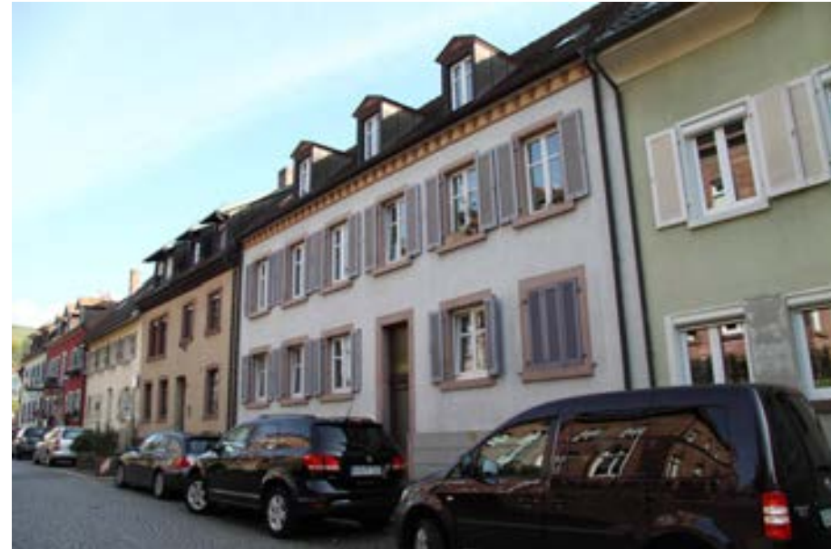
Ansicht gegen die Grabenstraße
