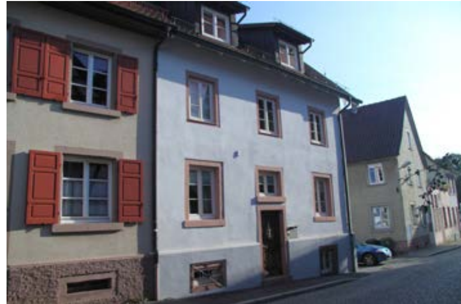
Ansicht gegen die Grabenstraße
