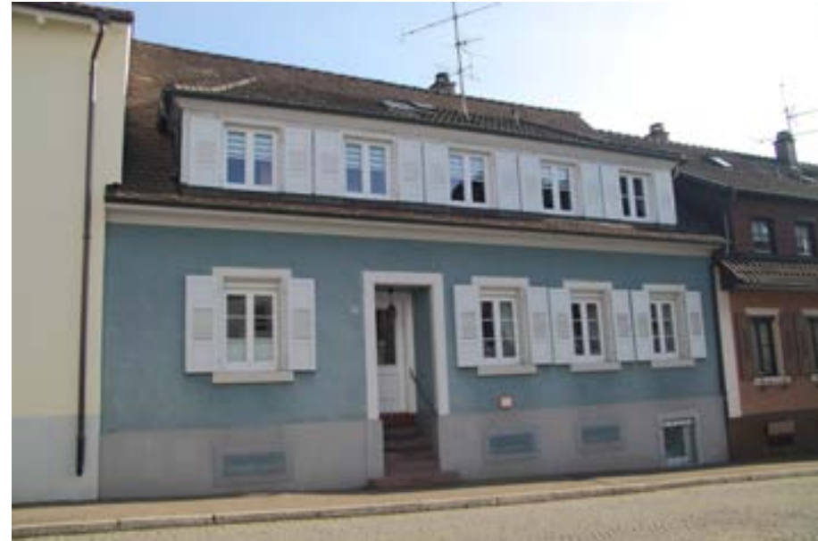
Ansicht gegen die Grabenstraße
