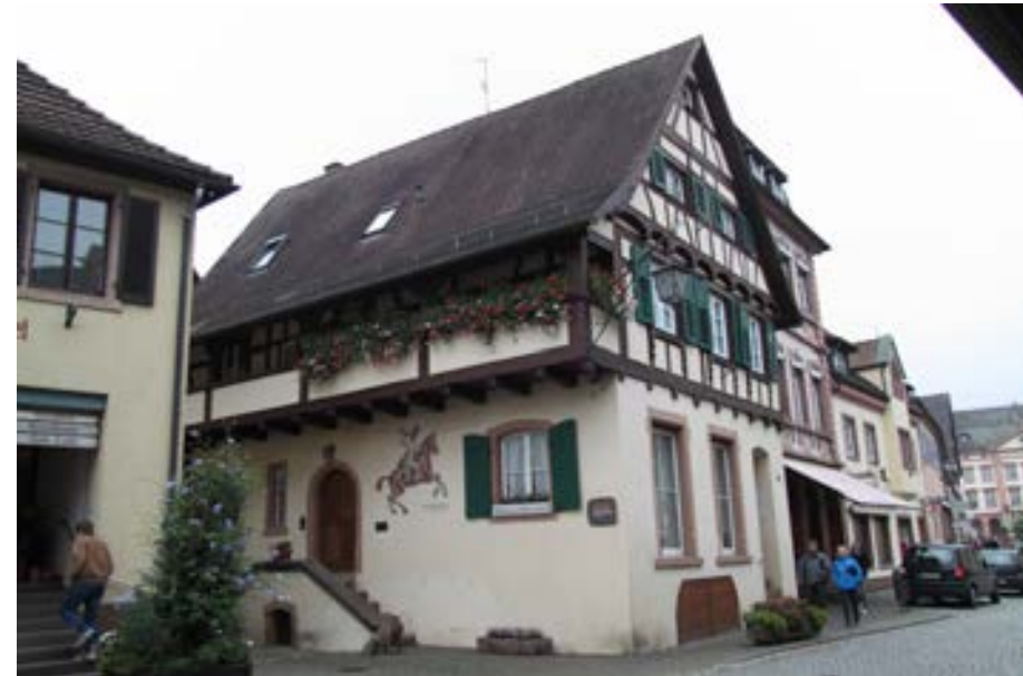
Ansicht gegen die Hauptstraße; seitlich die zweiläufige Treppe mit Eingangportal
