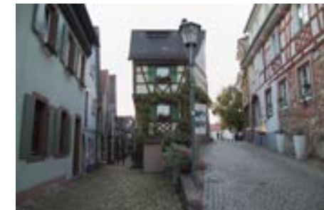
Blick von Osten auf das Zwickelgrundstück
