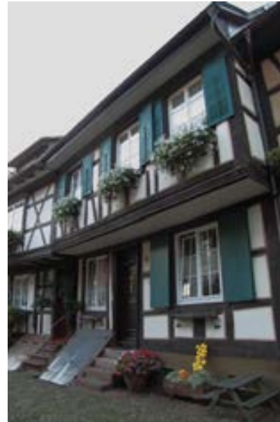
Hauptfassade mit charakteristischem Hauseingang mit Sandsteinstufen und Kellerhals
