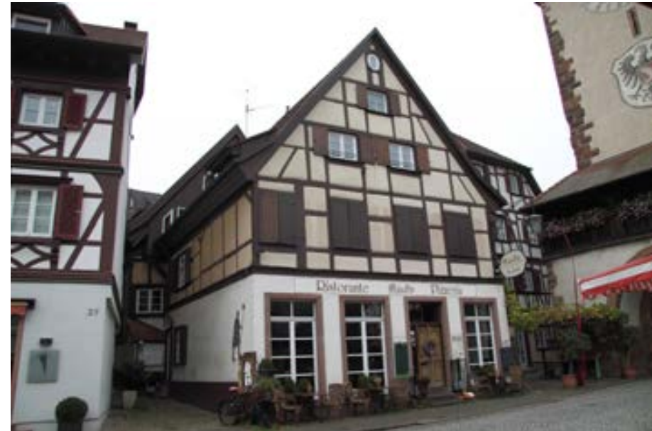
die giebelständigen Gebäude grenzen unmittelbar aneinander und sind baulich verbunden
