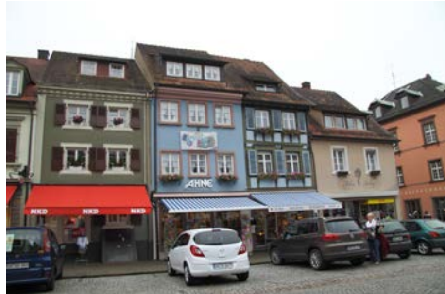
Nr. 18, zweites Gebäude von rechts
