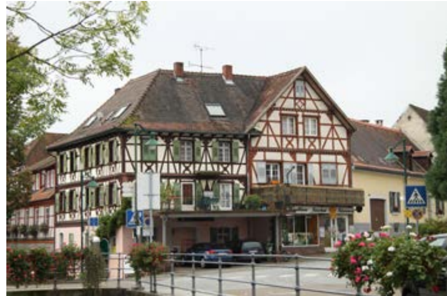
Blick auf die Nordfassade
