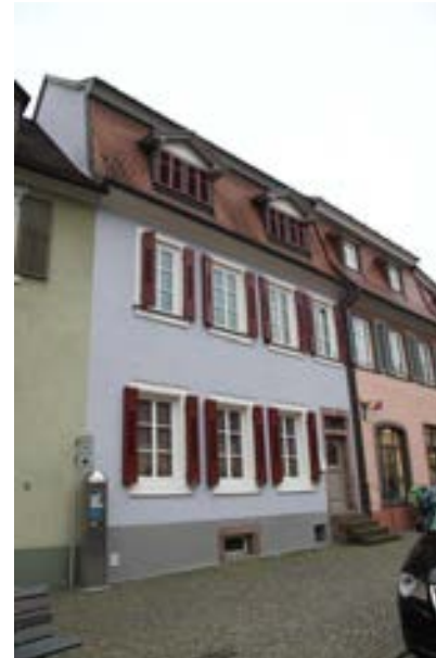
Ansicht gegen die Hauptstraße
