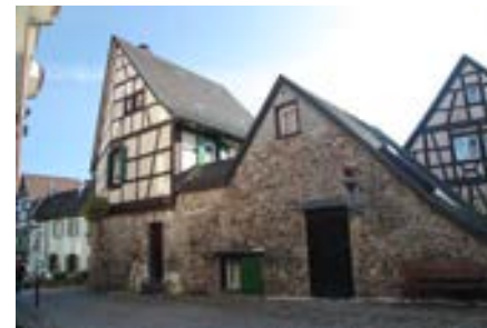
Nordfassade mit Bruchsteinmauerresten
