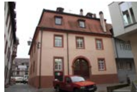
Ansicht der Rückfassade
