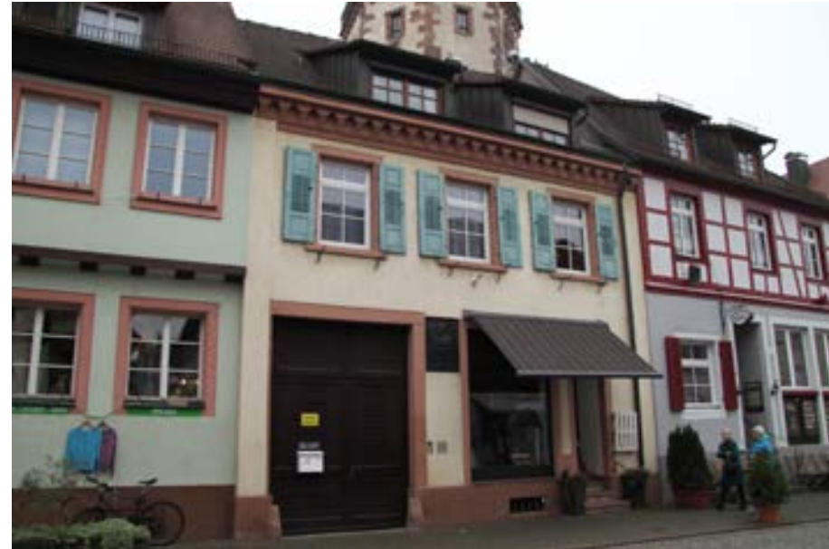
Ansicht gegen die Hauptstraße
