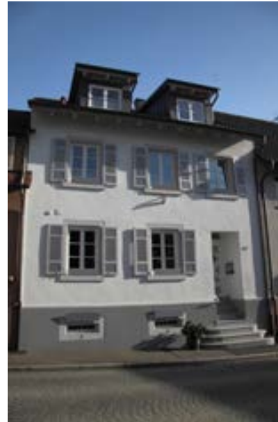
Ansicht gegen die Grabenstraße
