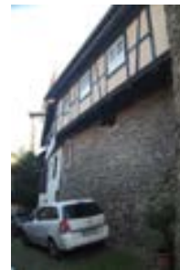
Nordansicht mit Stadtmauer
