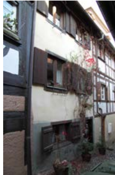
Fassade gegen den Gänsbühl
