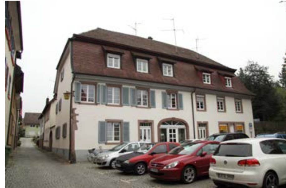
Blick auf die Westfassade
