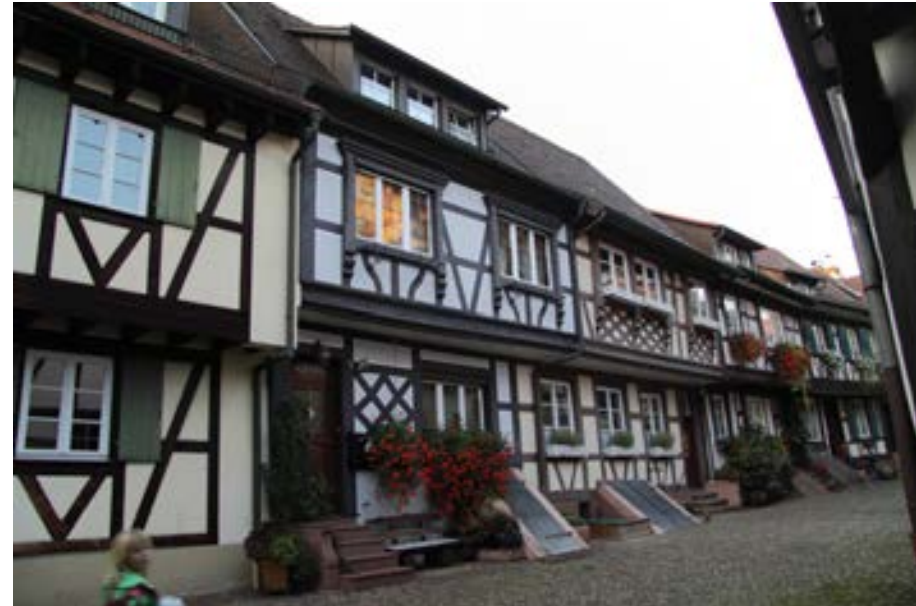
Hauptfassade mit charakteristischem Hauseingang mit Sandsteinstufen und Kellerhals
