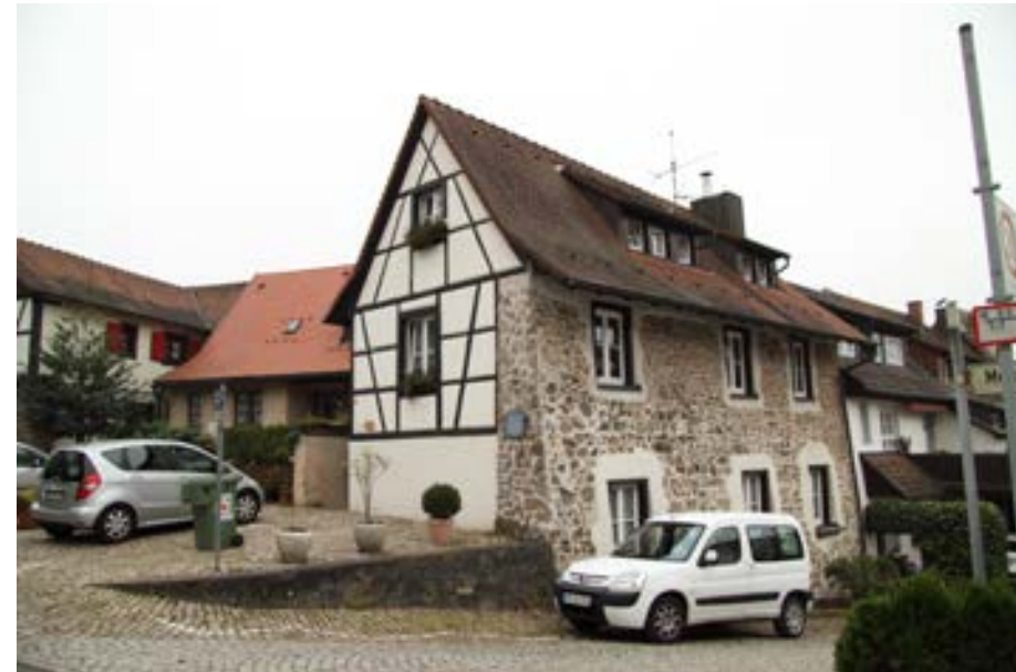
Eckansicht gegen den Mercy'schen Hof und der Straße "Am Hofberg" (rechts)
