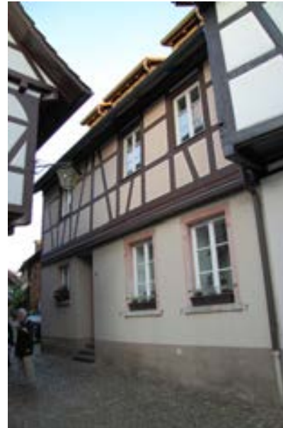
Blick auf die Westfassade
