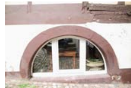
Kellerbogen am Rückgebäude bez. 1731
