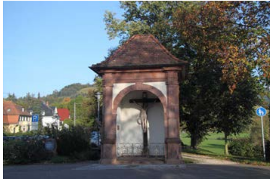
Nördlich der Kinzigbrücke stehende sog. Brückenskapelle von 1911
