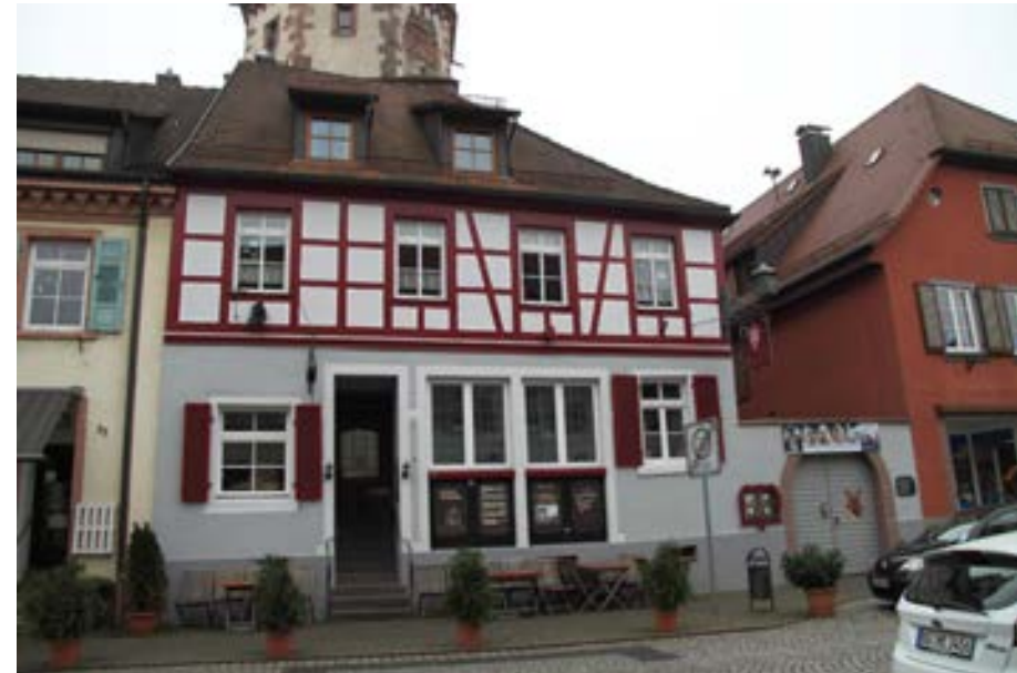
Ansicht der Hauptstraßenfassade mit seitlicher Hofeinfahrt
