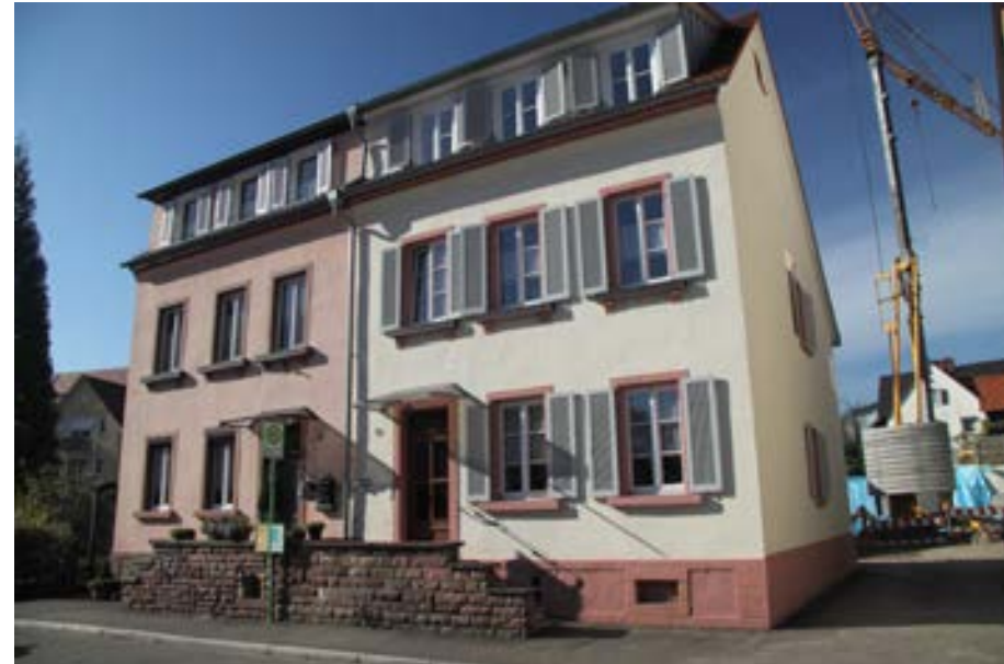
Ansicht gegen die Oberdorfstraße; rechts im Bild Nr. 9
