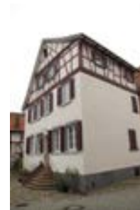
Schrägensicht von Südosten
