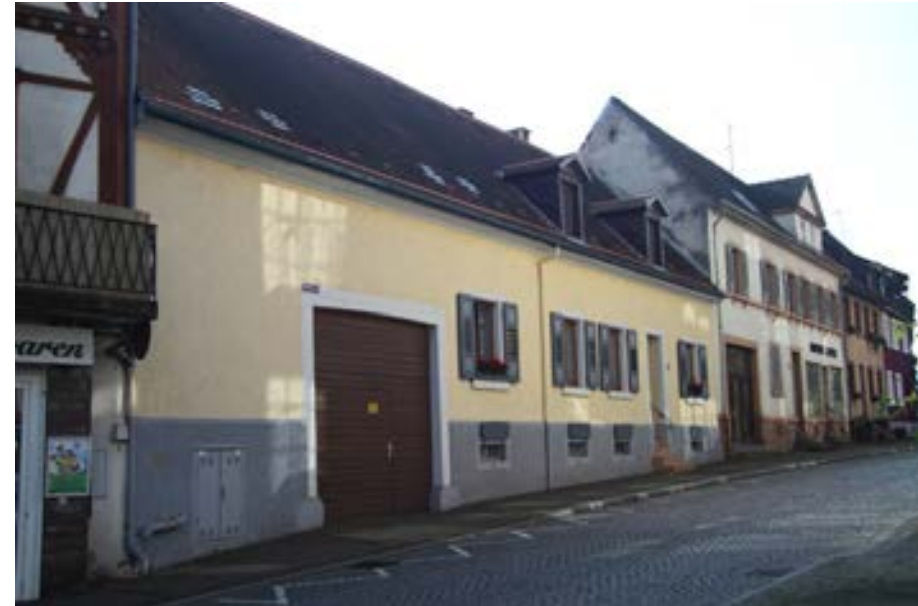
Ansicht gegen die Grabenstraße
