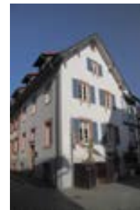
Eckansicht von Südwesten
