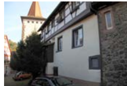
Nordansicht mit Stadtmauer und Obertor
