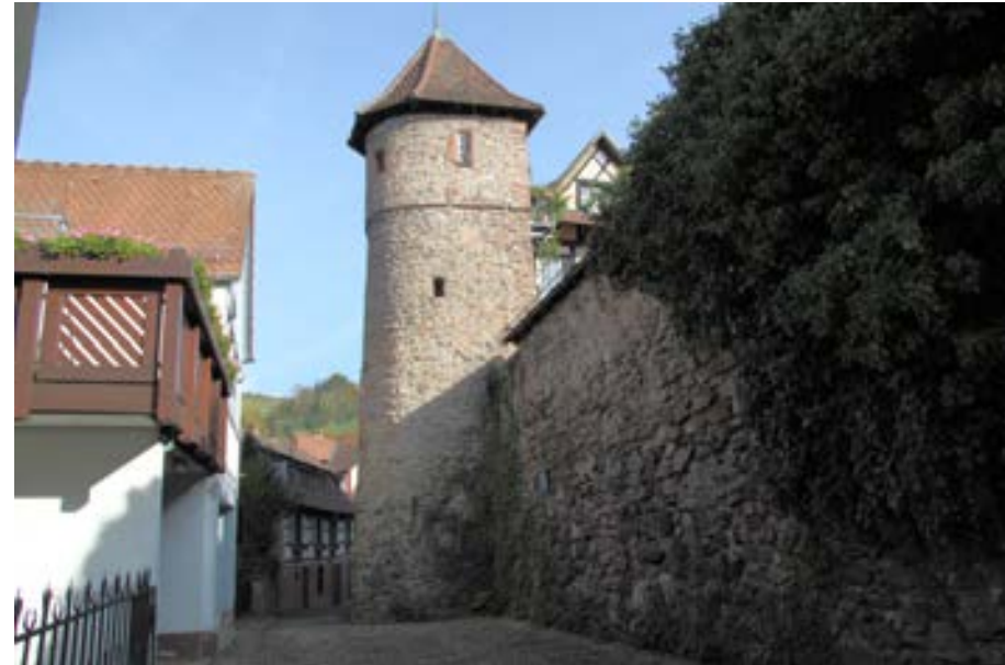
Brenngasse mit Schwedenturm (Adresse Gänsbühl 5a) und innerer Stadtmauer
