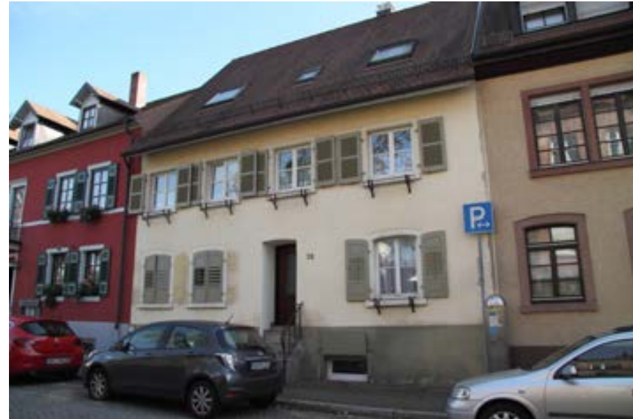
Ansicht gegen die Grabenstraße
