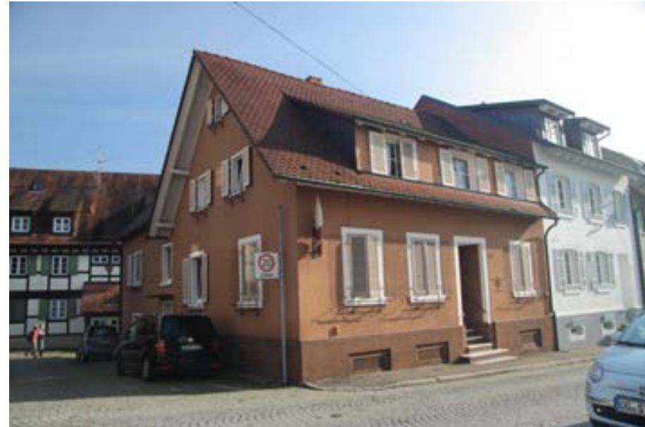
Ansicht gegen die Grabenstraße
