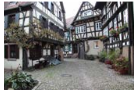
städtebaulich markante Situation im Nordteil
