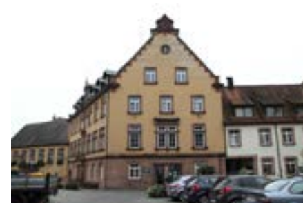
Blick auf die Nordfassade
