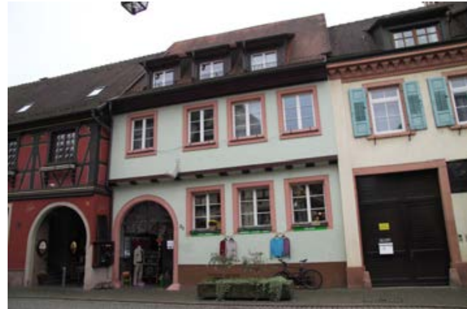
Ansicht gegen die Hauptstraße
