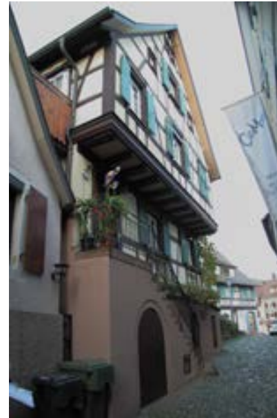
Südfassade an der Engelgasse mit Kellerbogen
