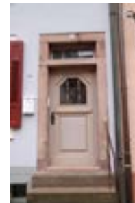
Eingang mit Rahmenfüllungstüre u. Oberlicht
