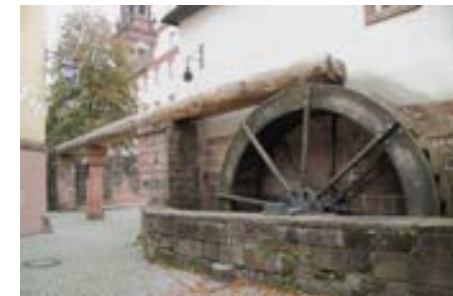
Wasserrad und hölzerner Zuleitung
