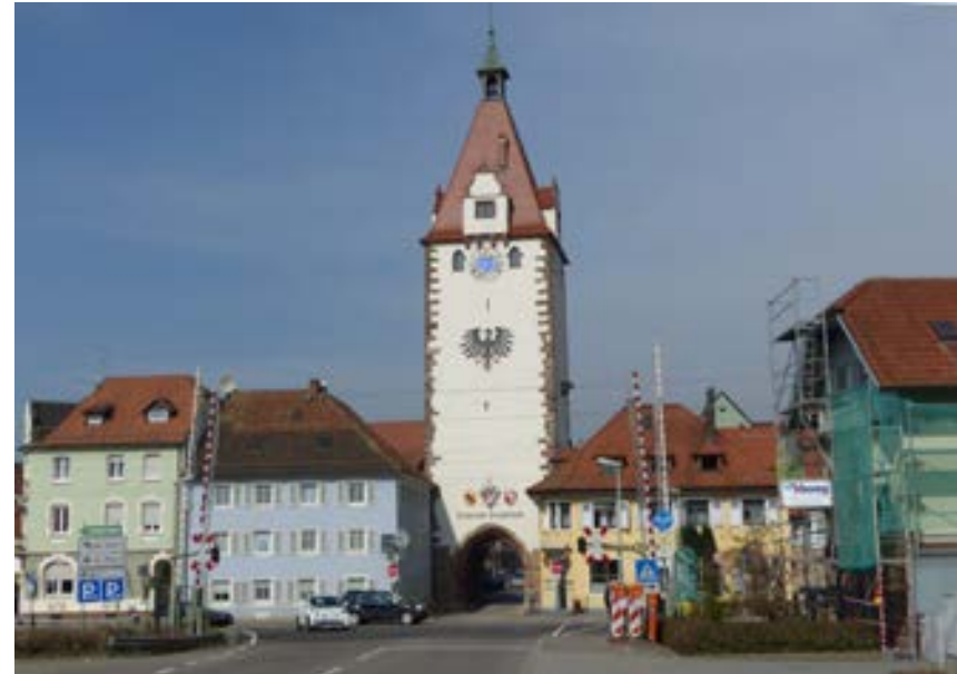
Blick von der Brückenhäuserstraße Richtung Altstadt
