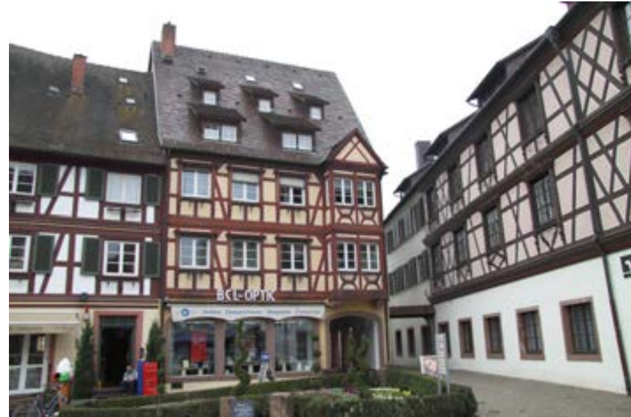
Ansicht der Fachwerkfront gegen die Victor-Kretz-Straße mit Adlersteinen mit Gangfisch
