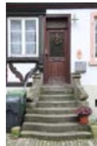
Detail: Hauseingang mit Sandsteintreppe
