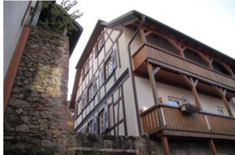
Ansicht des Giebels und der zur Brenngasse gerichteten Trauffassade über der Stadtmauer
