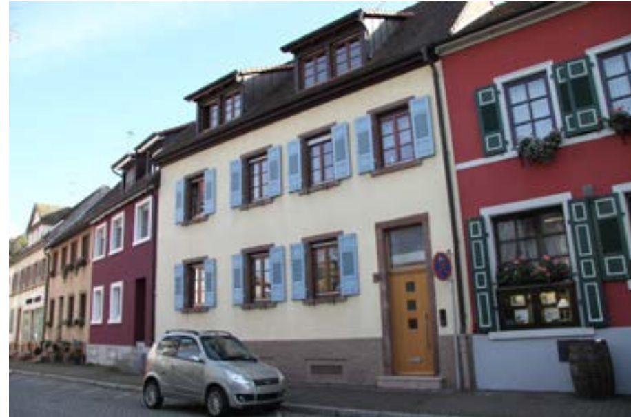
Ansicht gegen die Grabenstraße
