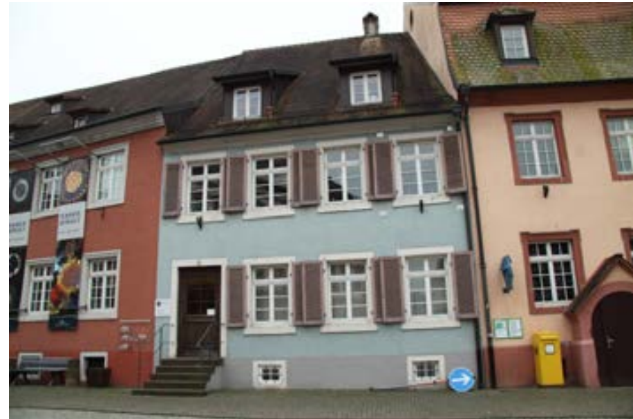
Ansicht gegen die Hauptstraße
