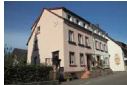
Detail: Nr. 7 mit individuellem Holzfenster im EG
