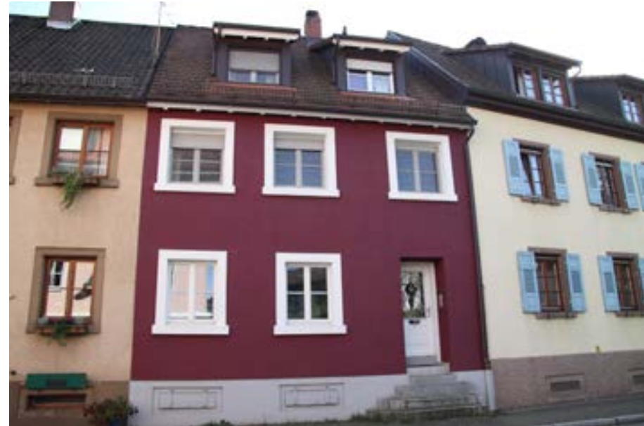
Ansicht gegen die Grabenstraße
