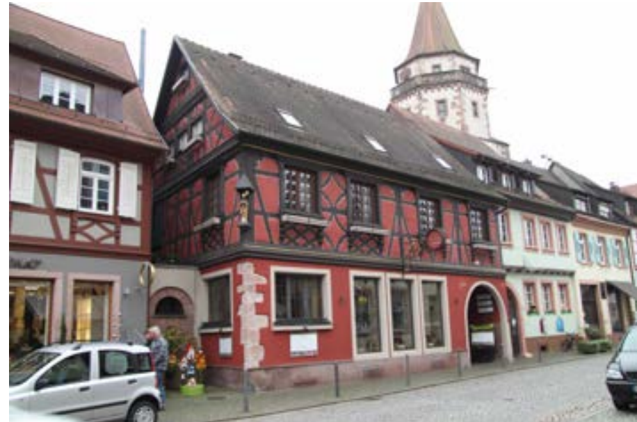
Ansicht der Fassade gegen die Hauptstraße
