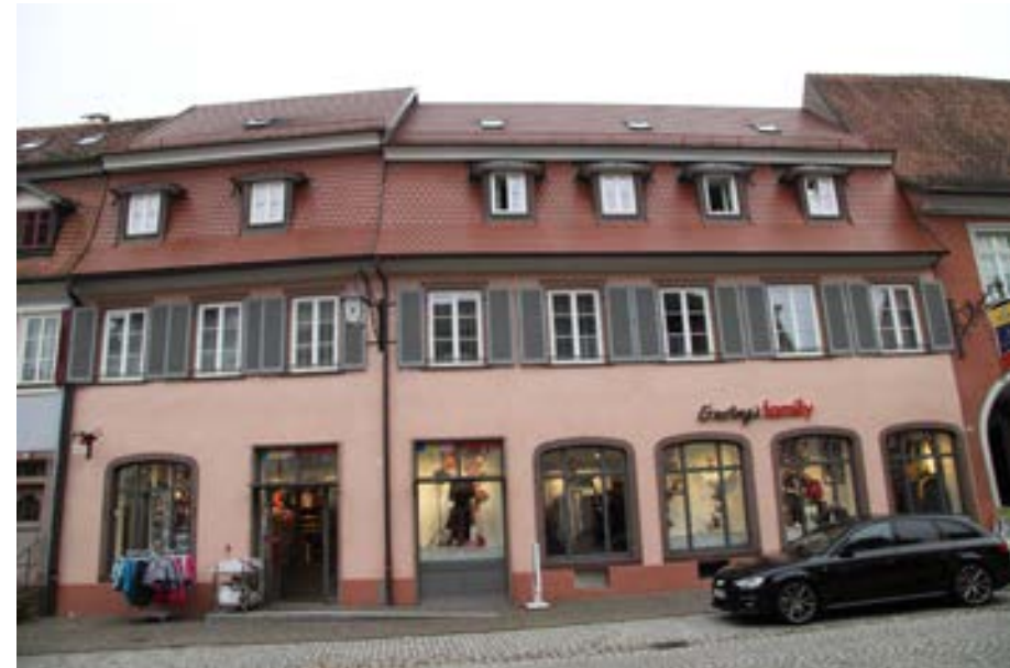
Ansicht der Hauptstraßenfassade
