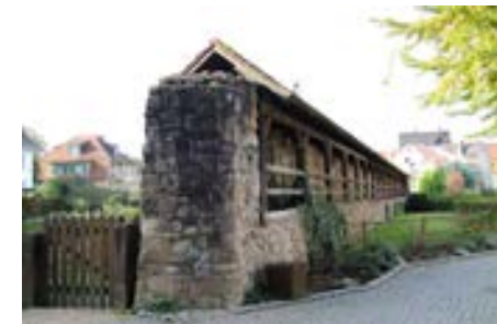
südöstlicher Stadtmauerzug (Kulturdenkmal)
