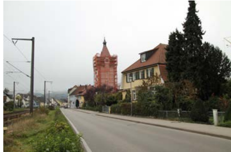
Friedrichstraße Höhe Nr. 47, Blick in westliche Richtung
