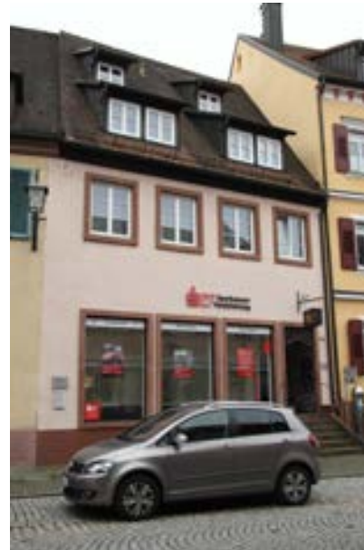
Ansicht gegen die Hauptstraße
