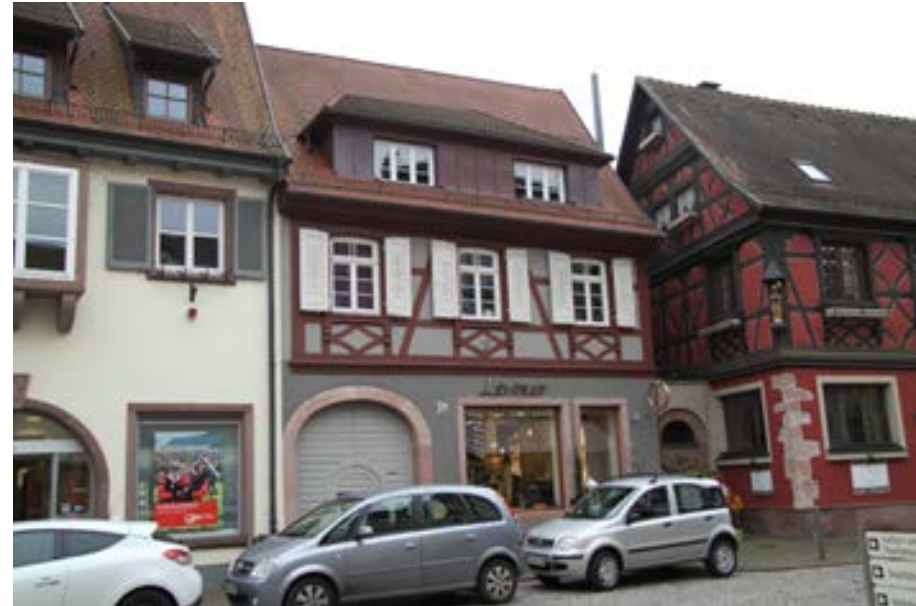
Ansicht der Hauptstraßenfassade
