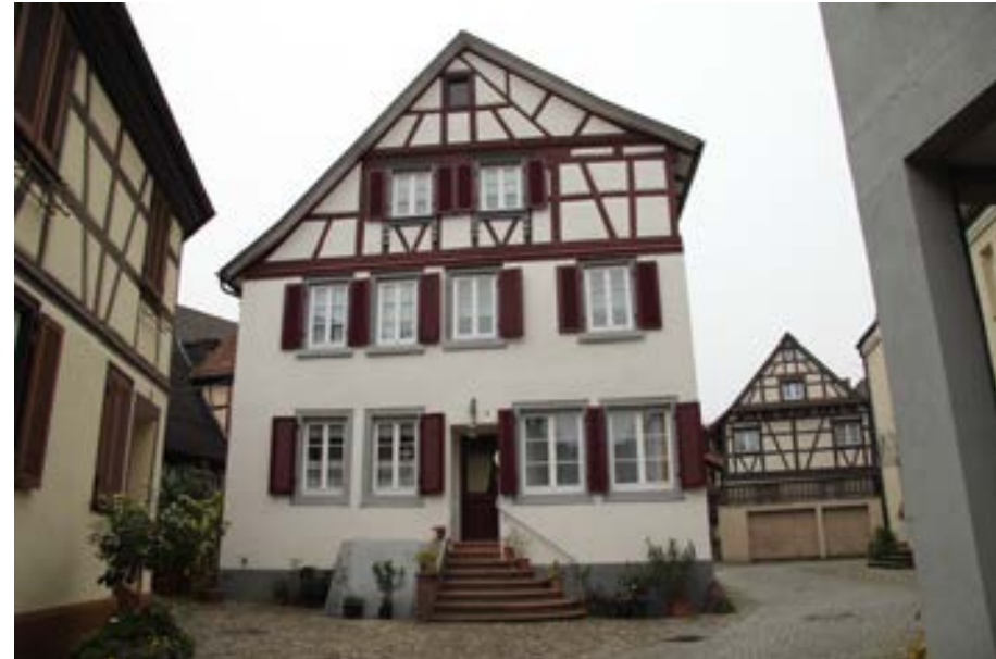
Blick auf die Südfassade
