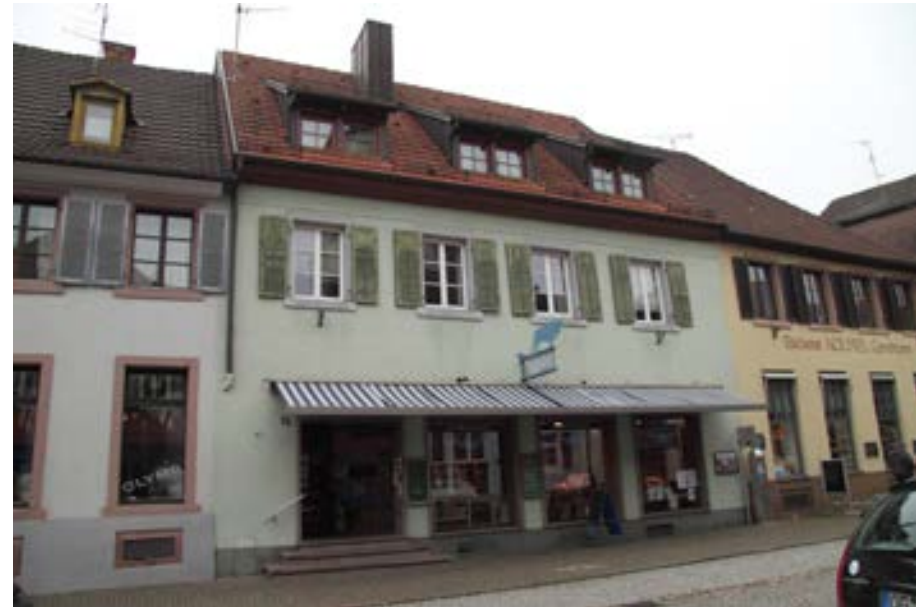
Ansicht der Fassade gegen die Hauptstraße
