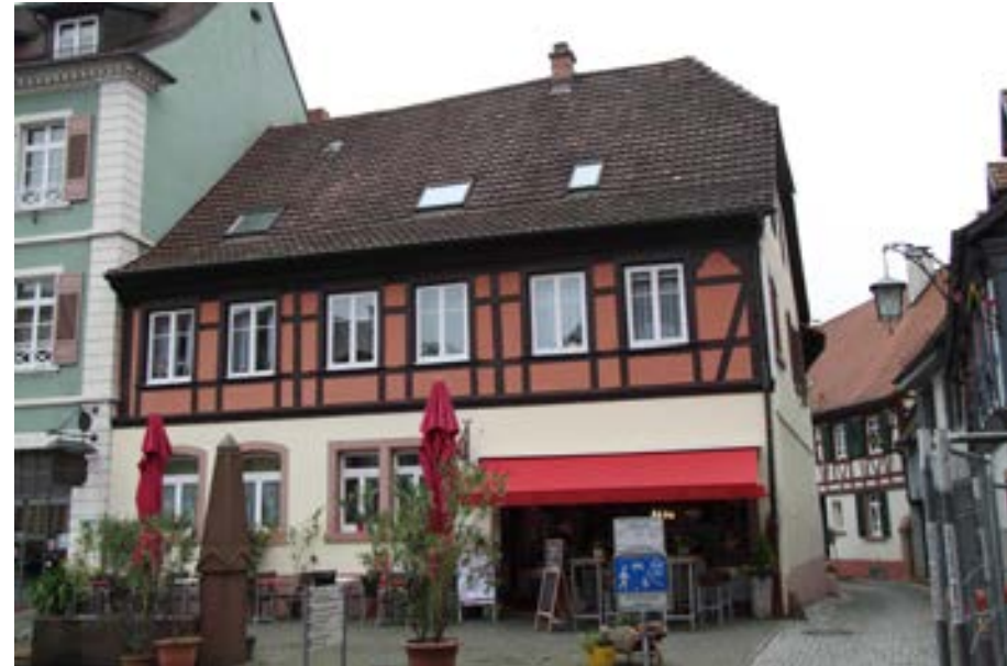
Ansicht von der Hauptstraße; seitlich die Einmündung der Klosterstraße
