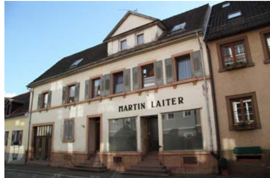
Ansicht gegen die Grabenstraße
