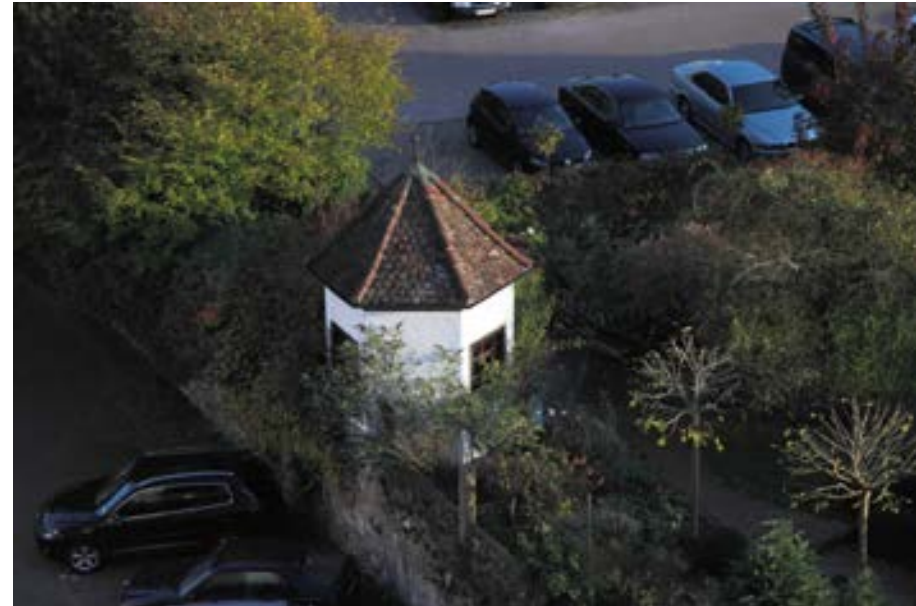
Pavillon an der Zwingermauer, Höhe Hauptstraße 29
