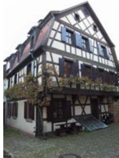
Blick auf die Nordfassade mit Kellerhals
