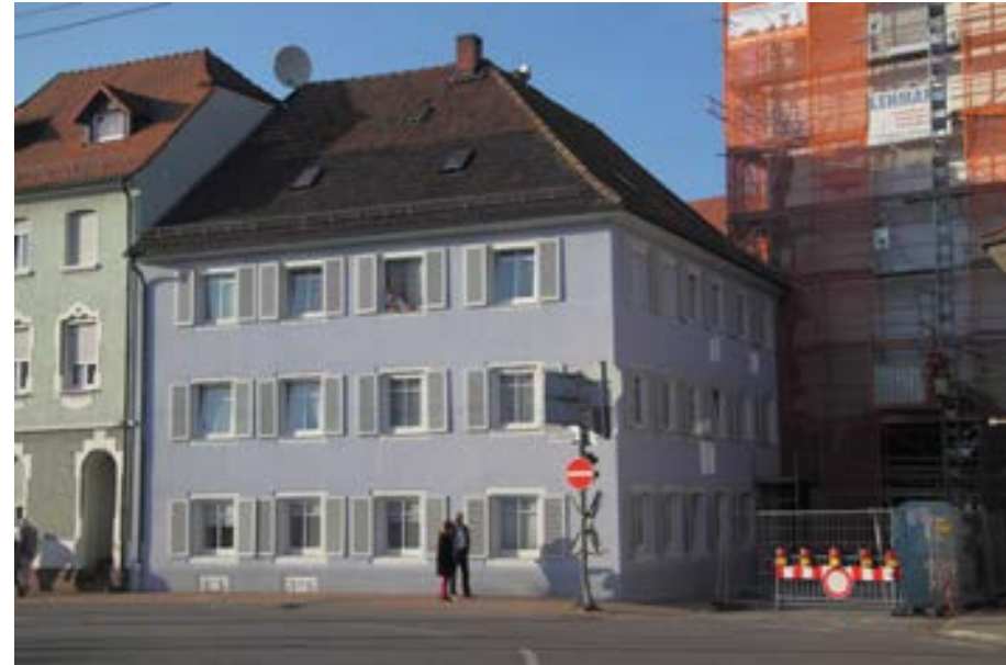
Eckansicht von Südosten mit eingerüstetem Kinzigturm
