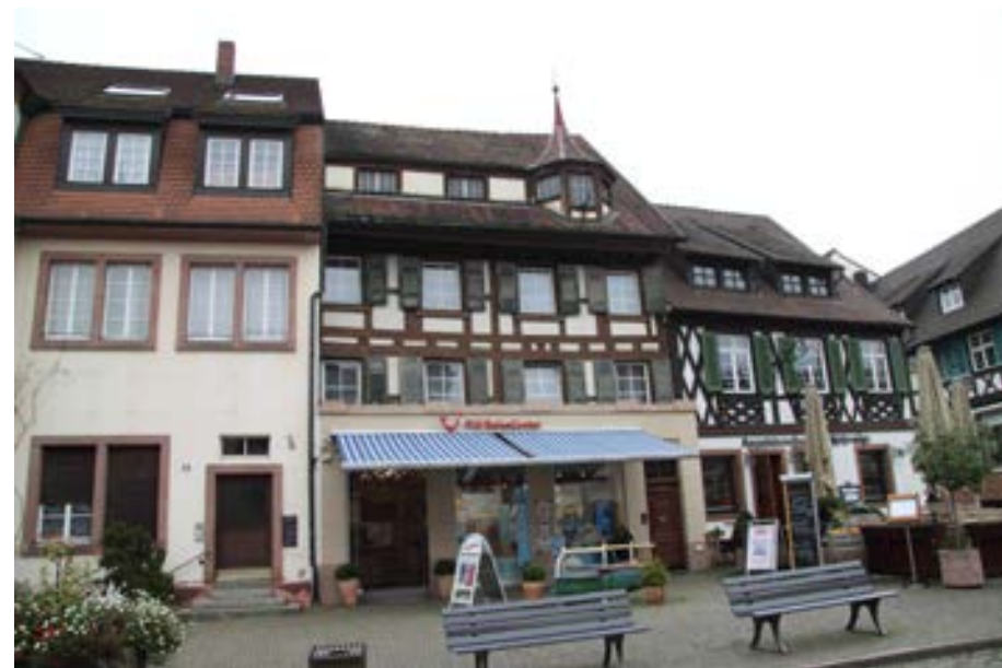
Ansicht der Front zur Victor-Kretz-Straße
