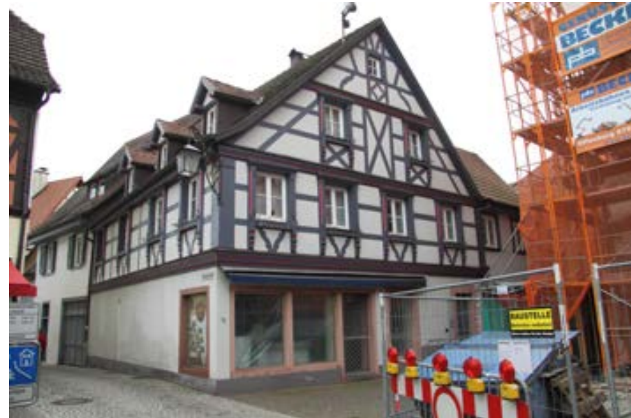
Ansicht gegen die Hauptstraße
