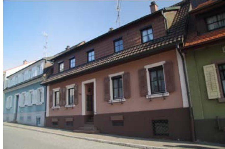
Ansicht gegen die Grabenstraße
