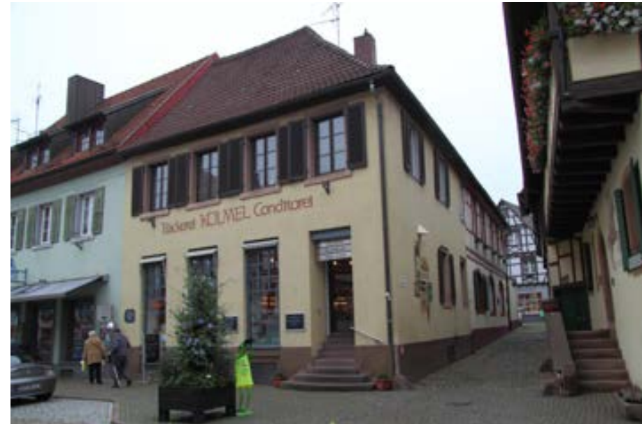
Ansicht gegen die Hauptstraße
