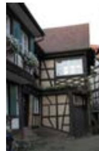
Südfassade mit Stubenfenster
