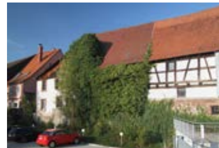
Rückgebäude gegen den Zwinger (2.v.l.)
