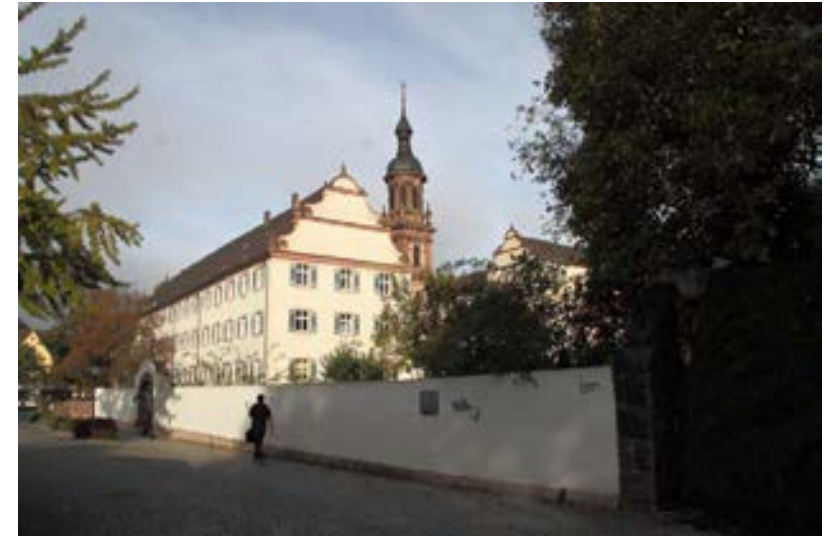
Ehem. Konventsbau und Kirche, von der Benedikt-von-Nursia-Straße aus gesehen.
