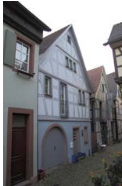
Nordfassade an der Engelgasse
