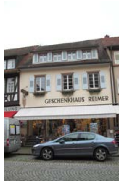
Ansicht der zur Victor-Kretz-Straße gewandten Traufseite mit Ladeneinbau
