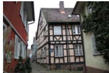
Rückansicht gegen die Engelgasse
