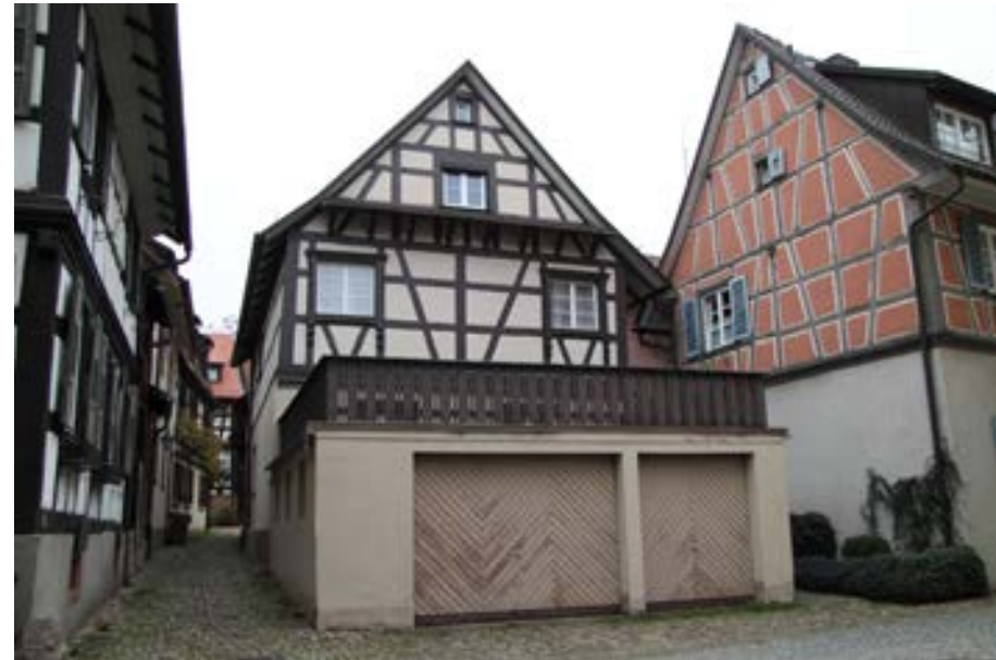
Ansicht der Giebelfront mit modernem Garagenvorbau
