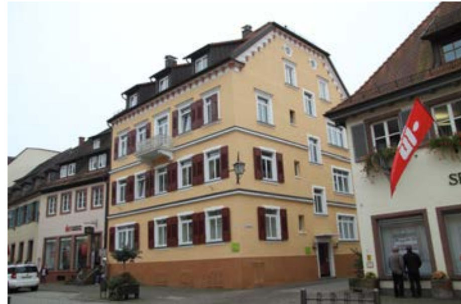
Ansicht gegen die Hauptstraße
