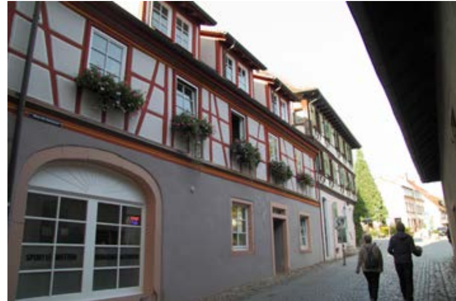
Ansicht gegen die Oberdorfstraße; links die heute in den Innenraum integrierte ehem. Zufahrt
