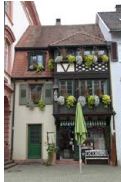
Ansicht der Fassade gegen die Hauptstraße
