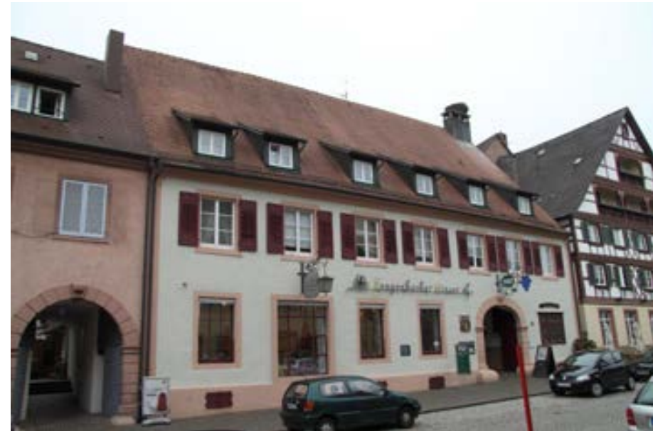
Ansicht der langgestreckten Fassade gegen die Hauptstraße
