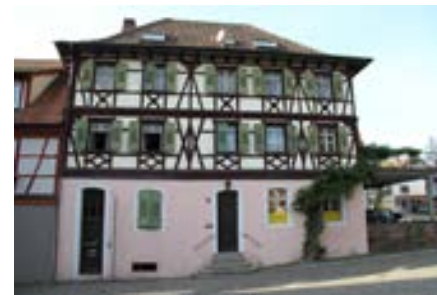
Ostfassade mit reichem Zierfachwerk
