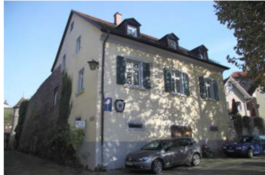
Das Gebäude sitzt mit seiner westlichen Giebelwand auf der Stadtmauer auf
