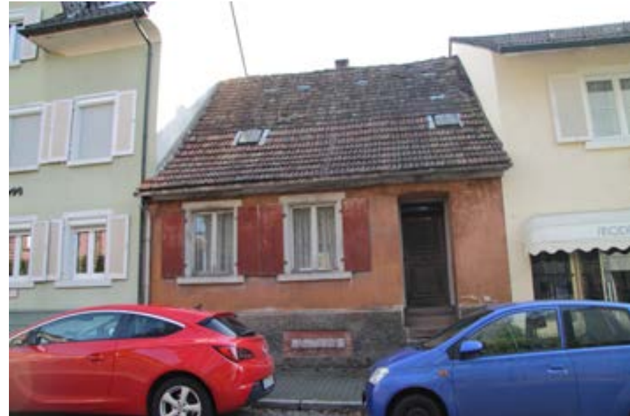
Ansicht gegen die Grabenstraße
