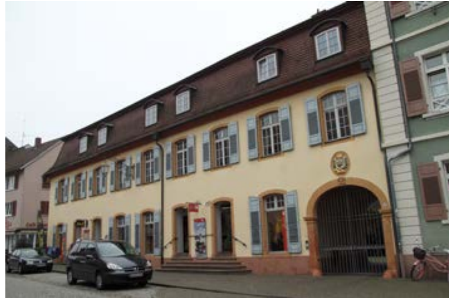
Ansicht gegen die Hauptstraße
