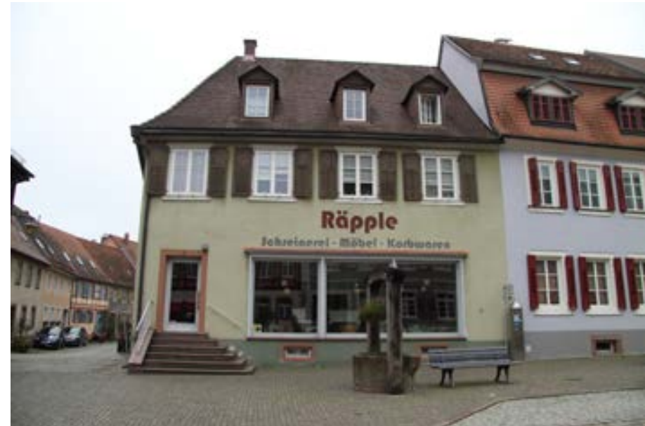
Ansicht gegen die Hauptstraße
