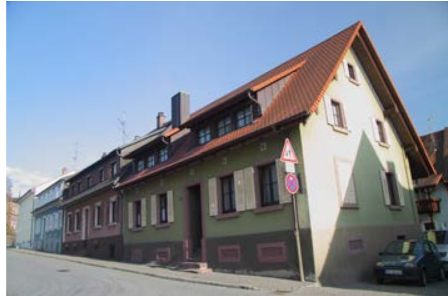
Ansicht gegen die Grabenstraße
