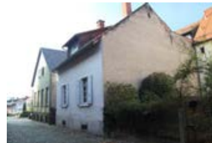
Rückgebäude an der Brenngasse
