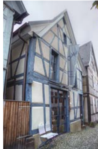
Nordfassade gegen die Engelgasse
