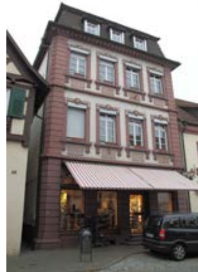
Ansicht gegen die Hauptstraße
