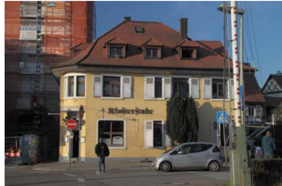
Ansicht von Süden mit eingerüstetem Kinzigturm
