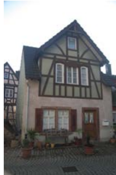
Blick auf die Hauptfassade gegen den Mercyschen Hof (Nordansicht)
