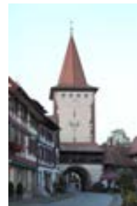
Ansicht von der Victor-Kretz-Straße
