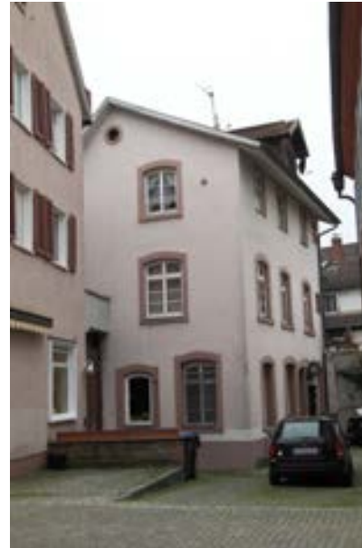
Ansicht gegen die Hauptstraße
