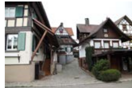
Ansicht gegen die Oberdorfstraße
