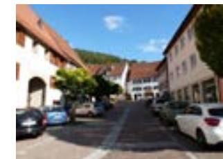
Ansicht von Westen
