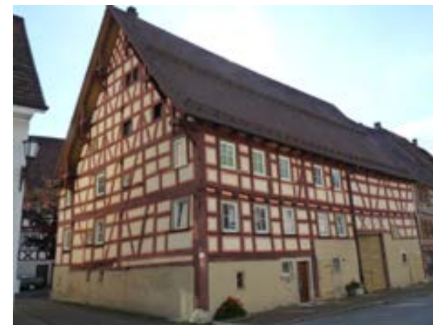
Ansicht von Nordosten
