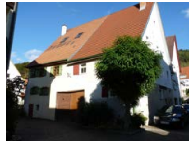
Ansicht mit Nr.2 von Südwesten
