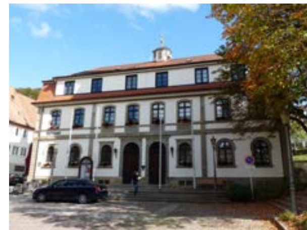
Rathaus, Ansicht von Westen
