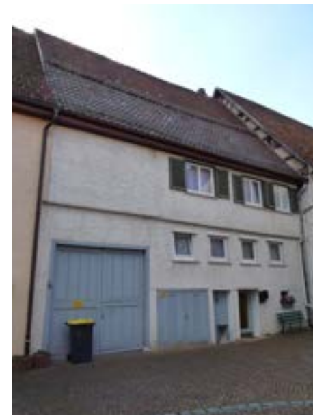
Ansicht von Nordosten
