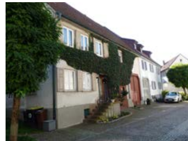
Ansicht von Nordosten
