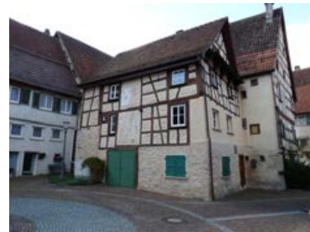
Ansicht von Nordosten
