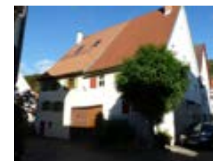
Ansicht mit Nr.4 von Südwesten
