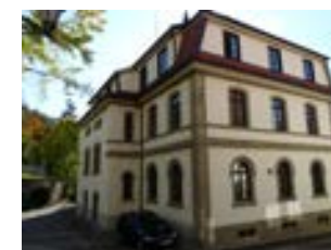
Rathaus, Ansicht von Nordwesten
