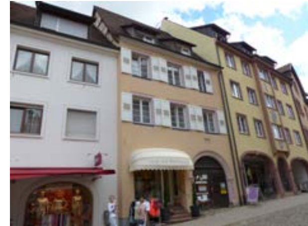
Ansicht von W
