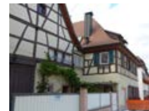
Ansicht von S von Hinter der Laube aus gesehen
