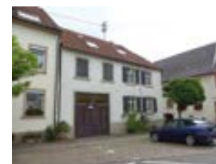
Ansicht von W
