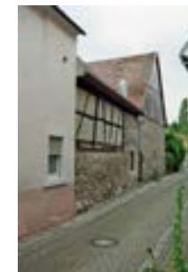
Scheune von Westen
