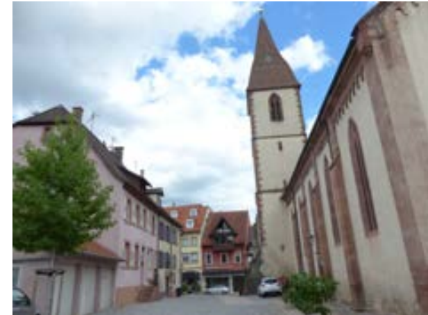
Bei der oberen Kirche, Blick von O
