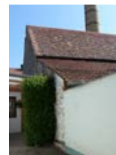
Rückwärtige Nebengebäude an der Nordseite
