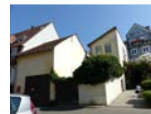
Rückgebäude Hauptstraße 56, Ansicht von N
