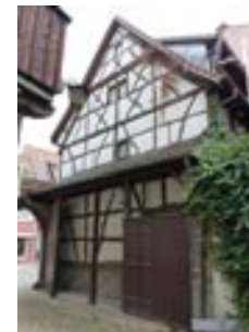
Ansicht von W
