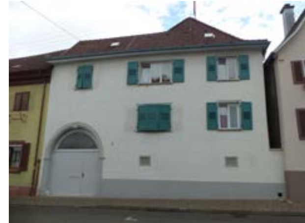
Ansicht von W
