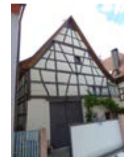
Nebengebäude, Ansicht von SO
