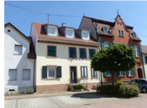
Ansicht von W
