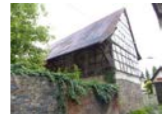
Ansicht von W
