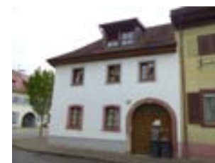
Ansicht von W
