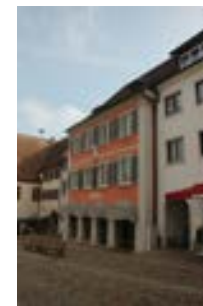
Wohn- und Geschäftshaus von Süd-Westen
