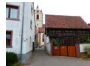
Unterkirchgäßli, Ansicht von S
