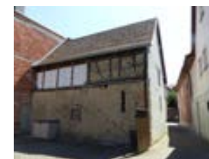
Rückwärtiger Ökonomieanbau, Ansicht von NW
