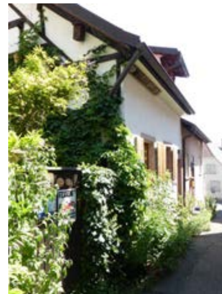
Ansicht von W
