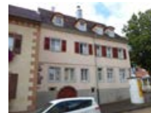
Lindenplatz 9, Ansicht von N
