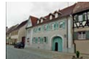
Wohnhaus von Nord-Westen
