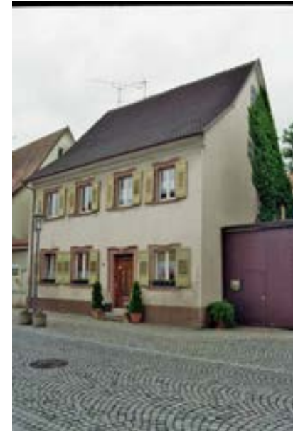
Wohnhaus von Nord-Westen
