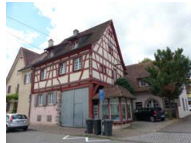
Dielenmarktstraße 16, Ansicht von NO
