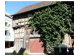
Rückwärtige Scheune, Ansicht von W
