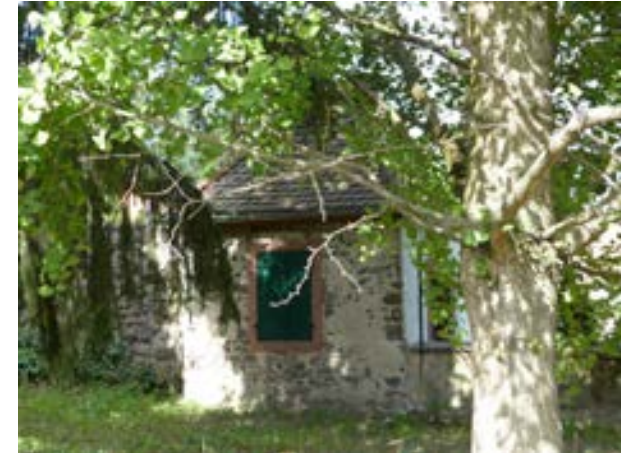
Ansicht von W
