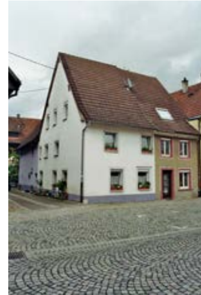
Wohn- und Wirtschaftsgebäude von Süd-Westen
