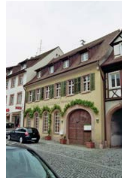
Wohnhaus von Süd-Osten
