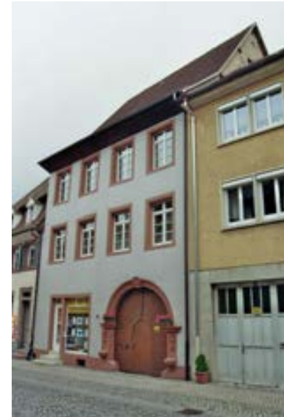
Wohn- und Geschäftshaus von Nord-Westen
