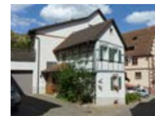
Ansicht von W
