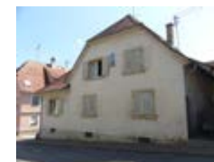
Ansicht von W
