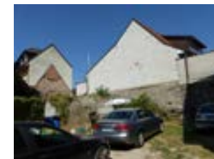
Hinterhof, Ansicht von SW
