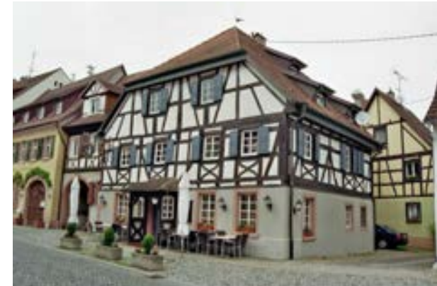
Wohnhaus von Süd-Osten
