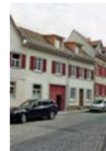
Lindenplatz 11 - Ansicht von Westen
