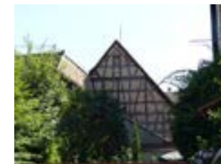
Nördliche Giebelwand, von An der Stadtmauer aus gesehen
