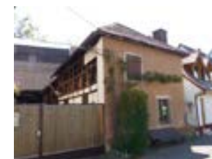
Nebengebäude, Ansicht von NO
