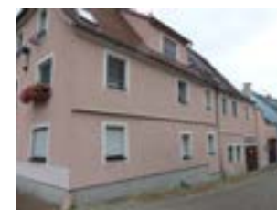
Ansicht von W
