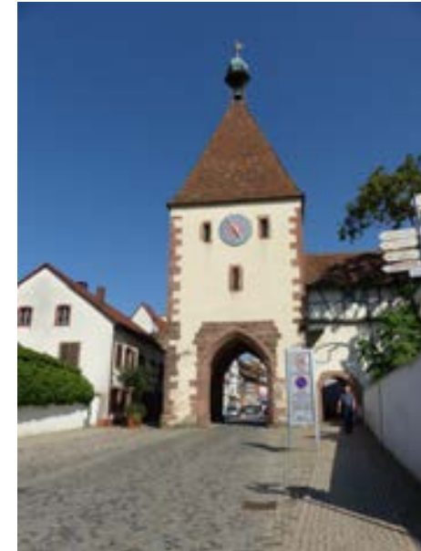
Ansicht von W
