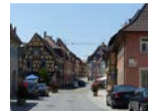
Hauptstraße, Blick von O Höhe des Marktplatzes
