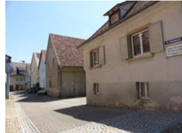
Im Gaiswasser, südlicher Gassenraum mit Blick nach O
