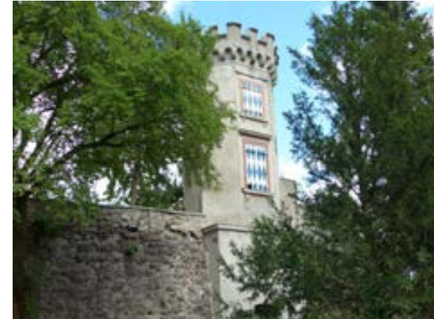
Ansicht von W
