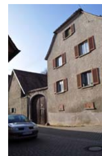
Fischergasse 36, Ansicht von S
