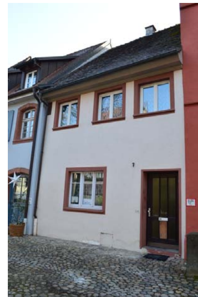
Mittelstadt 7, Ansicht von NW
