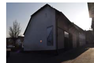
Fischergasse 21, Ansicht von NO
