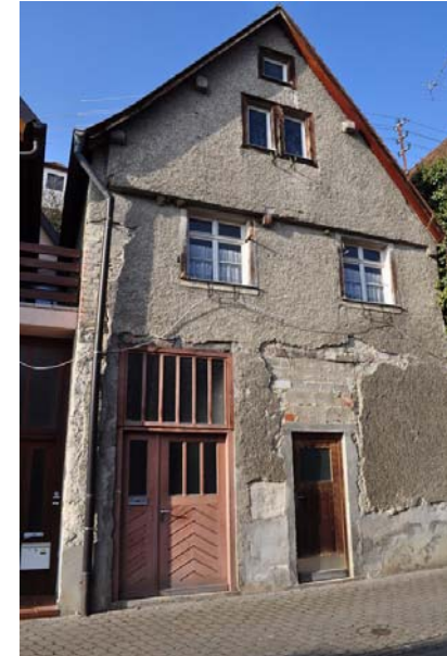
Fischergasse 40, Ansicht von S
