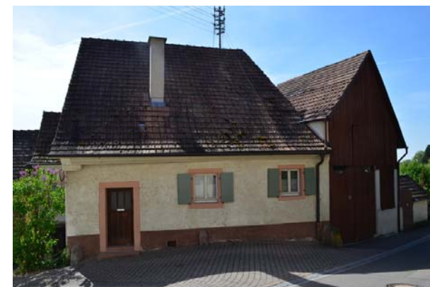
Fischergasse 35, Ansicht von N
