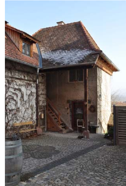
Spitalplatz 9, Ansicht von NW
