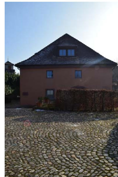
Bündlegasse 11, Ansicht von NW
