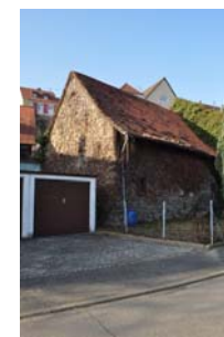
Fischergasse 19, Ansicht von O, von der Tullastraße aus gesehen
