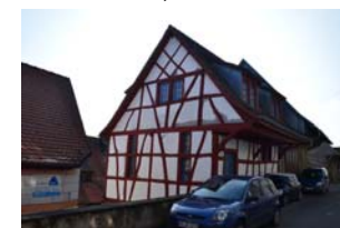
Mittelstadt 18, Rückgebäude, Ansicht von N
