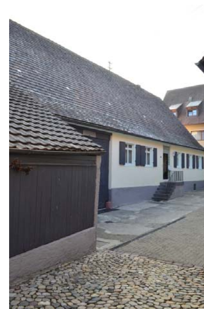
Mittelstadt 15, Ansicht von NW
