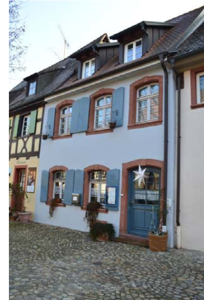
Mittelstadt 5, Ansicht von Osten
