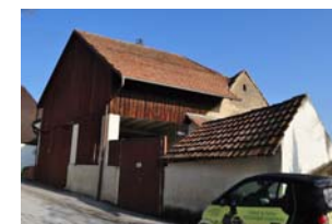
Fischergasse 35, Scheune, Ansicht von W
