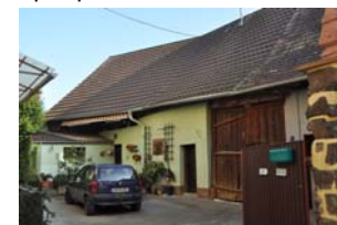
Spitalplatz 3, Scheune, Ansicht von SW
