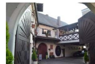
Mittelstadt 13, Rückgebäude, Ansicht von NW
