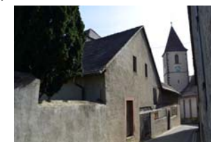
Am Kirchberg 5, Ansicht von Süden
