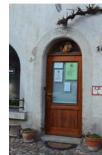
Mittelstadt 16, straßenseitige Eingangstüre
