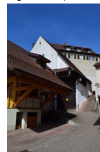
Fischergasse 34 (Bereich), Ansicht von SO
