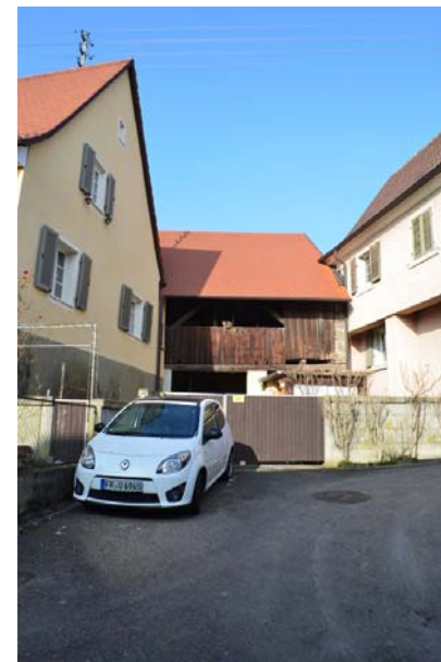
Am Kirchberg 14 (bei), Scheune, Ansicht von Südosten
