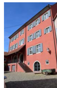
Mittelstadt 9, Rückansicht von O, vom Spitalplatz aus gesehen
