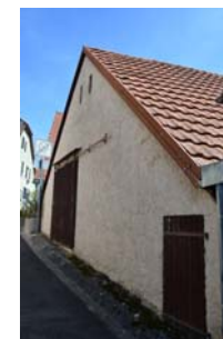
Mittelstadt 28, rückwärtige Scheune
