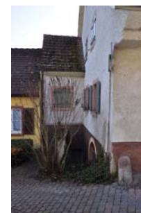
Fischergasse 35, Ansicht von NO
