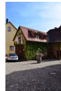
Spitalplatz 9 (bei), Scheune, Ansicht von W
