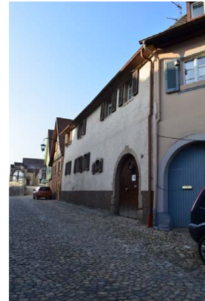
Mittelstadt 24, Ansicht von NO
