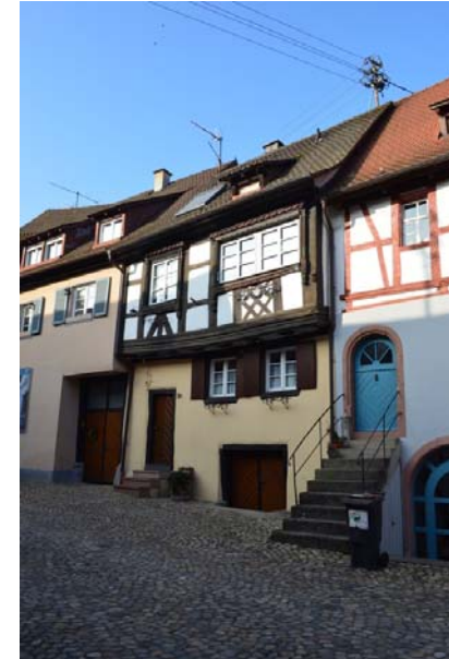
Mittelstadt 20, Ansicht von NO
