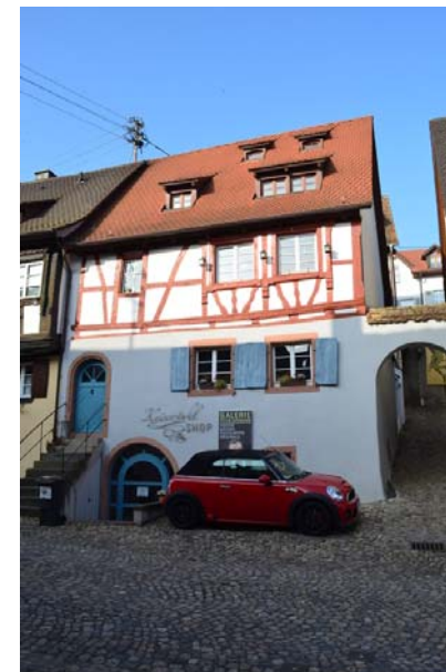
Mittelstadt 18, Ansicht von NO
