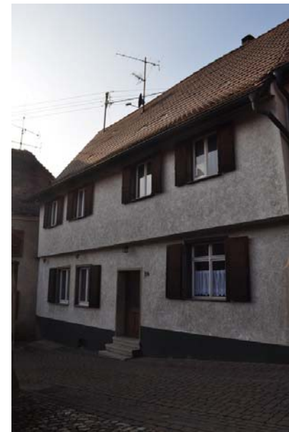
Fischergasse 34, Ansicht von NO
