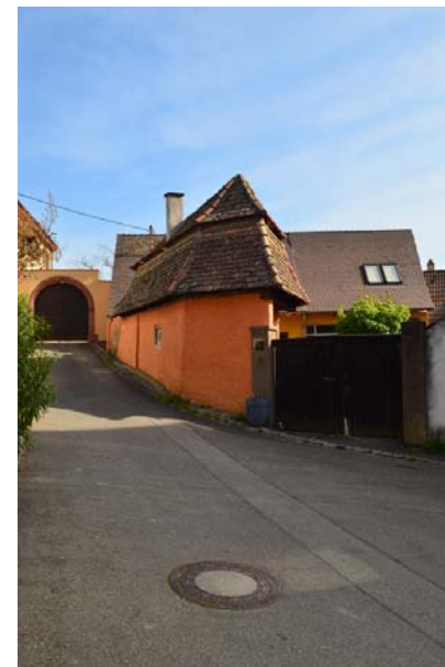
Am Kirchberg 22, Ansicht von SW
