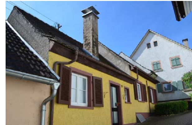
Fischergasse 33, Ansicht von NO
