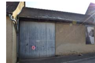
Mittelstadt 6, rückwärtige Scheune an der Jörg-Wickram-Gasse, Ansicht von W
