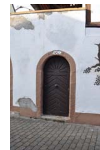
Fischergasse 48, Fußgängertür, Ansicht von SO
