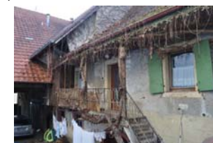
Fischergasse 25, Innenhof, Ansicht von N
