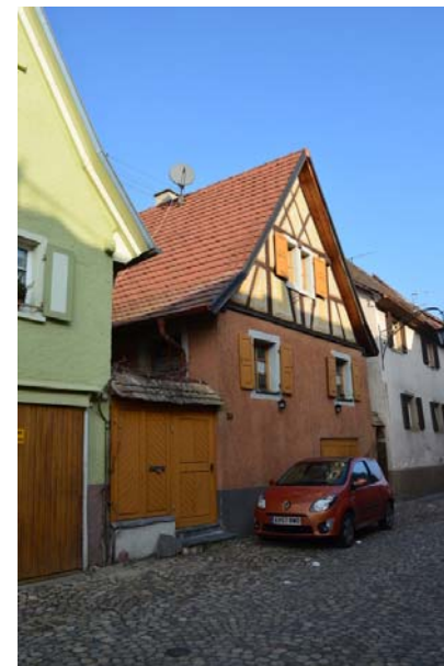
Mittelstadt 26, Ansicht von SO
