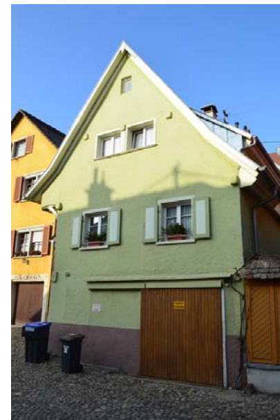
Mittelstadt 28, Ansicht von NO
