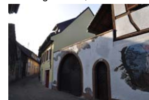
Fischergasse 48, Tordurchfahrt und Fußgängertür, von SO
