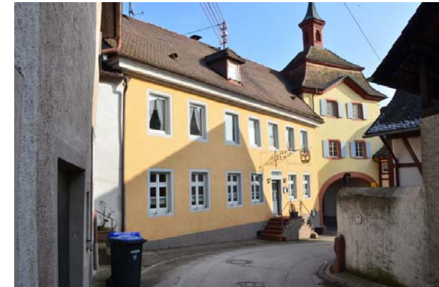
Am Kirchberg 2, Hauptfassade von SW
