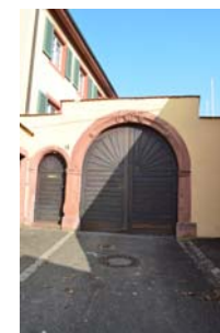
Am Kirchberg 13, Torbogen und Tür an der Südseite
