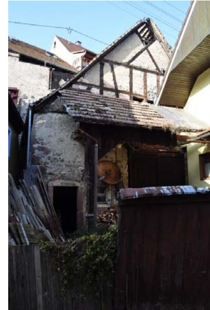
Fischergasse 52, Ansicht von S
