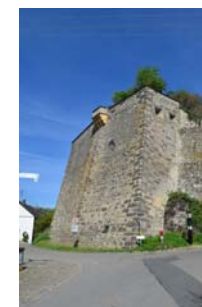
Mittelstadt, Burgruine, Substruktionsmauer mit Erker, Blick auf die Südseite des Schloßbergspornes
