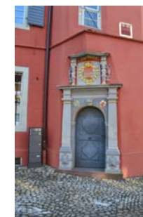
Mittelstadt 9, Eingangportal am Treppenturm
