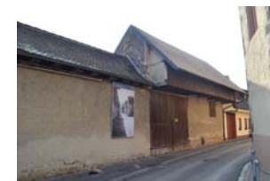
Mittelstadt 8, rückwärtige Scheune an der Jörg-Wickram- Gasse, Ansicht von W
