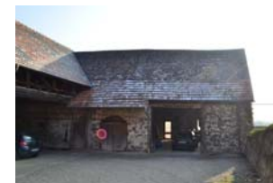
Mittelstadt 11, rückwärtige Scheune, Ansicht von W
