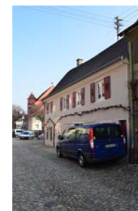
Mittelstadt 17 a, Ansicht von Südwesten
