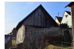
Spitalplatz 3, Scheune, Rückansicht von NO
