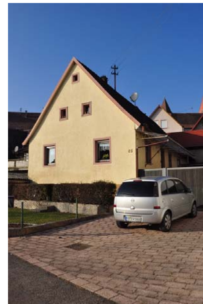
Tullastraße 25, Ansicht von SO
