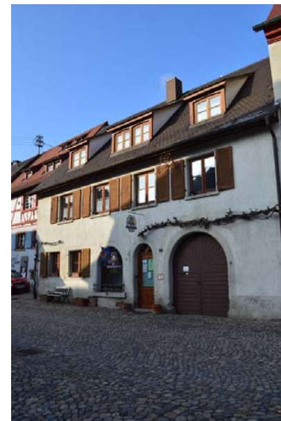
Mittelstadt 16, Ansicht von NO
