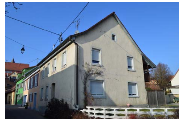
Fischergasse 2, Ansicht von SO am Beginn der Fischergasse
