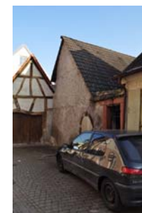
Tullastraße 25, Rückansicht an der Fischergasse
