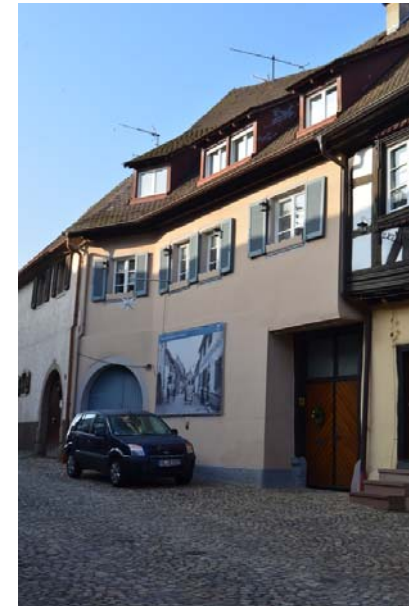
Mittelstadt 22, Ansicht von SO
