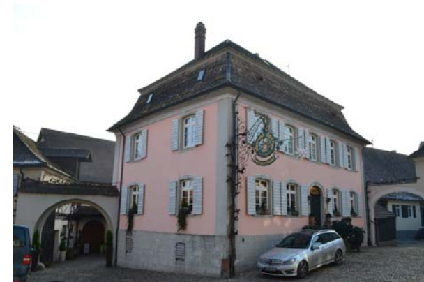
Mittelstadt 13, Ansicht von NW
