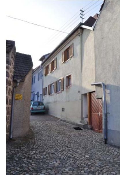
Mittelstadt 32, Ansicht von NO
