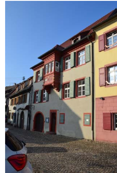
Mittelstadt 14, Ansicht von NO
