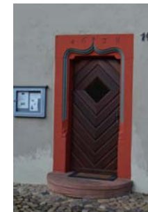
Mittelstadt 14, Eingangstür an Straßenfassade
