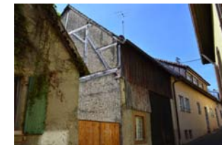
Fischergasse 27, Ansicht von NO
