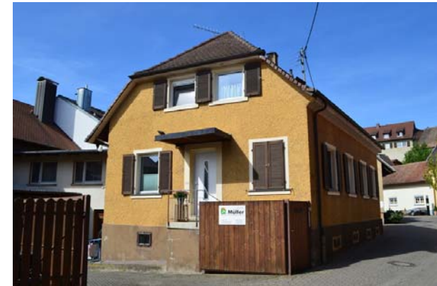
Fischergasse 1, Ansicht von O
