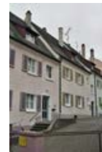
Münsterbergstraße 2, 4 - Wohnhaus, Nordseite
