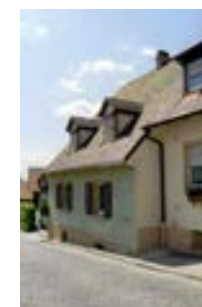
Wohnhaus von Osten
