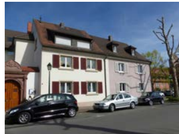
Ansicht von W
