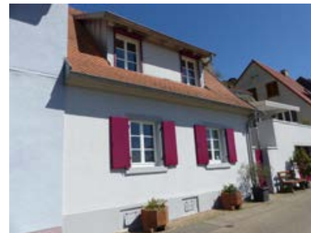
Ansicht von W
