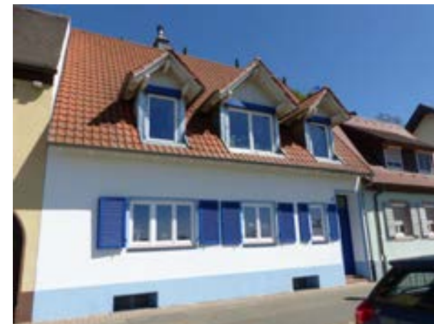
Ansicht von W
