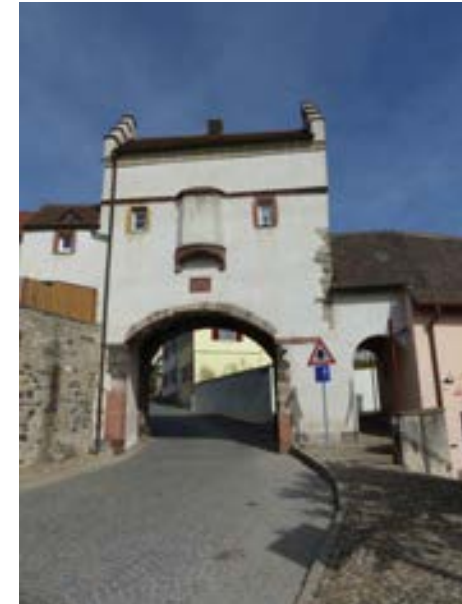
Ansicht von W
