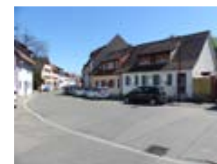
Rheintorstraße, Ansicht von W auf Höhe Rheintorstraße 34
