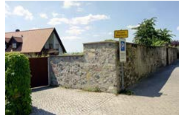
Grundstücksmauer entlang der Ostseite des Grundstücks
