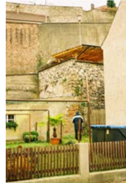
Bauwerk aus Bruchstein von Nordwesten
