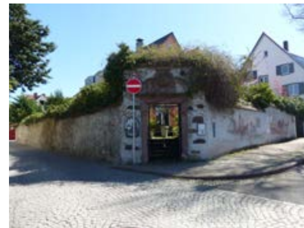
Portal, Ansicht von NW
