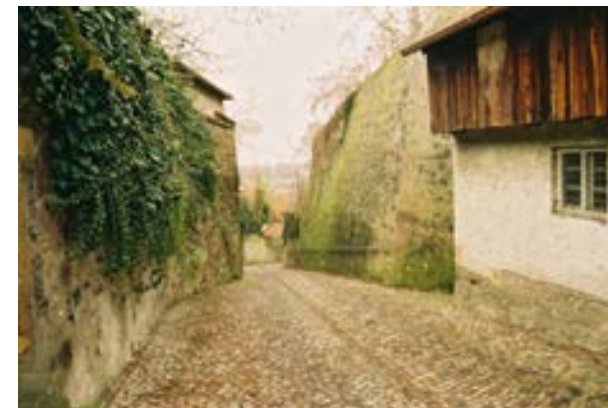
Rechts: Stützmauer hinter Augustinerberg 4
