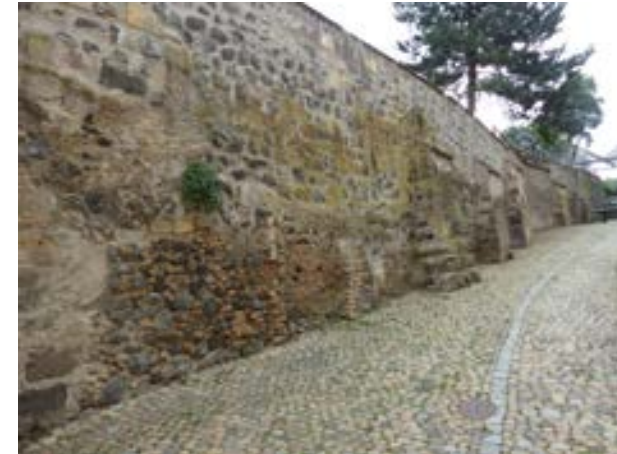
Ansicht von NW auf Höhe des Nebengebäude Schulgasse 3
