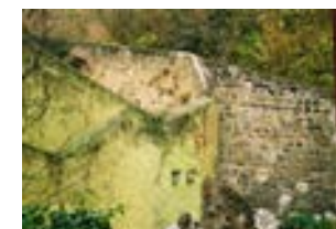
Substruktionsmauer, rückwärtig von Fischerhalde 38
