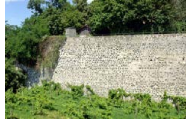
Stützmauer und Grabenbereich
