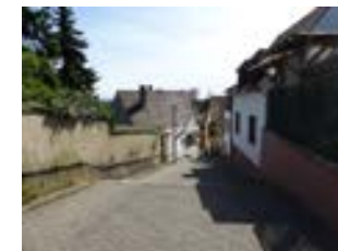
Ansicht von NO auf Höhe der Schänzletreppe 3
