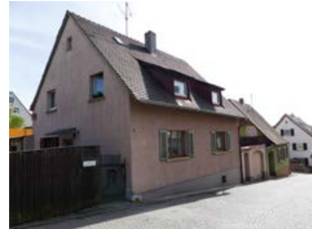
Ansicht von W
