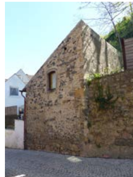
Ansicht von W
