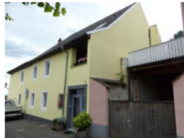
Ansicht von W
