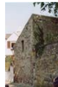
Stützmauer bei Augustinerberg 8
