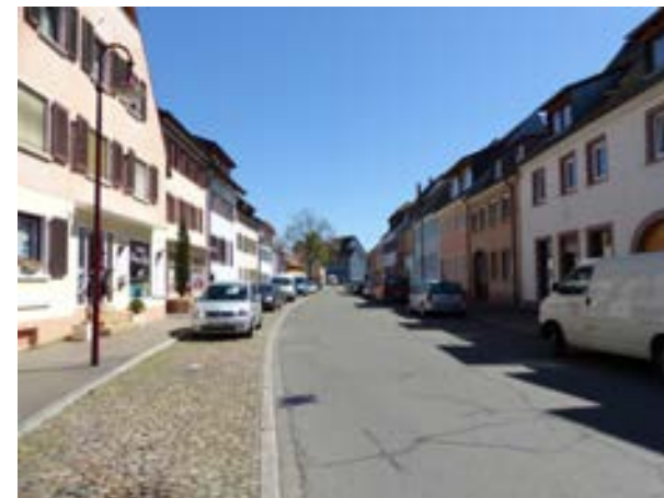
Rheintorstraße, Ansicht von W auf Höhe des Synagogenplatzes
