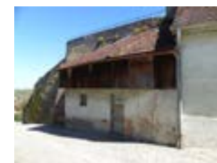
Nebengebäude von SW
