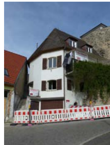
Ansicht von W
