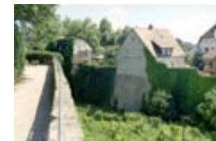
Substruktionsmauern und Grabenbereich
