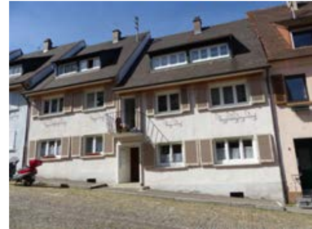
Nr. 10, Ansicht von SO
