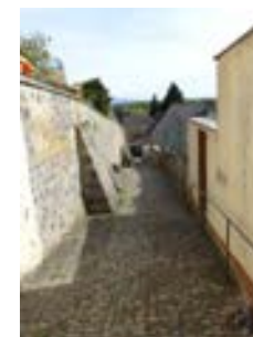
Schwanenrain, Ansicht von NO
