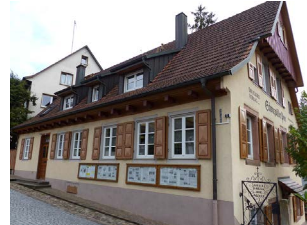
Ansicht von W
