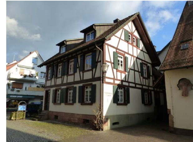
Ansicht von W
