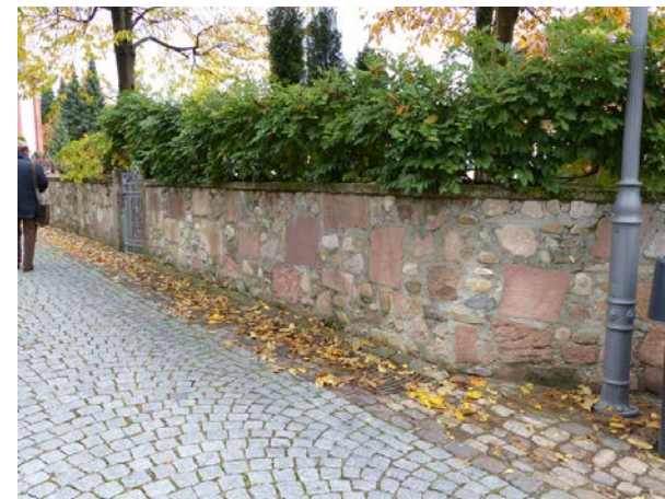
Ansicht von W
