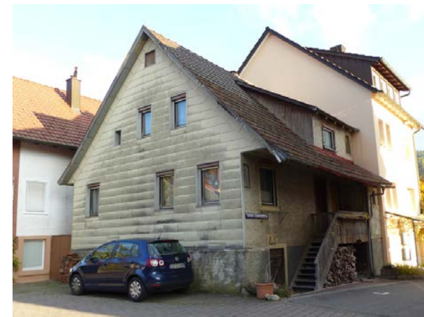
Ansicht von W
