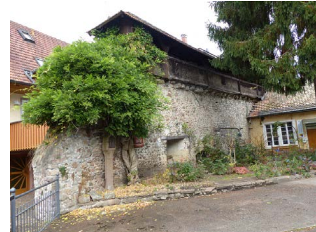
Stadtmauer bei Am Bach 1, Ansicht von SW
