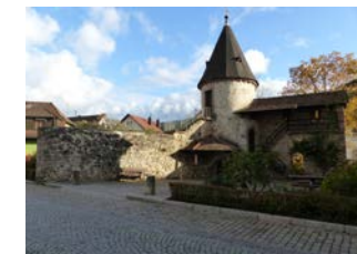
Hirschturm, Ansicht von N
