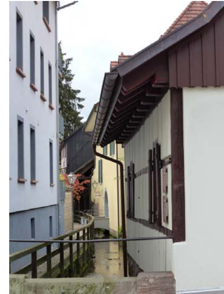
Ansicht von O, auf Höhe Kirchstraße 7
