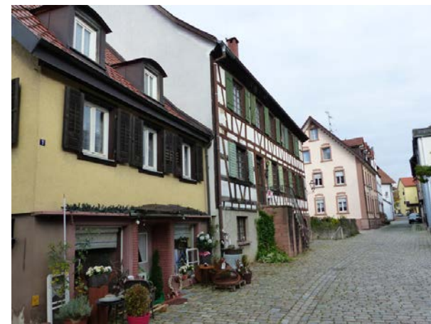
Ansicht von W
