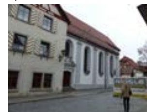
Spitalstraße 22 von SO
