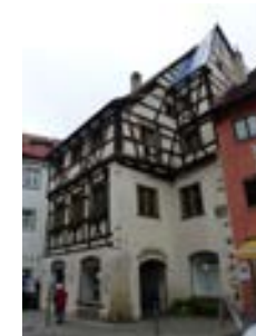
Schmiedstraße 1 bzw Trinklaube 2 von SW
