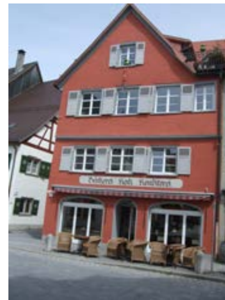
Wangen im Allgäu, Bindstraße 27 v. SW
