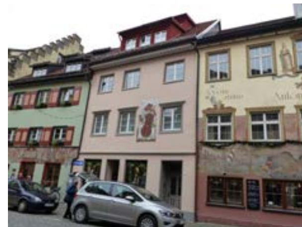
Wangen im Allgäu, Paradiesstraße 5, v. NW
