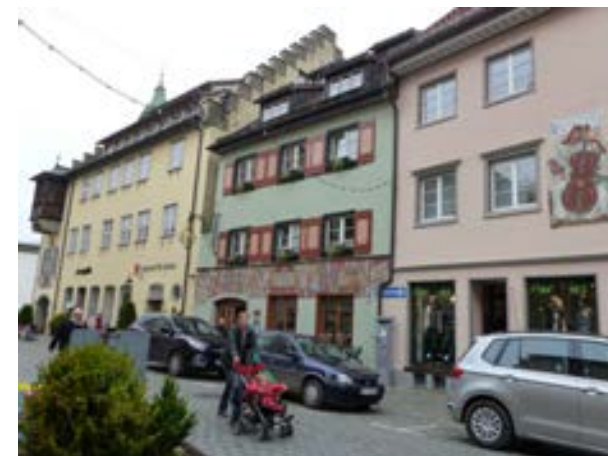
Wangen im Allgäu, Paradiesstraße 3, v. NW
