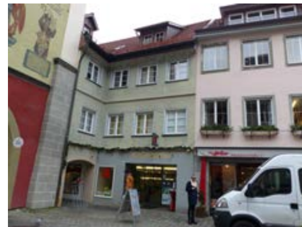
Wangen im Allgäu, Paradiesstraße 8/Martinstorplatz 4, v. SW
