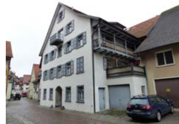
Wangen im Allgäu, Lange Gasse 51, v. SW
