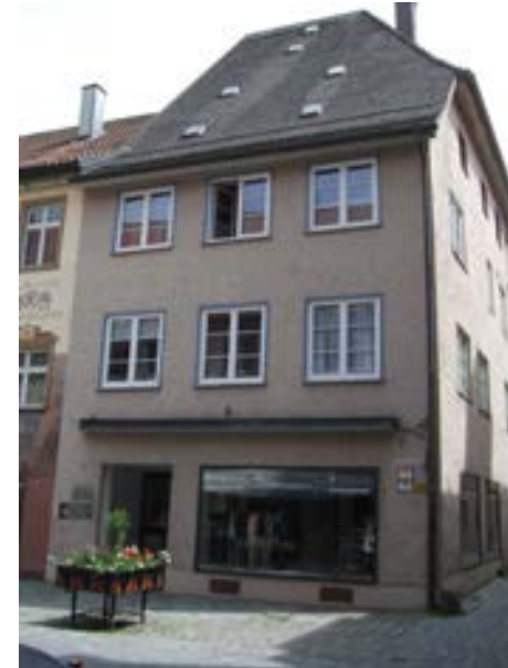
Wangen im Allgäu, Paradiesstraße 9, v. NW
