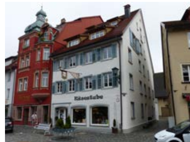
Wangen im Allgäu, Bindstraße 51 v. SW
