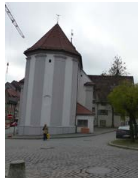
Spitalstraße 22 von N
