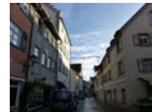
Bild Braugasse nach S Höhe Nr 23
