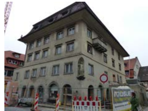
Bild Bindstraße 1 von SW
