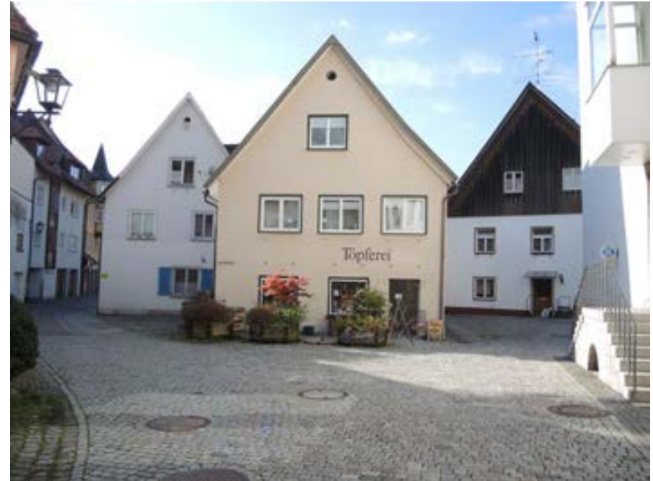
Ansicht des Gebäudes von Osten
