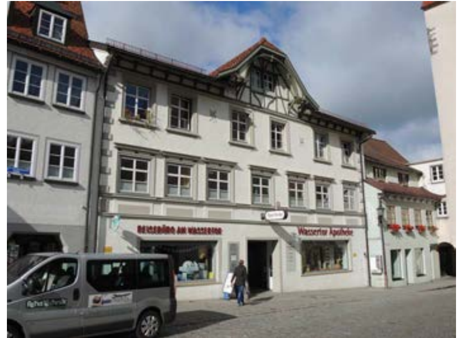
Ansicht des Gebäudes von Südosten
