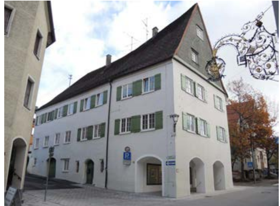
Ansicht des Gebäudes von Westen
