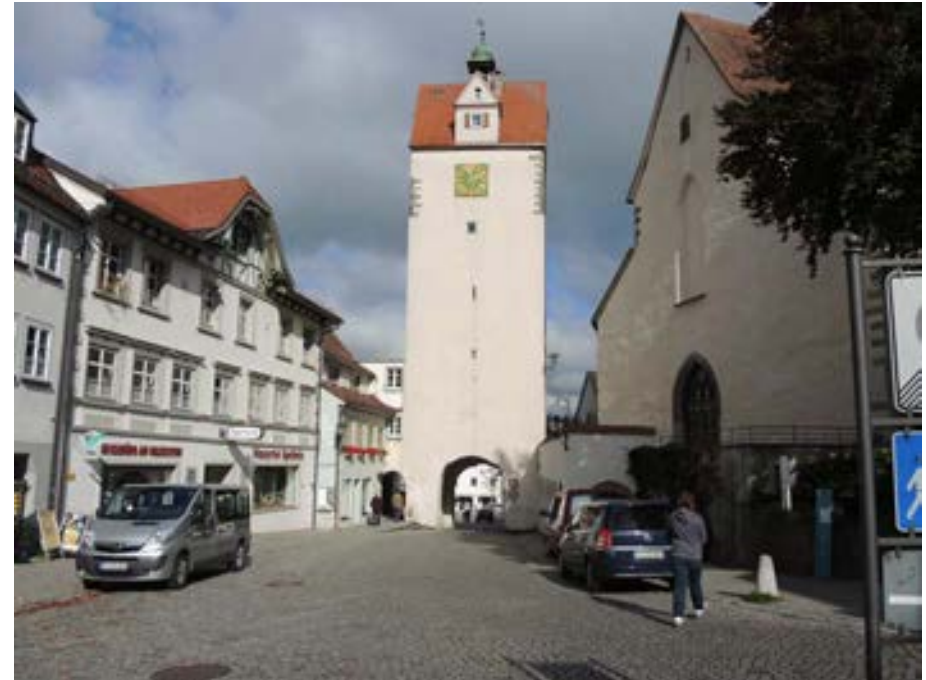
Ansicht des Wassertorturms von Südwesten
