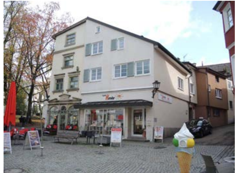
Ansicht des Gebäudes von Westen
