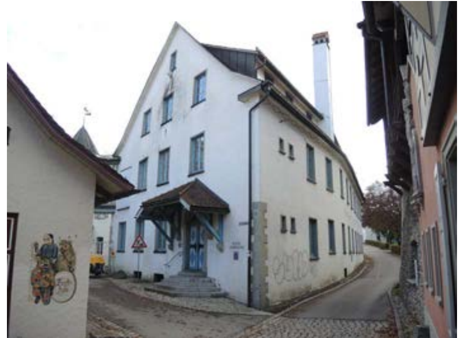
Ansicht des Gebäudes von Norden
