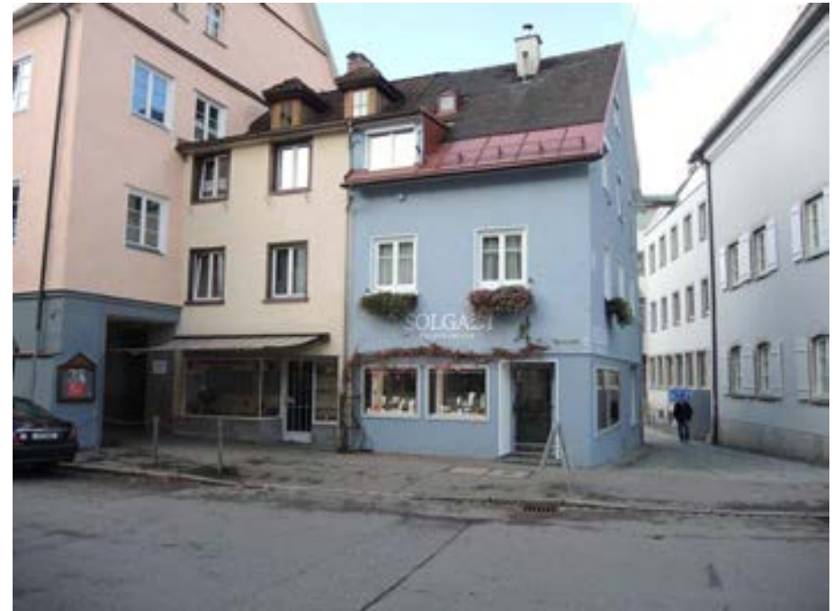
Ansicht des Gebäudes von Osten
