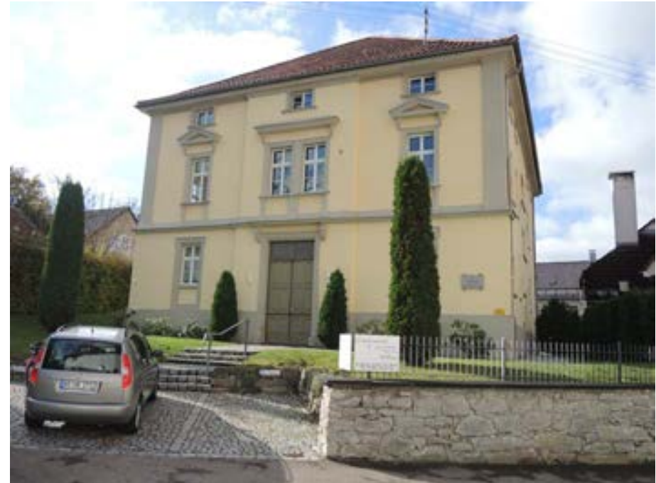
Ansicht des Gebäudes von Osten
