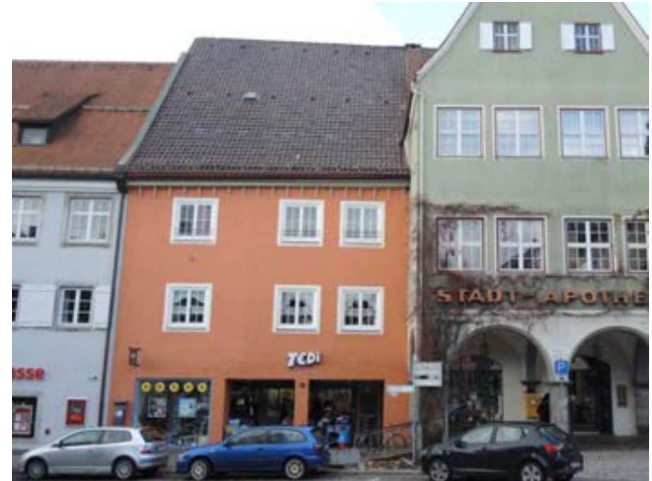
Ansicht des Gebäudes von Südosten
