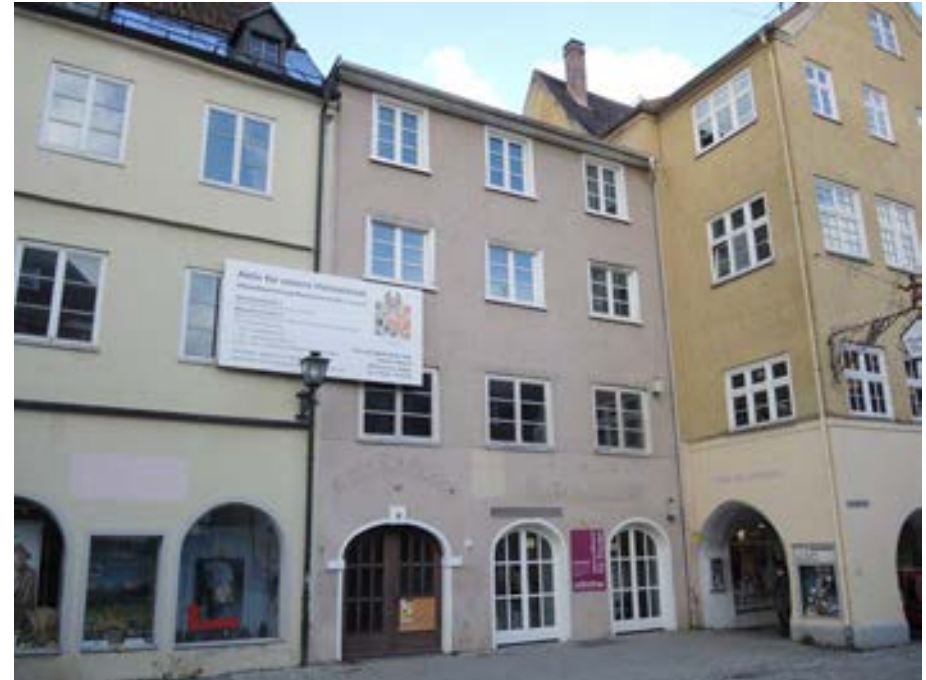
Ansicht des Gebäudes von Südosten
