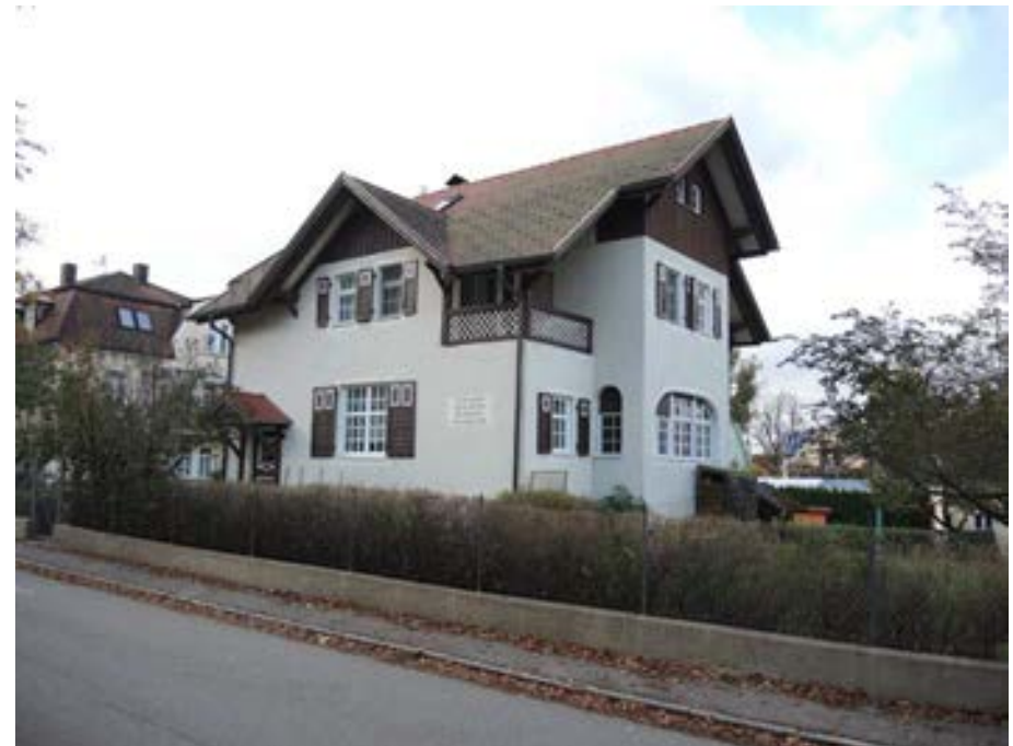
Ansicht des Gebäudes von Südosten
