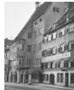
Ansicht von Nordosten um 1940
