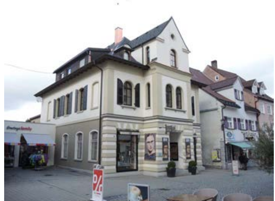
Ansicht des Gebäudes von Südosten
