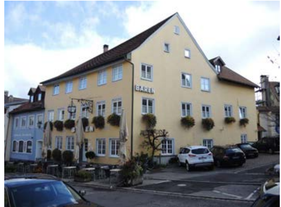
Ansicht des Gebäudes von Westen
