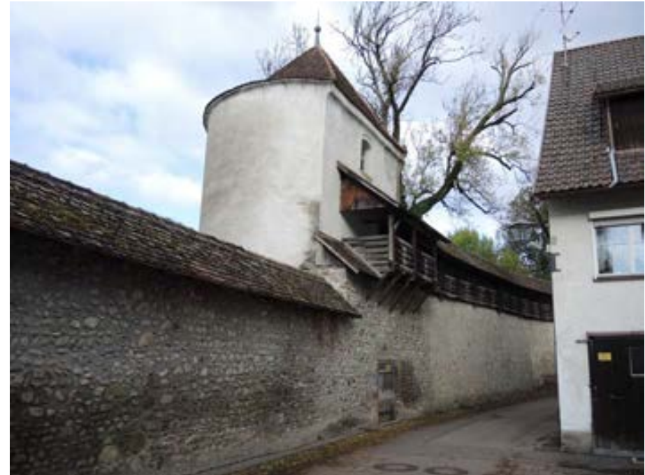
Ansicht des Speicherturm von Süden
