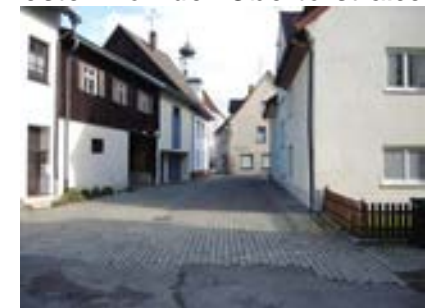
❷ Blick nach Osten bei Hausnr. 9
