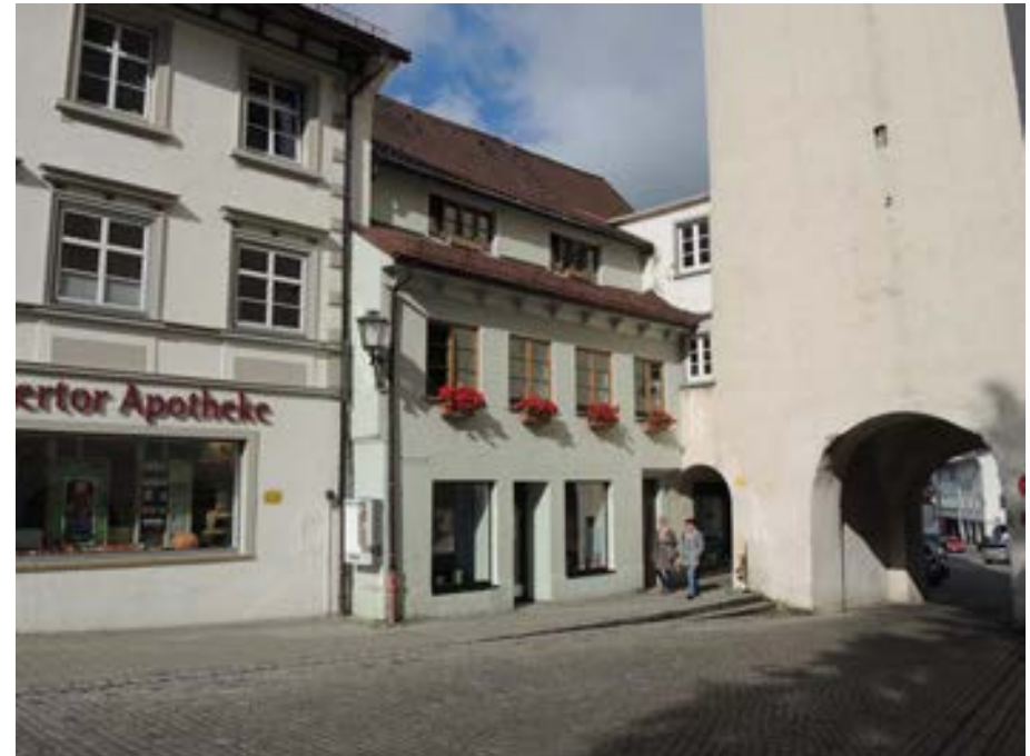
Ansicht des Gebäudes von Südosten
