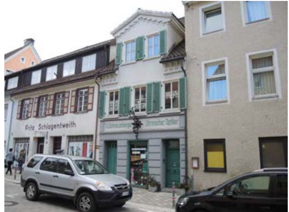
Ansicht des Gebäudes von Norden
