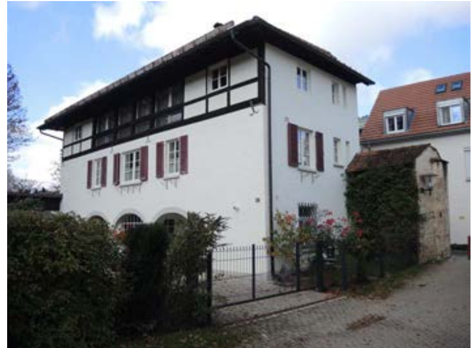
Ansicht des Gebäudes von Südosten
