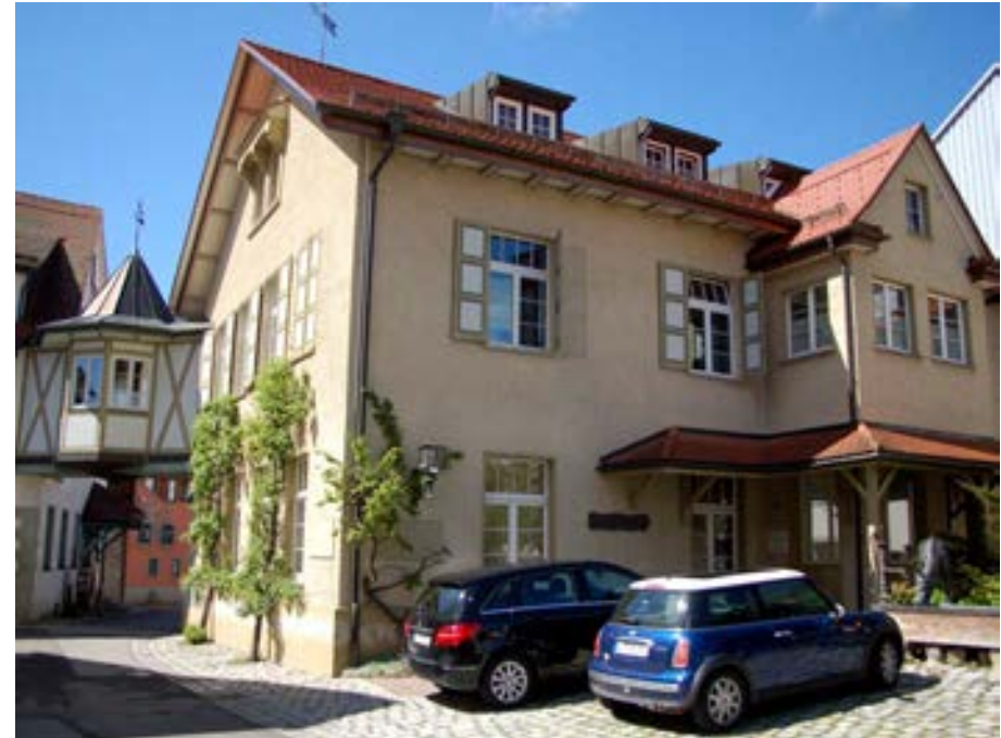
Ansicht des Gebäudes von Südosten
