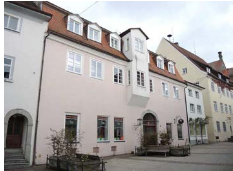
Ansicht des Gebäudes von Westen
