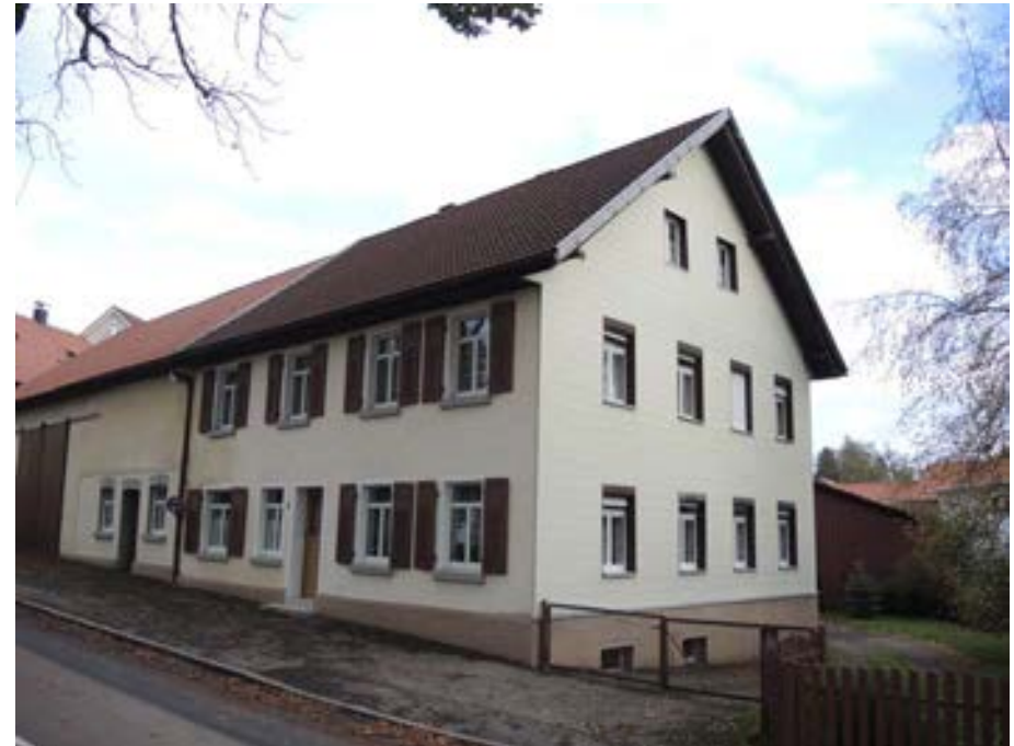
Ansicht des Gebäudes von Nordwesten
