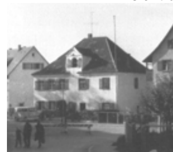
Ansicht von Südosten 1961
