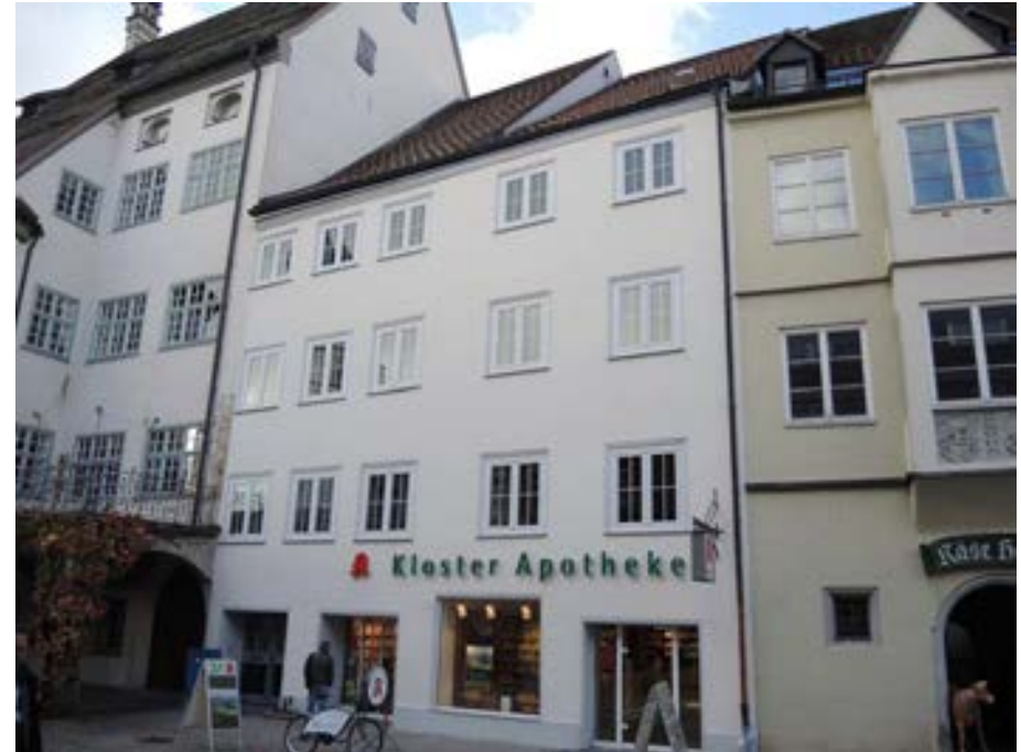
Ansicht des Gebäudes von Osten
