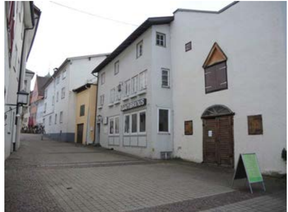
Ansicht des Gebäudes von Nordwesten
