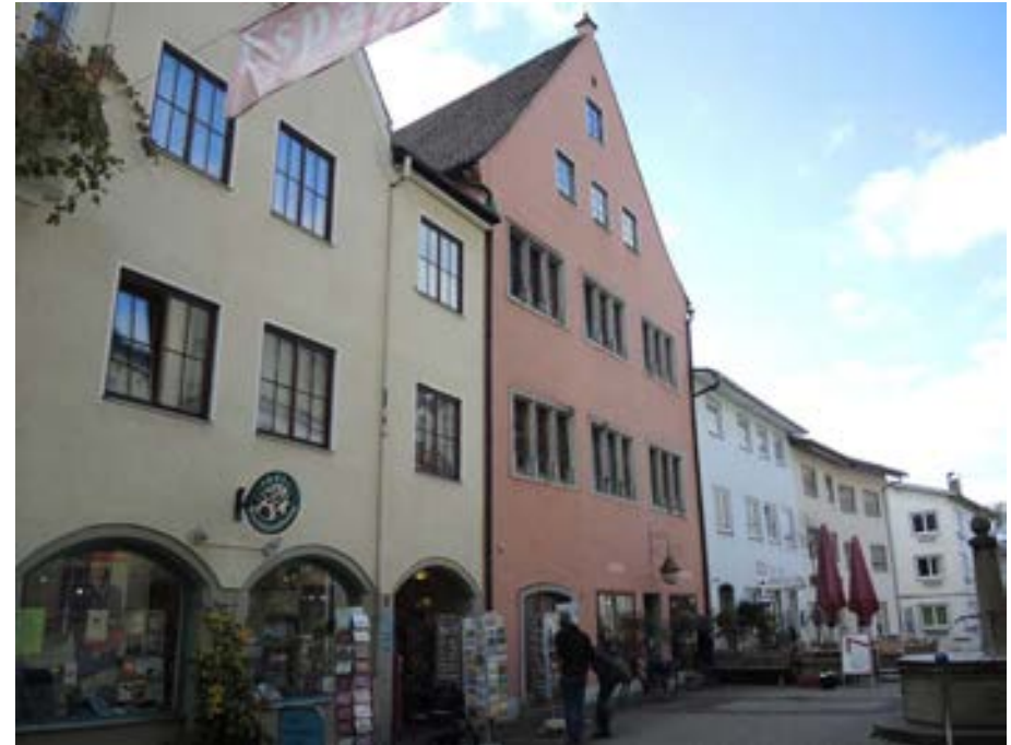
Ansicht des Gebäudes von Osten
