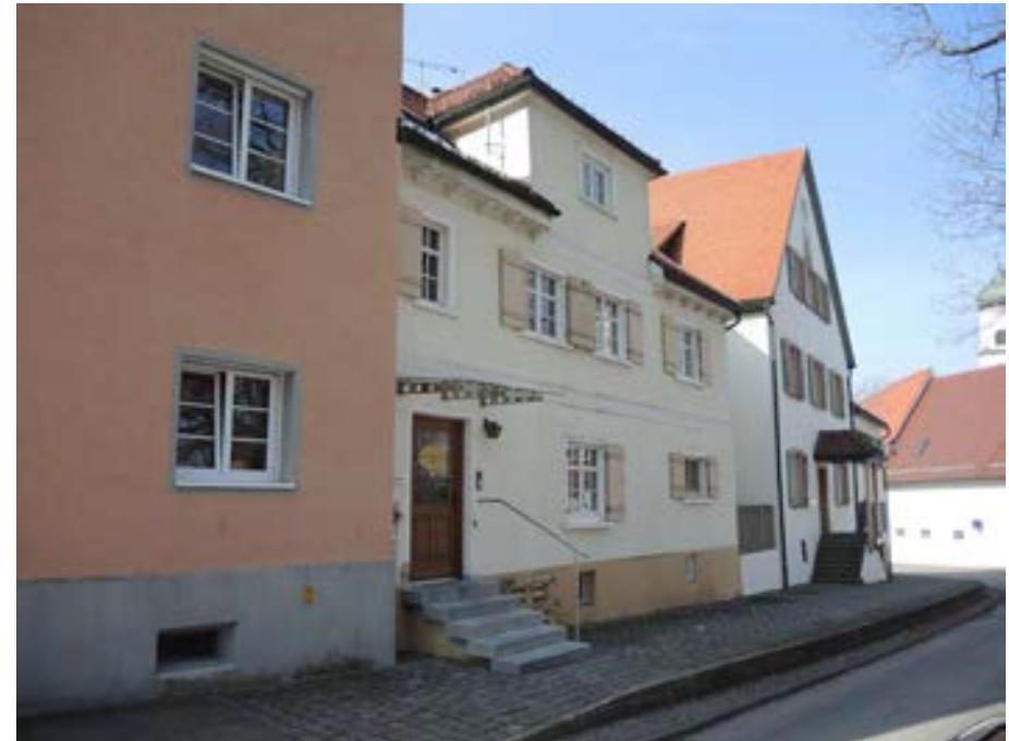
Ansicht des Gebäudes von Südosten
