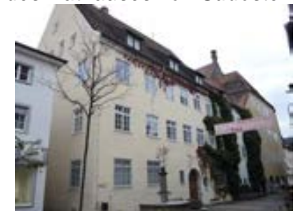
Ansicht Espantorstraße 6 von Westen
