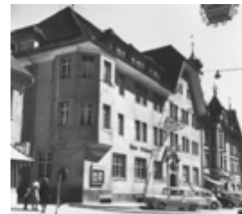
Ansicht von Norden 1962
