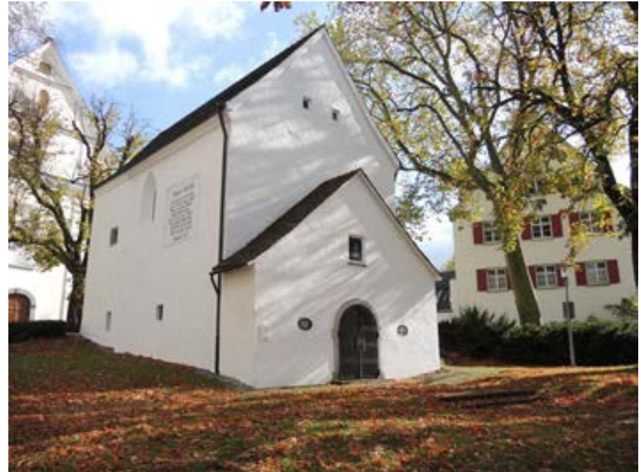
Ansicht der Ölbergkapelle von Nordwesten
