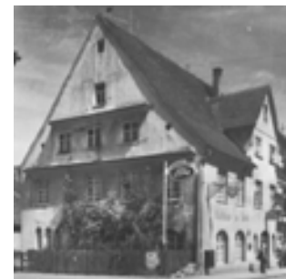
Ansicht von Südosten 1962
