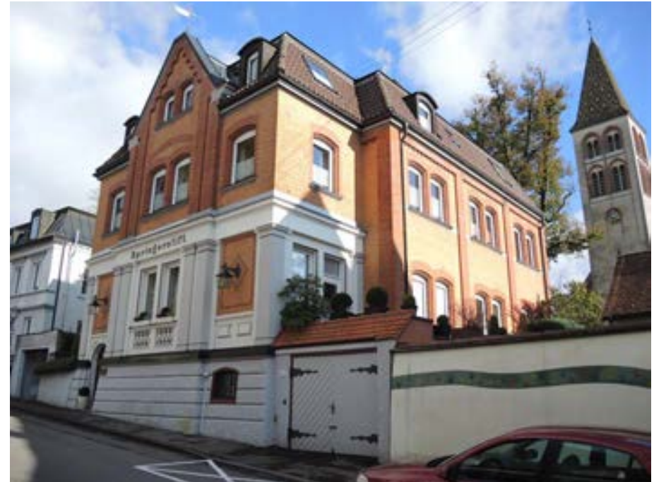
Ansicht des Gebäudes von Westen
