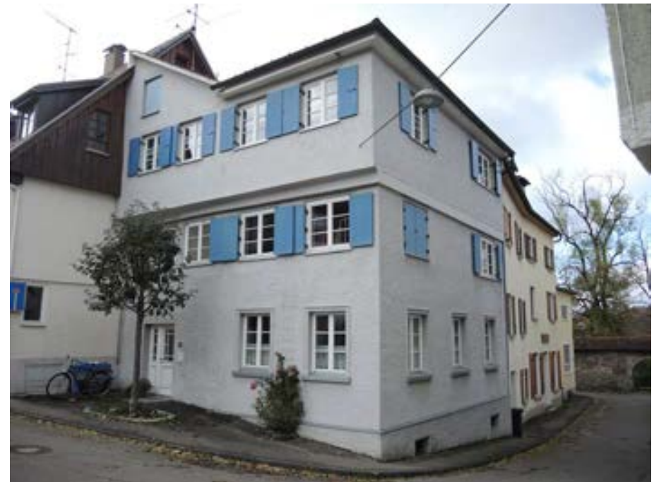
Ansicht des Gebäudes von Osten
