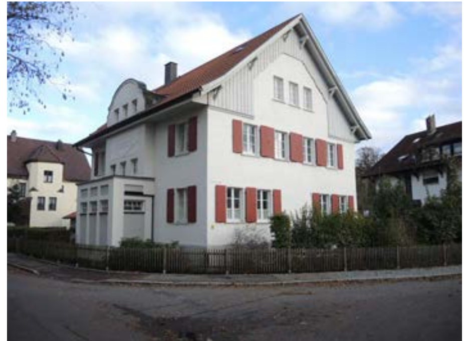
Ansicht des Gebäudes von Nordwesten
