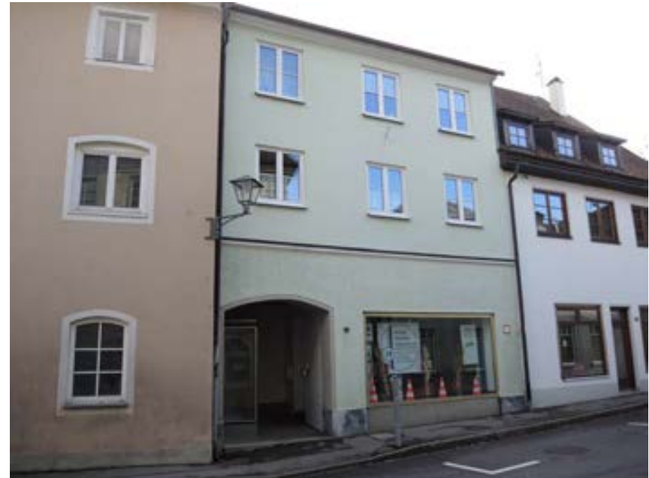
Ansicht des Gebäudes von Norden
