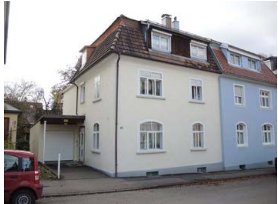
Ansicht des Gebäudes von Osten
