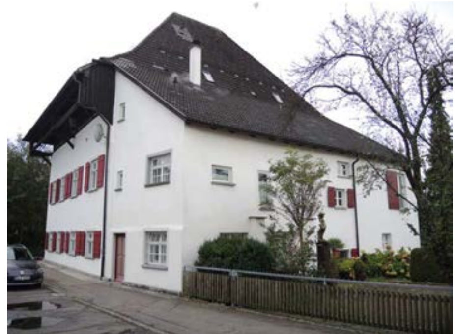
Ansicht des Gebäudes von Osten
