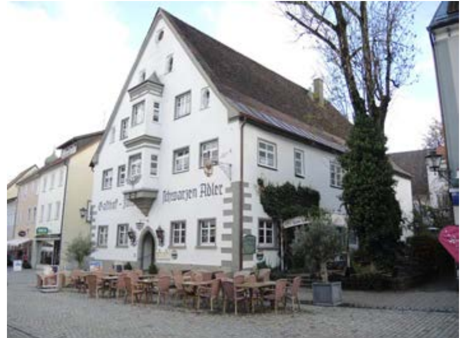
Ansicht des Gasthofes von Südwesten
