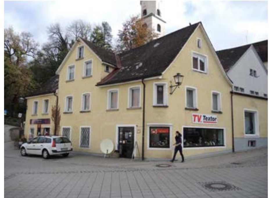
Ansicht des Gebäudes von Nordwesten
