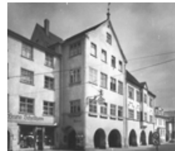
Ansicht von Südosten 1962
