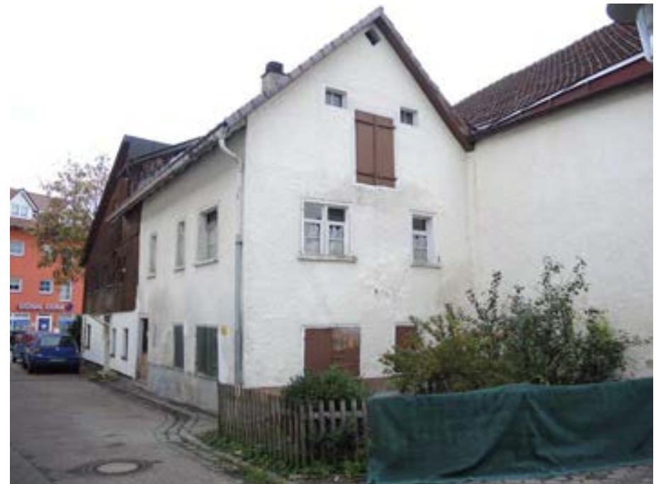
Ansicht des Gebäudes von Osten
