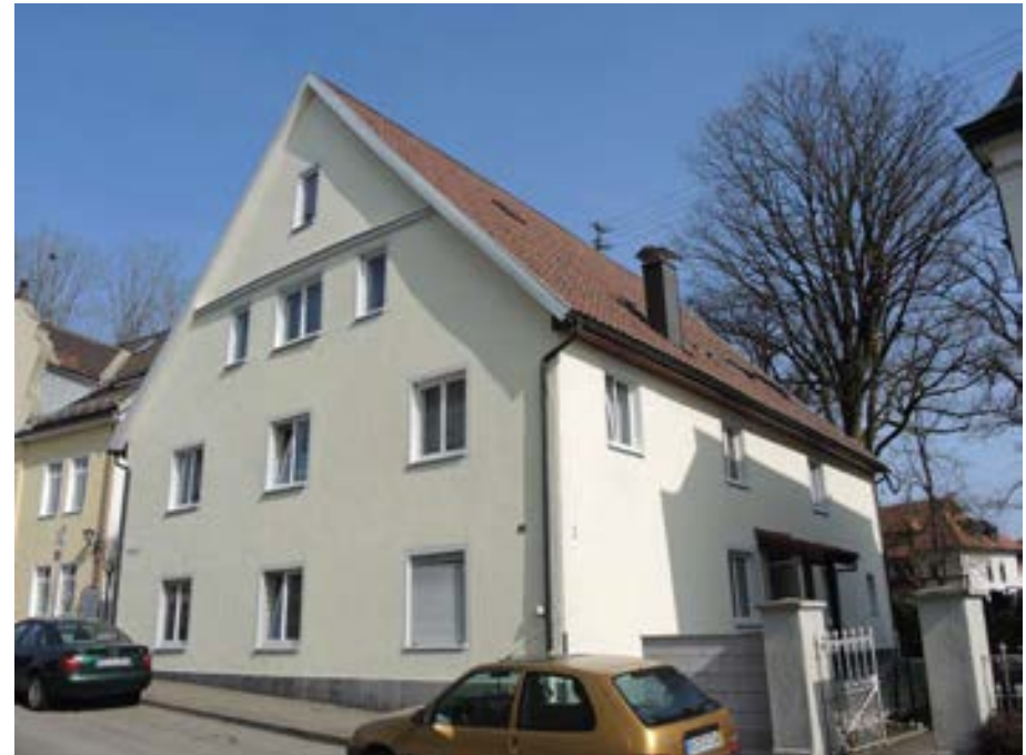
Ansicht des Gebäudes von Westen
