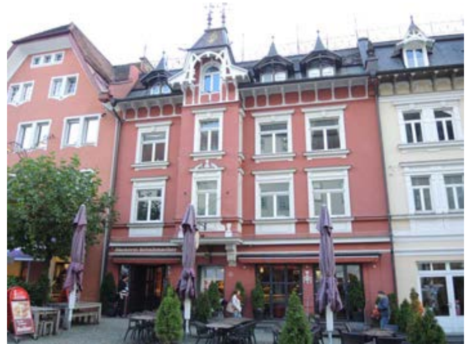
Ansicht des Gebäudes von Nordwesten
