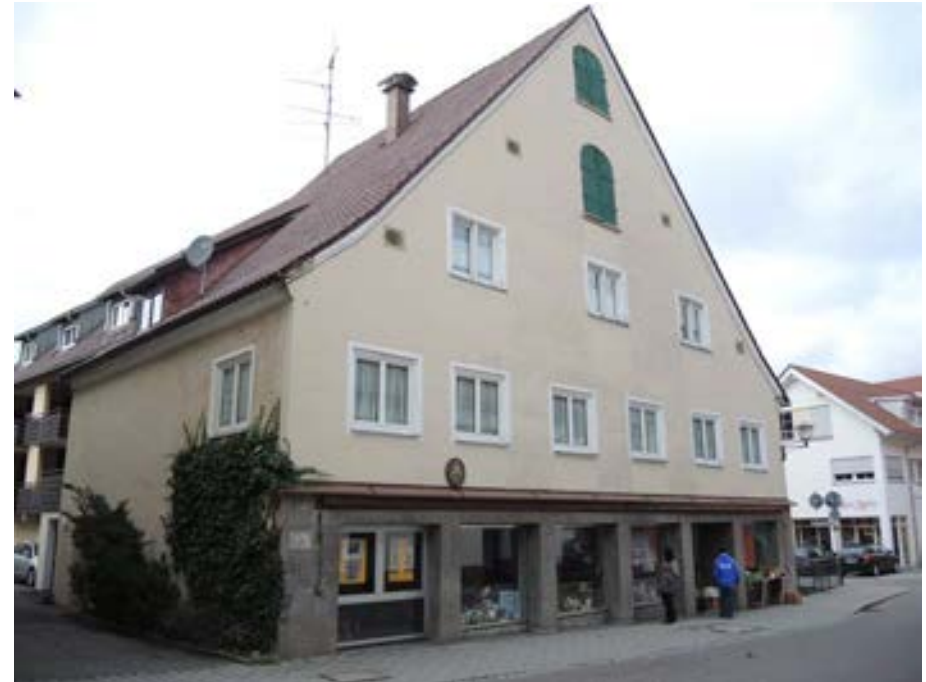
Ansicht des Gebäudes von Südosten
