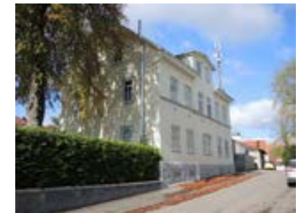
Ansicht von Südosten
