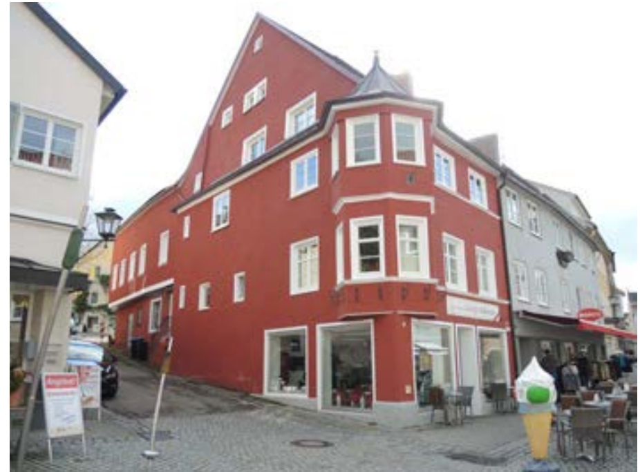
Ansicht des Gebäudes von Norden
