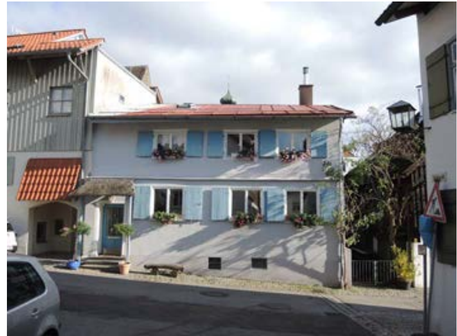
Ansicht des Gebäudes von Nordwesten
