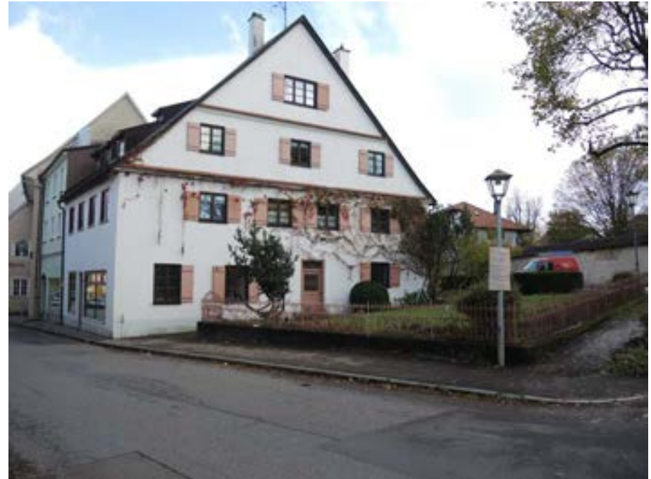
Ansicht des Gebäudes von Westen
