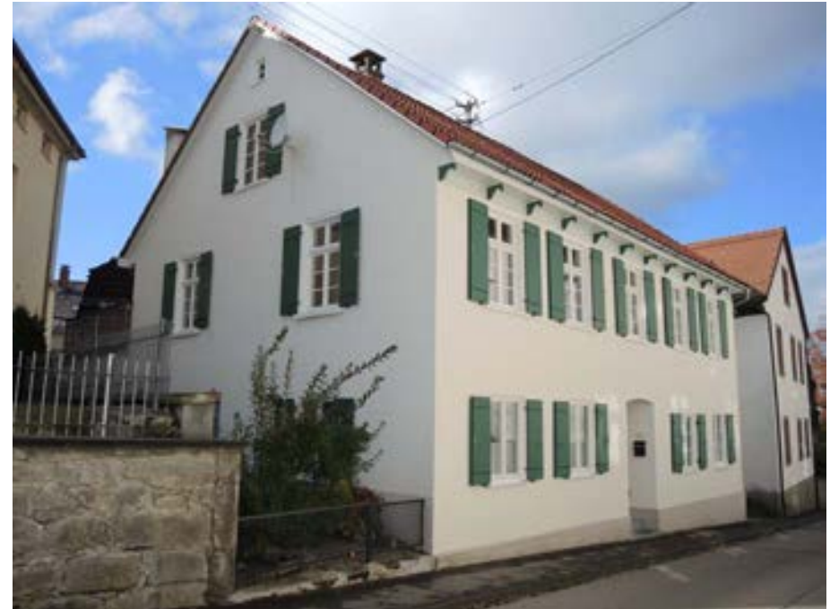
Ansicht des Gebäudes von Südosten
