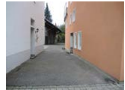
❷ Blick nach Nordwesten bei Nr. 11
