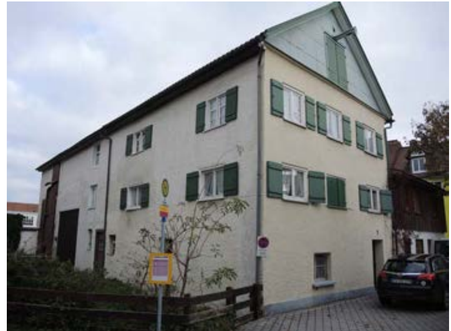
Ansicht des Gebäudes von Nordwesten
