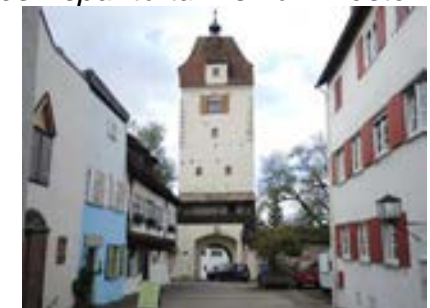
Ansicht von Südosten
