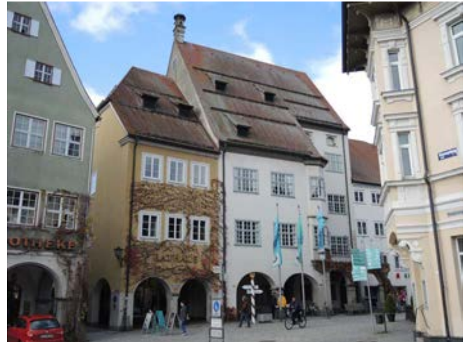
Ansicht des Rathauses von Südosten
