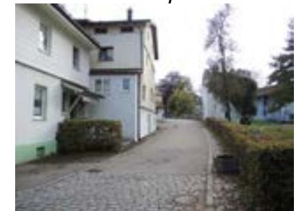
❷ Blick nach Süden bei Hausnr. 12
