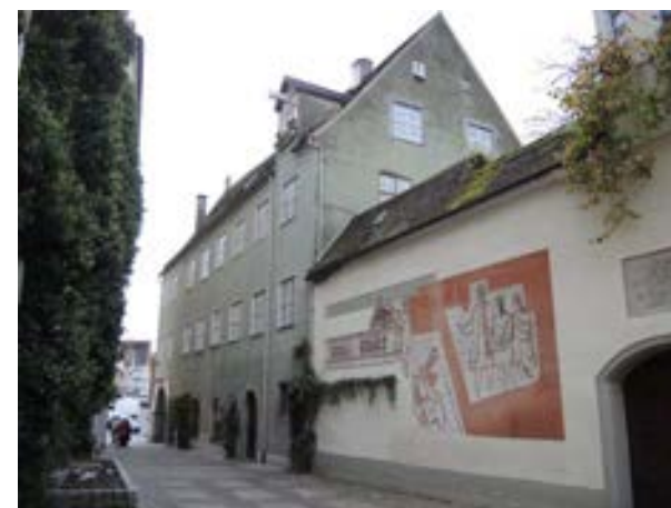
Ansicht der stattlichen Stadtapotheke am Beginn der Espantorstraße, 2014
