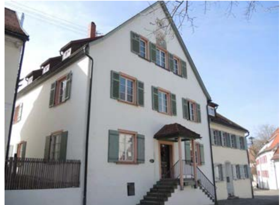
Ansicht des Gebäudes von Südosten
