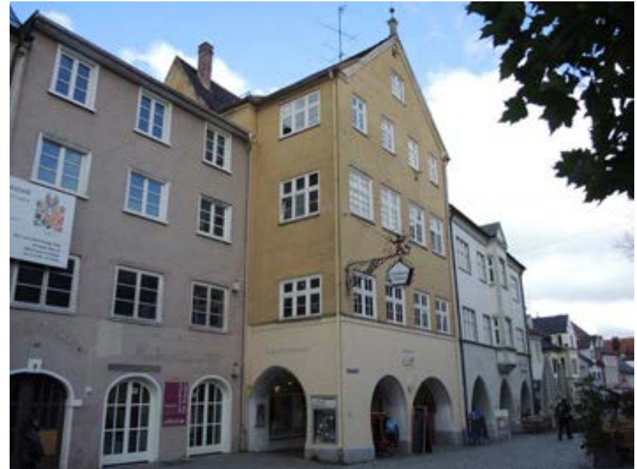
Ansicht des Gebäudes von Südosten
