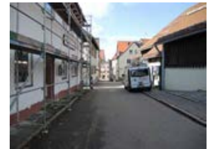
❷ Blick nach Nordwesten bei Nr. 12
