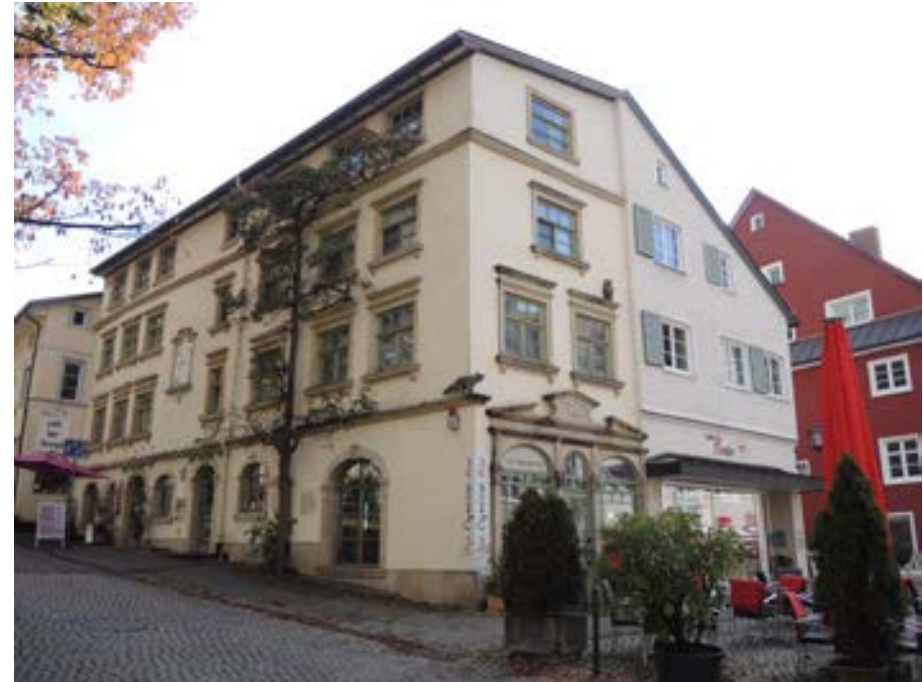
Ansicht des Gebäudes von Norden
