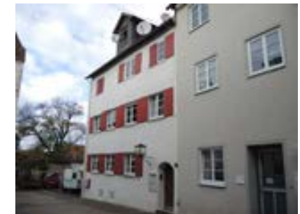
Ansicht von Südosten
