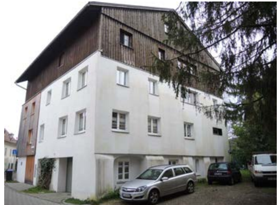
Ansicht des Gebäudes von Westen
