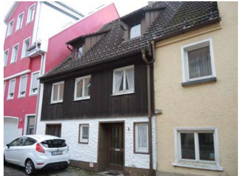
Ansicht des Gebäudes von Norden
