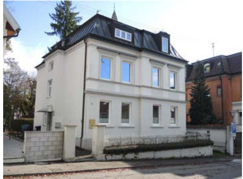
Ansicht des Gebäudes von Nordwesten
