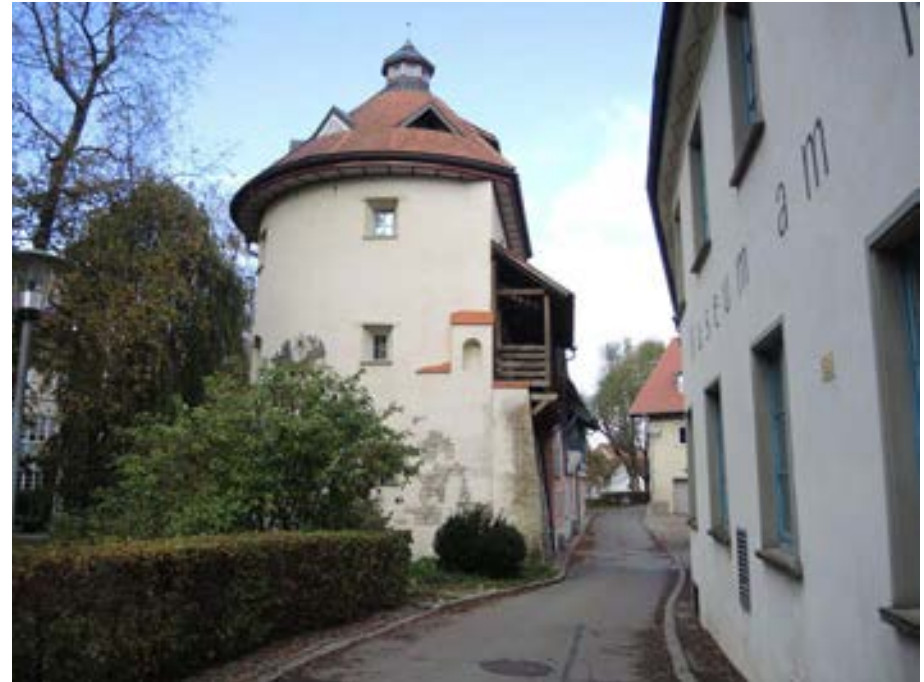
Ansicht des Mühlturms von Süden
