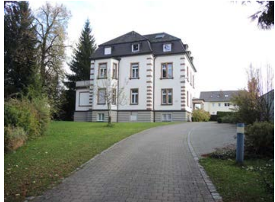
Ansicht des Gebäudes von Nordwesten
