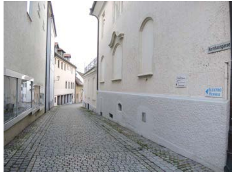
❶ Blick nach Nordwesten auf Höhe der Wassertorstraße
