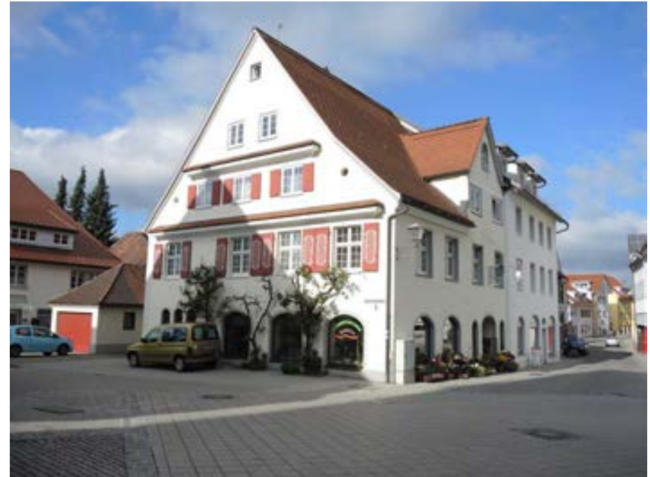
Ansicht des Gebäudes von Südosten
