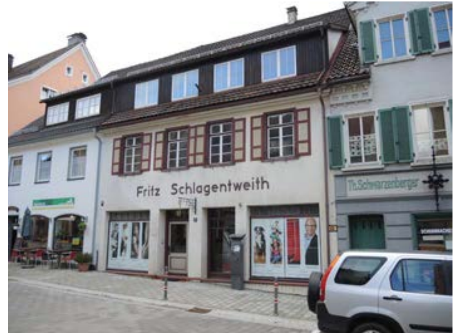
Ansicht des Gebäudes von Norden
