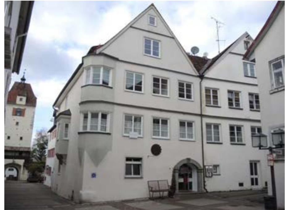
Ansicht des Gebäudes von Südosten
