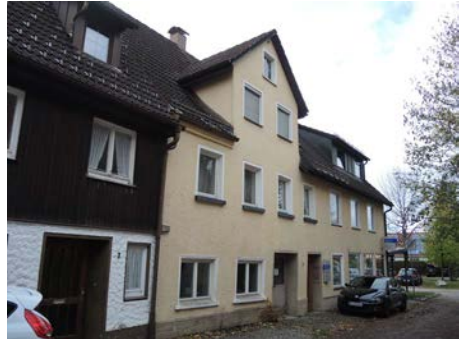
Ansicht des Gebäudes von Osten
