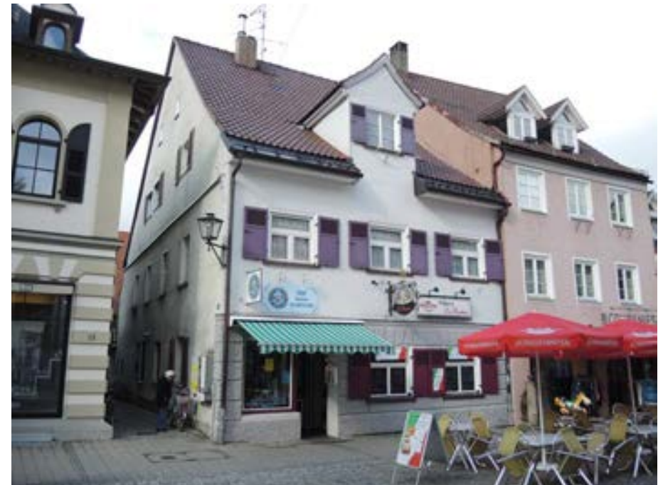
Ansicht des Gebäudes von Südosten
