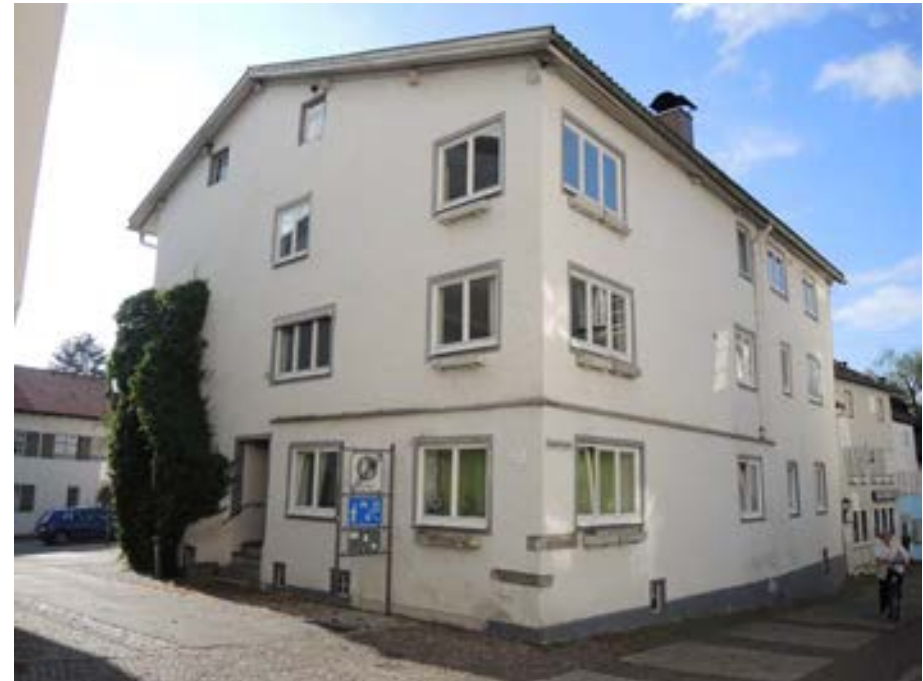
Ansicht des Gebäudes von Osten
