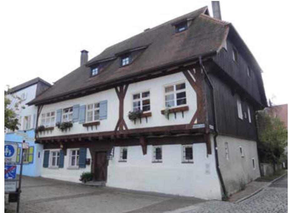
Ansicht des ehemaligen Pfarrhauses von Norden
