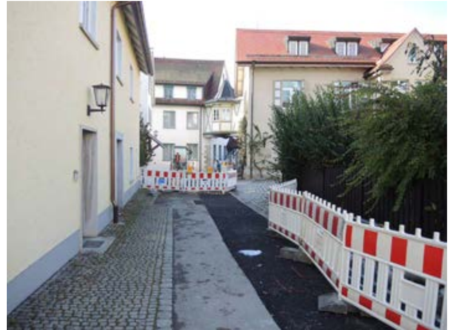
❶ Blick nach Westen auf Höhe von Hausnr. 17
