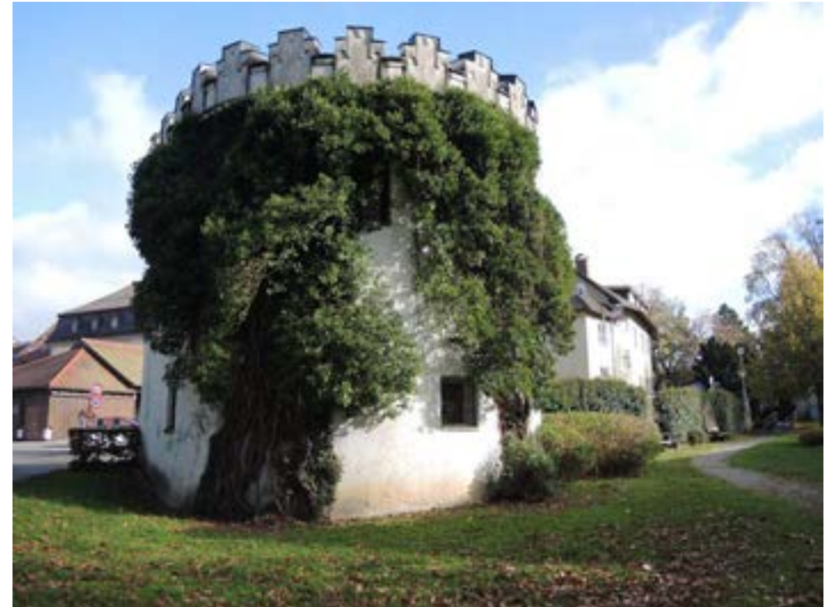
Ansicht des Hafendeckelturms von Nordwesten
