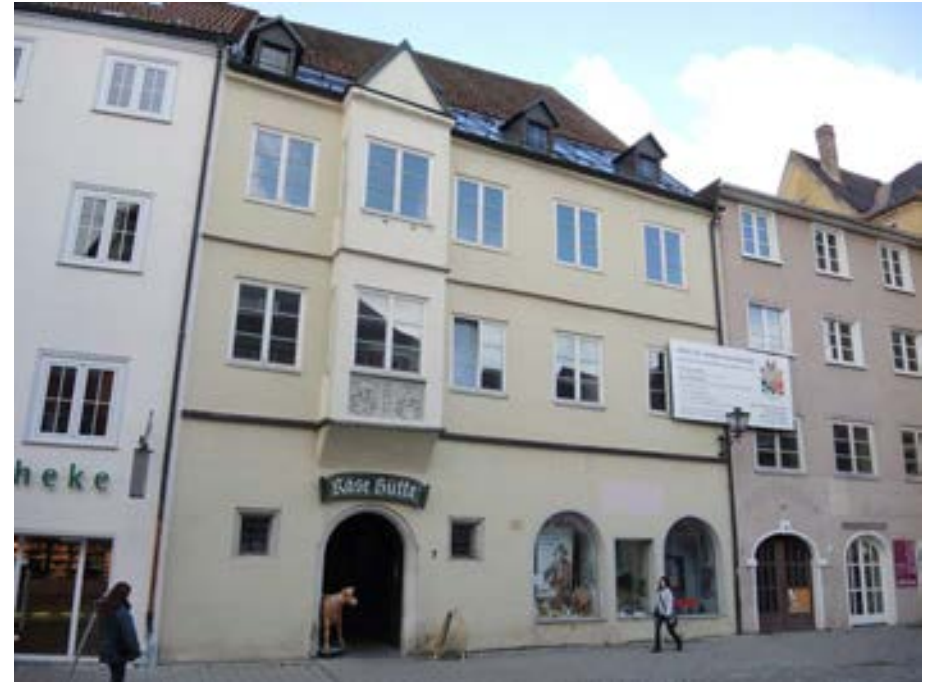
Ansicht des Gebäudes von Südosten
