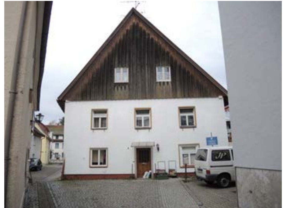
Ansicht des Gebäudes von Osten
