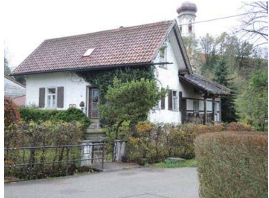
Ansicht des Gebäudes von Norden
