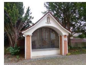
Ölbergkapelle, Ansicht von Westen
