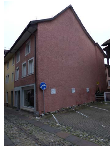
Ansicht von W
