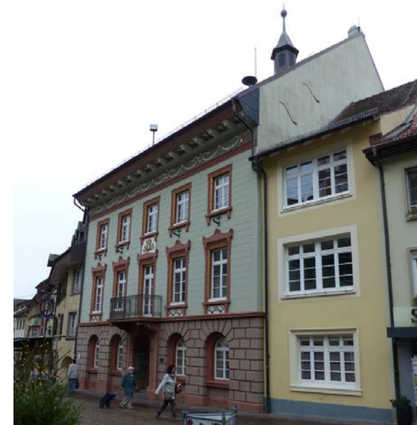
Ansicht von W
