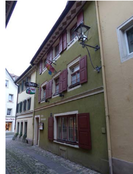
Ansicht von W
