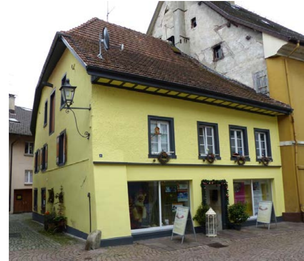
Ansicht von W
