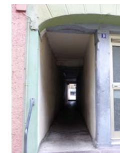
Durchgang zur Turmgasse, Ansicht von S
