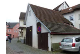
Lager Fahrgasse, Ansicht von N
