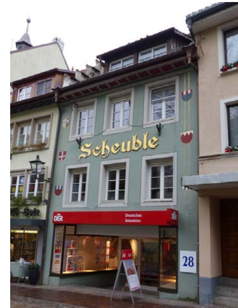
Ansicht von W
