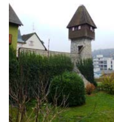
Storchenturm, Ansicht von NW
