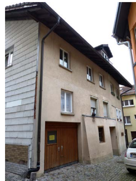
Ansicht von W
