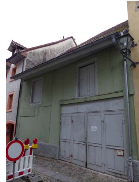
Ansicht von W
