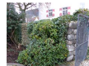
Ansicht von W
