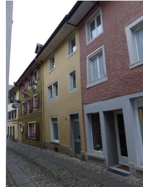
Ansicht von W
