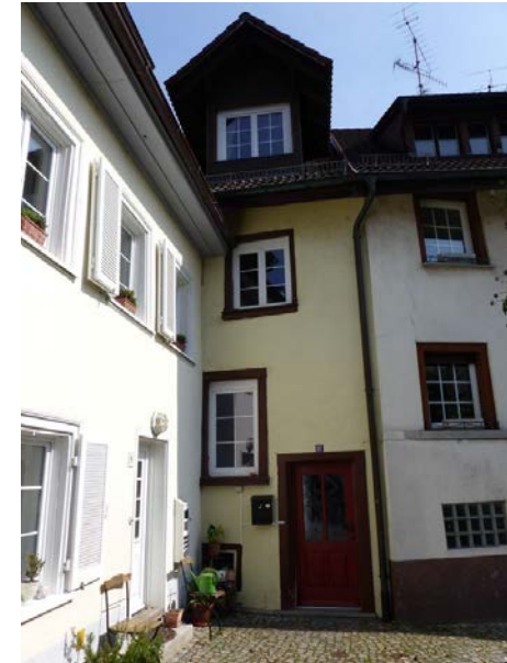
Ansicht von W
