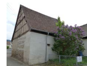
Rückgebäude, Ansicht von N
