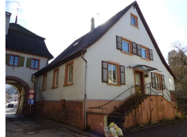
Ansicht von W
