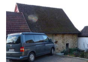
rückwärtige Scheune, Ansicht von NO
