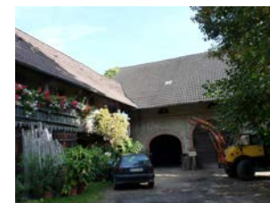
Innenhof, Ansicht von SW
