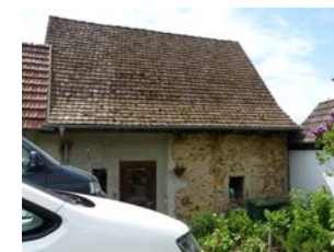
Rückgebäude, Ansicht von W
