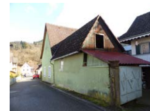
Scheunen, Ansicht von SW
