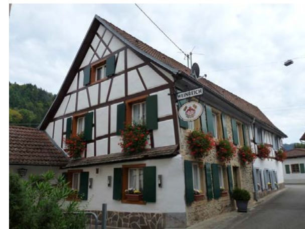
Ansicht von W
