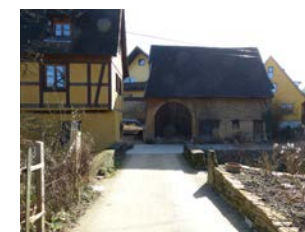
Bogenbrücke bei Hauptstraße 26a, Ansicht von NW
