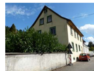
Ansicht von W
