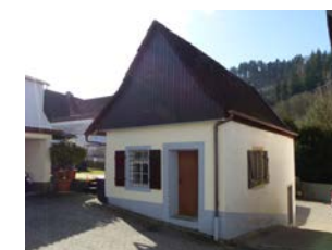
rückwärtiger Ökonomiebau, Ansicht von NO
