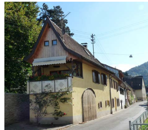
Ansicht von W
