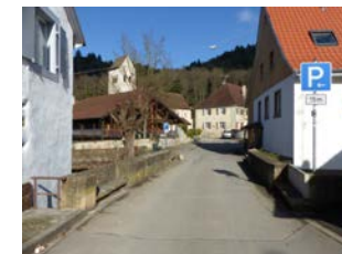
Bogenbrücke auf Höhe von Gustav-Weil-Straße 2, Ansicht von SW
