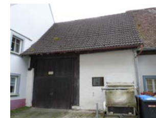
rückwärtige Scheune an der Gustav-Weil-Straße, Ansicht von NO
