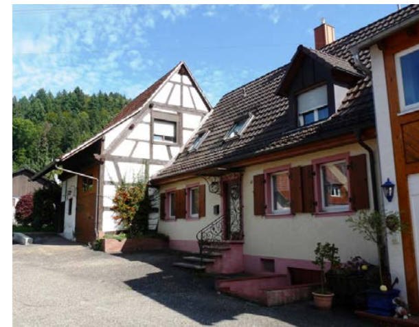
Ansicht von W
