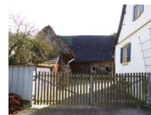
Hofeinfahrt mit Scheune, Ansicht von NW
