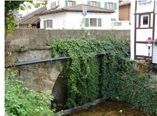
Brücke Klostergasse, Ansicht von NW
