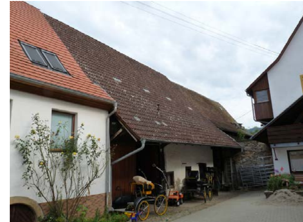
Ansicht von W
