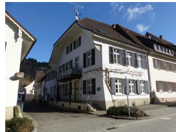
Ansicht von W
