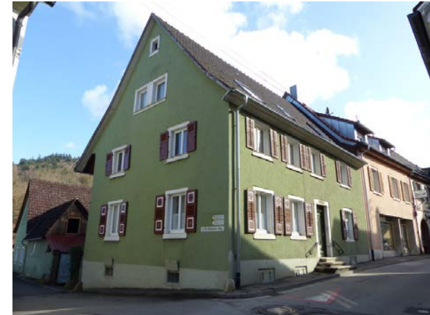
Ansicht von W
