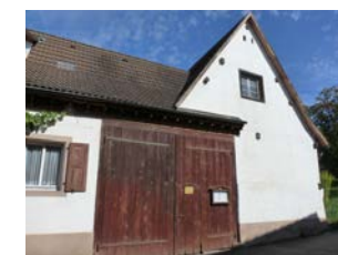
Ökonomieteil, Ansicht von SW
