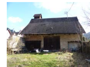
rückwärtige Scheune, Ansicht von W
