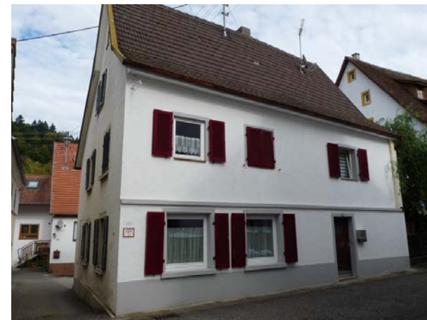
Ansicht von W
