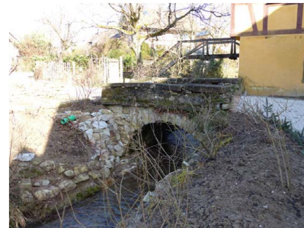
Bogenbrücke bei Hauptstraße 26a, Ansicht von S
