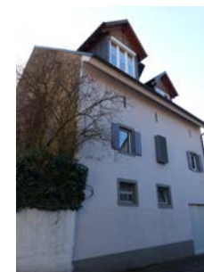
rückwärtige Scheune an der Gustav-Weil-Straße, Ansicht von NO
