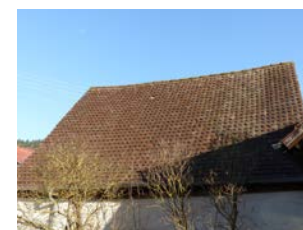
rückwärtige Scheune, Ansicht von W
