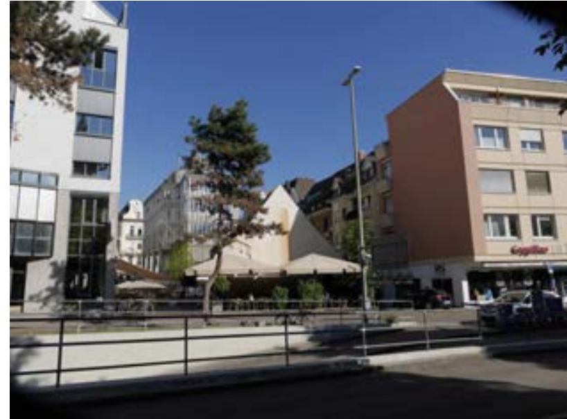
Ehem. Stechhäusle, sog. Mehlwaage (Bildmitte)
