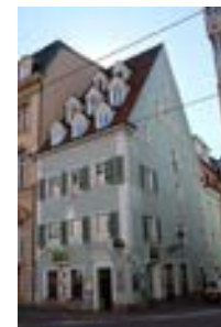
Ehem. Badhaus, Ecke K-J-Straße
