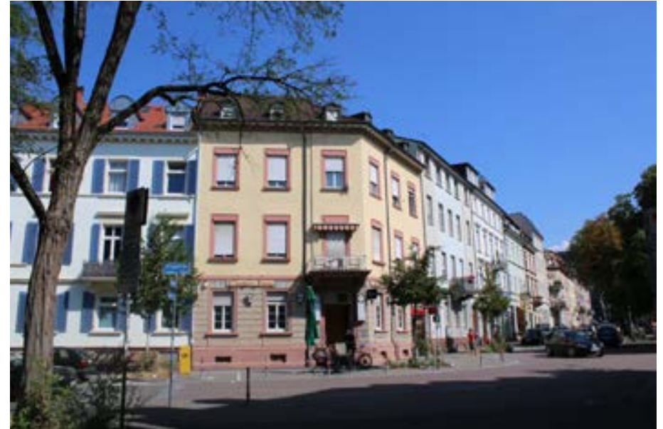
Kreuzungsbereich Wilhelm-, Belfort- und Moltkestraße
