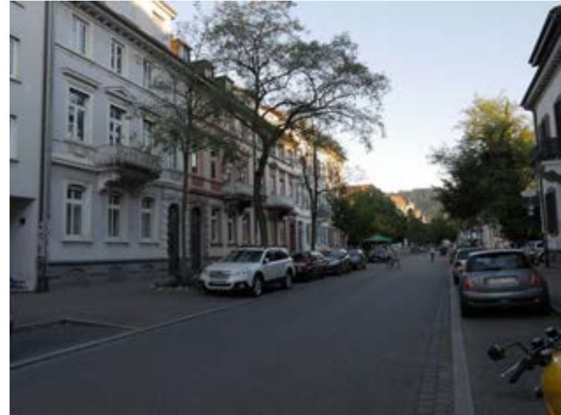
Typische gründerzeitliche Blockrandbebauung, Höhe Nr. 30-34
