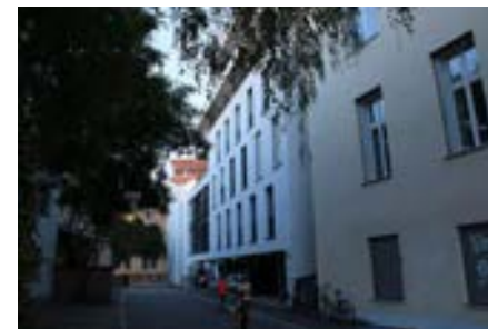
Abschnitt nördl. der Wilhelmstraße
