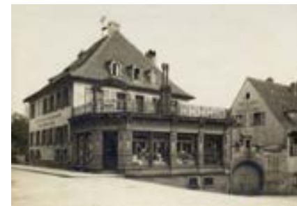
Ehem. Schwabentorring 5 (pr/RT)
