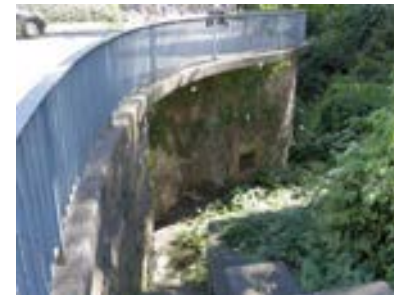
Turmstumpf des ma. Pulverturms
