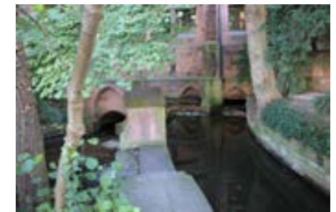
Wasserbauliche Anlage, Nr. 15
