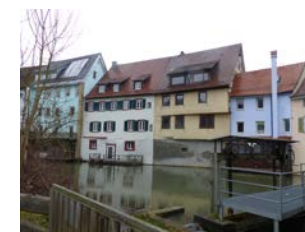
Mühlgässle 15 bis 19, Rückseiten
