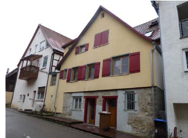
Alzheimer Straße 15, Rückseite, von der Grabenbachgasse
