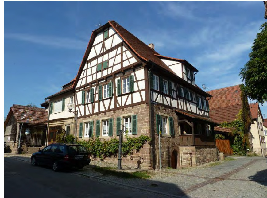
Ansicht von Südosten auf das Wohngebäude mit gegenüberstehender Scheune Richtung Norden
