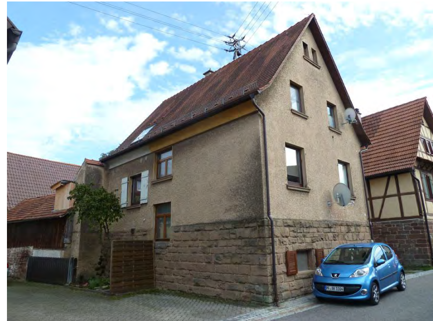
Nordwestansicht des Wohnhauses mit Anbau
