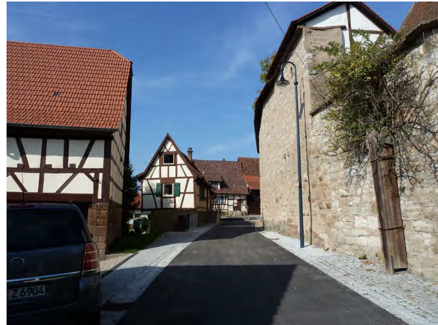
Blick nach Westen auf Höhe von Hausnummer 5, entlang der rechts verlaufenden Wehrmauer
