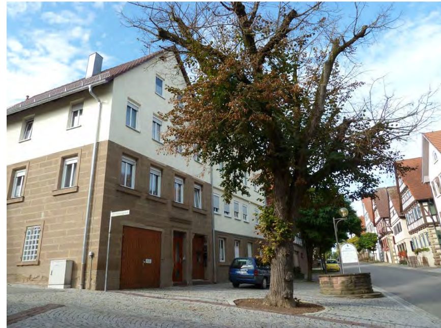
Nordostansicht des Wohnhauses
