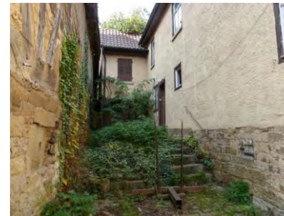
Südansicht des rückwärtigen Anbaus
