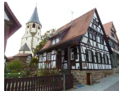
Nordostansicht des Wohnhauses
