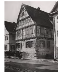
Südostansicht des Gebäudes von 1925
