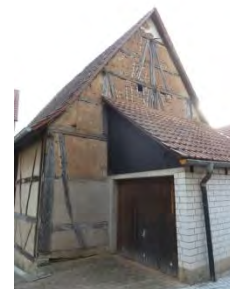
Ansicht des Gebäudes von Norden
