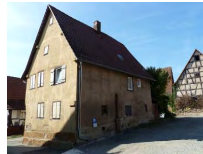
Nordostansicht des Wohnhauses
