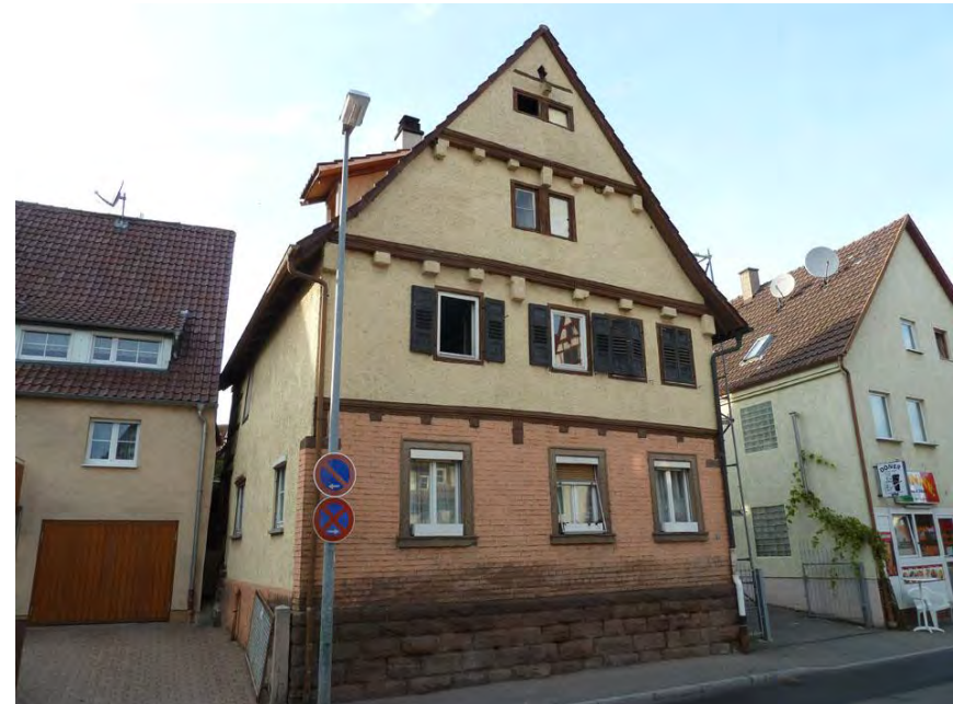
Südostansicht des Gebäudes
