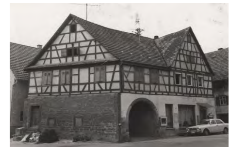
Nordostansicht des Gebäudes von 1974
