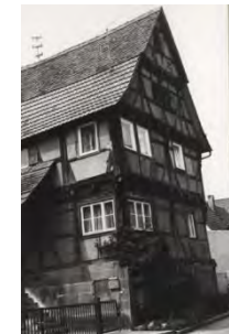
Südostansicht des Wohnhauses von 1974
