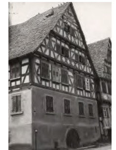
Nordostansicht des Wohnhauses von 1973
