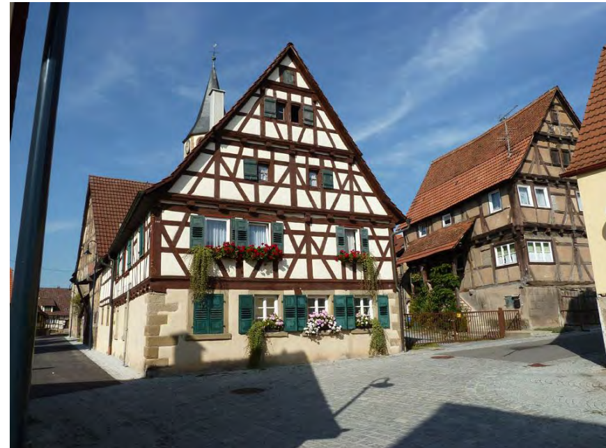
Südostansicht der Hofanlage
