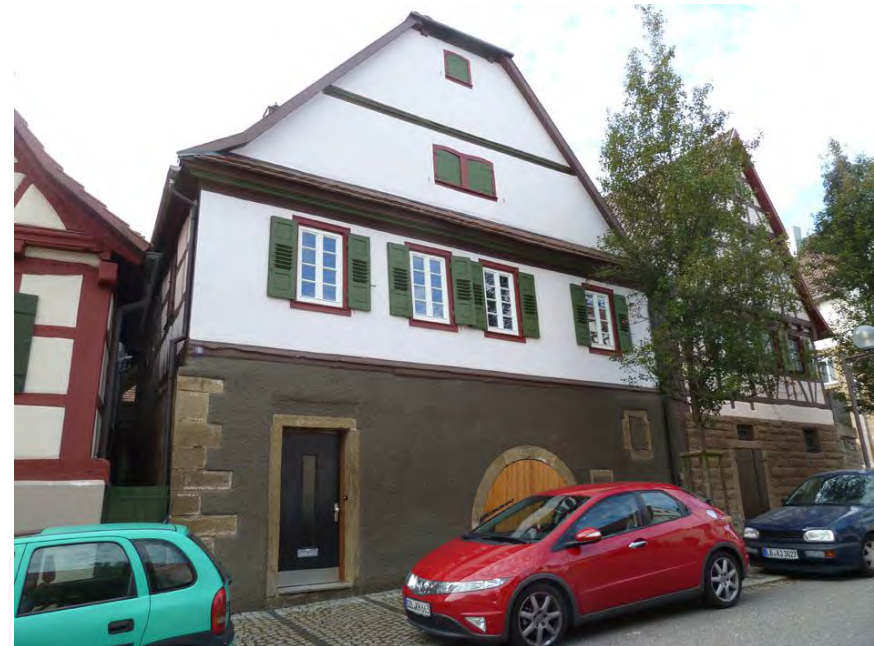
Nordostansicht des Wohnhauses
