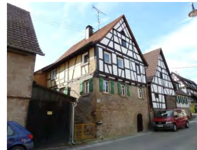
Nordostansicht des Wohngebäudes mit westlich angrenzender Scheune
