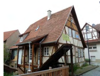
Südostansicht mit Treppenabgang in den ehemaligen Wassergraben
