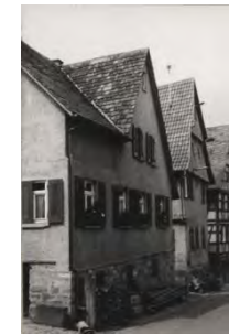
Südostansicht des Gebäudes von 1973
