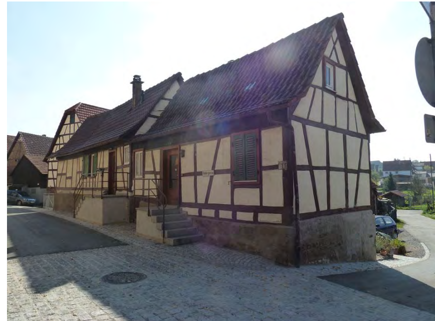
Ansicht der Gebäude von Nordwesten
