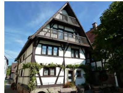
Südwestansicht des rückwärtigen Gebäudeteils
