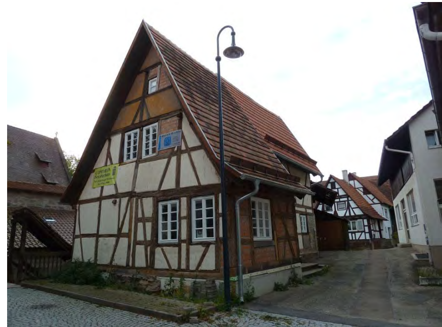
Nordostansicht des Wohnhauses
