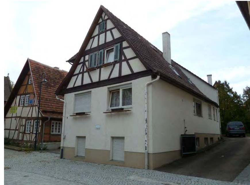
Nordostansicht des Wohnhauses
