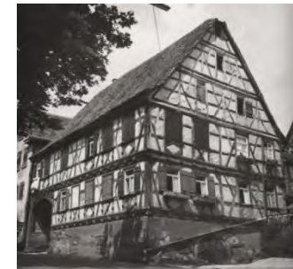
Südostansicht des Wohnhauses von 1964
