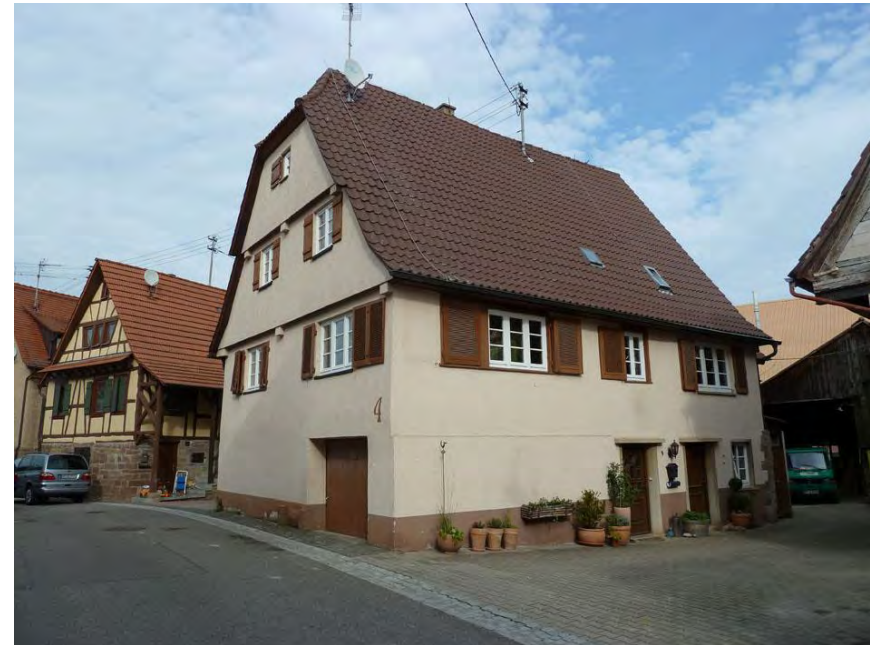
Südwestansicht des Wohnhauses mit Blick in den Hof zur rückwärtigen Scheune
