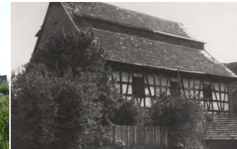
Südwestansicht der Scheune von 1973
