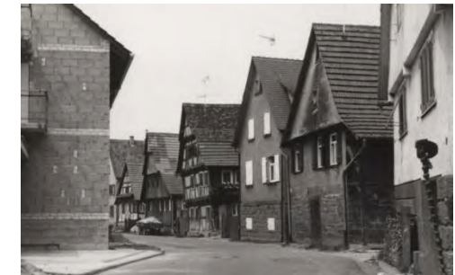
Blick nach Norden auf Höhe Hausnummer 4, 1974
