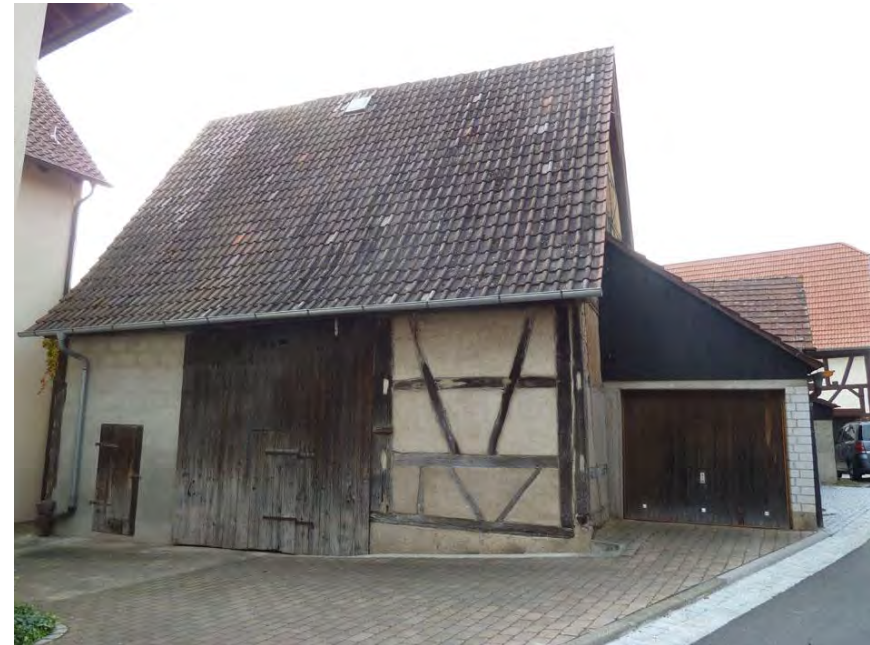
Ansicht des Gebäudes von Osten
