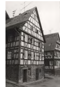
Südostansicht des Wohnhauses von 1974
