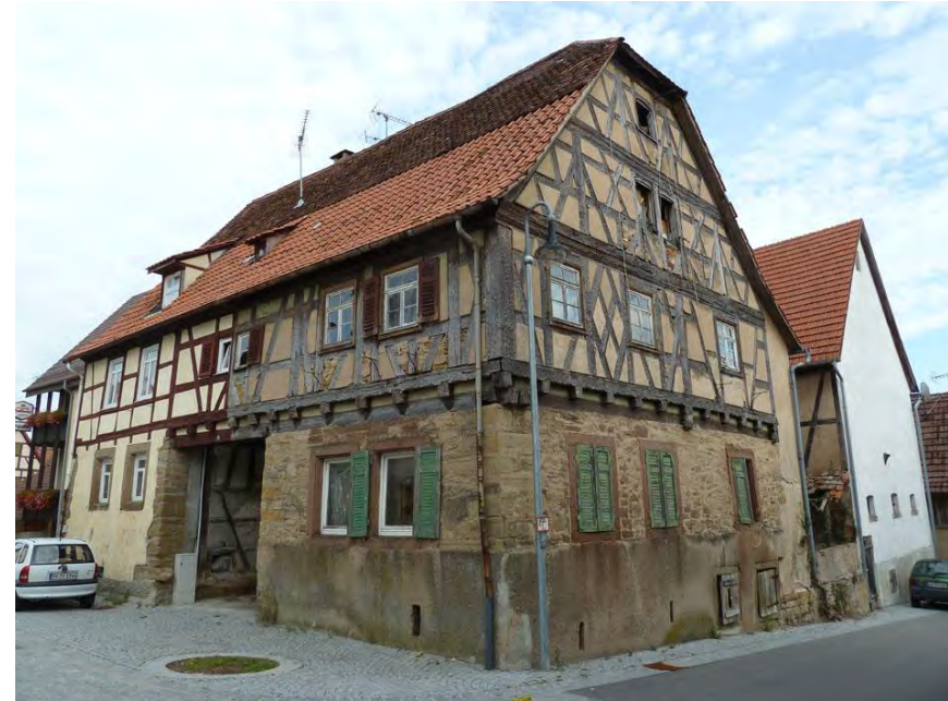
Südwestansicht des teilrenovierten Wohnhauses
