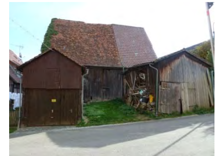
Westansicht der Scheune mit vorgelagerten Schuppen
