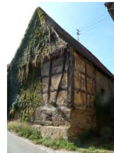
Scheune von Nordosten mit erhaltenem Steinschiebefenster an der Nordseite
