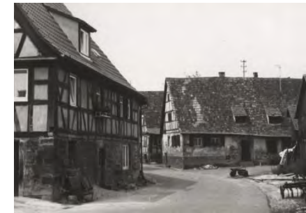
Südwestansicht des Gebäudes im Hintergrund von 1973
