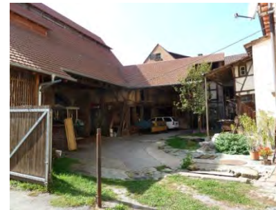
Nordostansicht in den Hof mit Scheunentrakt
