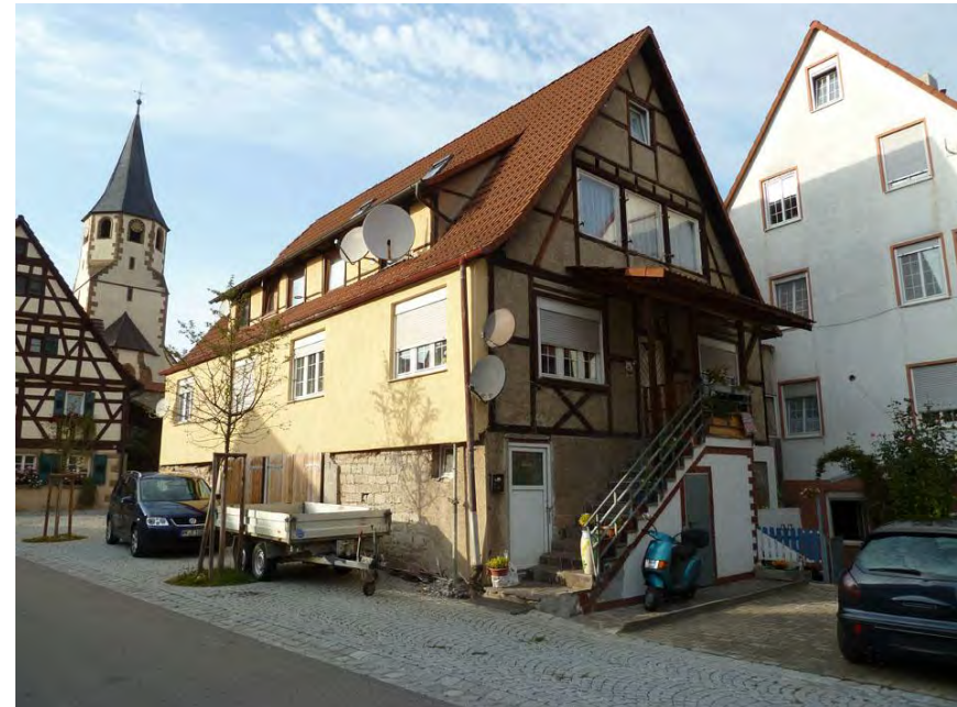
Südostansicht des Gebäudes
