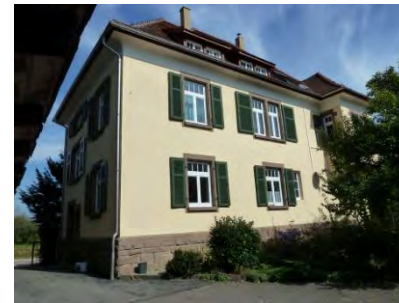
Südostansicht des Forsthauses
