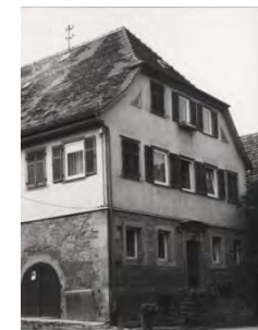
Südostansicht des Gebäudes von 1973
