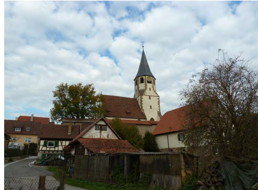
Südansicht der Wehrkirche von der Spindelgasse Ecke Bachweg aus
