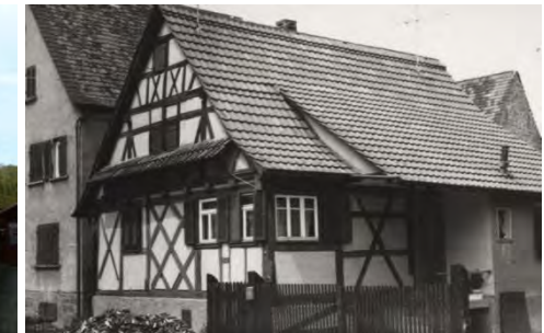
Südwestansicht des Hauptgebäudes von 1974
