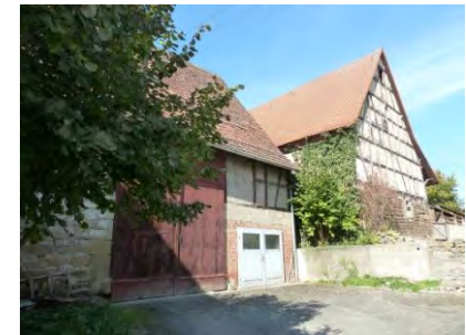
Ostansicht der Scheune
