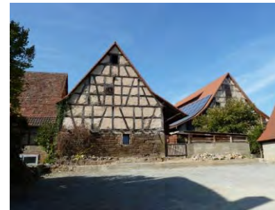
Ostansicht der weit zurückliegenden Scheune
