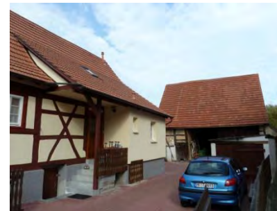
Westansicht der rückwärtigen Scheune
