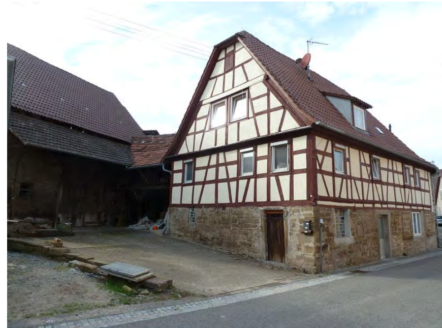
Südostansicht des Wohnhauses mit rückwärtiger Scheune
