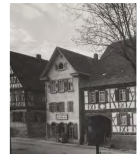
Südostansicht des Wohnhauses von 1925
