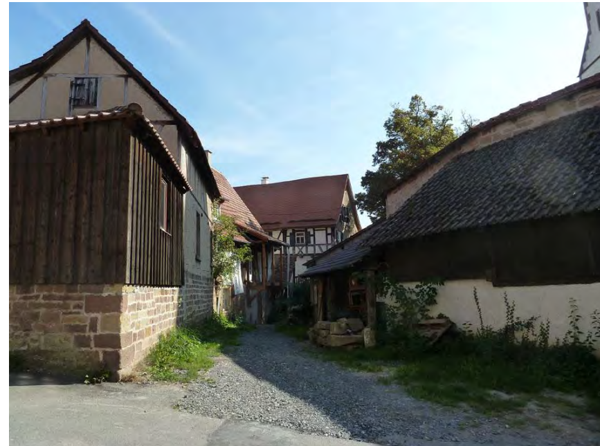
Blick Richtung Osten zum Schulhaus in der Kirchenburggasse auf Höhe Spindelgasse Nr.8
