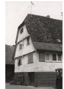
Westansicht des Bauernhauses von 1974
