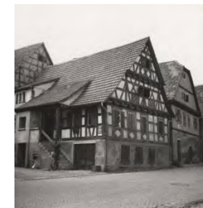
Nordostansicht des Wohnhauses von 1964
