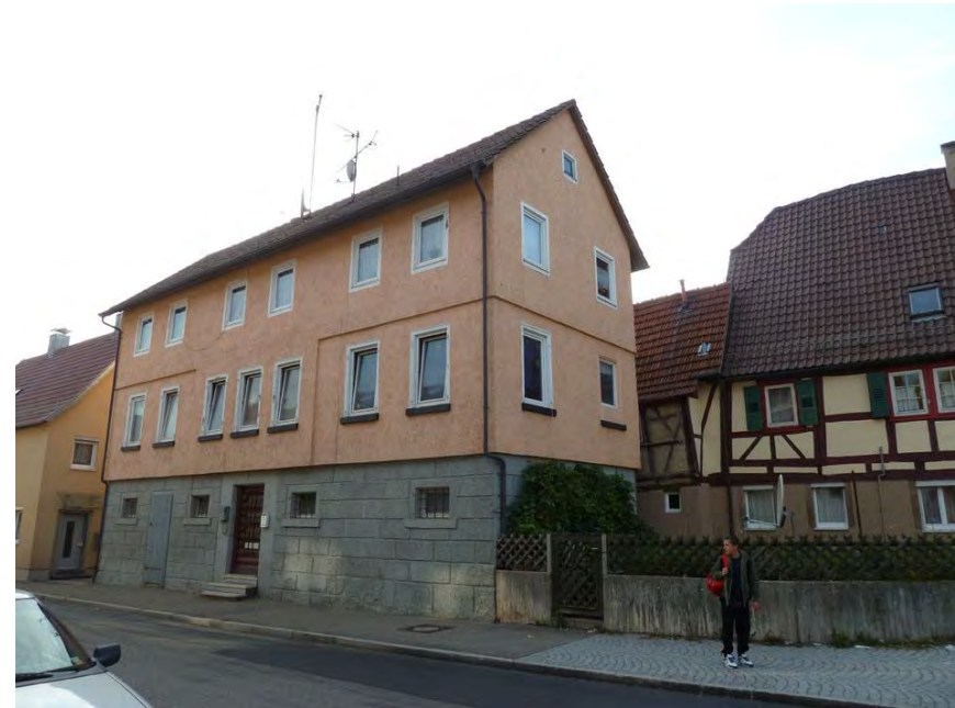
Ansicht des Wohnhauses von Nordosten
