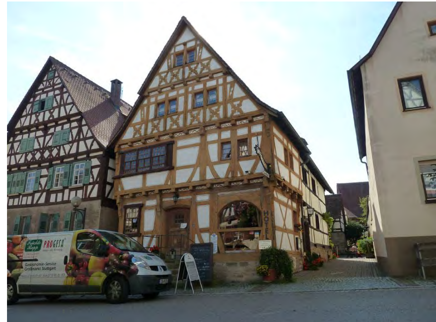
Nordwestansicht des Gasthauses, im Hintergrund rückwärtig gelegene Scheune
