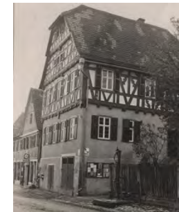
Nordostansicht des Rathauses von 1925
