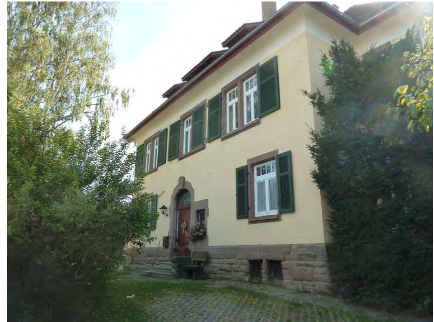
Nordansicht des Forsthauses
