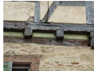
Detail – grün gefasste Gefache teilweise erhalten, gekerbte Schwellen sichtbar
