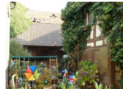
Westansicht der rückwärtigen Scheune
