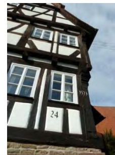
Detail – geschnitzte Knaggen und Inschrift am nordöstlichen Eckständer
