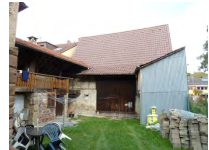
Südwestansicht Scheune mit Verbindungsbau
