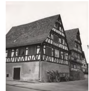
Südostansicht des Wohnhauses von 1964
