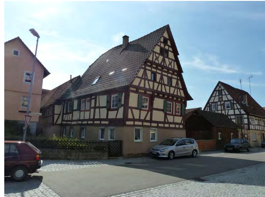
Nordostansicht des Wohnhauses mit rückseitigem Anbau
