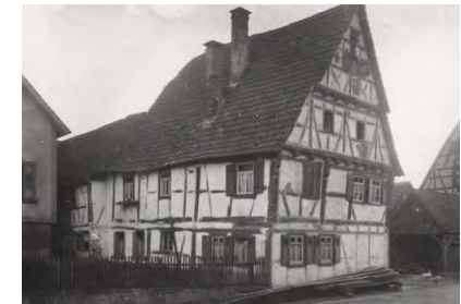
Nordostansicht des Wohnhauses von 1925
