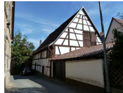
Südwestansicht des Wohnhauses von der Spindelgasse aus
