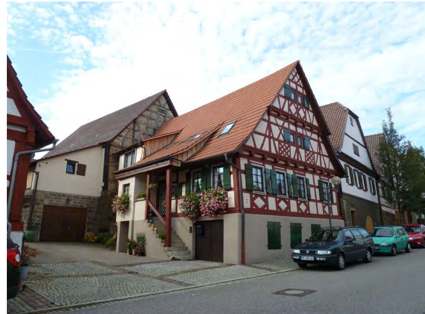
Nordostansicht des Wohnhauses
