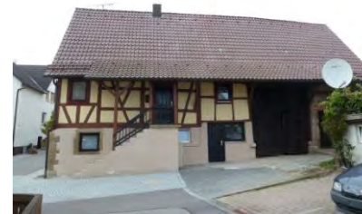
Ostansicht des Wohnhauses mit Scheunentrakt
