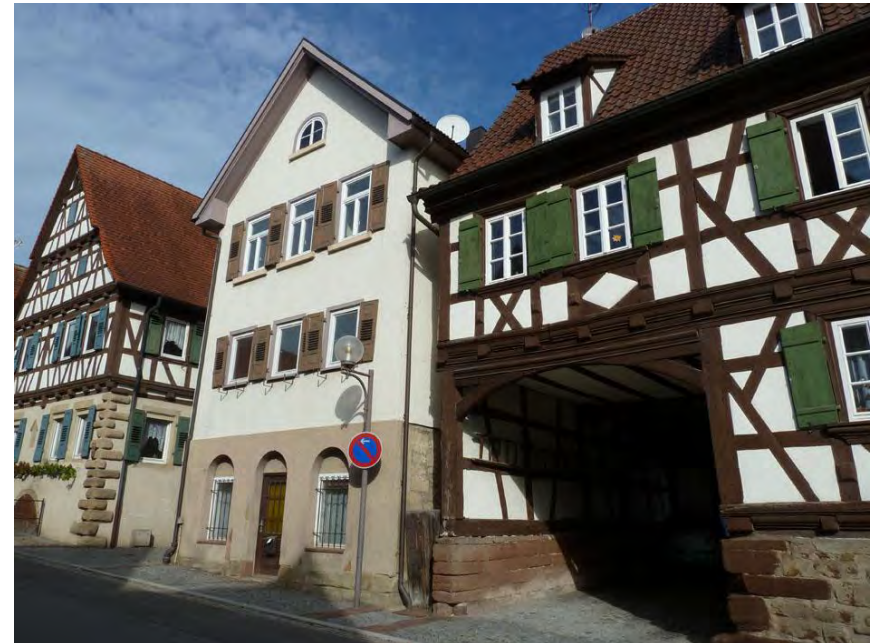
Südostansicht des Gebäudes
