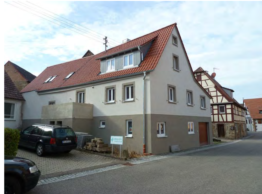
Südostansicht des Gebäudes
