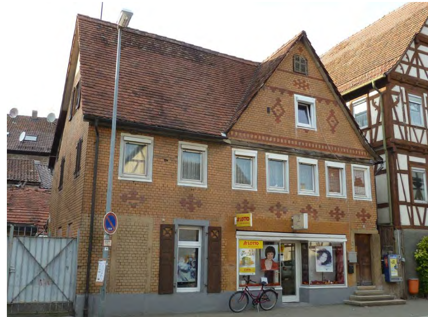
Ansicht des Wohnhauses von Osten
