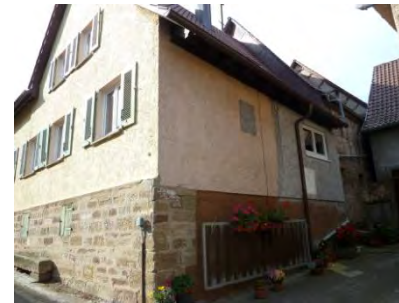
Nordostansicht des Wohnhauses mit Anbau
