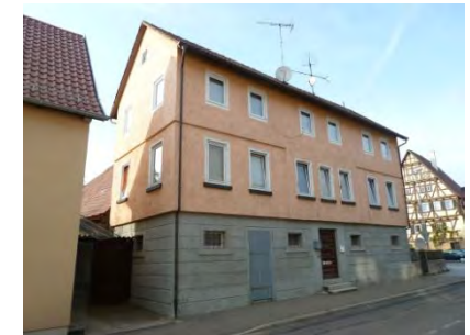
Südostansicht des Gebäudes
