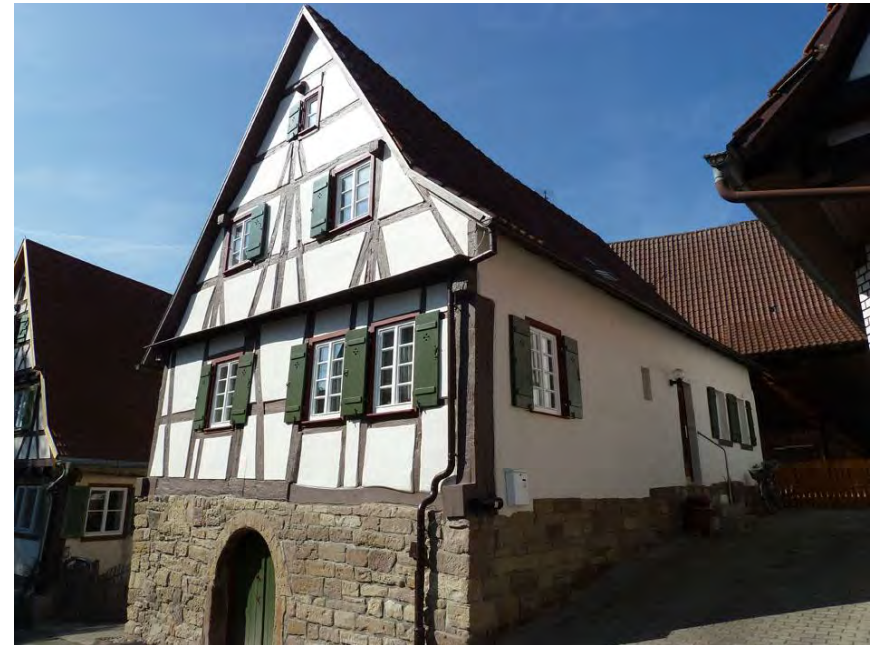
Nordostansicht des Wohnhauses
