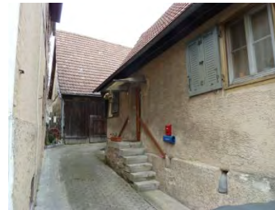
Südwestansicht des Wohnhauses mit rückwärtig gelegener Scheune
