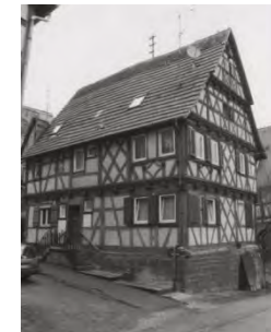
Südostansicht des Wohnhauses von 1974
