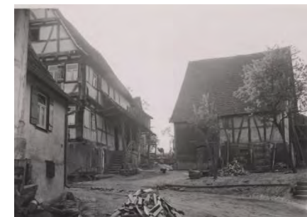
Südostansicht des Wohnhauses mit Scheune von 1938
