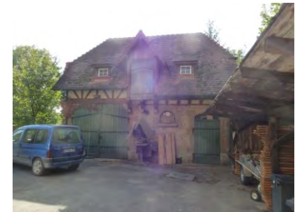
Nordansicht der rückwärtigen Remise
