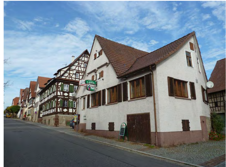
Südostansicht des Gebäudes mit jüngeren Veränderungen
