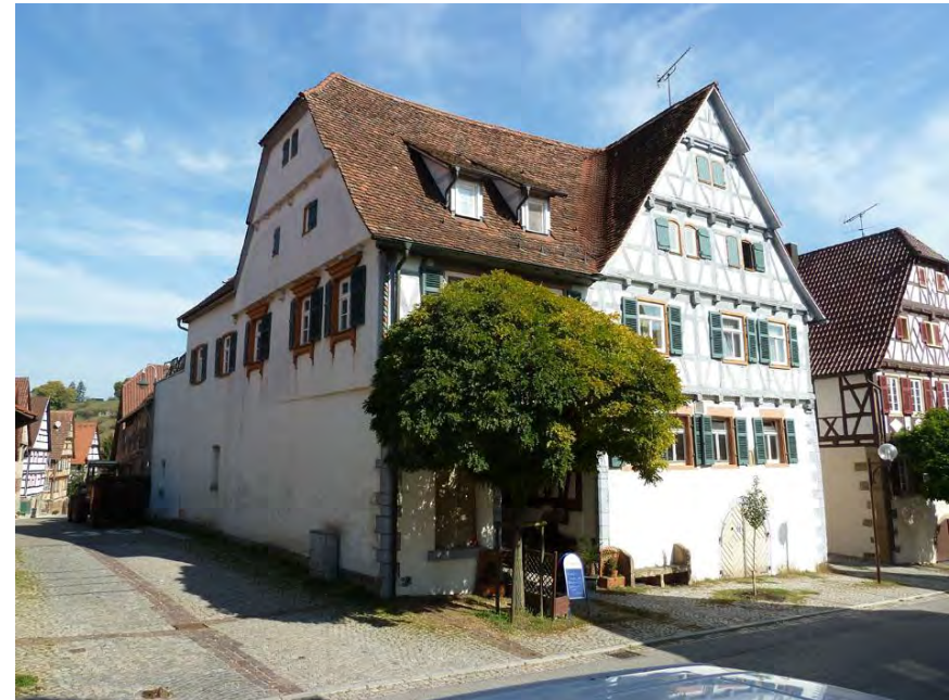
Ansicht des Gasthauses von Südwesten mit Blick in die Herzenbühlstraße
