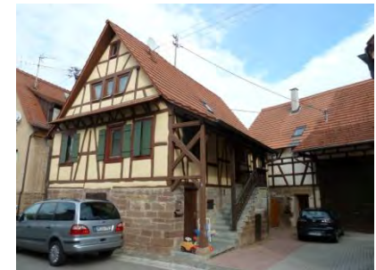
Südwestansicht mit Blick auf die Scheune
