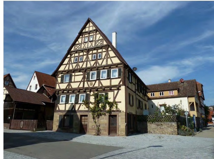
Südostansicht der Hofanlage mit Schopf und Holzlege nach Westen
