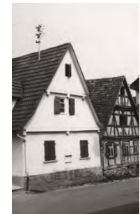
Südansicht des Wohnhauses von 1973
