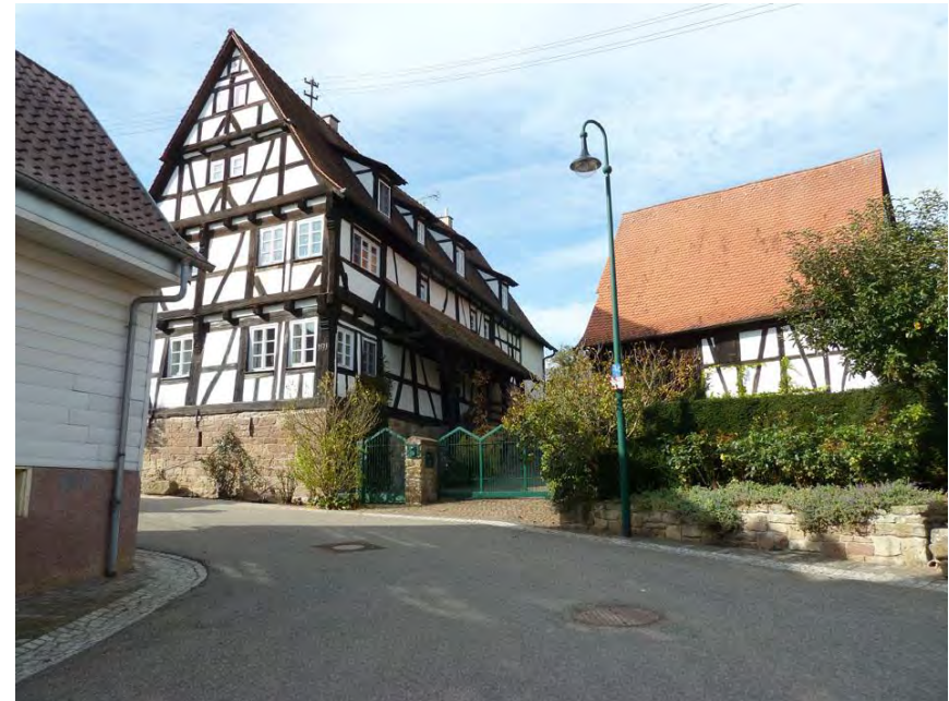
Südostansicht der Hofanlage
