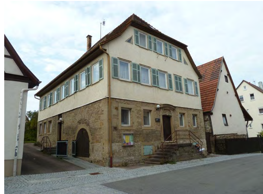
Südostansicht des Pfarrhauses
