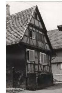
Südostansicht des Wohnhauses von 1974
