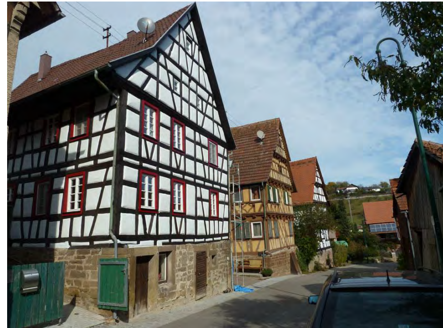
Südostansicht des Wohngebäudes
