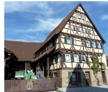
Südwestansicht der Hofanlage
