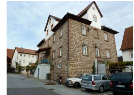
Südwestansicht des ehemaligen Schulhauses
