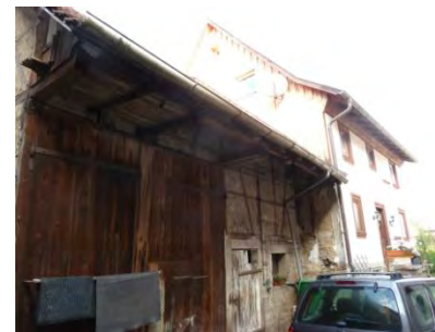
Südlich des Wohnhauses angebaute Scheune
