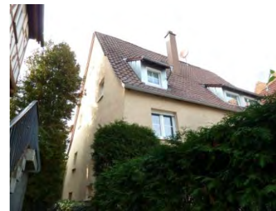
Südostansicht des Gebäudes
