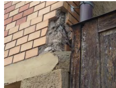
Mit Klinkern verblendete Fachwerkkonstruktion
