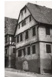
Südostansicht des Hauptgebäudes von 1973
