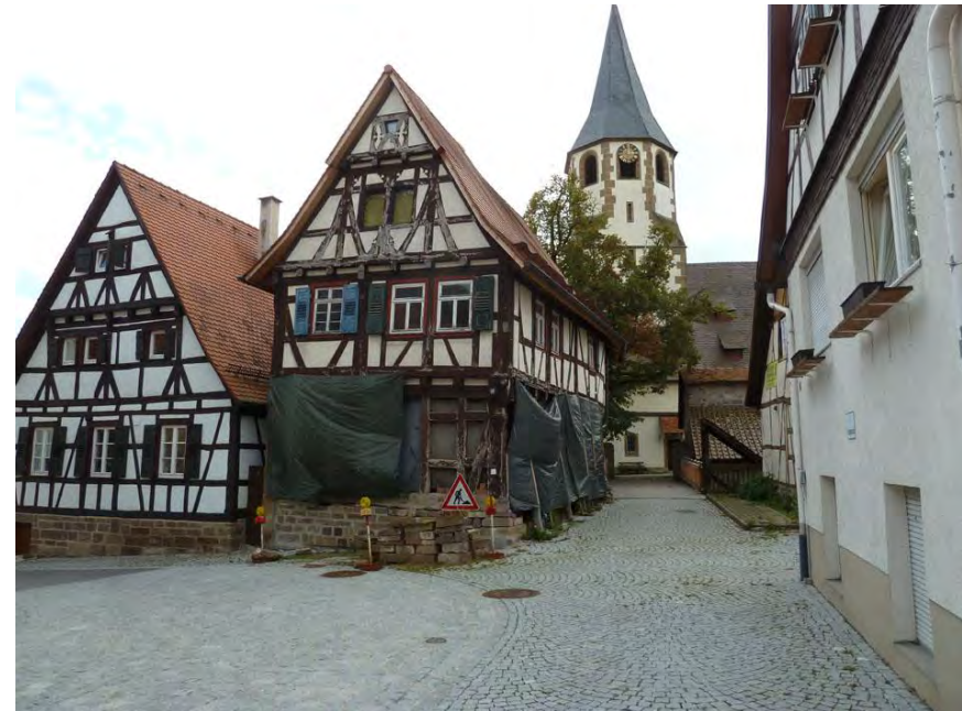
Nordwestansicht des Gebäudes mit Blick über die Brücke in die Kirchenburg
