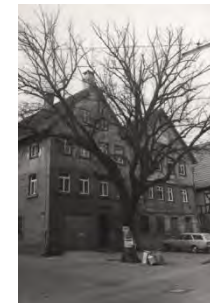
Nordostansicht des Gebäudes von 1974
