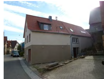
Nordansicht des Gebäudes
