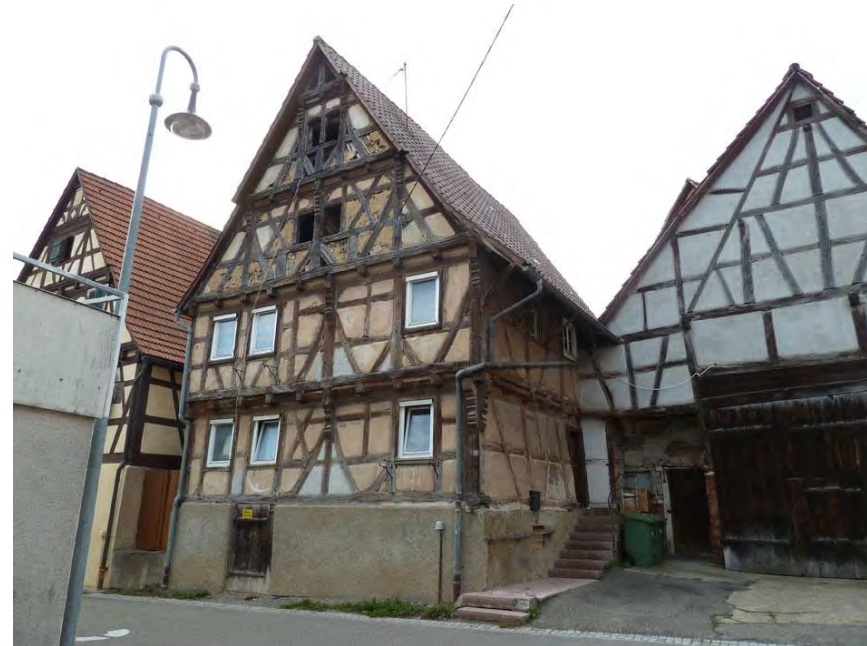
Nordostansicht des Wohnhauses mit nördlich anschließendem Scheunentrakt
