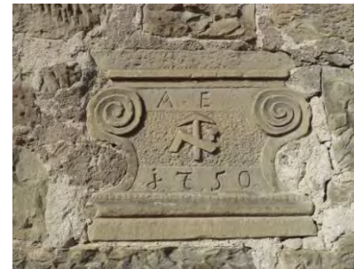
Detail – Spolie: eingemauerter Ofenstein im Sockelbereich des straßenseitigen Giebels
