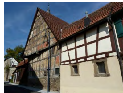
Südansicht der Scheune mit eingefügtem Nebengebäude
