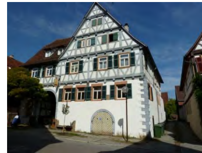
Ansicht des Gasthauses von Südosten mit Blick ins Feuergässle
