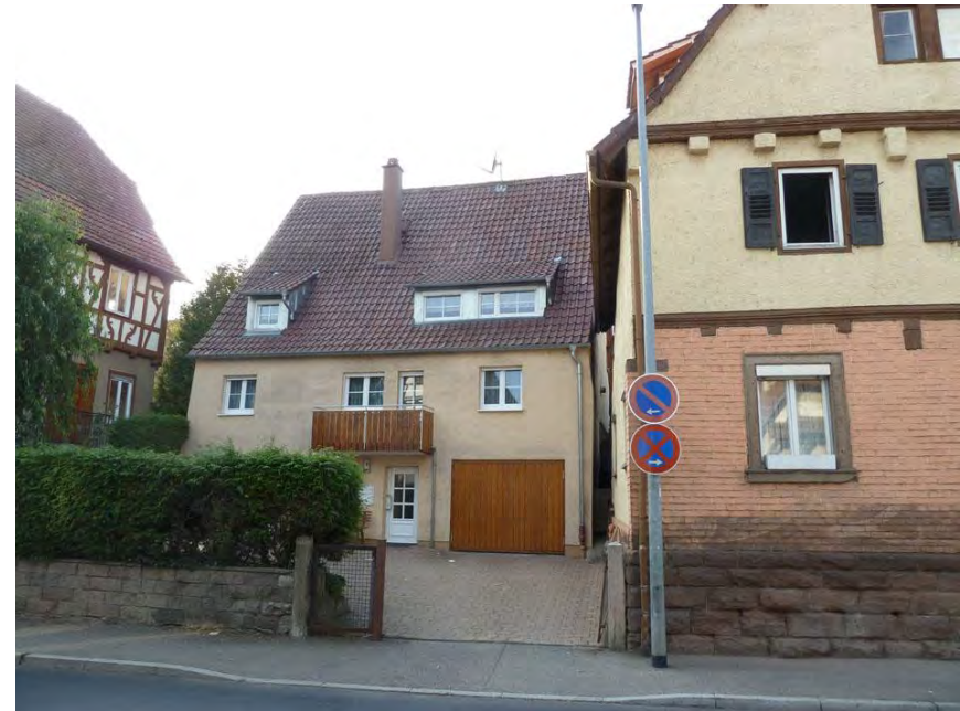
Ansicht des Wohnhauses von Osten
