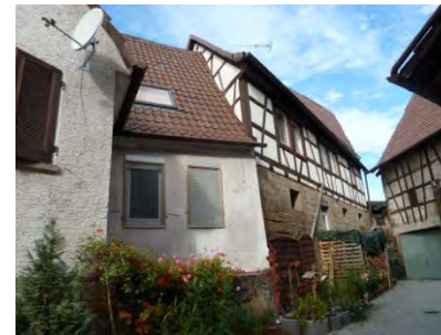
Blick in den Hof auf die Ostseite des Gebäudes mit Hinterhaus und Zwischenbau
