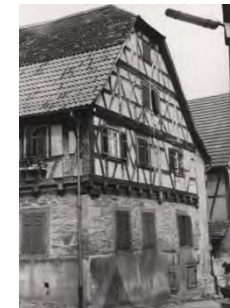
Südwestansicht des Gebäudes von 1973
