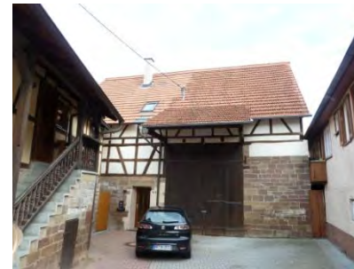
Westansicht der rückwärtigen Scheune
