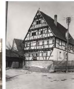
Südostansicht des Wohnhauses von 1925
