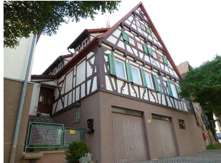
Nordostansicht des Wohnhauses
