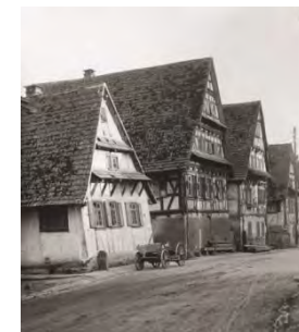
Westansicht des Haupthauses im Bild ganz vorne von 1925
