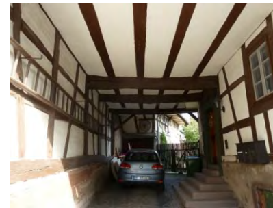
Durchfahrt mit Blick zur rückwärtigen Scheune
