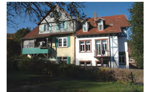
Rückfassaden gg. den Pfarrgarten
