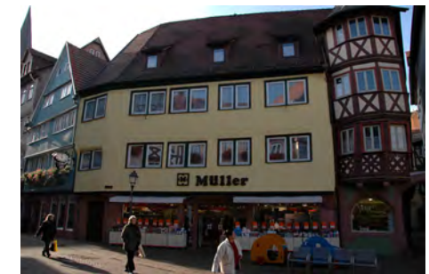
Marktplatz 14, erhaltenswerter Gebäudeteil
