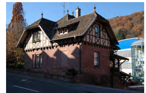
Ehem. Wohnhaus, Uihlein-Straße 2
