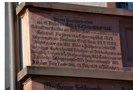
Bauinschrift von 1912, Hauptfassade
