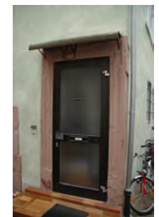
Geohrtes Sandsteinportal, hofseitig
