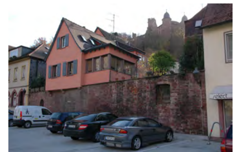
Rückwärtiger Anbau des 20. Jh.
