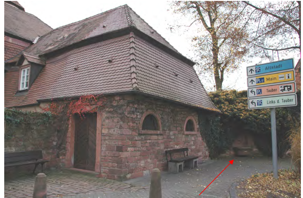
Erhaltenswertes Nebengebäude, anschließend der Laufbrunnen
