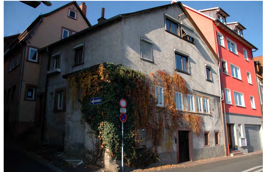
Erhaltenswertes Wohnhaus mit Stadtmauerrest (Kulturdenkmal)
