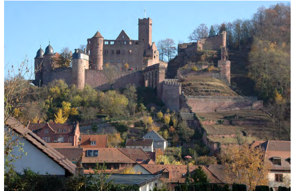
Ansicht von Westen mit Hirschgraben und Schenkelmauern
