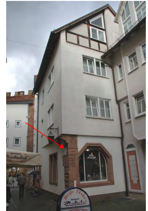
Eckpfeiler, Trakt an der Maingasse
