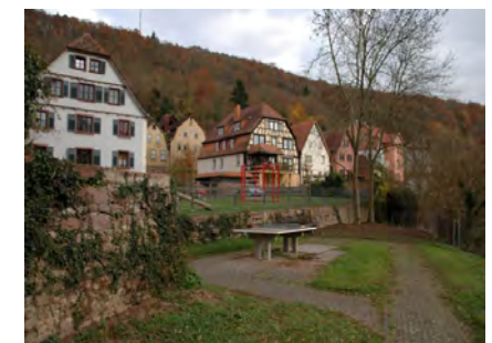
Rückfassaden Nr. 30-48 (v.li.)
