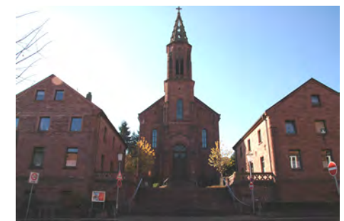
Gebäudegruppe Bismarckstr. 3, 3a, 5
