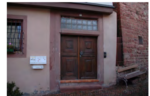
Barockportal mit bauzeitlichem Türblatt
