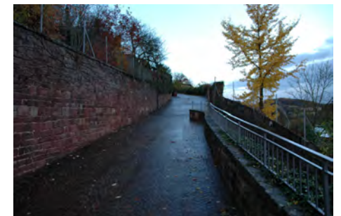
❸ Höhe Nr. 3, in Richtung Süden
