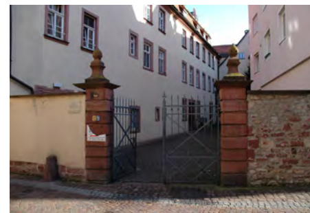
Blick in den Hofraum
