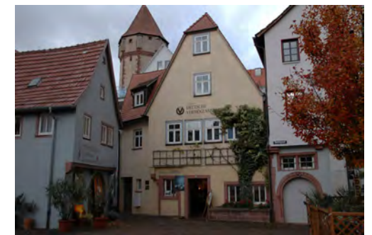
Höhe Neuplatz Nr. 1, in Richtung Norden
