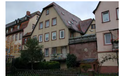
Nordansicht, östlicher Gebäudeteil
