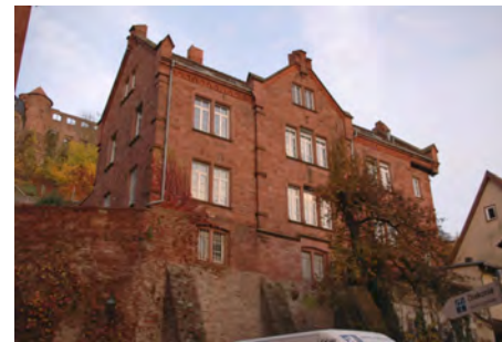
Westansicht des Gebäudes (Prüffall)
