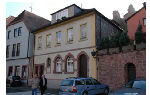
Fassade gg. die Packhofstraße
