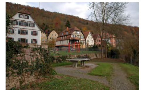
Rückfassaden Nr. 30-48 (v.li.)
