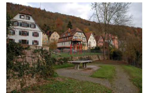
Rückfassaden Nr. 30-48 (v.l.)
