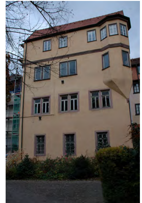
Ansicht gg. den Hof, Westfassade
