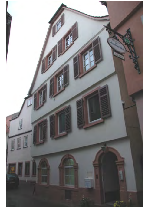
Hauptfassade an der Gerbergasse
