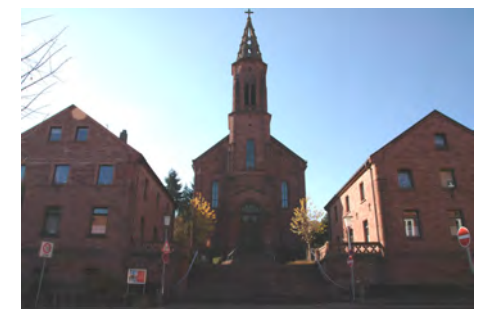
Gebäudegruppe Bismarckstr. 3, 3a, 5
