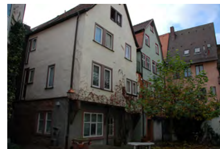
Rückfassade(Mitte) gg. den Innenhof
