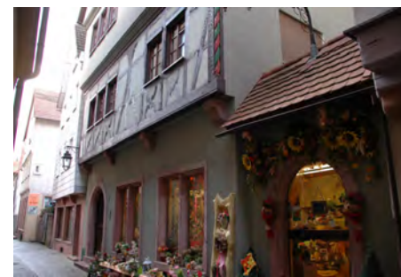
Zierfachwerk im 1. Obergeschoss
