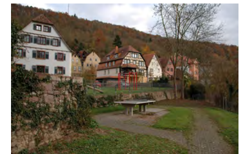
Rückfassaden Nr. 30-48 (v.l.)
