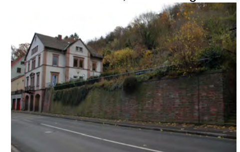
③ Höhe Nr. 76, in Richtung Osten
