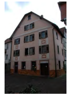
Erweiterungsbau, gg. den Neuplatz
