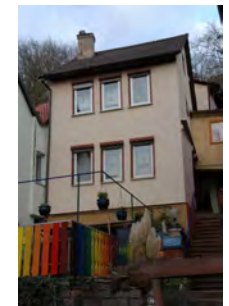
Erhaltenswertes Gebäude, Nr. 17
