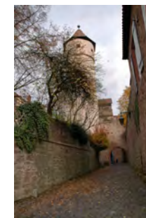
Roter Turm, Westansicht
