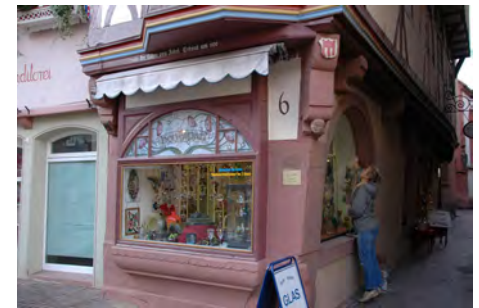
Erdgeschoss, Ecke Kapellengasse
