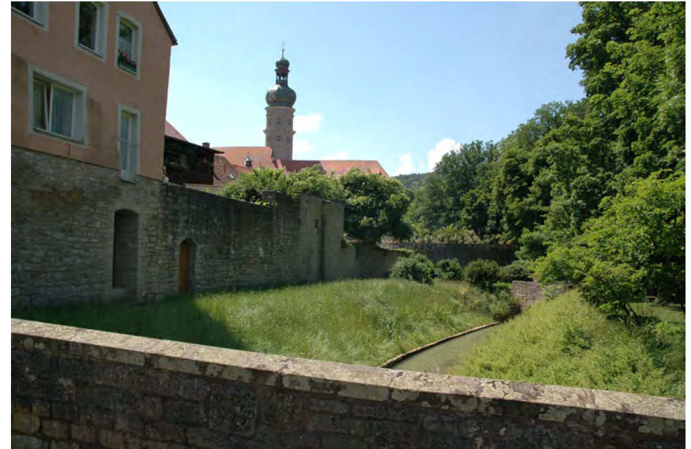
Bereich Stadtgraben, Höhe Hohenloherstraße 14, nach Westen
