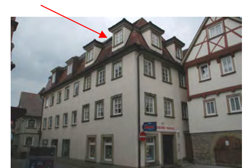
Mit Hauptstraße 18, von Nordwest
