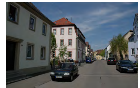
Blick nach Nordost, Höhe Nr. 14
