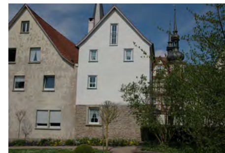
Rückfassade zum Stadtpark
