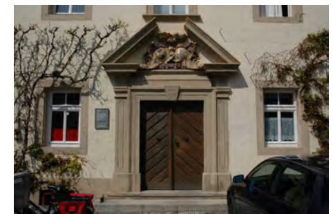
Hauptportal mit Sprenggiebel
