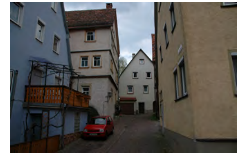
Westansicht mit Kellerbogen
