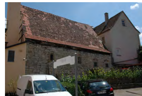
Scheune und Saalbau, Westansicht
