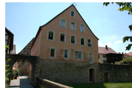
Rückfassade gegen den Stadtgraben
