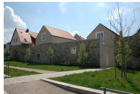
Nordöstlicher Abschnitt, Höhe Kanalstraße
