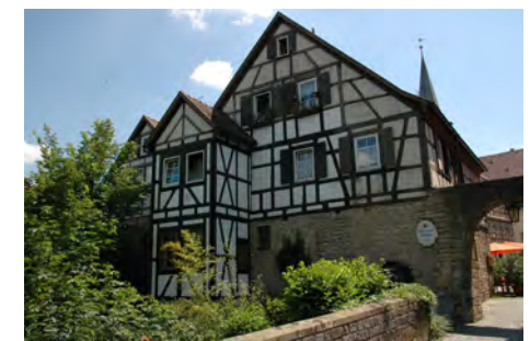
Rückfassade gegen den Stadtgraben
