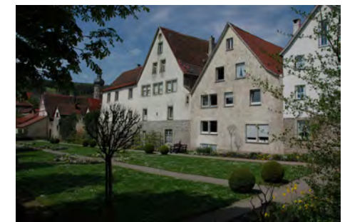
Rückfassaden Hauptstr. 3/1, 3 und 5
