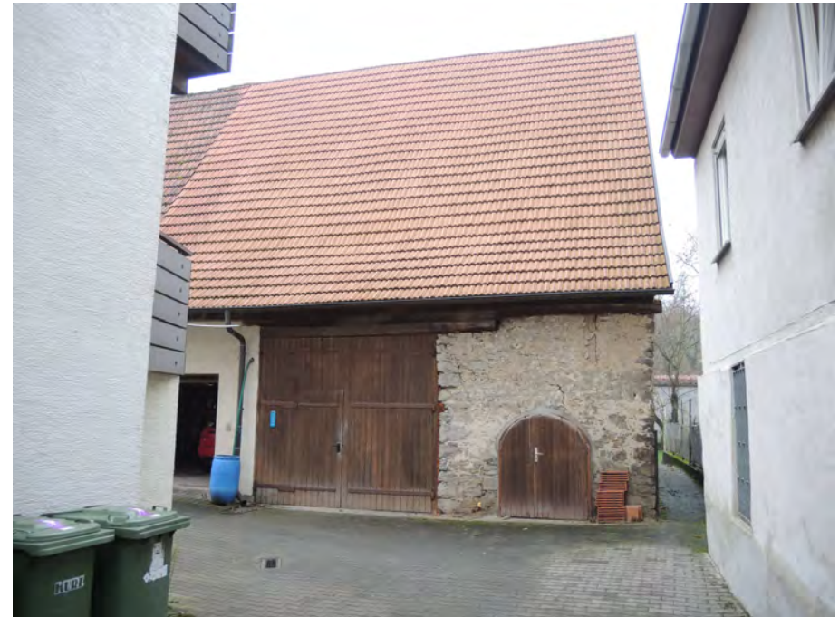
Ansicht der Scheune von Norden
