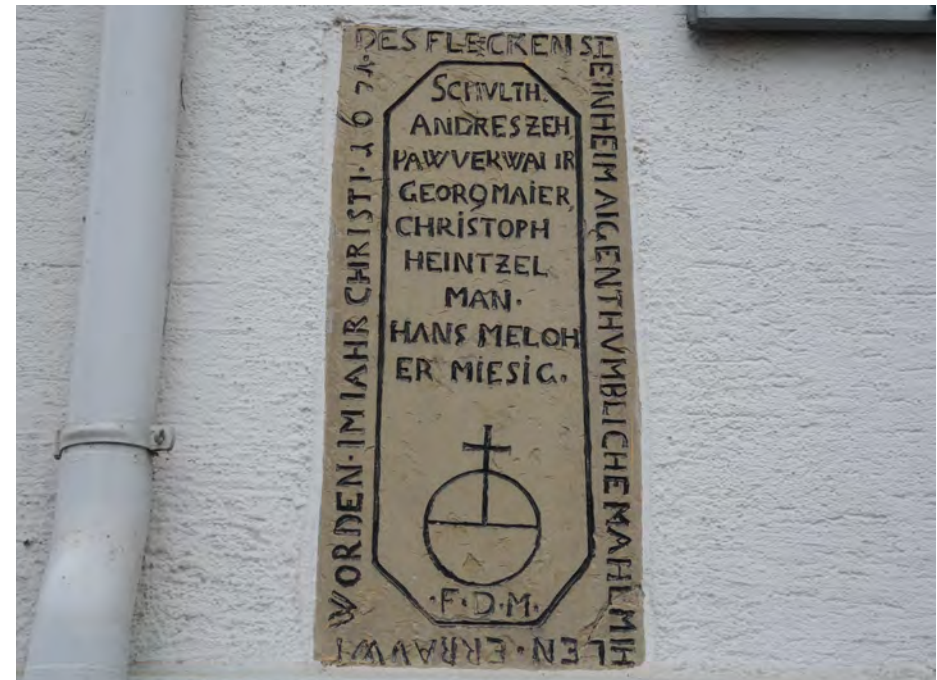
Ansicht der Inscriptentafel an der nordöstlichen Gebäudeecke
