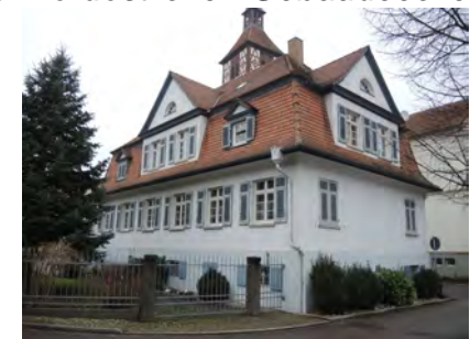
Ansicht des Gebäudes von Südosten
