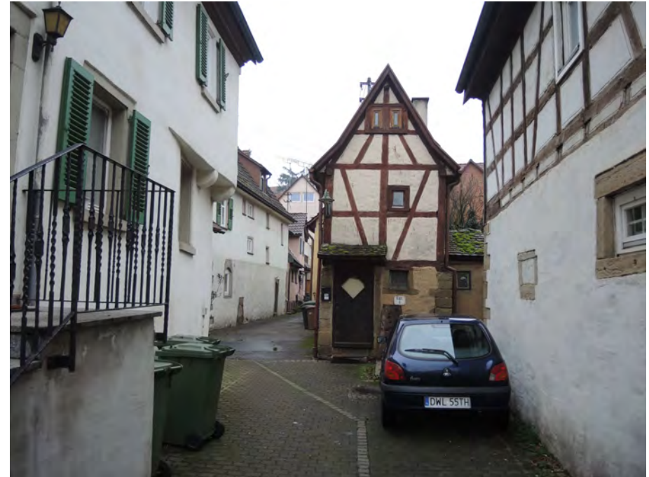
Ansicht des Wohnhauses von Südwesten
