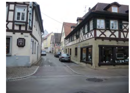
② Blick nach Nordosten ab Marktstraße
