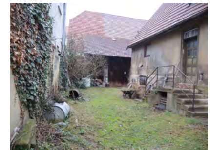
Ansicht der Ökonomie von Südosten
