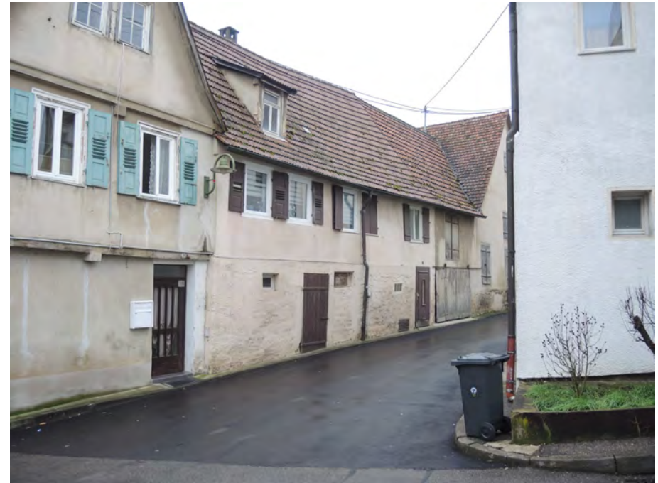
Ansicht des Wohnhauses von Nordosten
