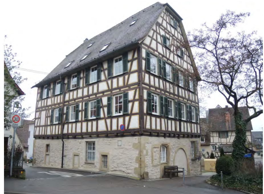
Ansicht des ehemaligen Rathauses von Norden
