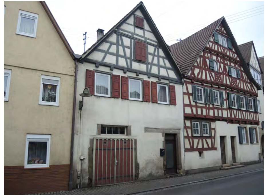
Ansicht des Wohnhauses von Nordosten
