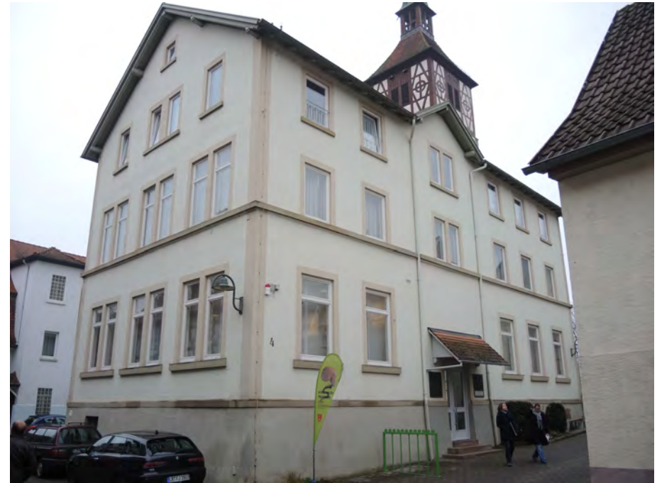
Ansicht des ehemaligen Schulhauses von Nordosten
