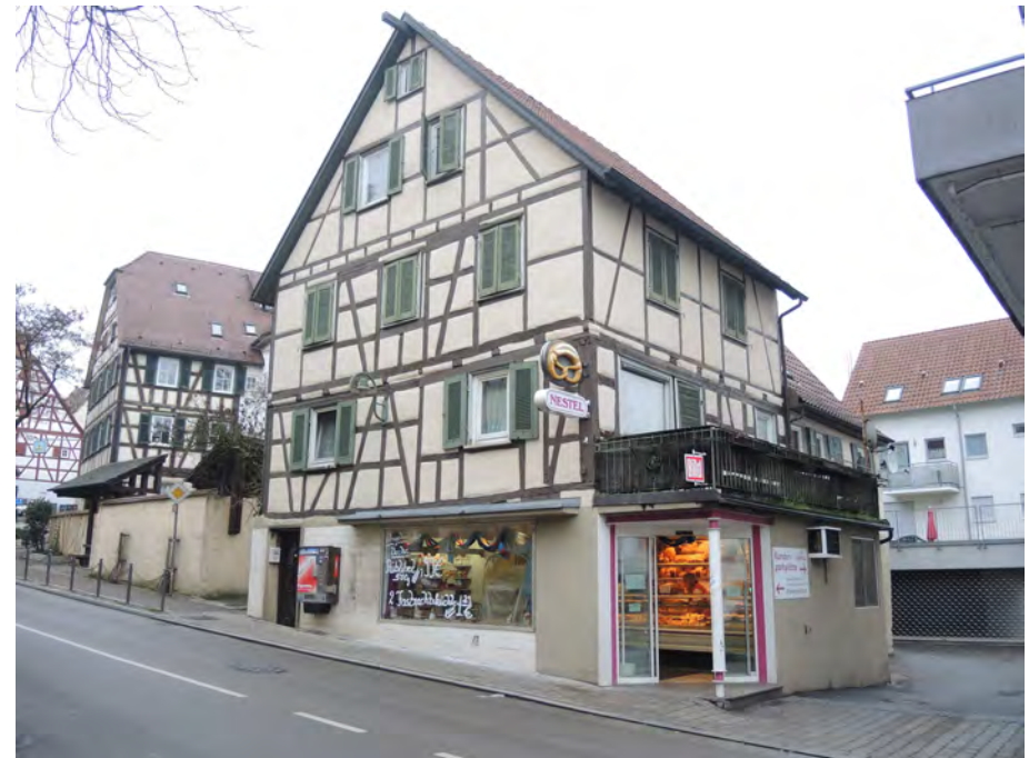
Ansicht des Wohn- und Geschäftshauses (Nr. 10) von Südwesten
