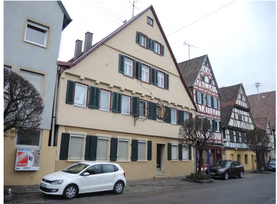
Ansicht des Gasthauses von Südwesten
