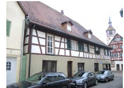
Ansicht von Norden
