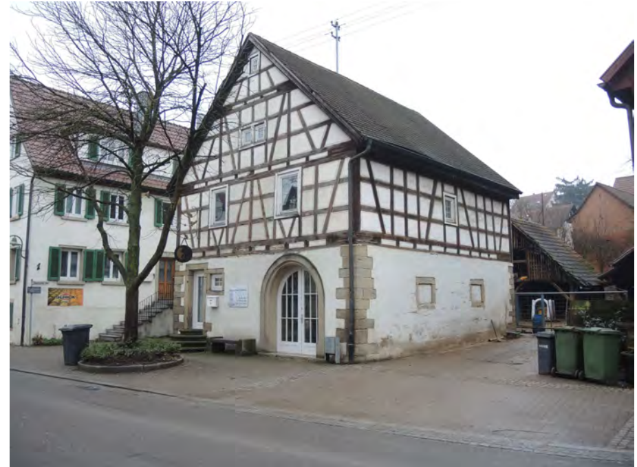
Ansicht des Gebäudes von Südosten
