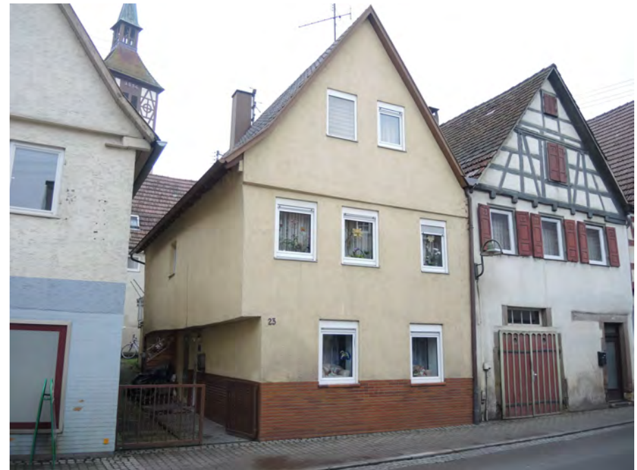
Ansicht des Wohnhauses von Nordosten
