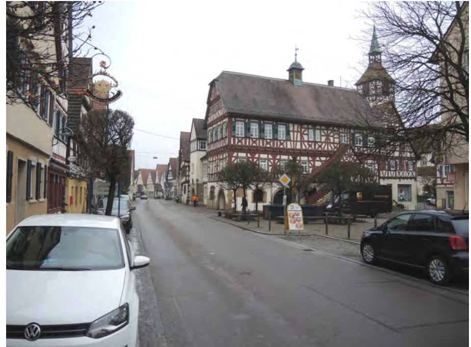
❶ Blick nach Südosten auf Höhe von Hausnr. 42
