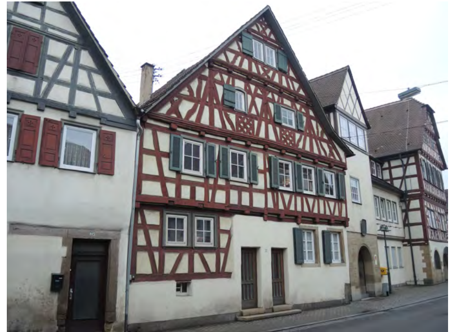
Ansicht des Wohnhauses von Nordosten
