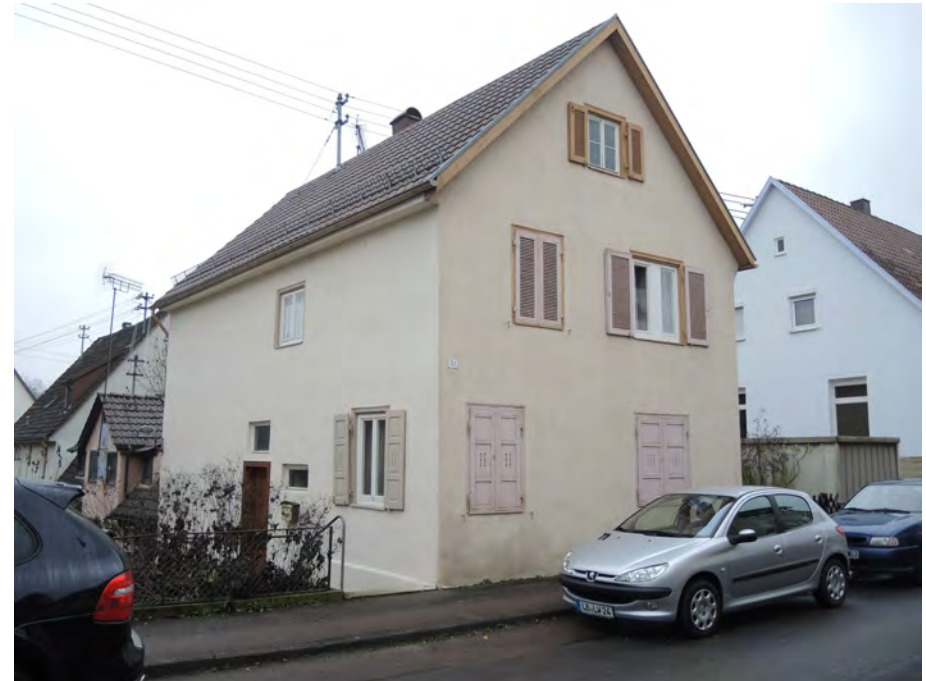
Ansicht des Wohnhauses von Nordosten
