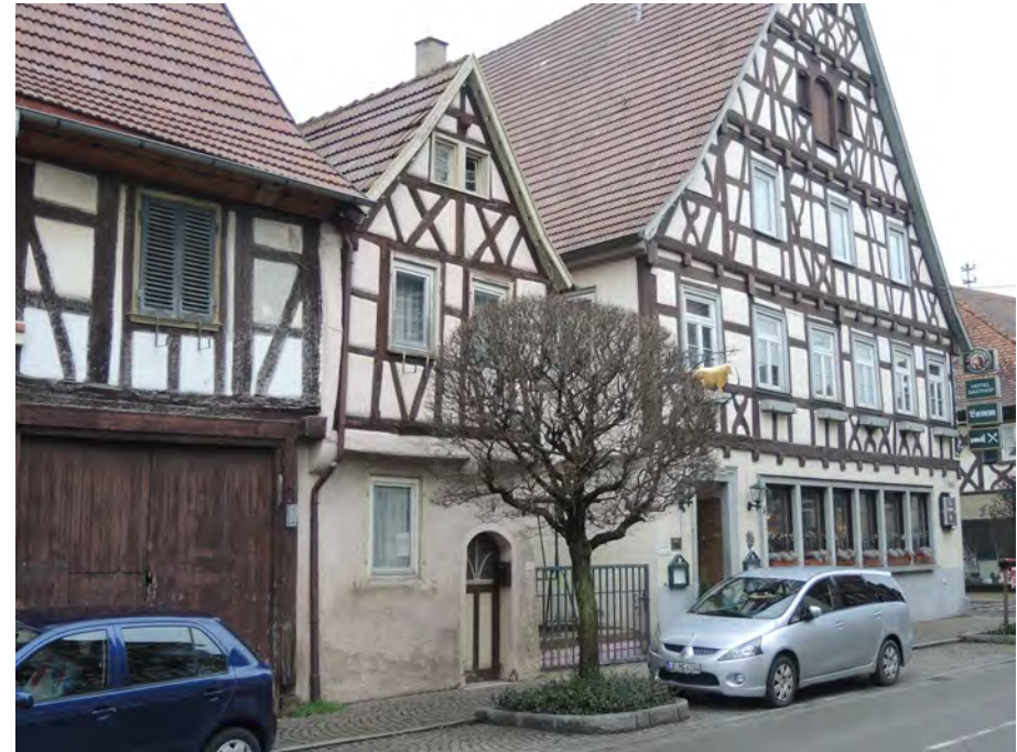
Ansicht des Wohnhauses von Südwesten
