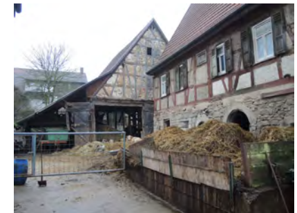
Ansicht der Scheune von Südwesten
