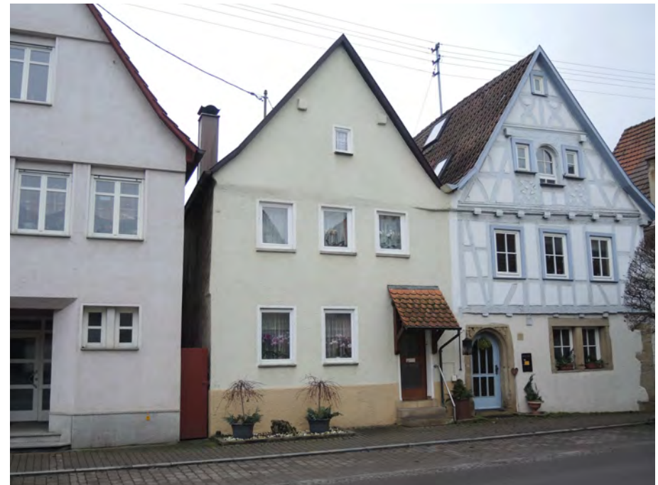
Ansicht des Wohnhauses von Nordosten
