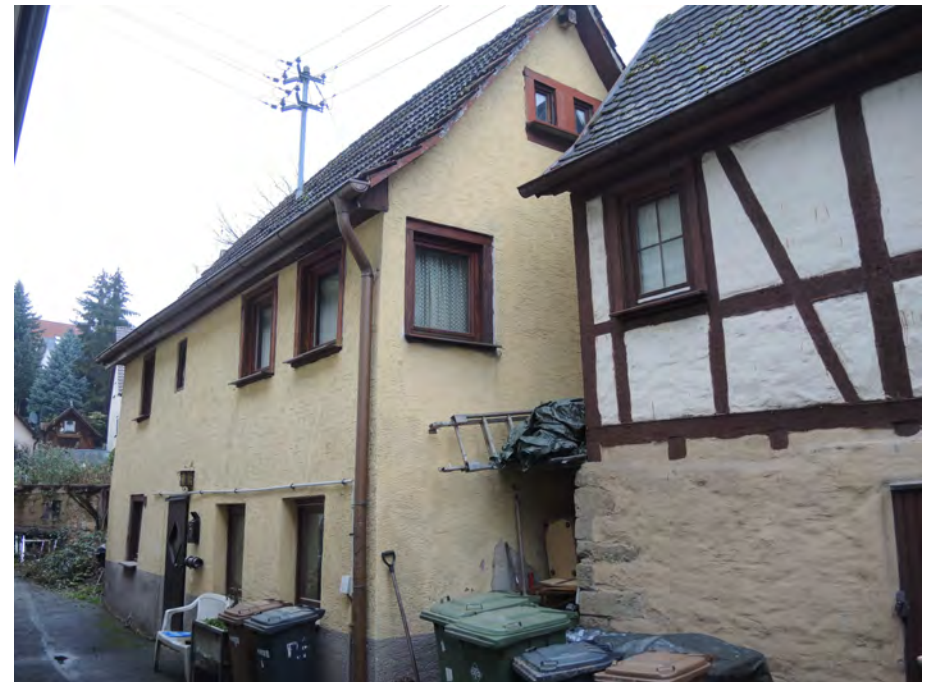
Ansicht des Wohnhauses von Südwesten
