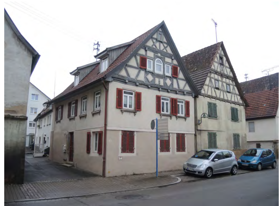
Ansicht des Wohnhauses von Südwesten
