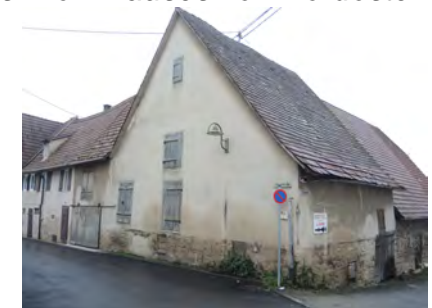
Ansicht der Scheune von Norden
