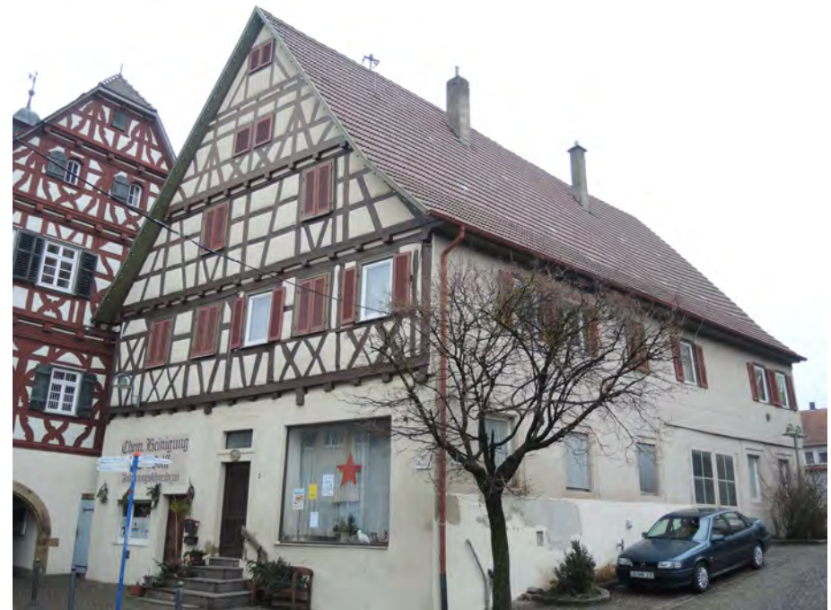
Ansicht des ehemaligen Pfarrhauses von Südwesten
