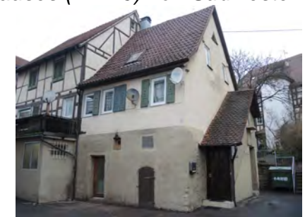
Ansicht (Nr. 12) von Südosten
