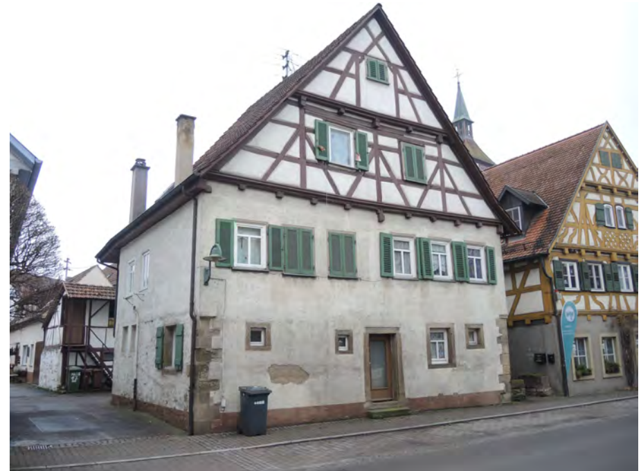
Ansicht des Wohnhauses von Nordosten
