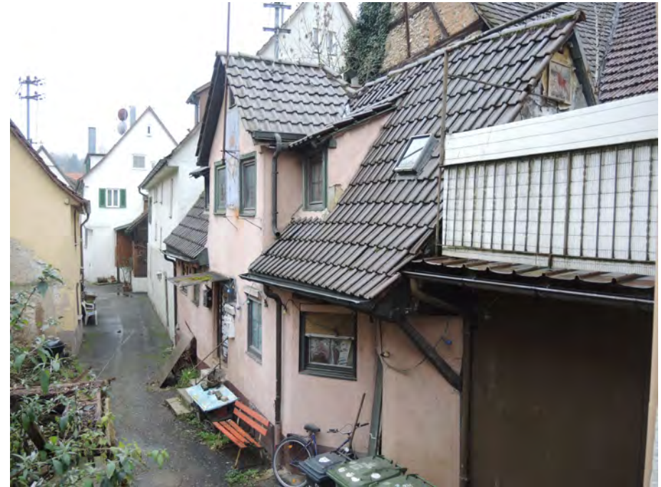
Ansicht des Wohnhauses von Nordosten
