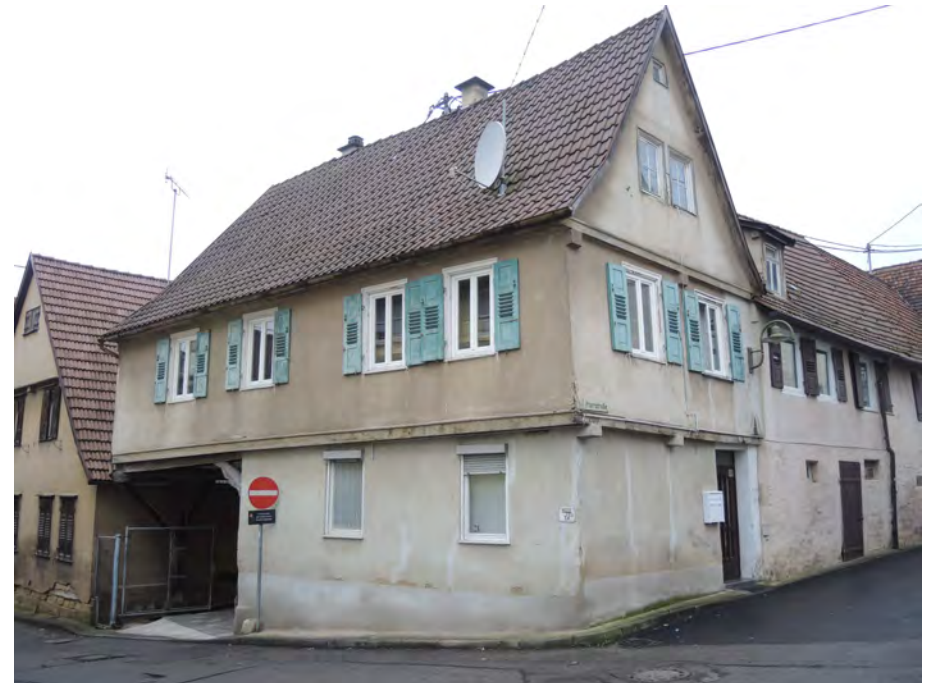
Ansicht des Wohnhauses von Nordosten
