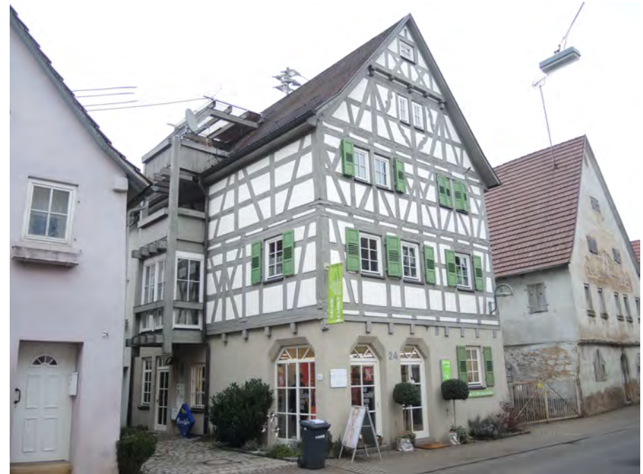
Ansicht des Wohnhauses von Südwesten
