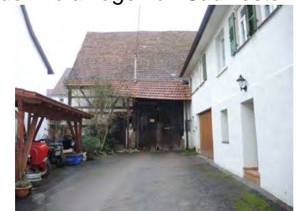
Ansicht der Scheune von Südwesten
