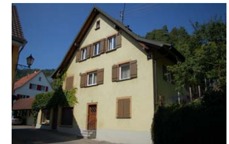
Ansicht von Südosten (Foto: Ref. 26)
