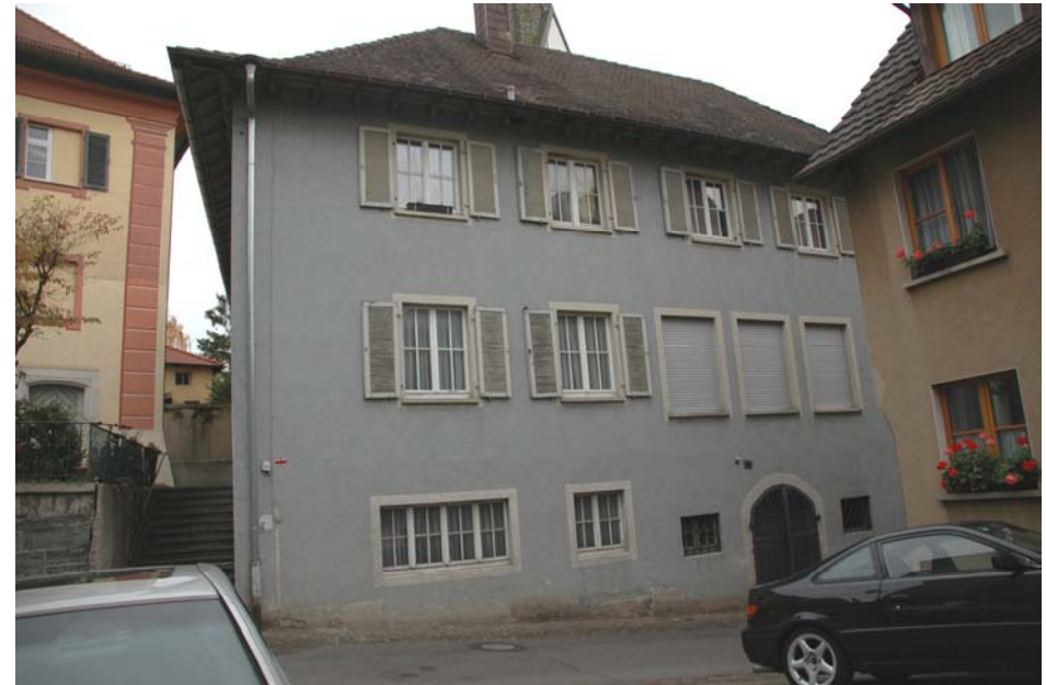
Westfassade gegen die Rathausstraße mit Kellerbogen
