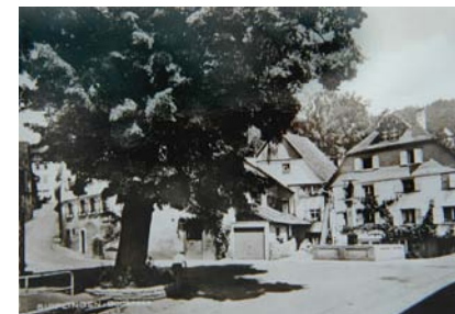
Ansicht mit altem Ökonomieteil (Lohrer)
