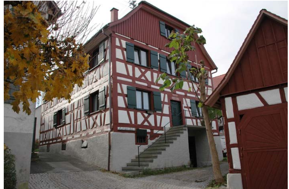
Blick auf das Wohnhaus von Westen, von der Rathausstraße aus
