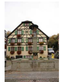
Gesamtansicht mit Brunnentrog
