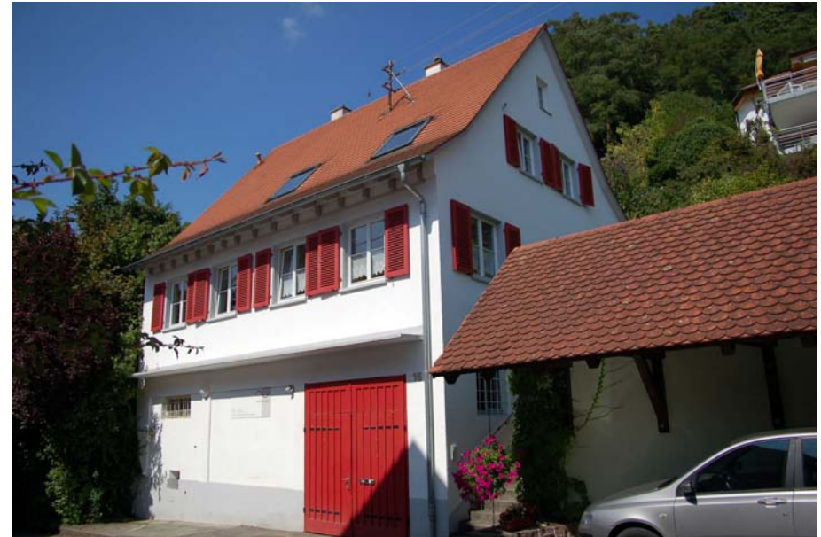
Ansicht von Südosten (Foto: Ref. 26)
