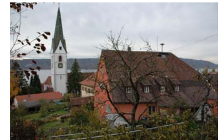
Blick auf die Rückfassade
