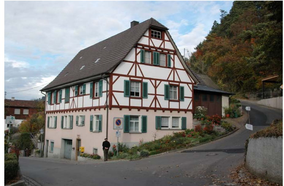
Ansicht von Südosten am Abzweig zur Kleinen Steige
