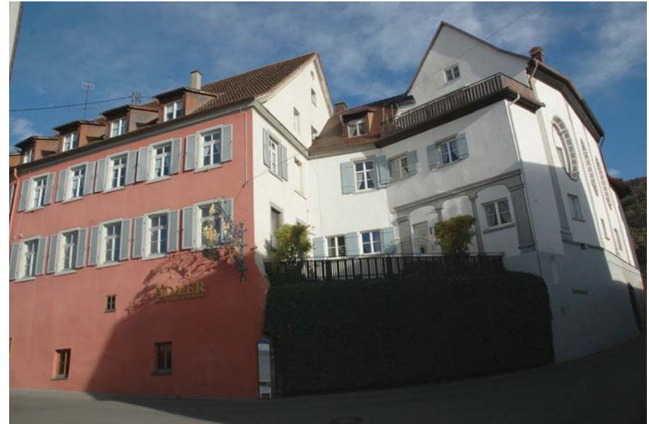
Blick vom Lenzensteig auf die Südostfassade; rechts die ehem. Kapelle
