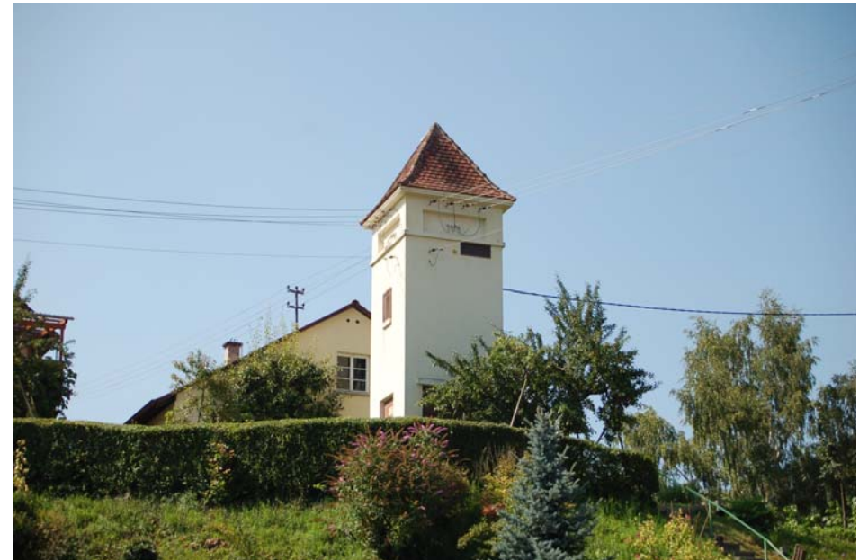
Ansicht gegen Osten, in Richtung Rathausstraße (Foto: Ref. 26)
