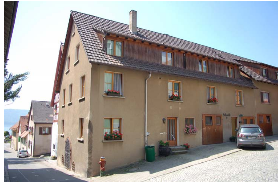
Blick von Nordosten
