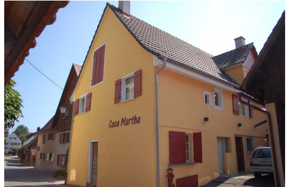
Ansicht von Nordwesten (Foto:Ref.26)
