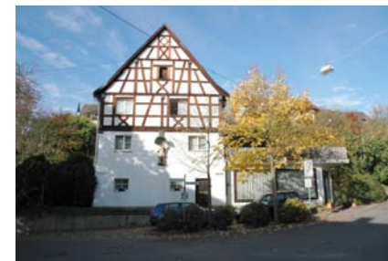
Ostfassade gegen die Kreuzung
