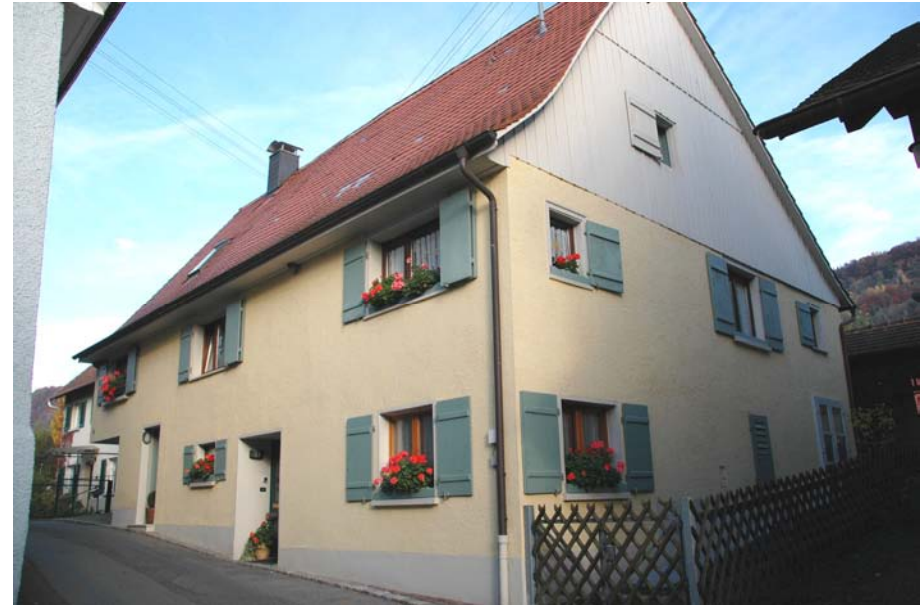
Ansicht von Südosten
