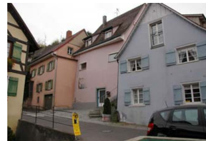
Gesamtansicht mit Nr. 14 und 12
