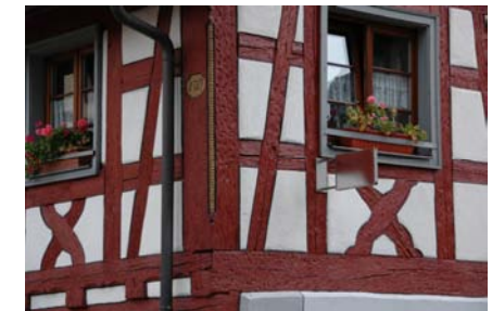
Fassadendetail mit Bauinschrift
