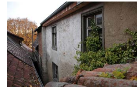
Ehem. Kaplanei, Ostfassade
