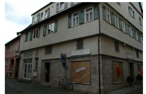
Ansicht Ecke Hirschgasse
