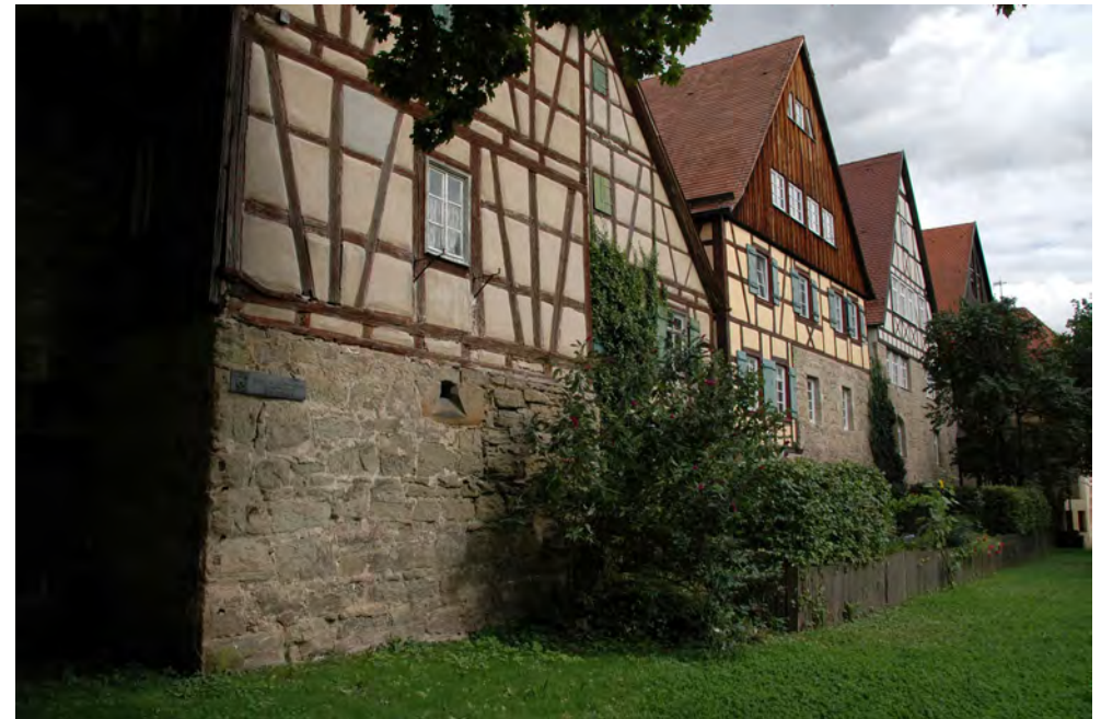
Stadtmauer des 14. Jh. im Bereich Im Sack 3-7
