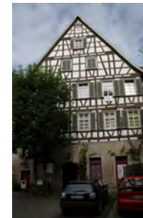
Südfassade gegen den ehem. Stadtgraben
