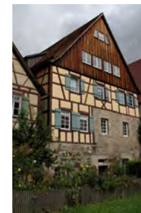
Südfassade zum ehem. Stadtgraben
