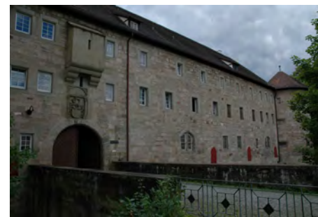
Nordansicht mit Brücke
