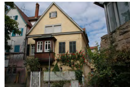
Südfassade gegen den ehem. Stadtgraben
