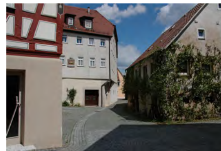
❷ Höhe Amtsgasse 12, gg. Norden
