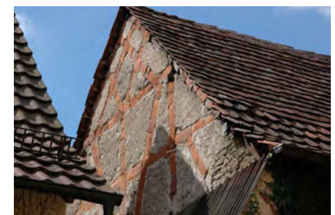
Fachwerkverkleidung mit Biberschwanzziegel
