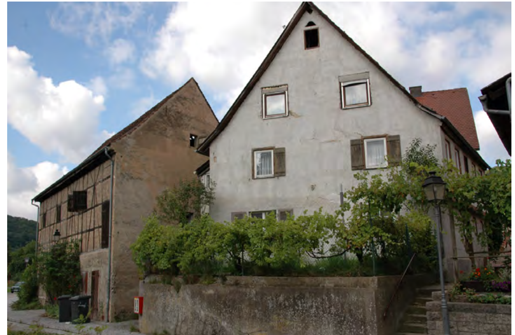
Ansicht gegen die Bahnhofstraße mit Durchgang von 1924
