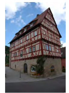
Ansicht von Südost
