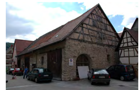
Ansicht von Norden
