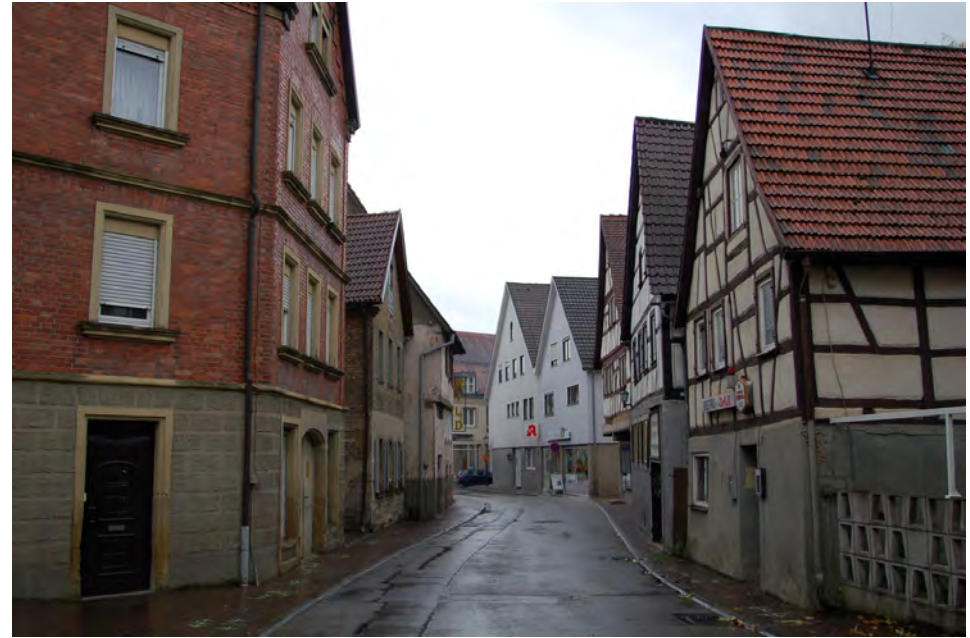
Mühlgasse von der Abzweigung Hauptstraße nach Süden (❶, ❷)
