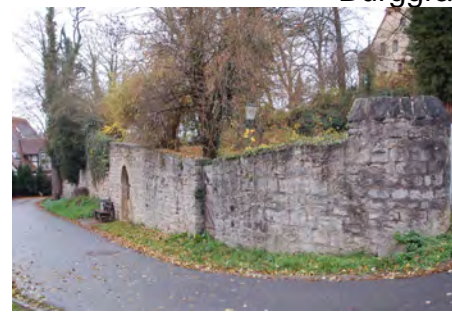
Zufahrtsmauer mit Brunnennische
