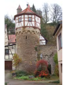
Ansicht von außen
