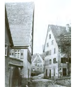
Stadtmühle vor dem Abbruch (links)
