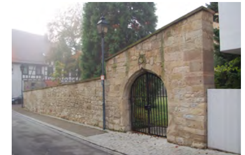
Ummauerung an der Spitalgasse
