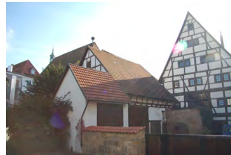
Rückansicht und Nebengebäude Nr. 4/2
