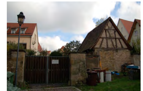
Waschhaus und Ummauerung
