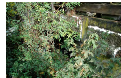
Tonnengewölbe von Westen
