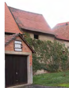
Rückansicht mit Vorstadtmauer
