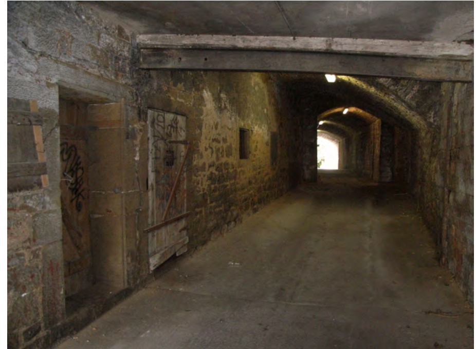
Der „Tunnel“ Grabenstraße von Nord nach Süd
