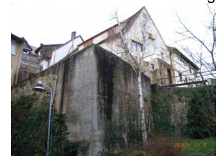
Südliche Mauer von Grabenstraße
