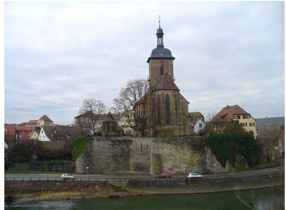
Kirchhofmauer an der Kiesstraße von Neckarburg
