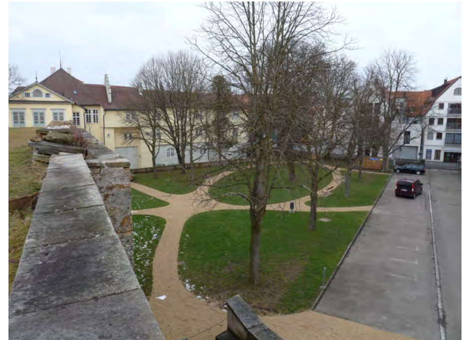
Ansicht von der Bastion
