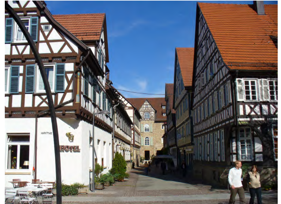
❶ Ansicht nach Norden
