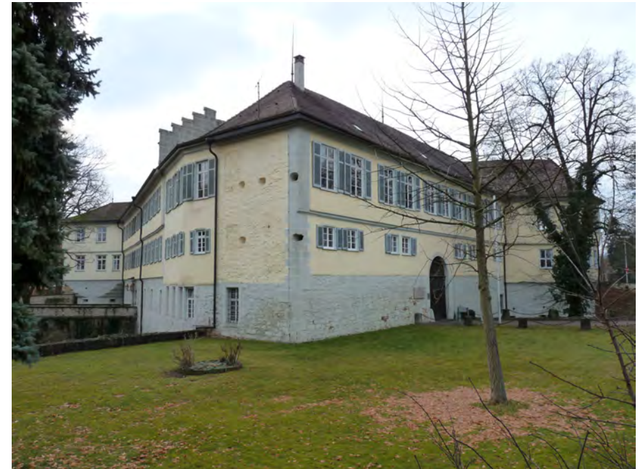
Ansicht von der Alleenstraße
