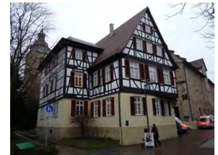
Westseite mit Anbau
