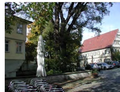
Ansicht nach Nordwesten
