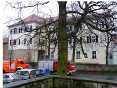
Ansicht von der Alleenstraße
