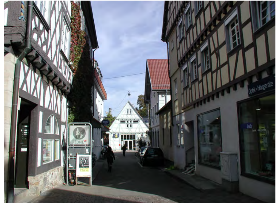
❶ Ansicht nach Norden
