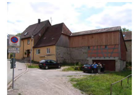
Rückansicht mit Poststraße 29
