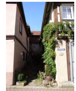
Stadtmauerabschnitt zw. Kirchstr. 13 u. 15
