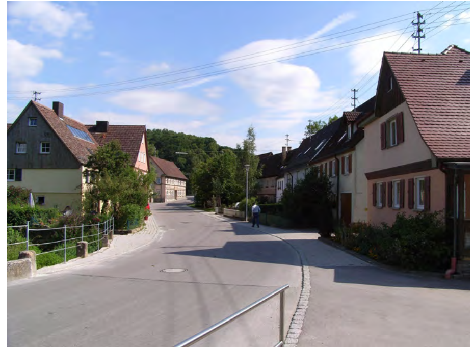
Ansicht nach Süden (bei Nr. 15) ❶
