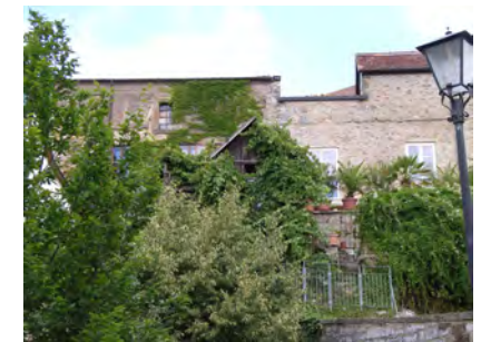
Rückansicht mit Stadtmauerabschnitt
