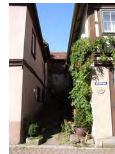
Stadtmauerabschnitt zw. Kirchstr. 13 u. 15
