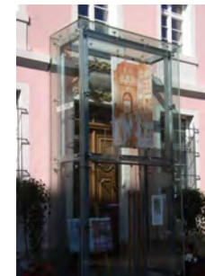
Portal mit Glasvorbau
