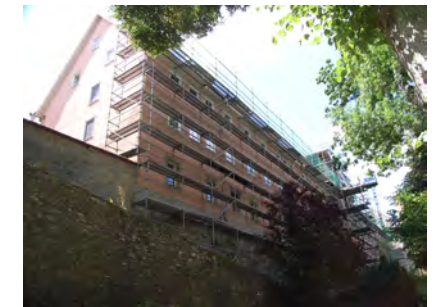
Rückansicht vom Neuen Weg
