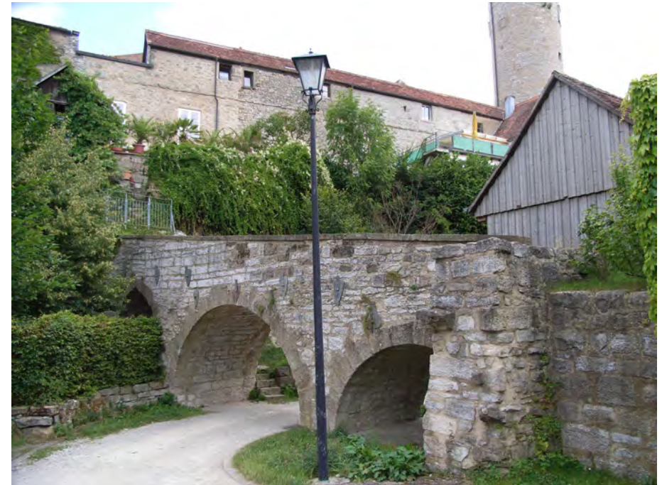
Aquädukt am Neuen Weg
