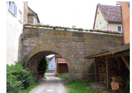
Grabenbrücke in der Poststraße
