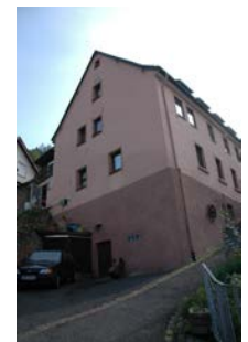
Ansicht von Nordwest
