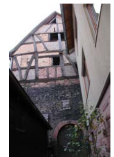
Giebelansicht mit Kellerbogen
