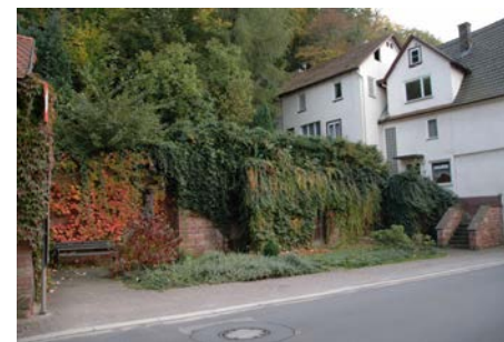
Ansicht von Nordwest
