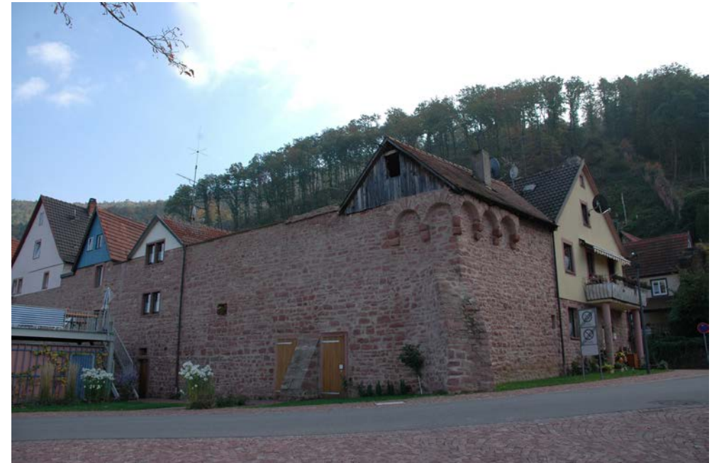
Mainstraße Ecke Hauptstraße, Reste der Zwingermauer
