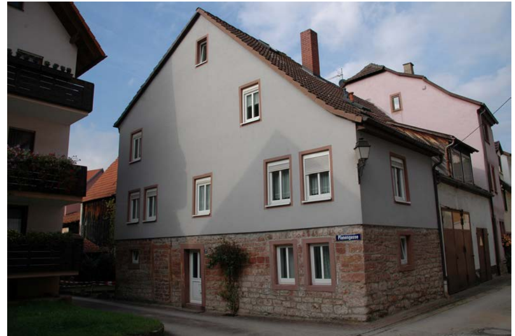
Ansicht Ecke Scheuergasse, Blick in nordwestliche Richtung
