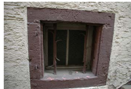
Fenstergewände, Rückfassade, bez. 1718
