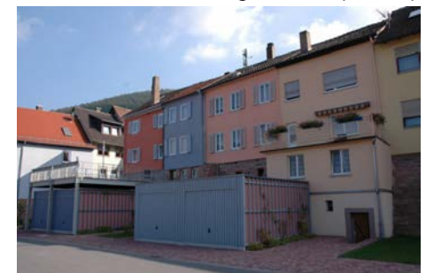
Rückfassaden gg. die Mainstraße
