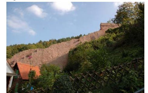
Schenkelmauer, Höhe Burgweg 7
