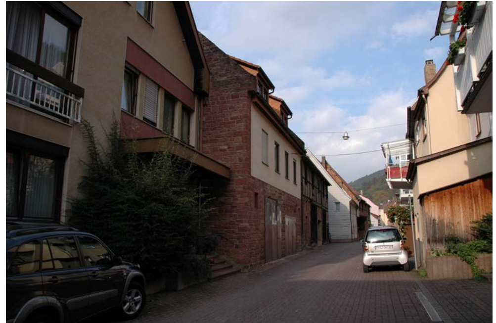
Blick nach Nordost, Höhe Maingasse
