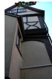
Detail Giebelfassade(gg. Nordost)
