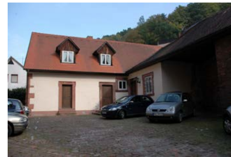
Erhaltenswertes Nebengeb. (eh. Remise)
