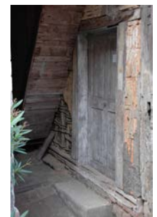
Details: Werkstattzugang, Fachwerkwand
