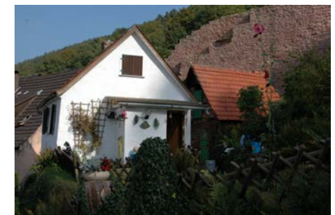
Ansicht von Süden mit Schenkelmauer
