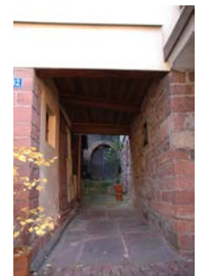
Durchgang zur Scheune Nr. 34
