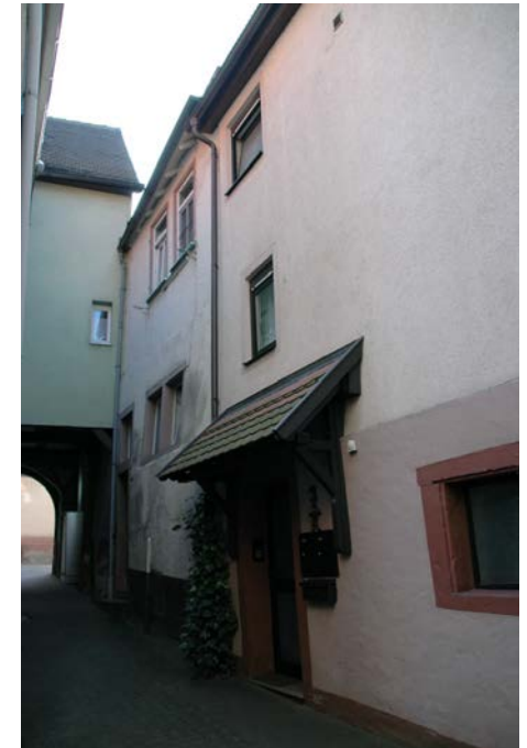
Seitenfassade gegen die Hallengasse (rechts)
