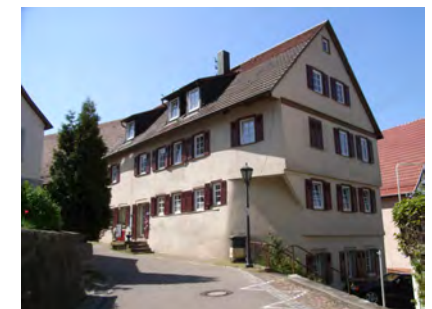
Haupthaus von der Schulstraße
