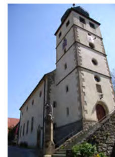
Ansicht von Nordwest
