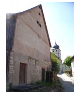
Scheune, Ansicht gegen die Kirchgasse
