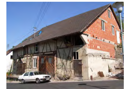
Ansicht von Südost
