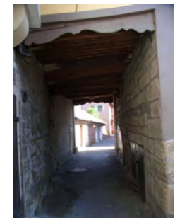
Durchgang, Blick nach Osten
