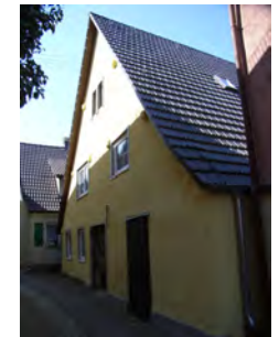
Ansicht gegen die Hafenmarktstraße
