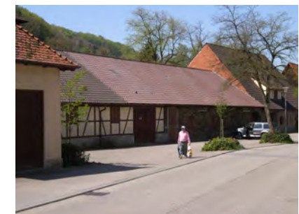
Kelter von Südost
