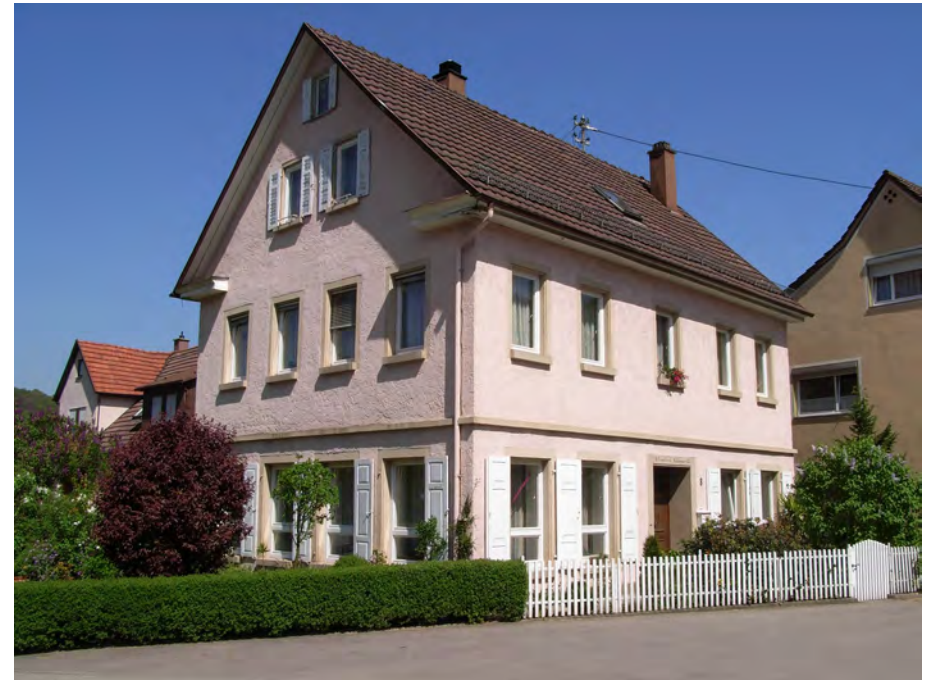
Ansicht gegen die Öhringer Straße
