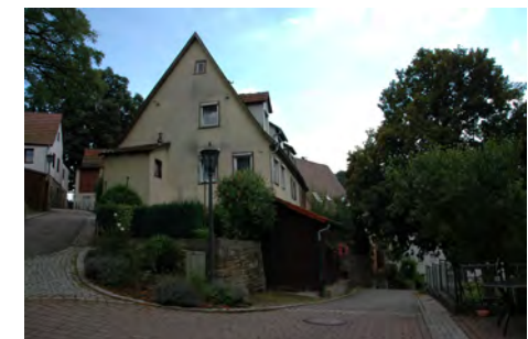
Blick in Richtung Südwesten
