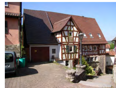
Hauptgebäude mit Wirtschaftsteil (li)
