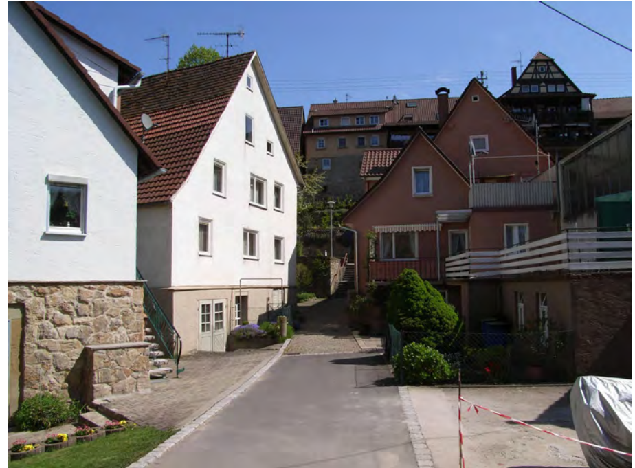
Blick in Richtung Nordost
