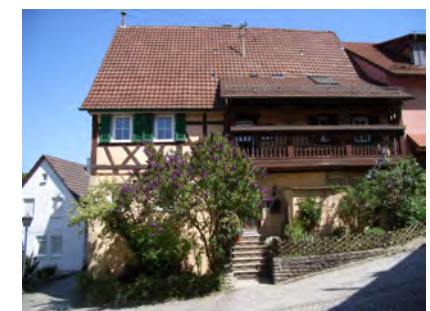
Westansicht mit Laubengang
