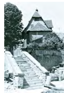
Treppenaufgang, hist. Ansicht
