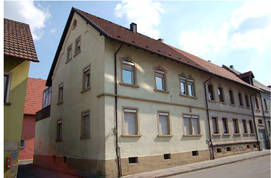
Badgasse 11 von der Rappenauser Straße aus (Schauseite)
