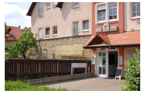
Erneuerte Stadtmauer (Kleinbrückentorplatz 3)
