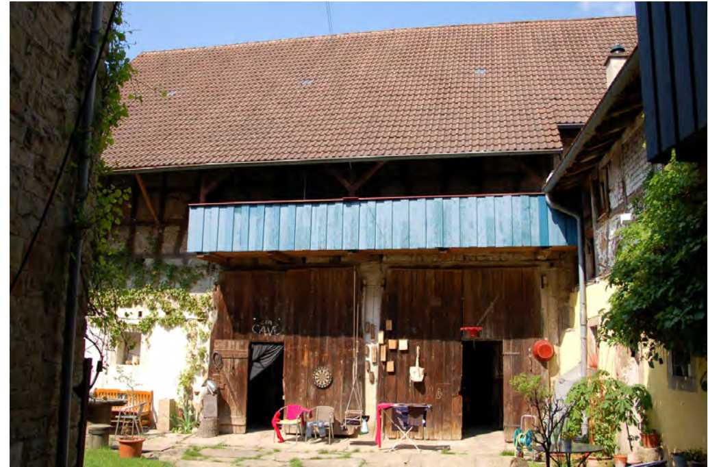
Scheune vom Innenhof des Anwesen aus (Süden)
