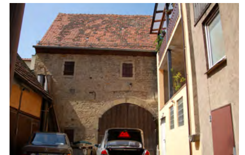
Rückwärtige Scheune von Osten
