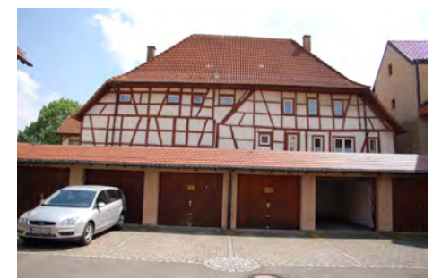
Ansicht von Norden
