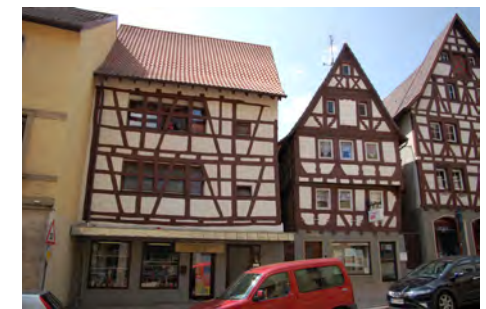
Mit der ehemaligen Scheune 6/1 (links)
