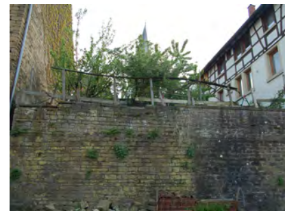
Mauer östlich des Anwesens
