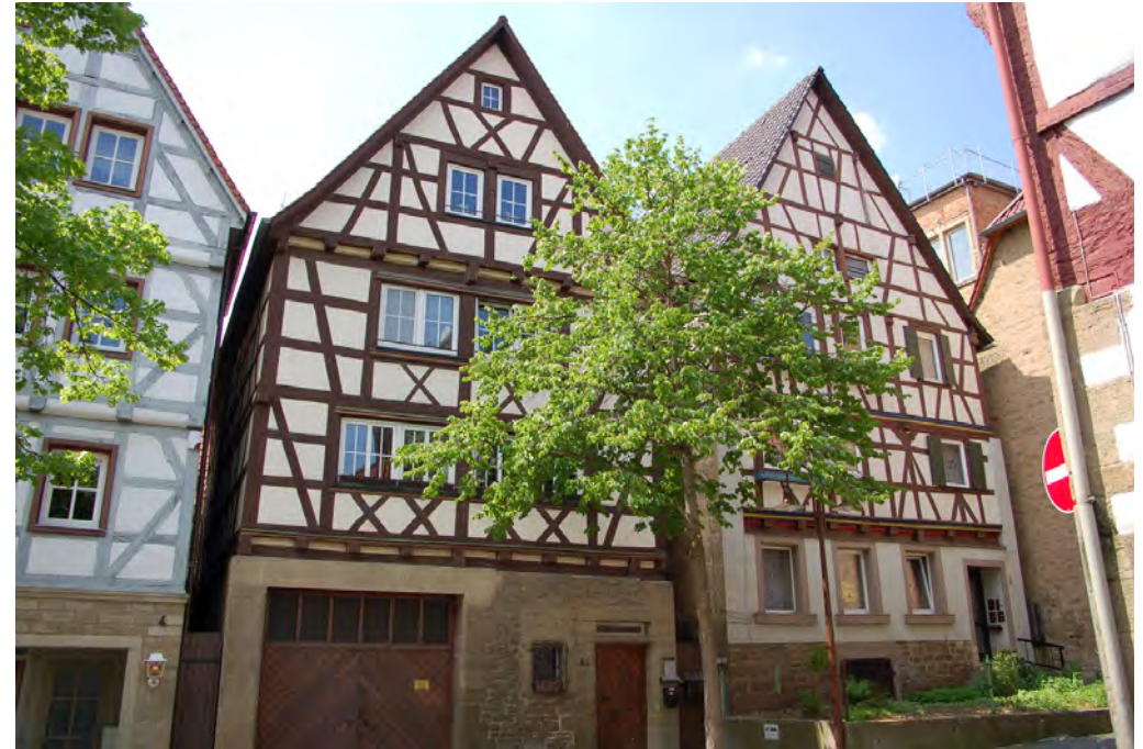
Ehemalige Scheune Nr. 2/1 links, Wohnhaus Nr. 2 rechts
