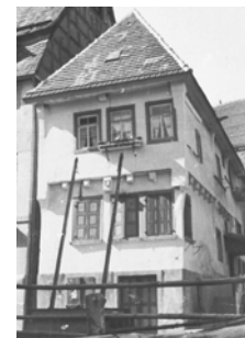
Vor der Fachwerkfreilegung
