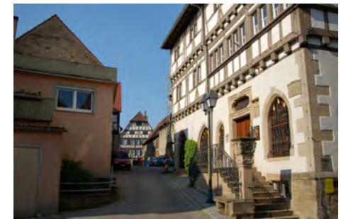
Von der Altstadtstraße nach Norden
