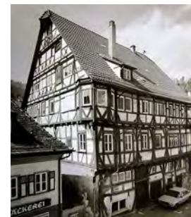
Aufnahme vor der Sanierung
