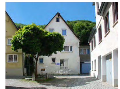
Ausrichtung auf die Ziegelgasse ❶
