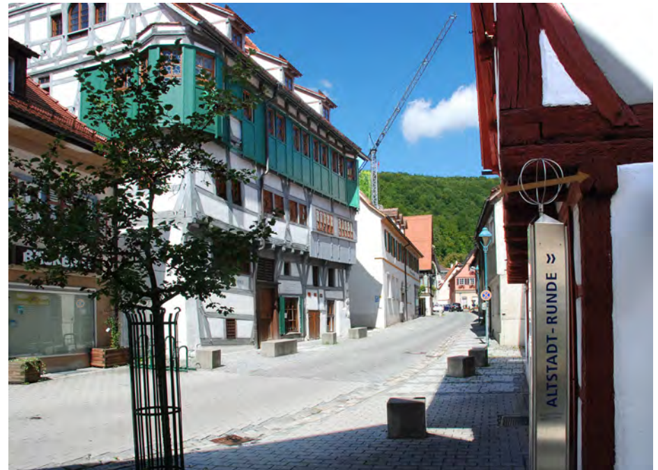
Webergasse beim sog. »Großen Haus« ①
