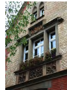
Fenster im Risalit nach Süden ③
