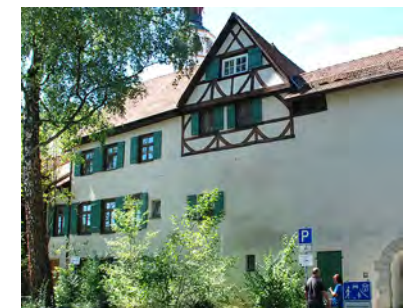
Gebäuderückseite mit Stadtbefestigung
