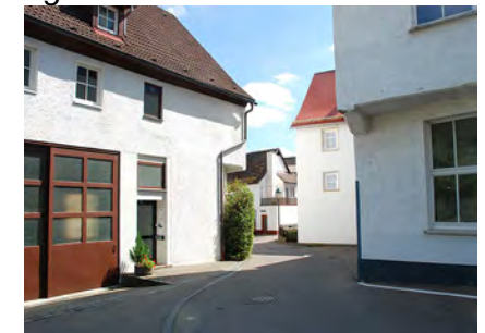
Straßenknicke östlicher Abschnitt
