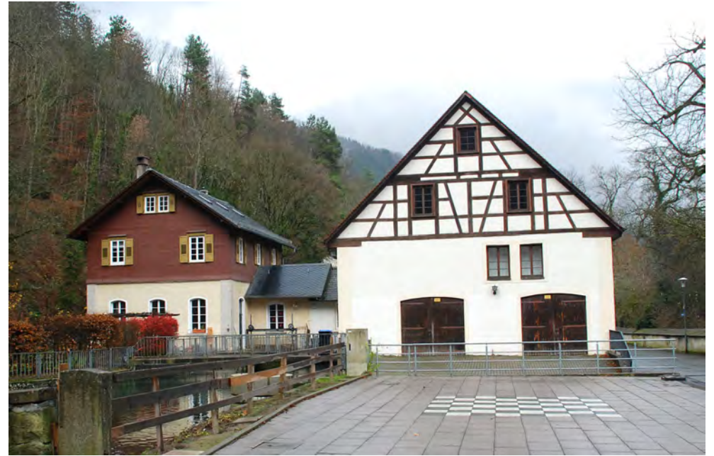
Wohn- und Maschinengebäude links, Kanal und Pumpenhaus ❶
