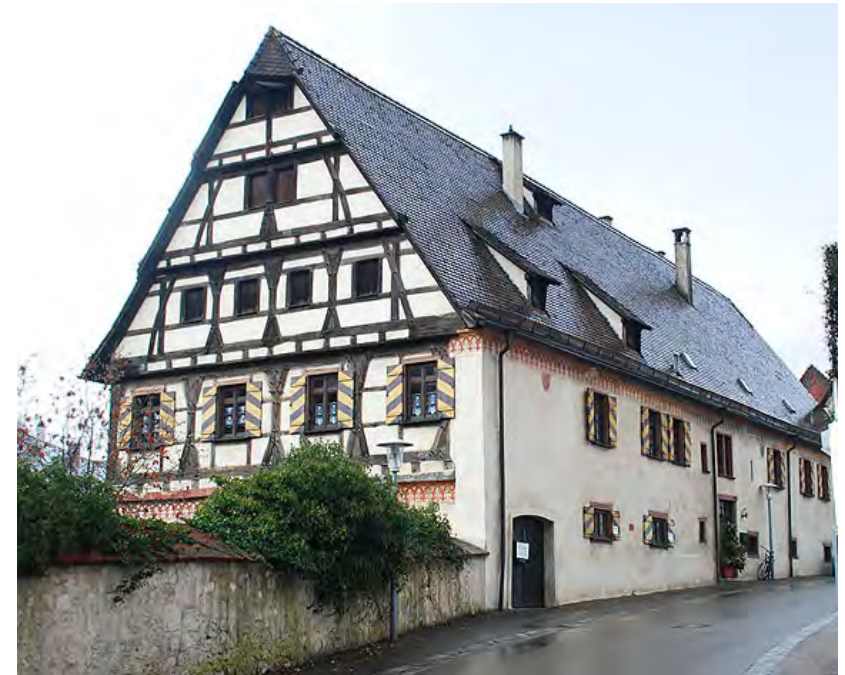
Bandhaus und Reste der Klostermauer ❶
