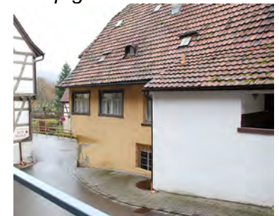
Zur Blau abknickender Verlauf des Mühlwegs
