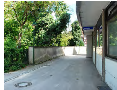
Mauergasse im westl. Bereich mit Betonbau
