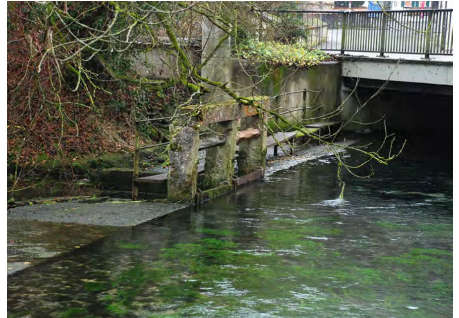
Blau mit Regulierungsschleuse und Streichwehr bei der Schimmelmühle 1
