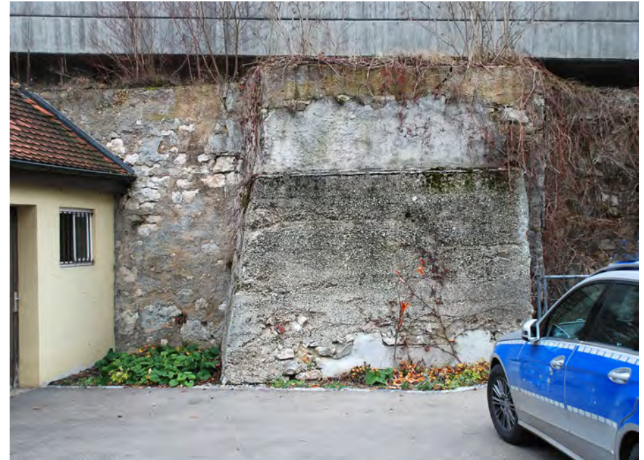
Mauerreste unter und hinter den Betonstützmauern der Lindenstraße ❶
