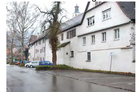
Gut sichtbarer Mauerverlauf ❹
