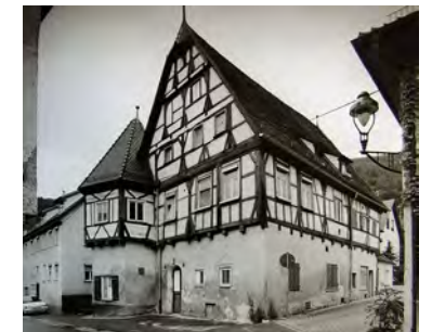
Zustand vor der Sanierung
