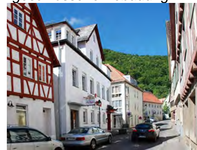
Oberer Abschnitt mit Neubauten ❸
