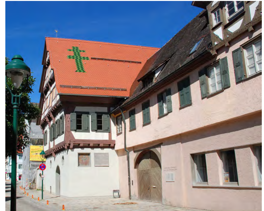
Front zur Karlstraße mit Hauptbau links ❶
