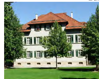
Ehemaliges Amtsgericht ❸
