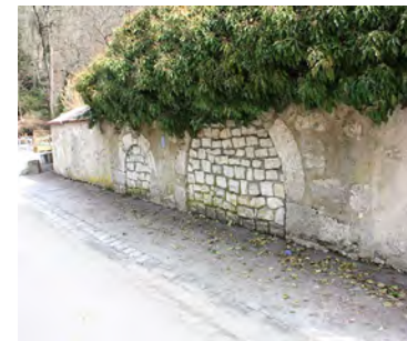
An der Blautopfgasse mit ehem. Portal ❷
