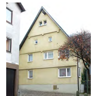
Giebel zur Ziegelgasse ❶
