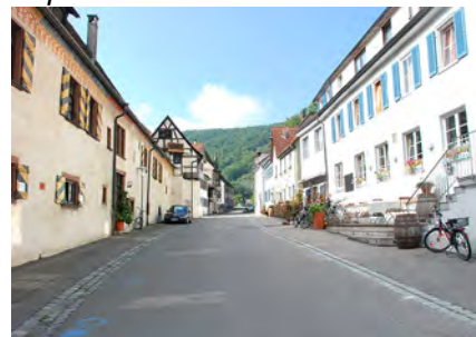
Mittl. Abschnitt bei der Klostermauer (li) ❸
