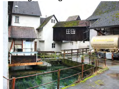
Mühlkanal und Turbinenhaus (li.) der Schimmelmühle 2
