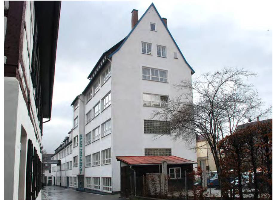
Westgabel des Baus von 1956 ❶
