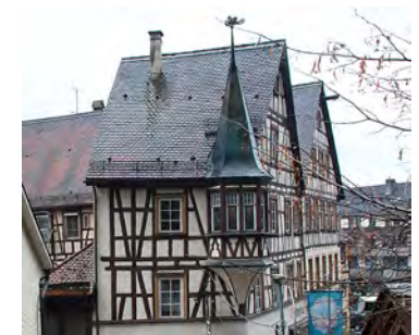
Ansicht von Norden ❸
