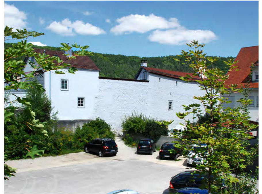
Außenseiten von Küfergasse 22 (li.), 24 und 26 ❶
