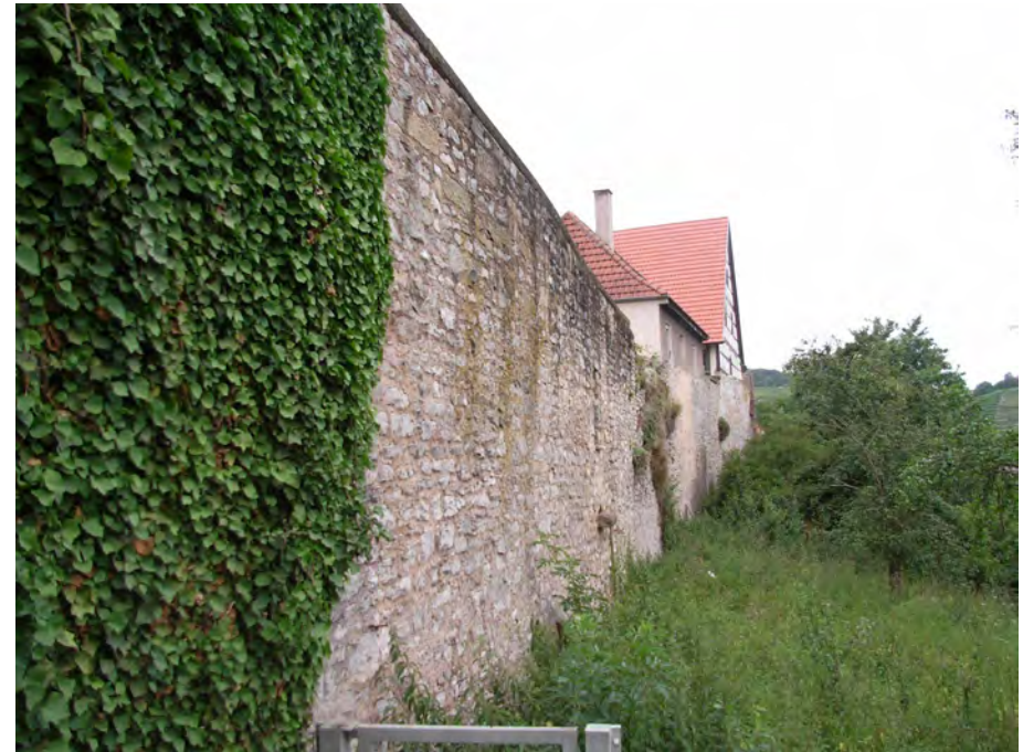
Innere Stadtmauer im Südosten, zu Kirchstraße 63
