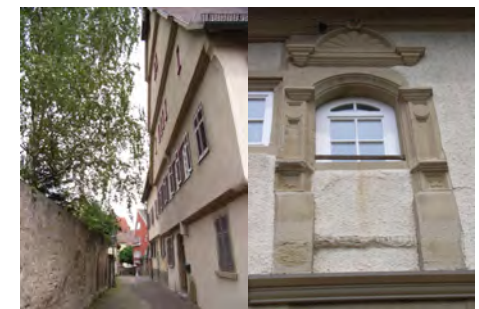
Giebelseite; ehemaliger Balkon
