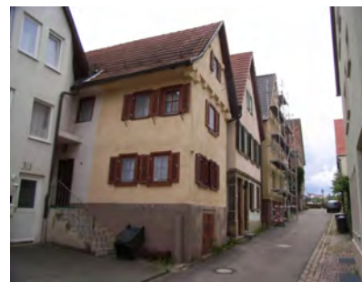
Bebauung der Südseite
