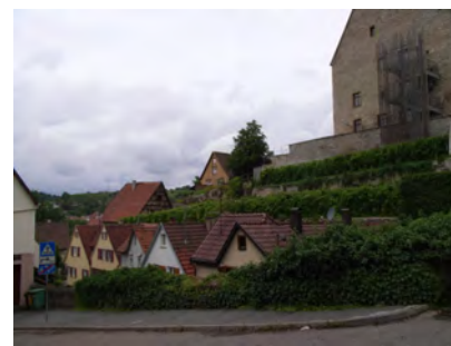
Gesamtansicht von Osten
