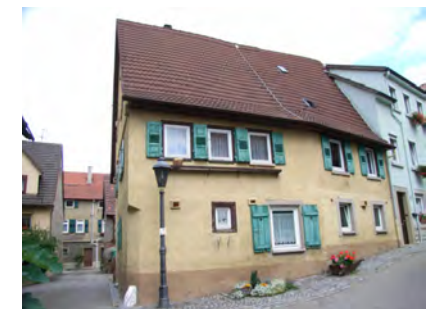
Südseite des Anwesens
