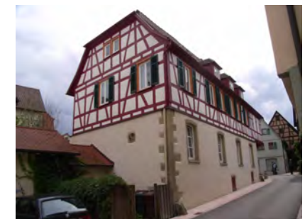
Ansicht von Osten (Nordflügel)
