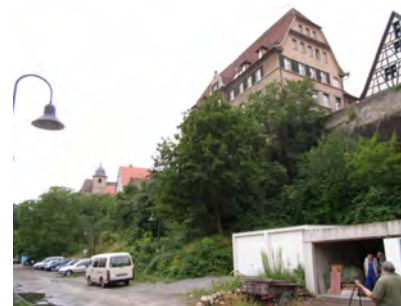
Stadtgraben ohne äußere Mauer
