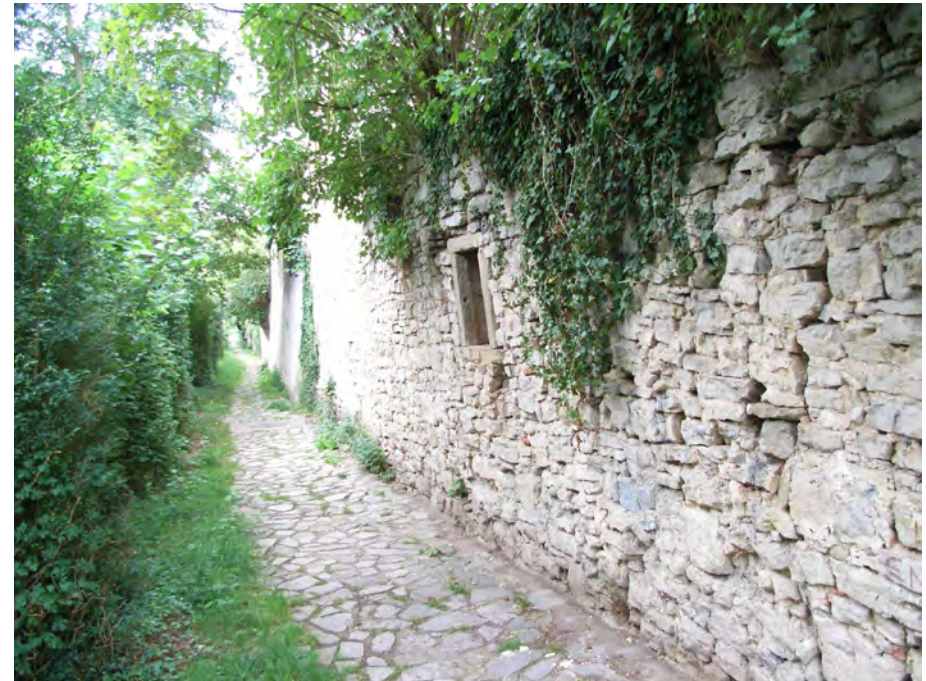
Äußere Stadtmauer im Nordwesten, zu Vorstadt 19, 23, 25
