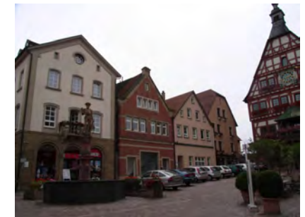
Südliche Bauzeile mit Rathaus
