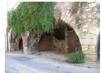
Gewölbe des Kellers
